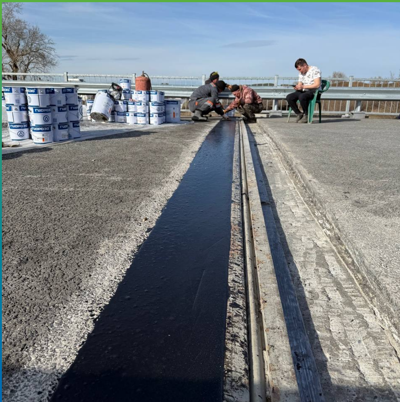
Пришовная зона заполненная составом Манопур 336
