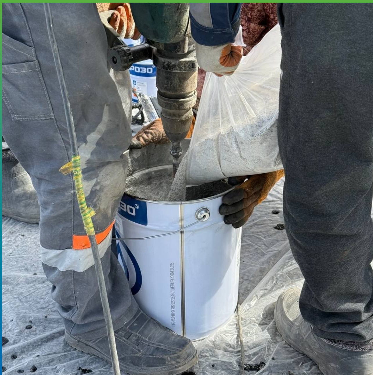
Добавление компонента А в заранее промешанные Б1 и Б2
