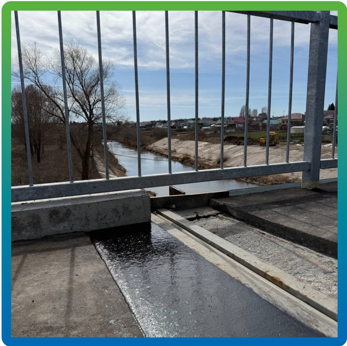
Пришовная зона заполненная составом Манопур 336
