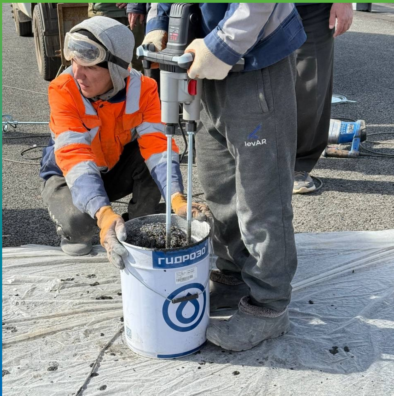
Тщательное promешивание трех компонентов материала Манопур 336
