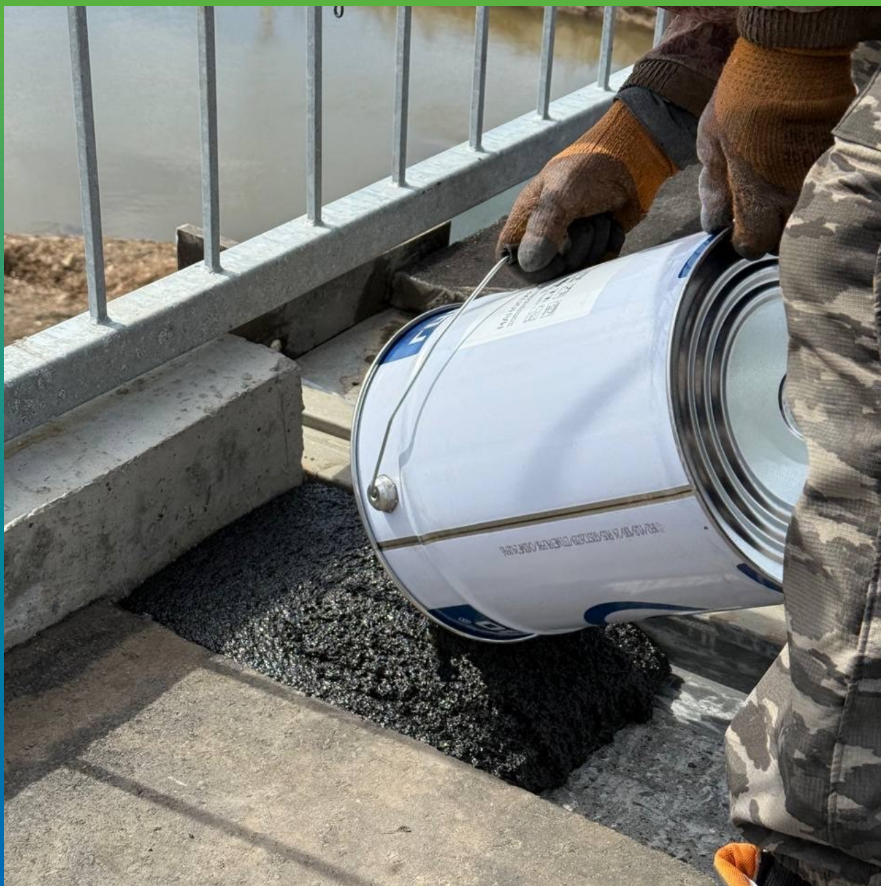
Подача готового состава для устройства пришовной зоны в штрабу
