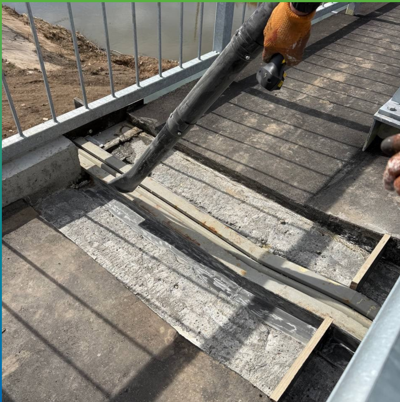
Продувка основания от пыли и незакрепленных частиц
