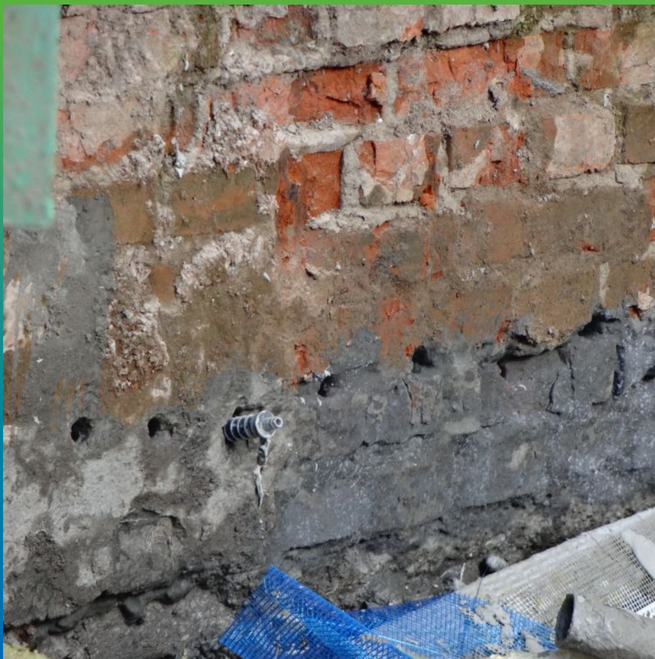
Инъектирование Максклир Инжекшн в кладку
