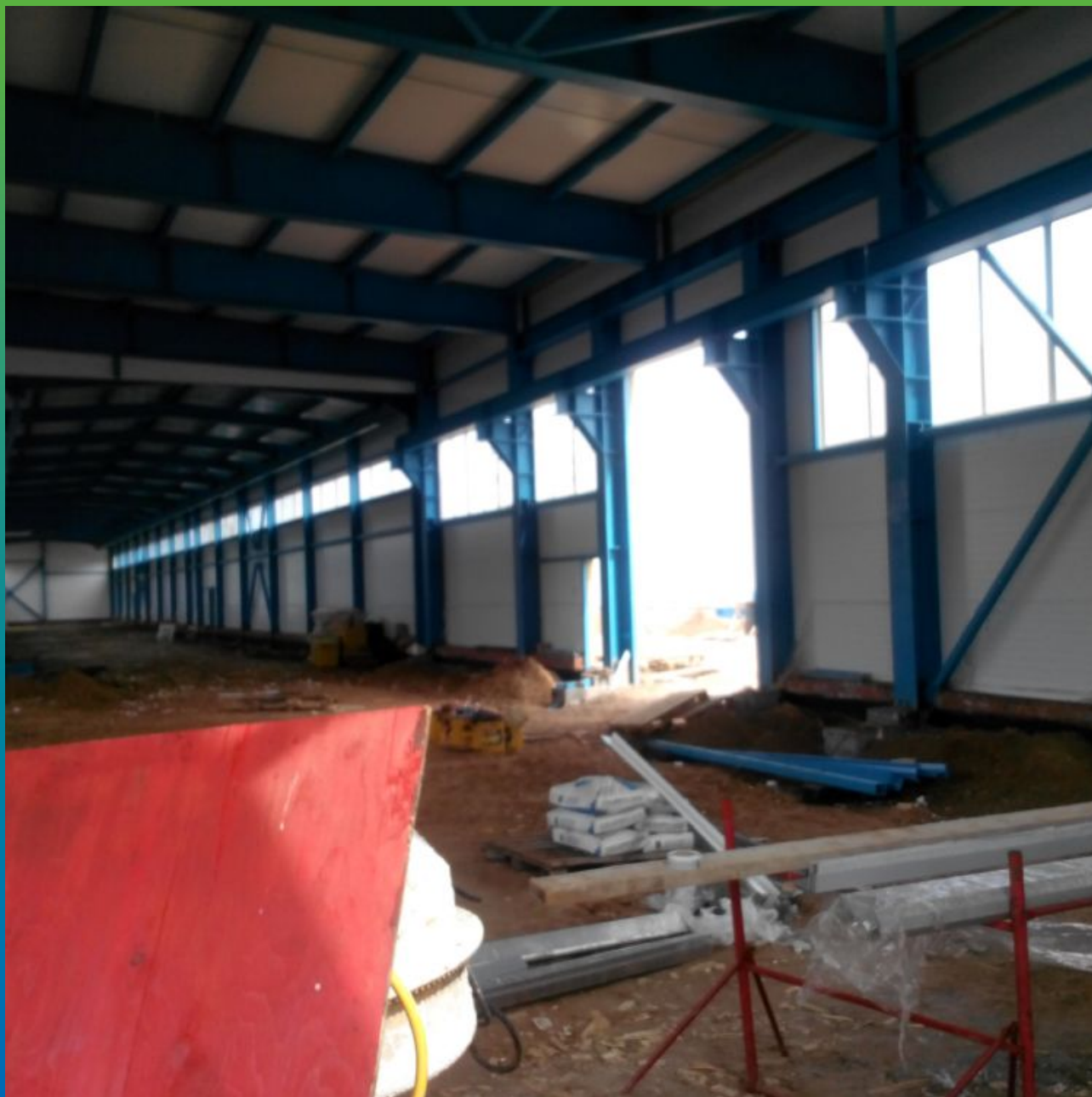
Подготовительные работы перед заливкой стяжки
