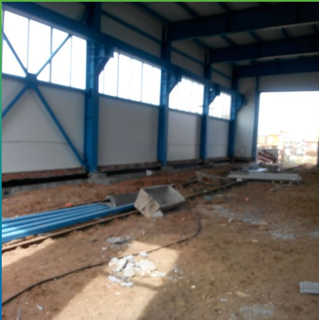
Подготовительные работы перед заливкой стяжки
