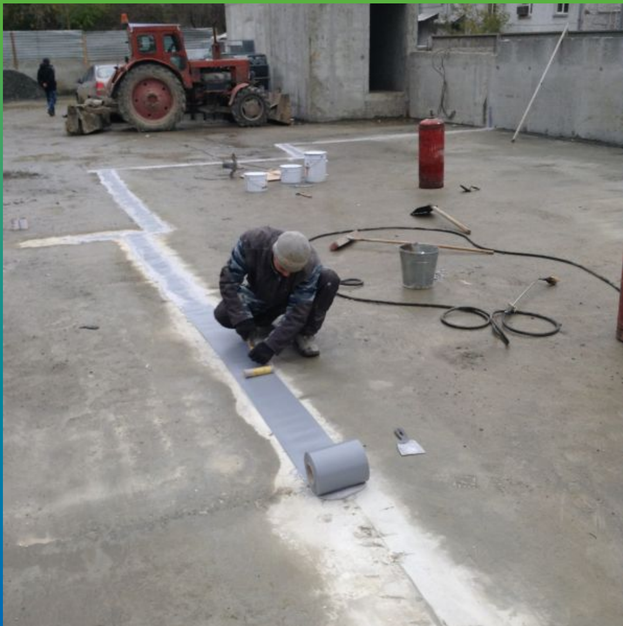
Монтаж гидроизоляционной ленты Манодил Про. Общий вид небольшого участка
