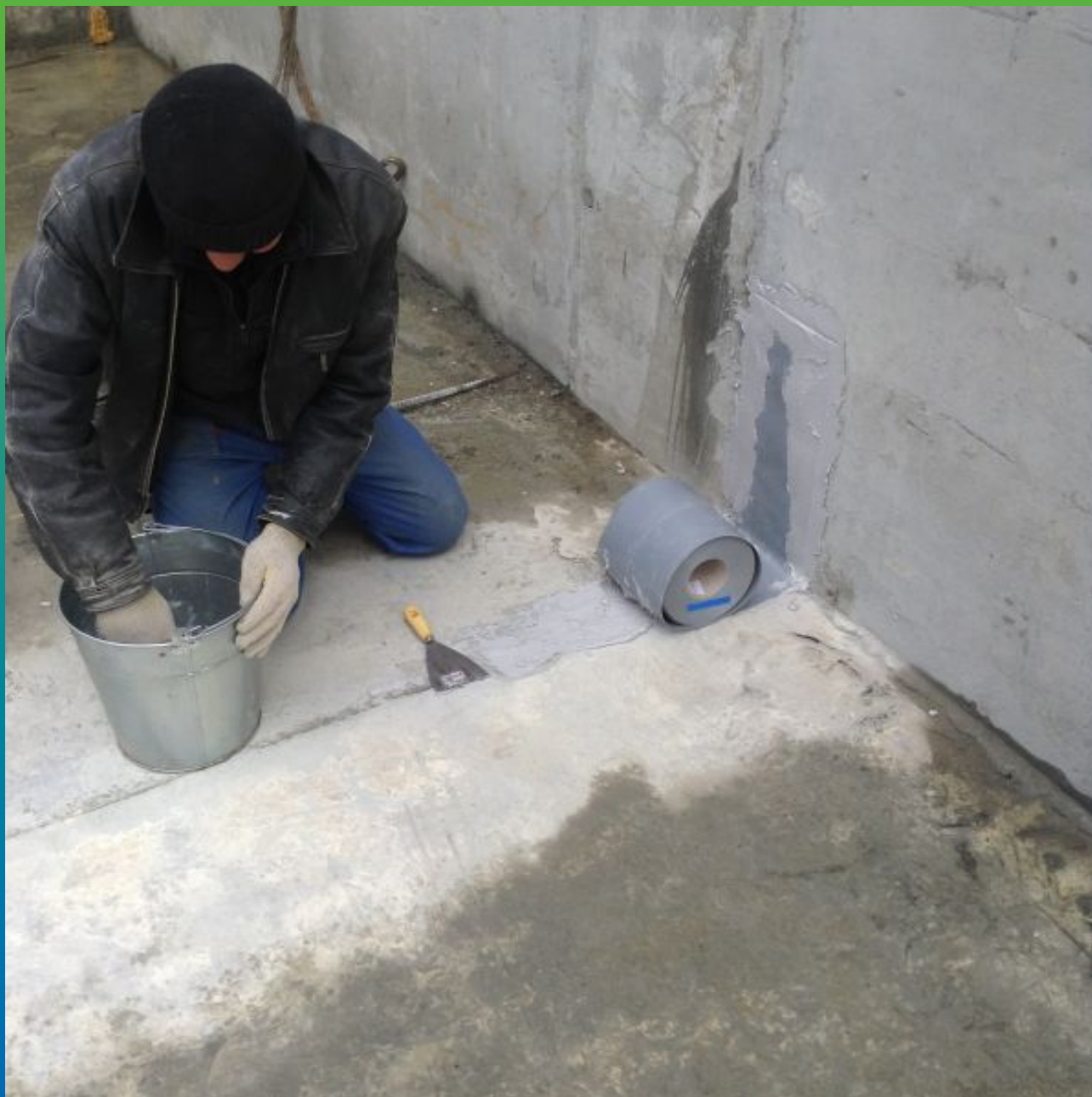
Нанесение клея Манопокс 331 на основание и укладка гидроизоляционной ленты Манодил Про
