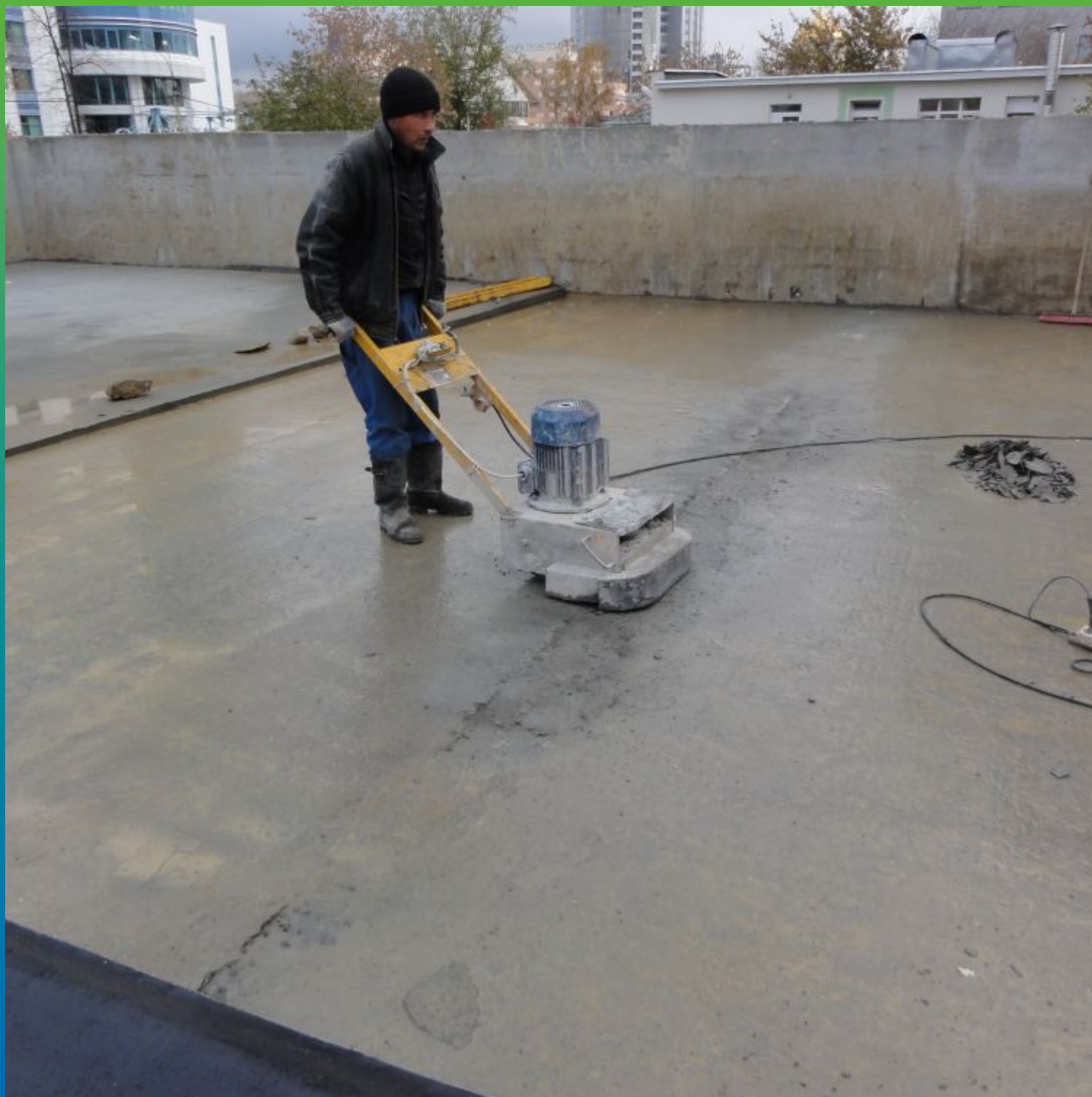
Механическая очистка основания шлиф. машиной от цементного молочка и прочих дефектов
