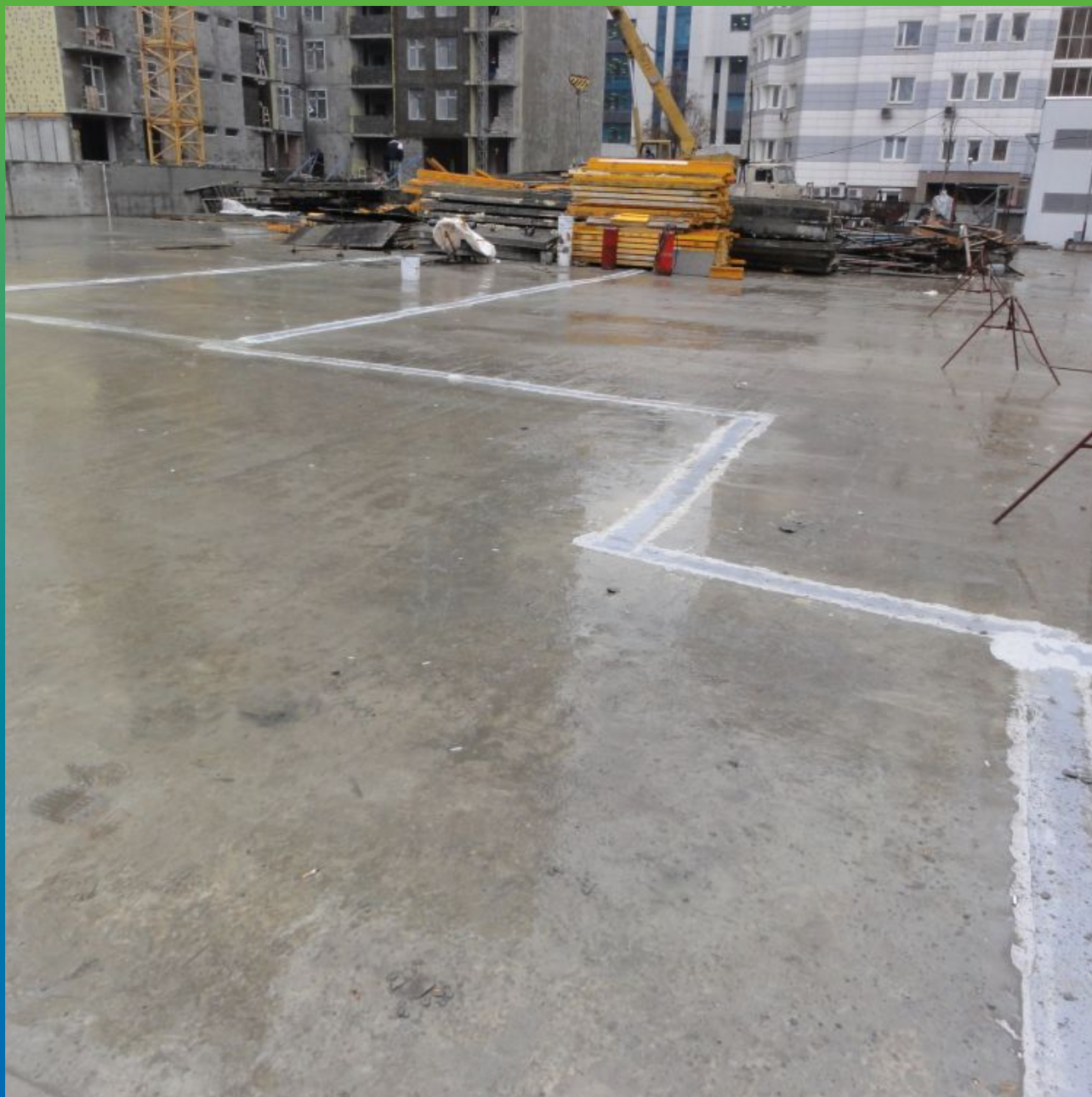
Смонтированные гидроизоляционные ленты на покрытии паркинга
