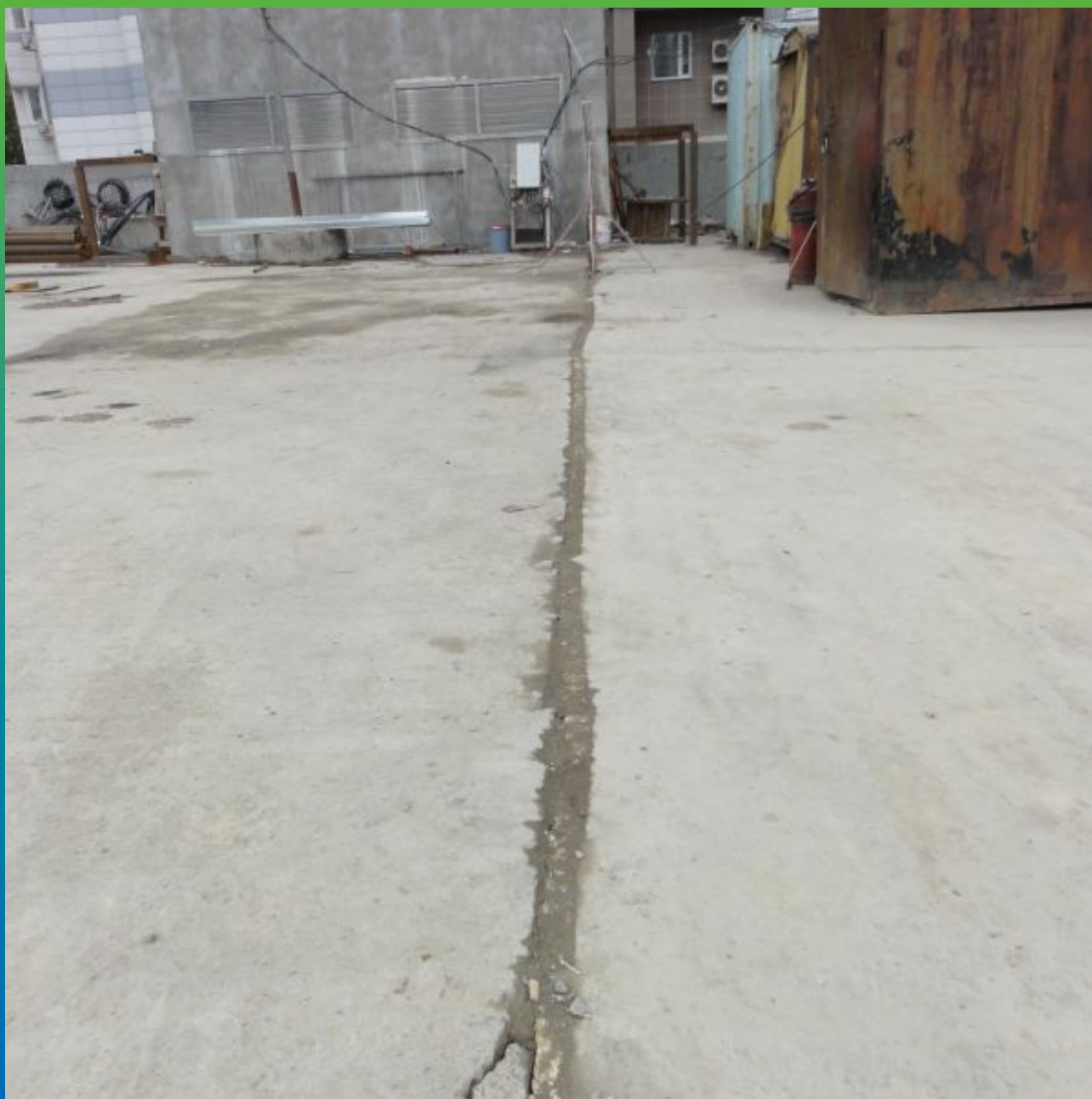
Швы паркинга до начала работ
