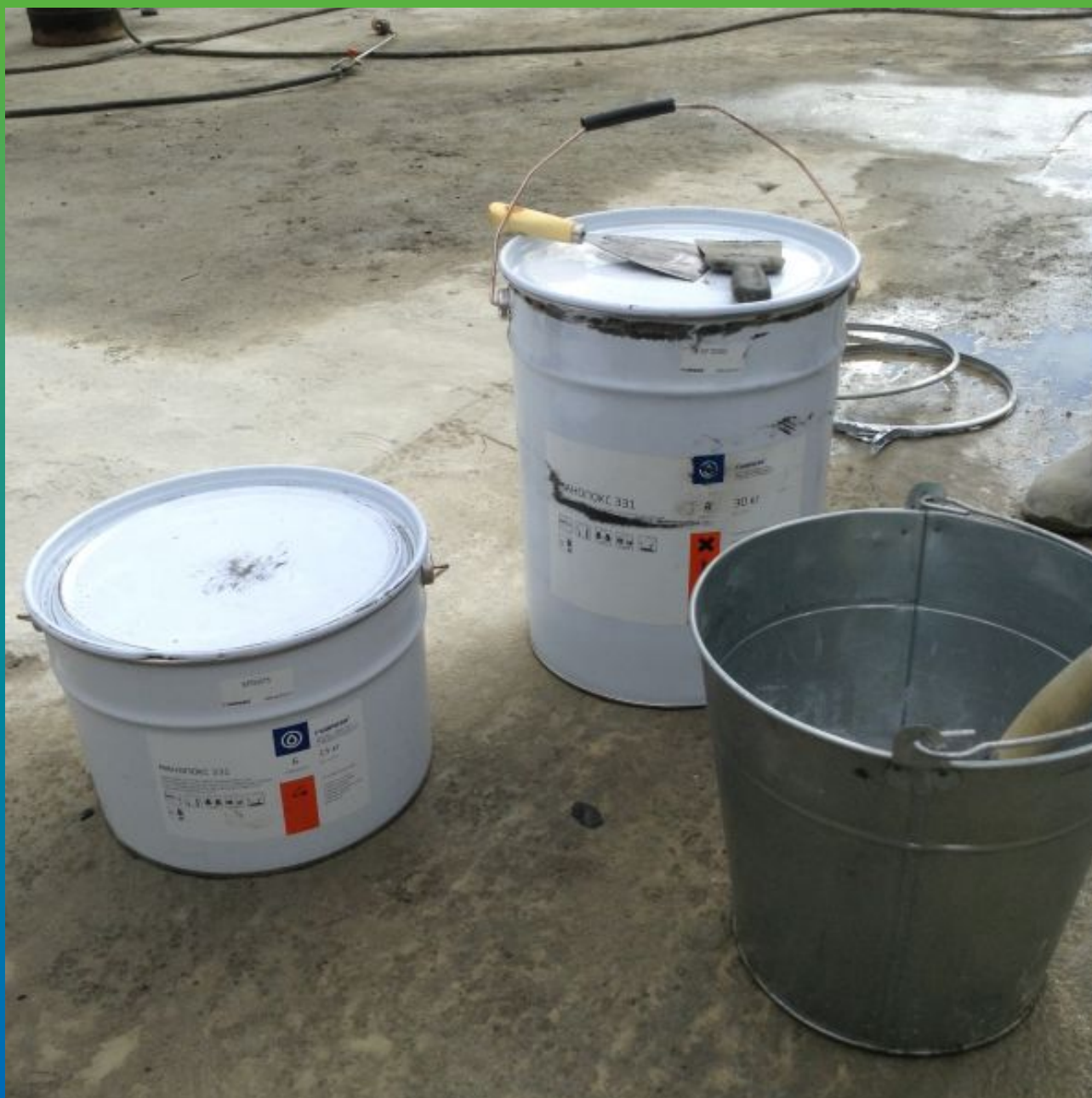
Подготовка материала. Замешивание двухкомпонентного клея Манопокс 331
