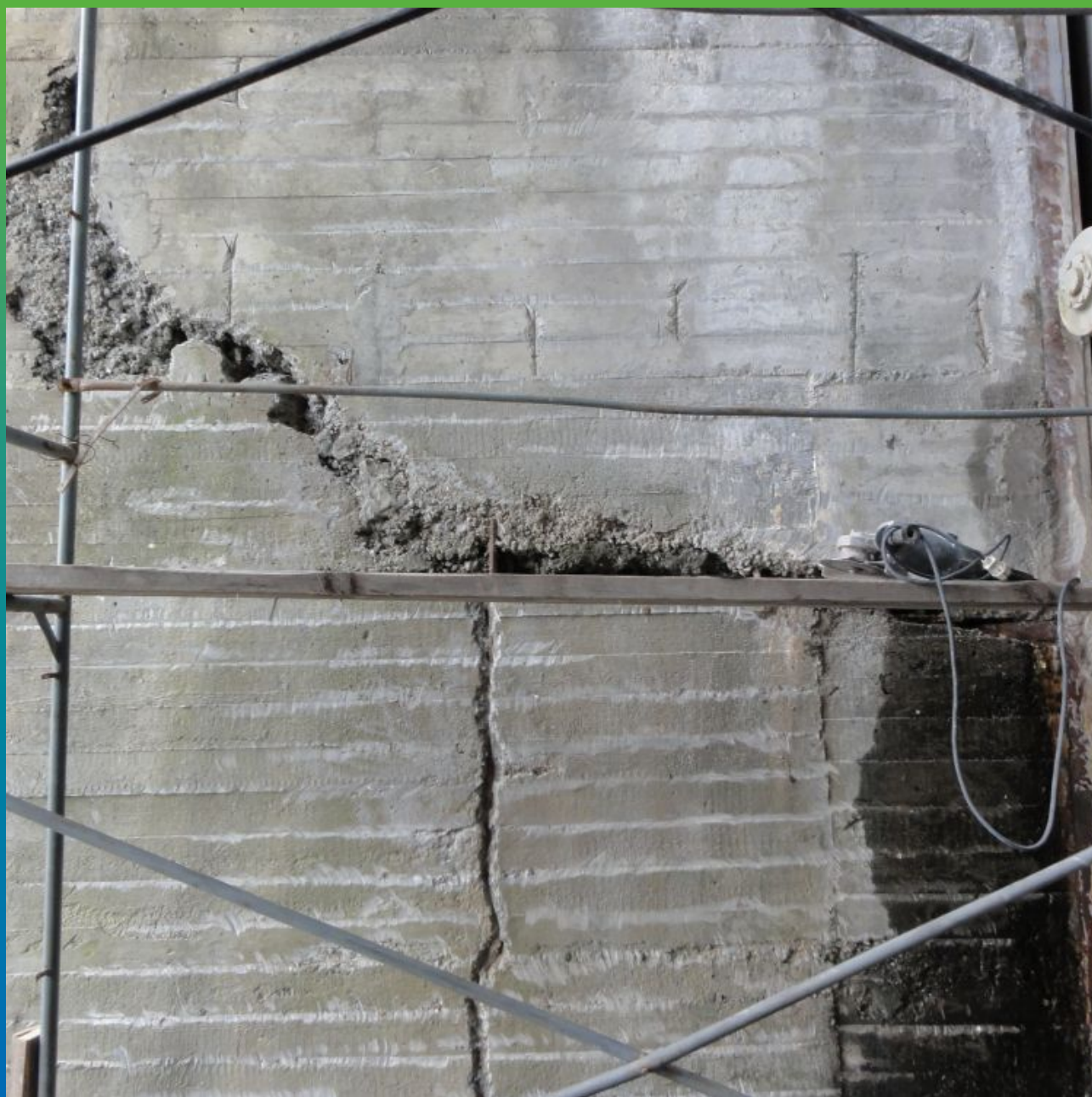
Расшивка трещин
