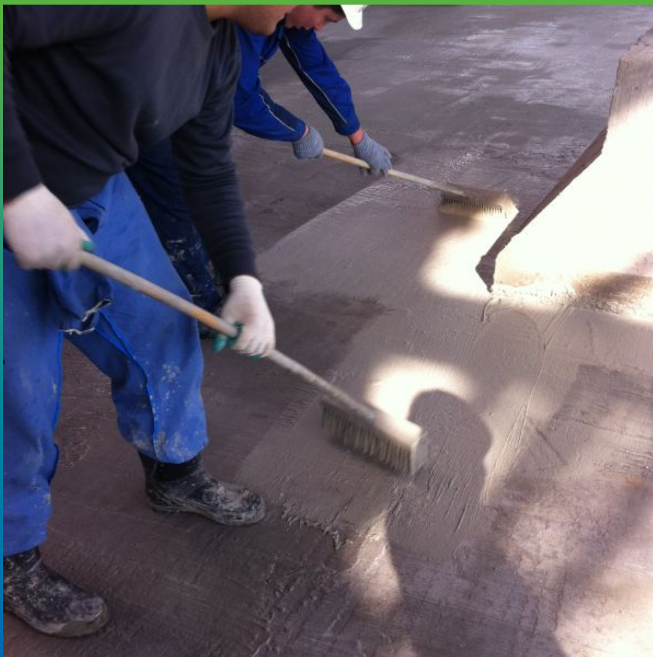
Нанесение гидроизоляционного покрытия Максил
