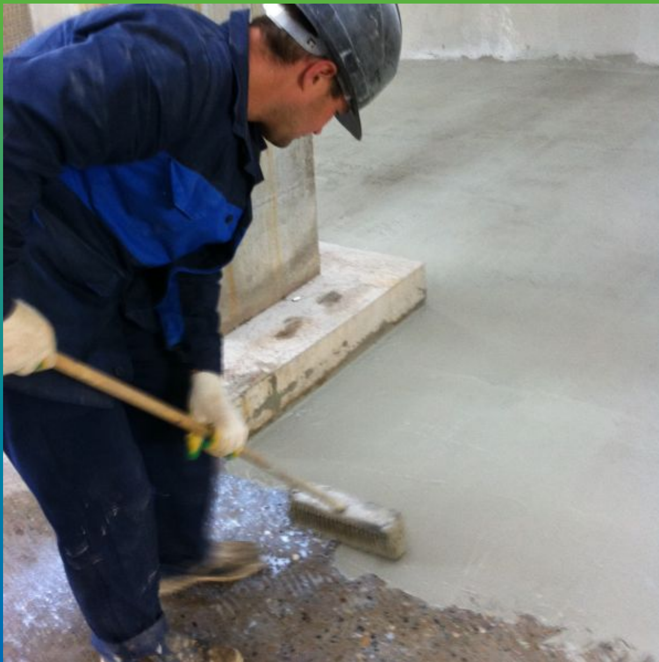
Нанесение гидроизоляционного покрытия Максил
