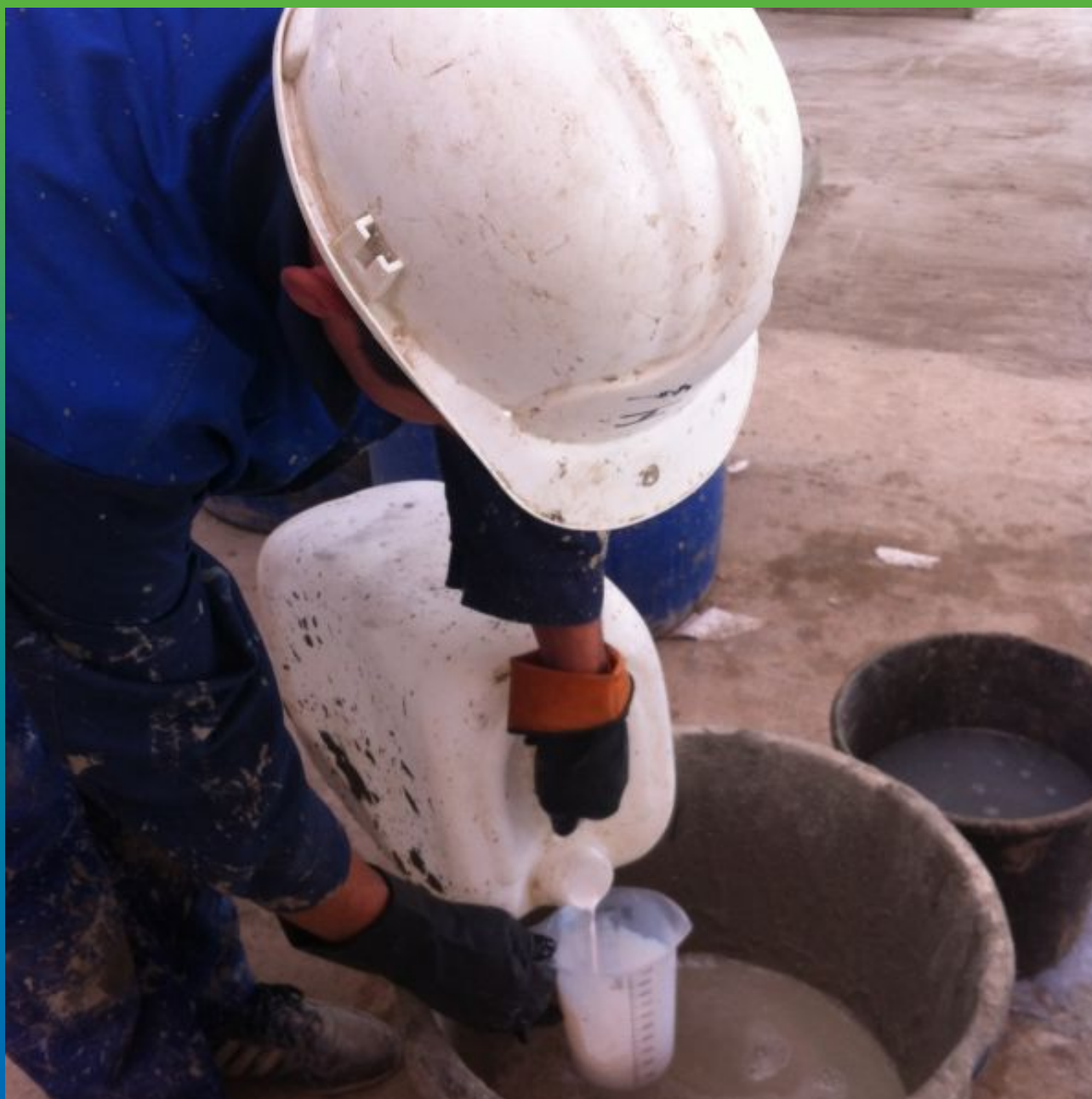
Приготовление гидроизоляционного покрытия Максил с добавлением Максрил
