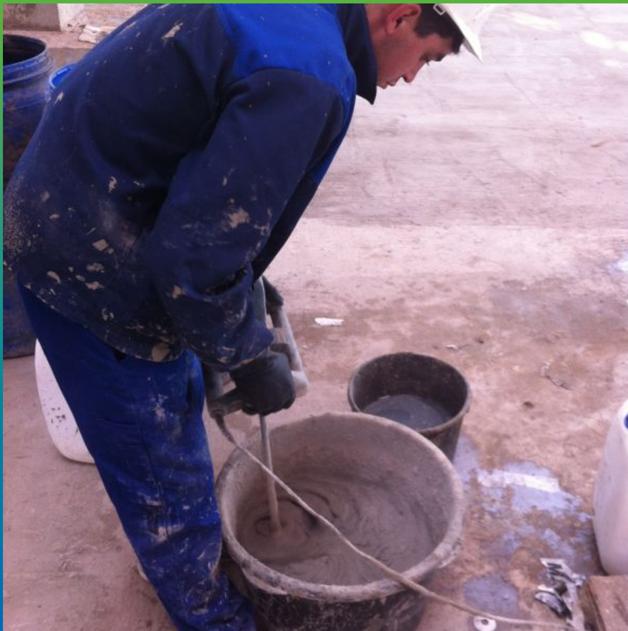
Приготовление гидроизоляционного покрытия Максил с добавлением Максрил
