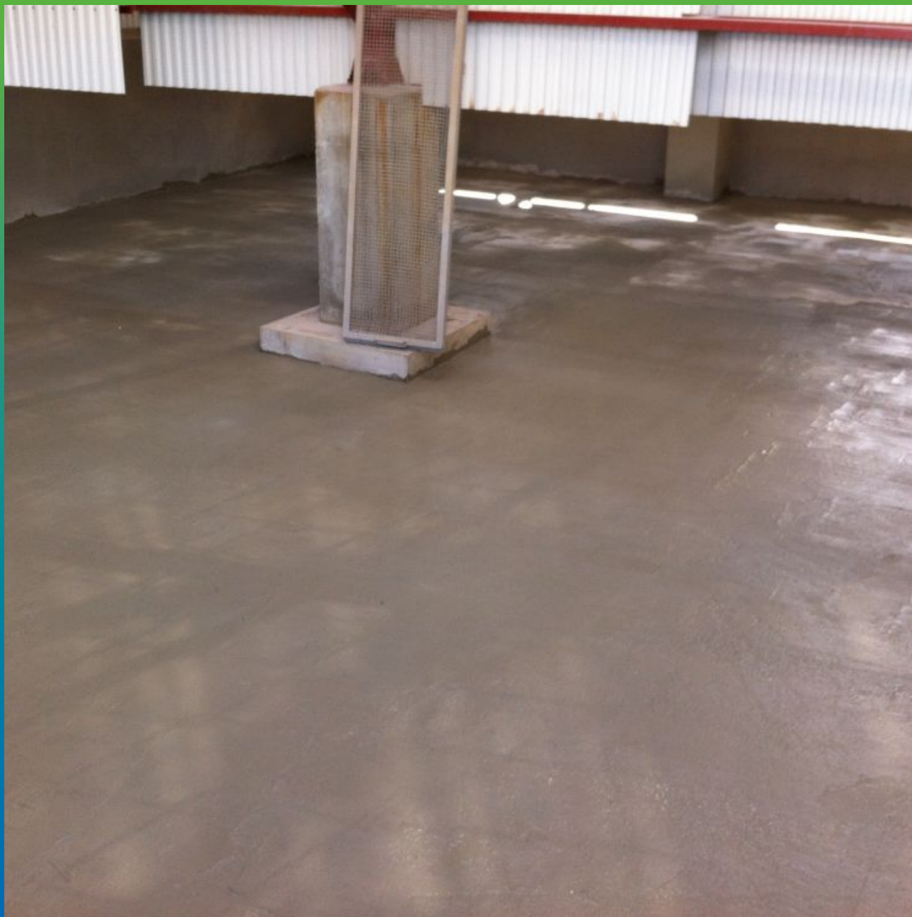
Готовое гидроизоляционное покрытие Максил с добавлением Максрил
