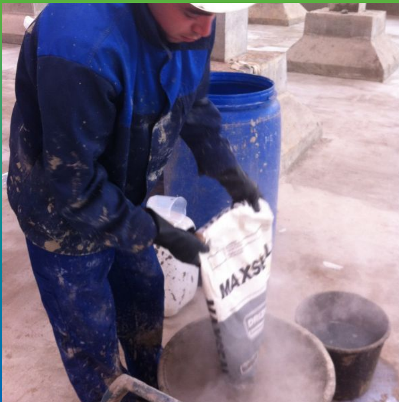
Приготовление гидроизоляционного покрытия Максил с добавлением Максрил
