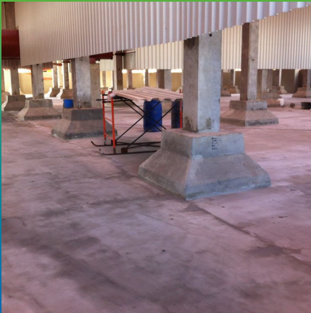
Готовое гидроизолированное днище бассейна градирни
