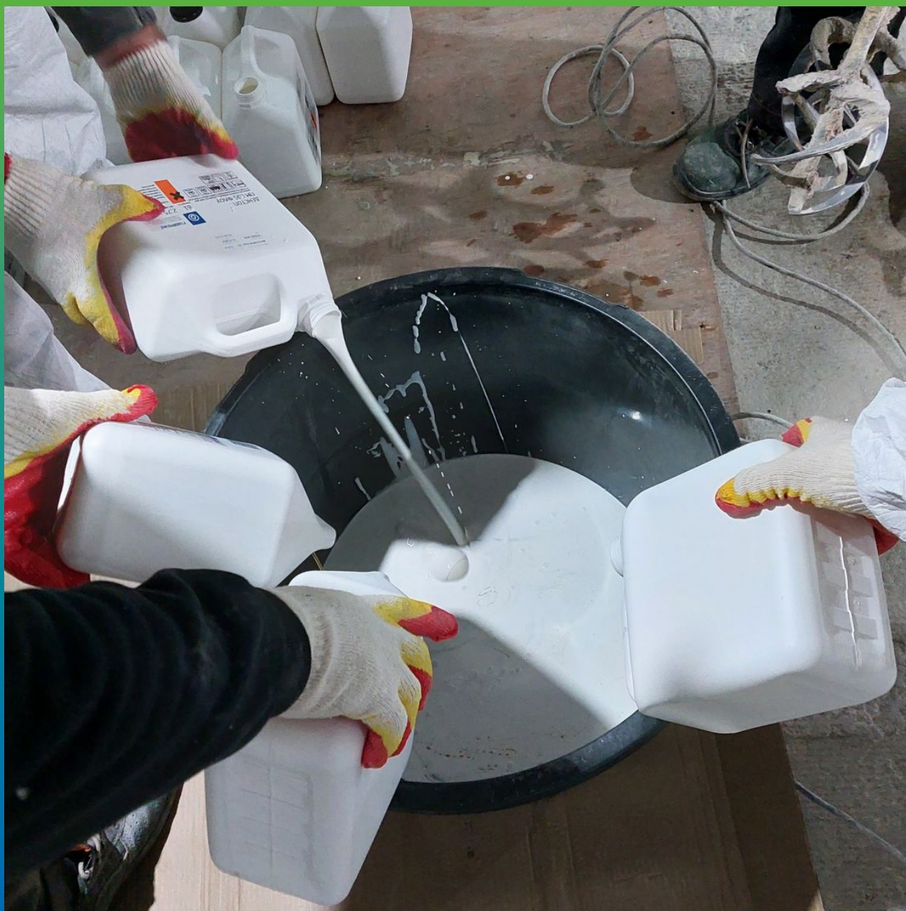
Смешивание жидких компонентов ДенТоп ПМ 605 Флоу
