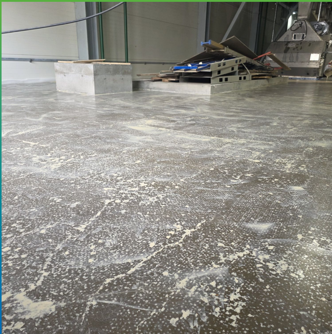
Вид загрунтованной поверхности без пор
