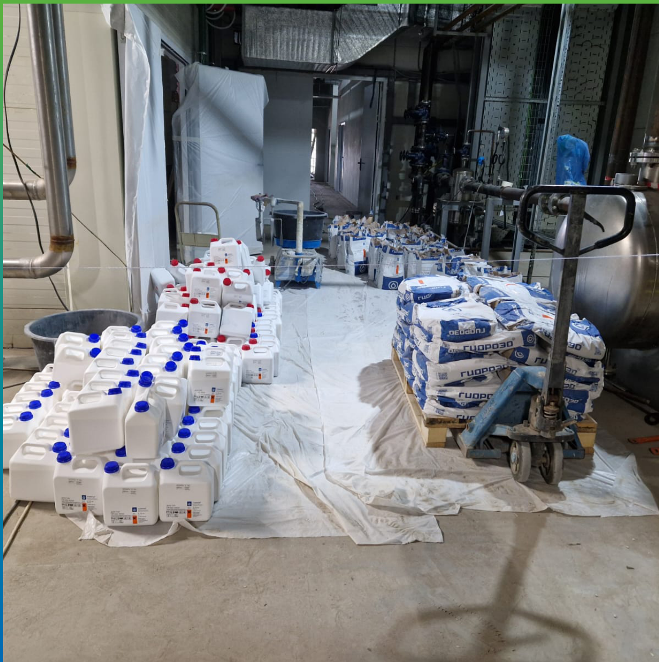
Материалы Гидрозо на объекте
