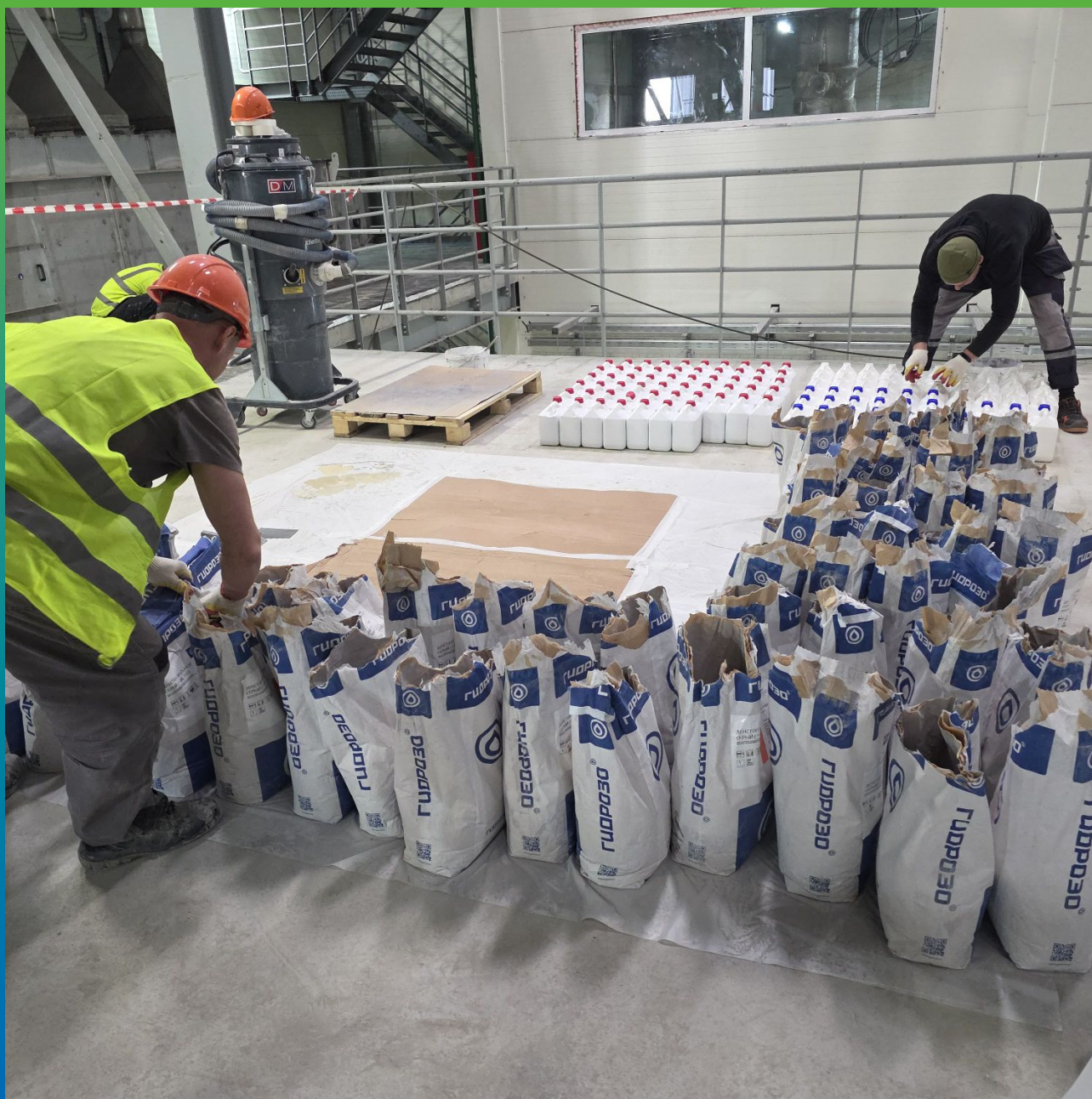
Приготовление материала ДенТоп ПМ 605 Флоу к работе
