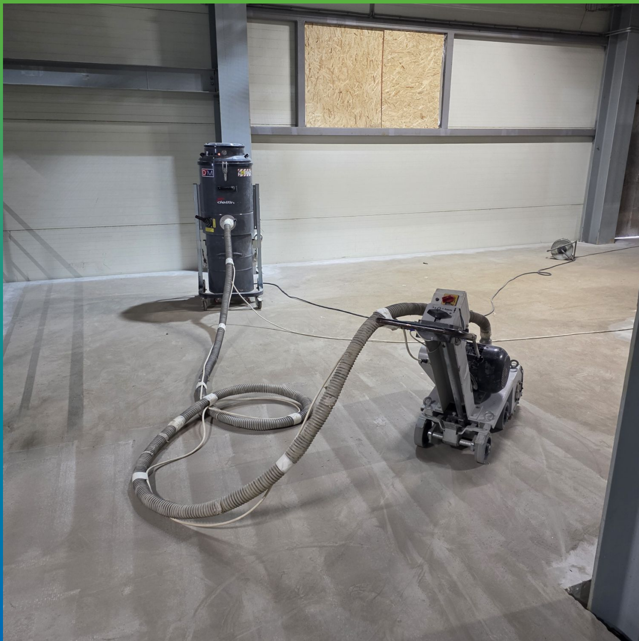
Отфрезерованное основание
