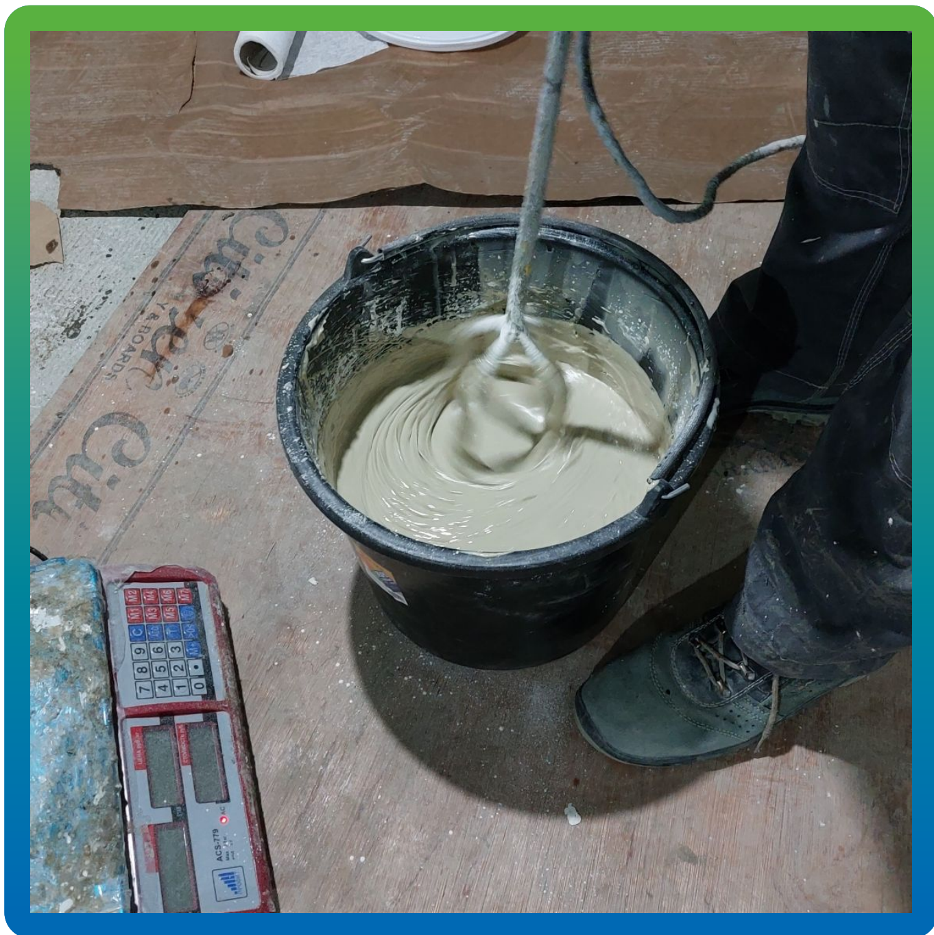
Смешивание грунтовки ДенТоп ПМ 600
