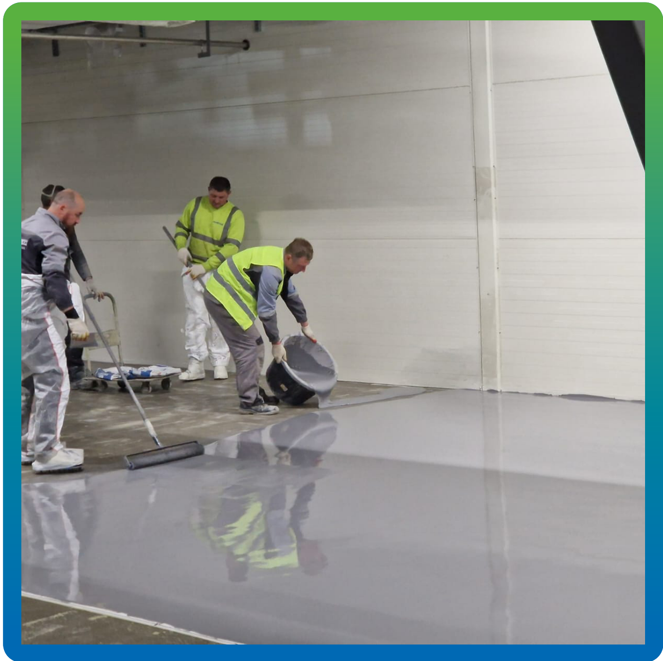
Укладка полиуретанцемента ДенсТоп ПМ 605 Флоу
