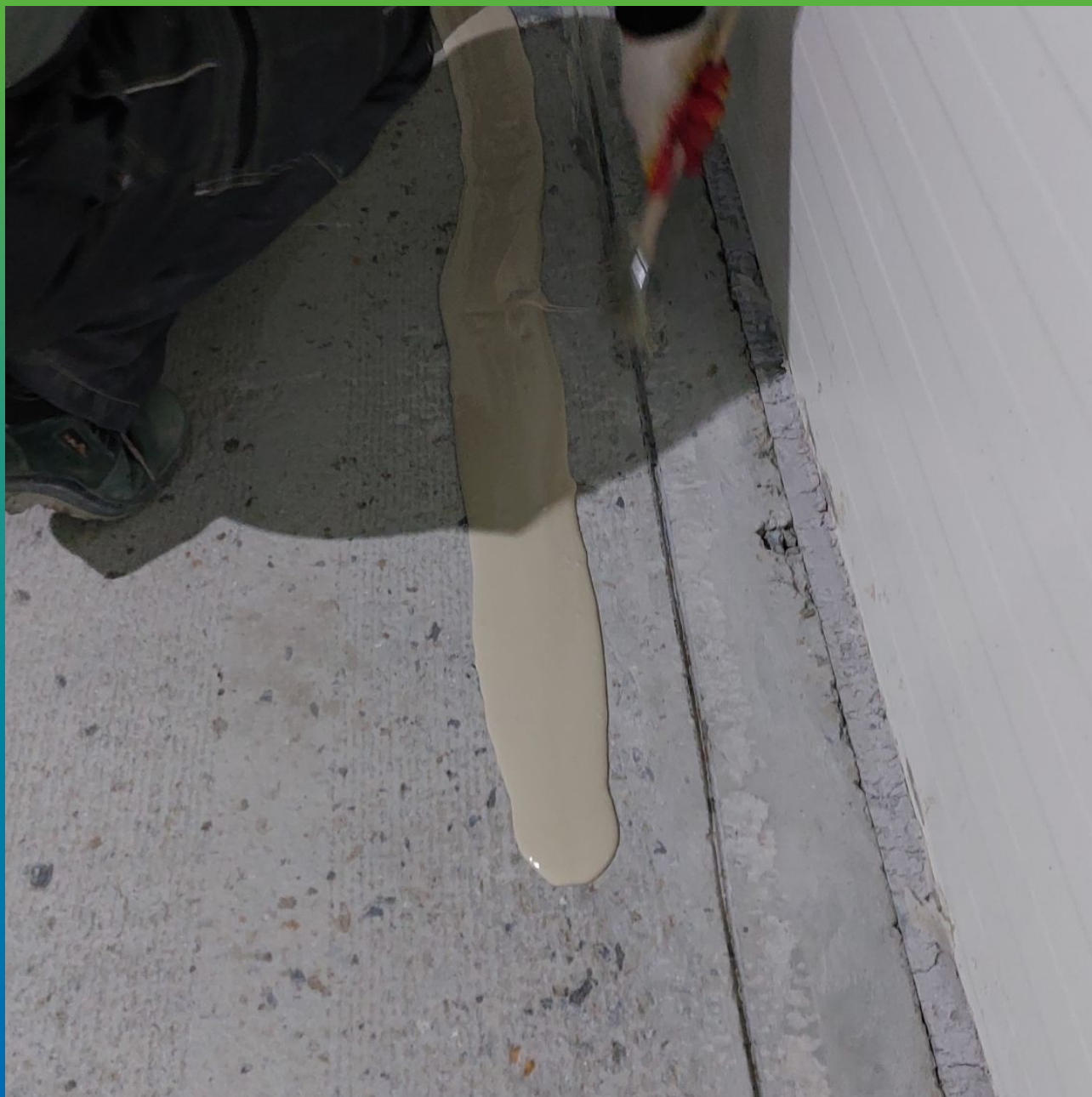
Грунтование анкерных пропилов ДенсТоп ПМ 600
