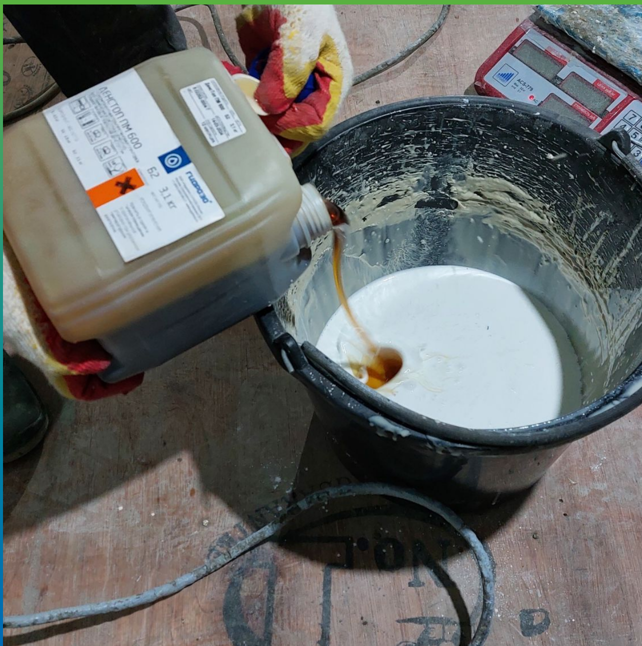
Подготовка грунтовки ДенСтон ПМ 600
