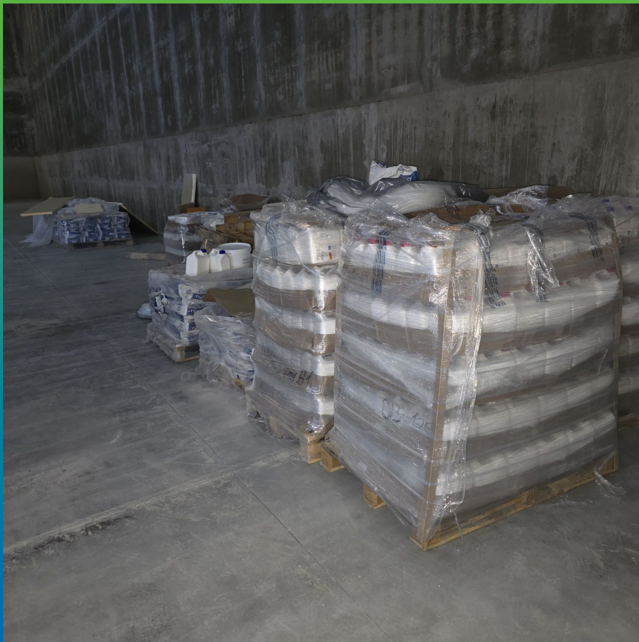
Материалы Гидрозо на объекте
