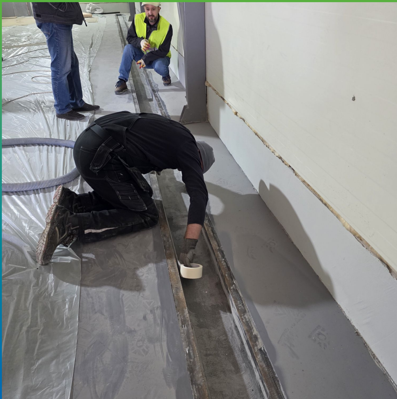
Приклейка монтажного скотча
