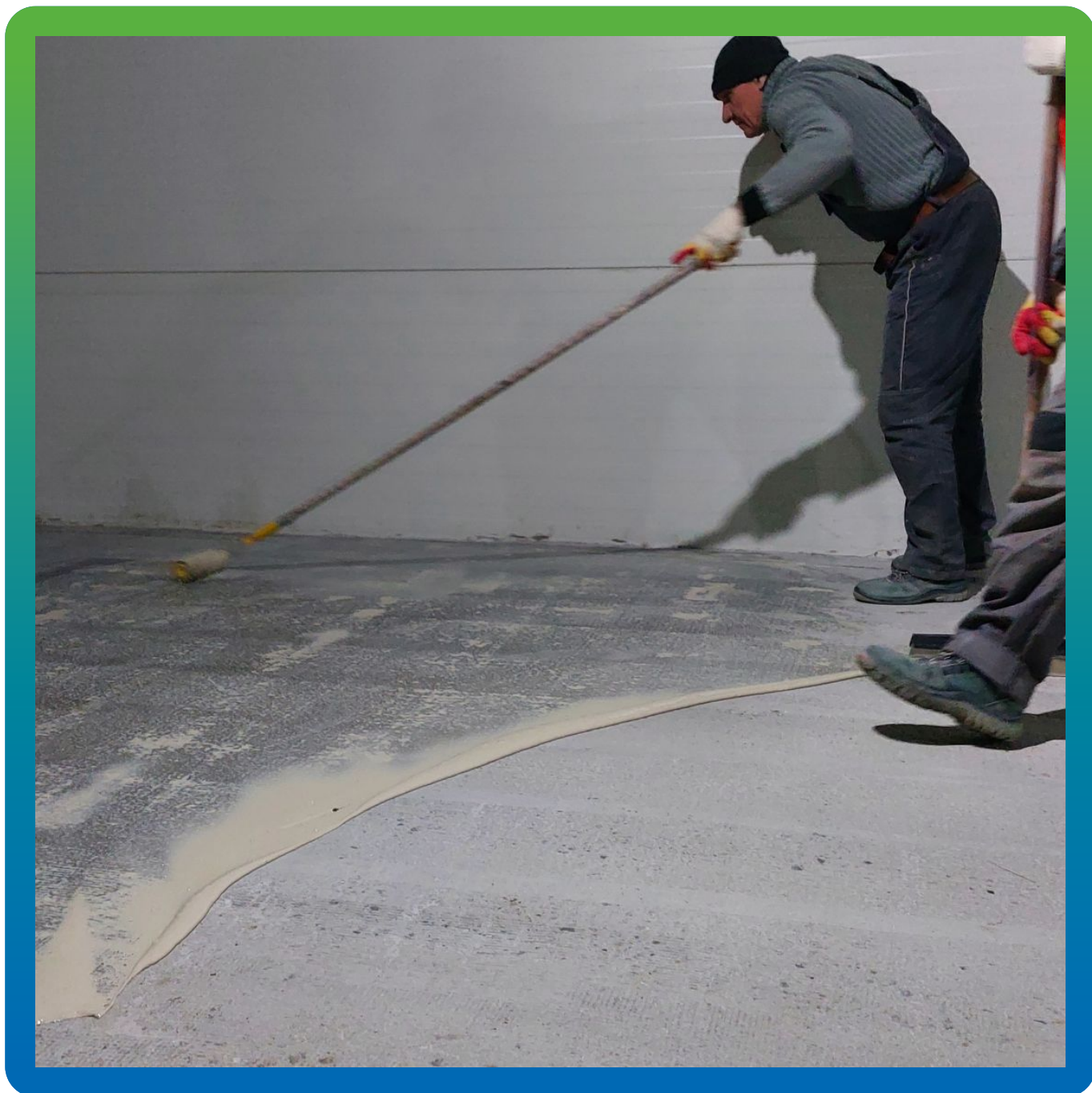
Грунтование поверхности ДенсТоп ПМ 600
