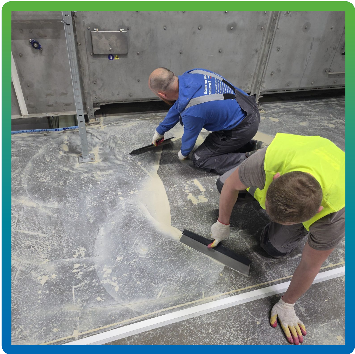
Грунтование на сдир 2 раз ДенсТоп ПМ 600
