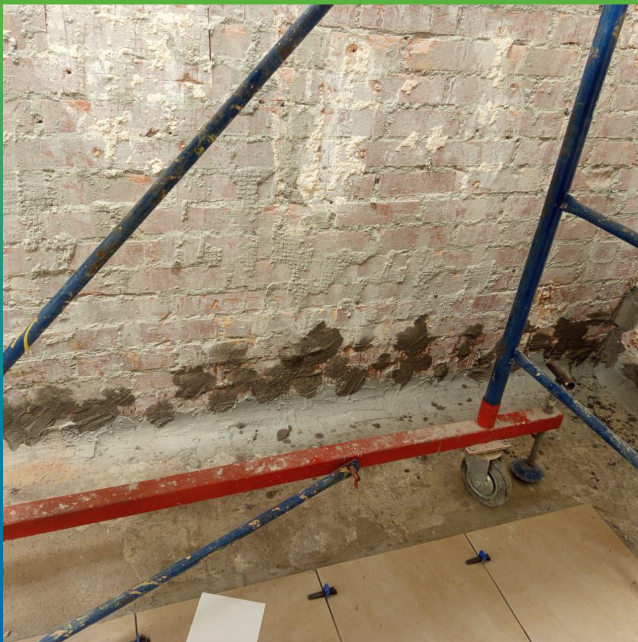
Устройство галтели пол-стена
