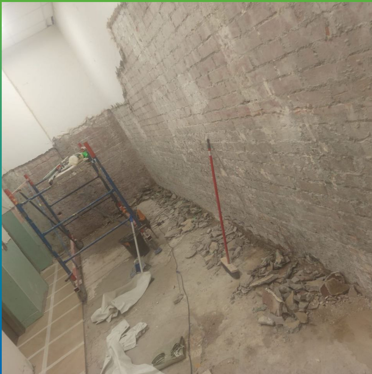
Демонтаж штукатурного слоя и стяжки
