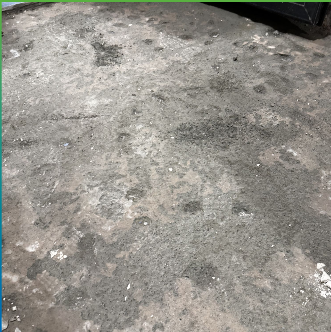
Внешний вид после удаления битумной гидроизоляции
