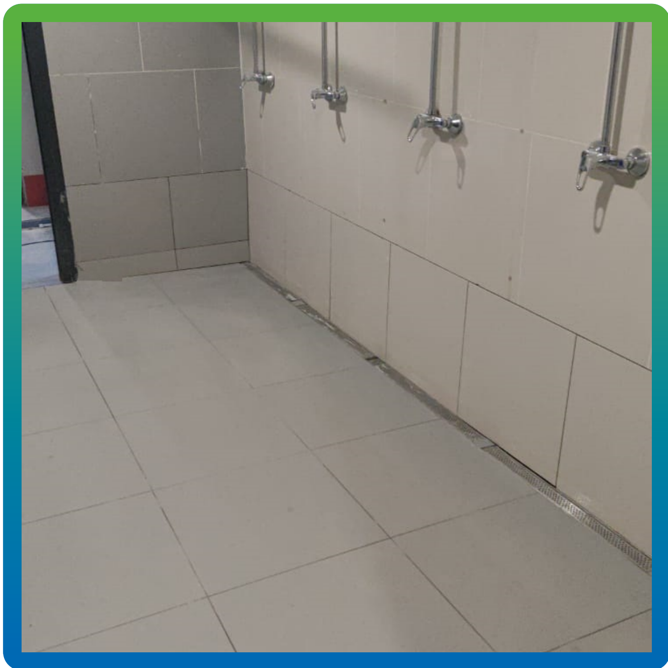
Оклейка плиткой, окончание работ
