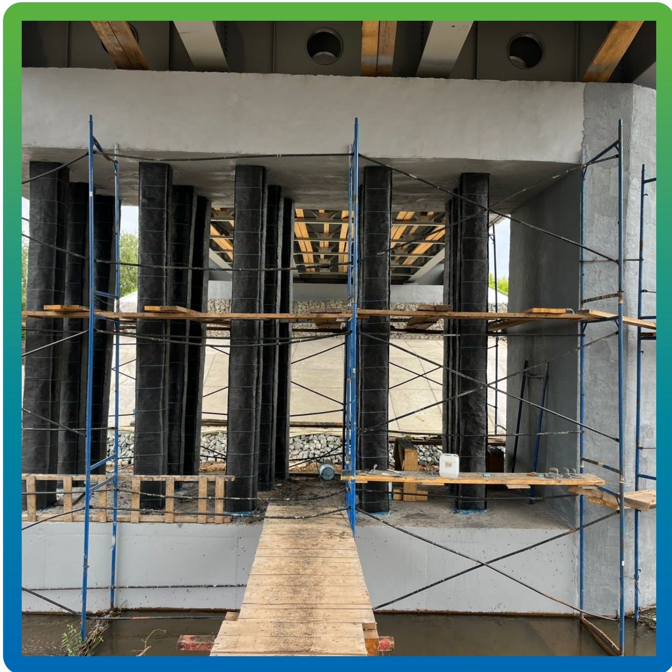
Внешний вид объекта после монтажа системы композитного усиления
