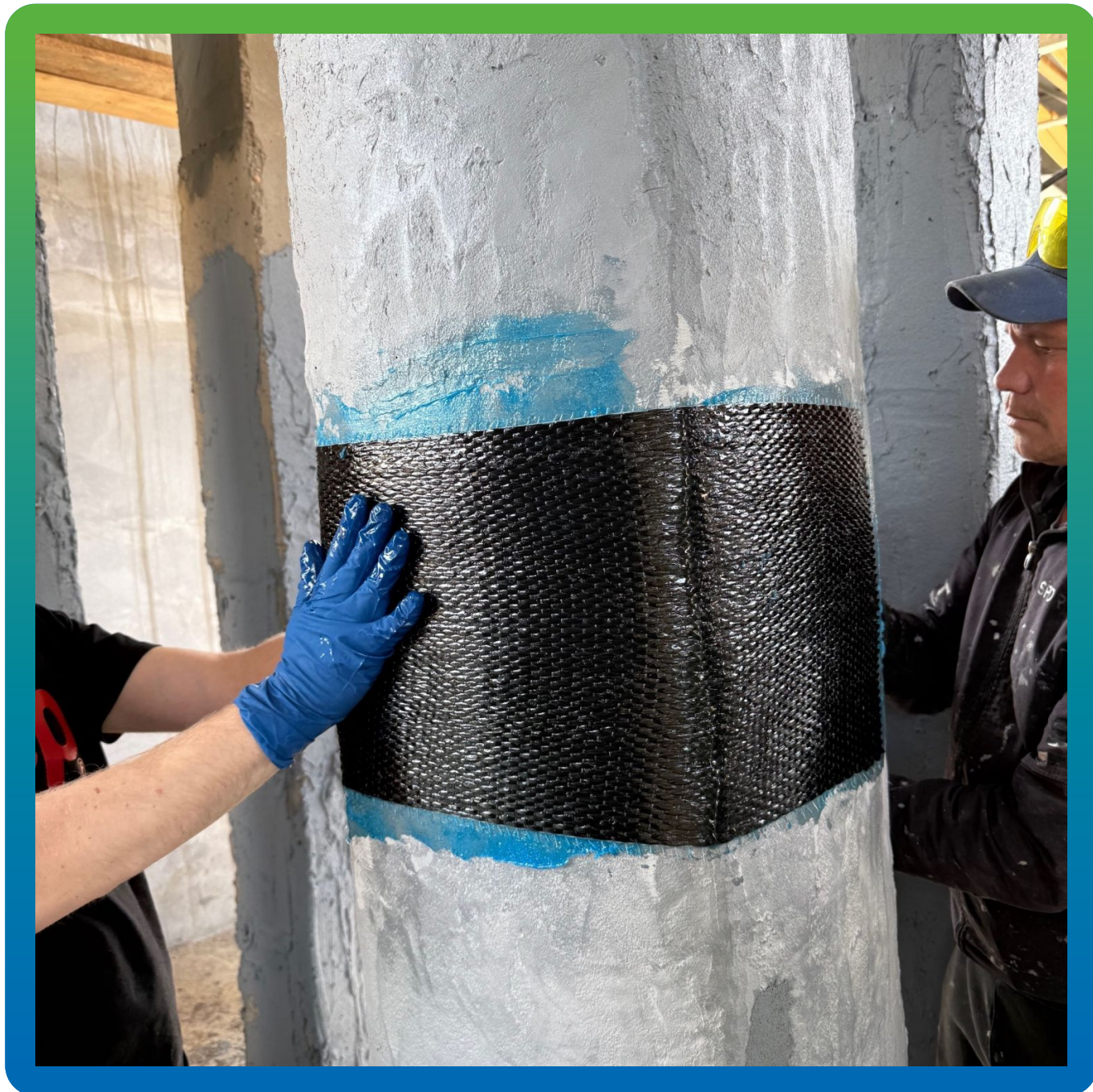
Разравнивание холста на поверхности опоры
