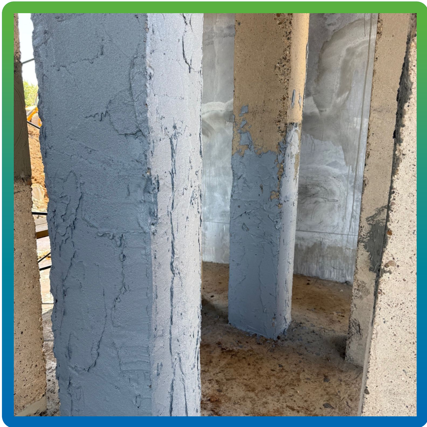
Внешний вид колонн с нанесенным Манопокс 331 по всей площади
