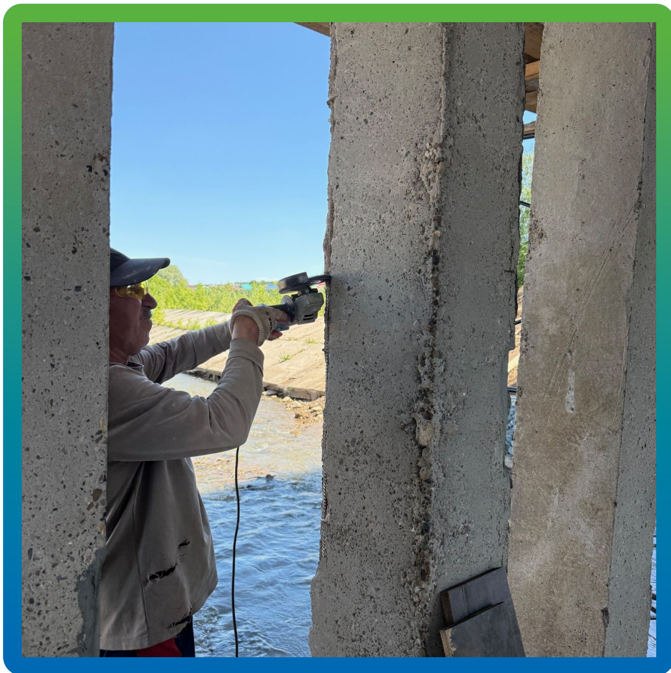
Подготовка основания механизированным способом
