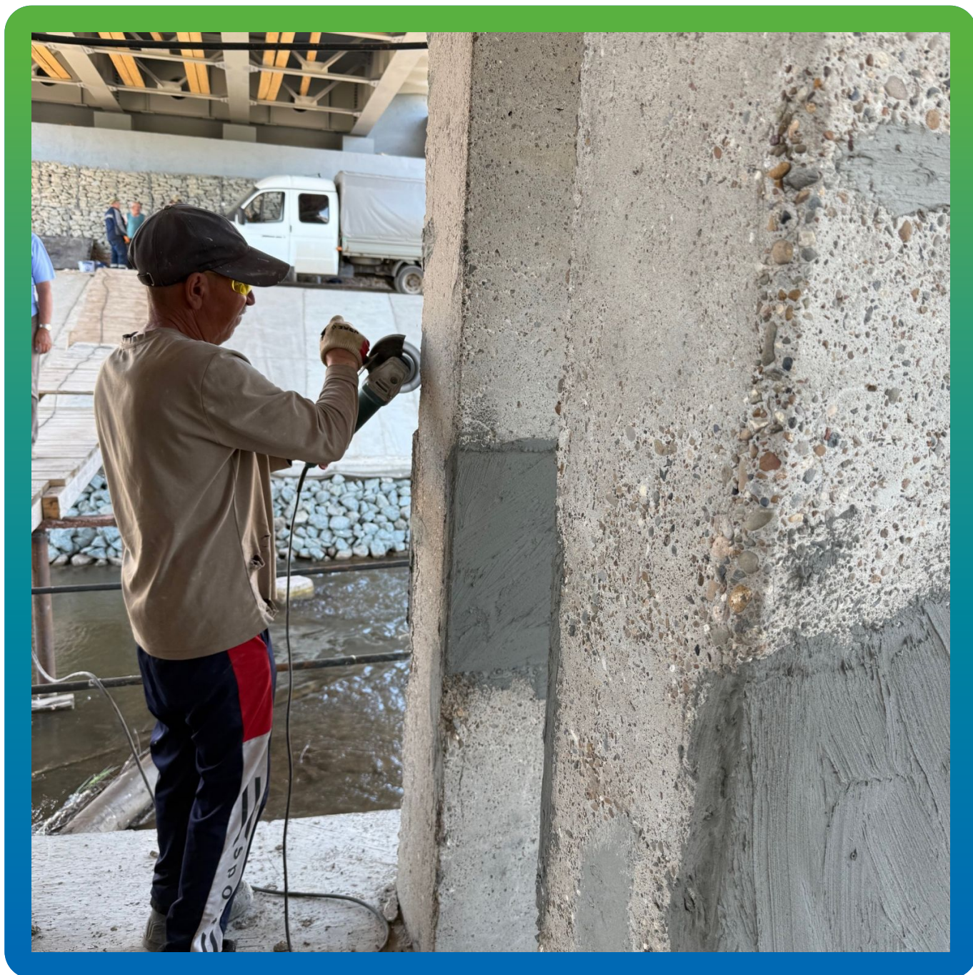
Подготовка основания механизированным способом
