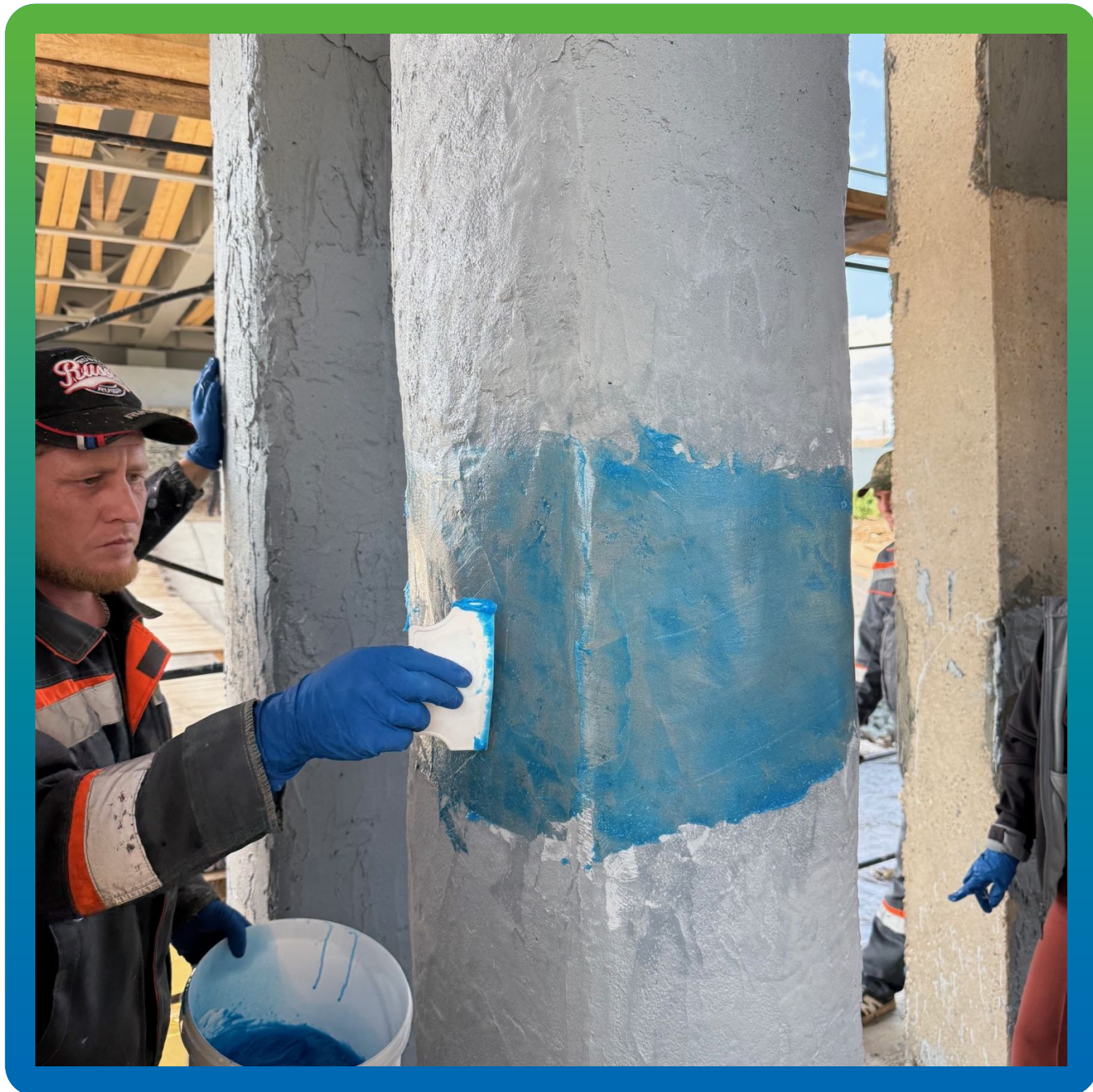
Нанесение клея на основание
