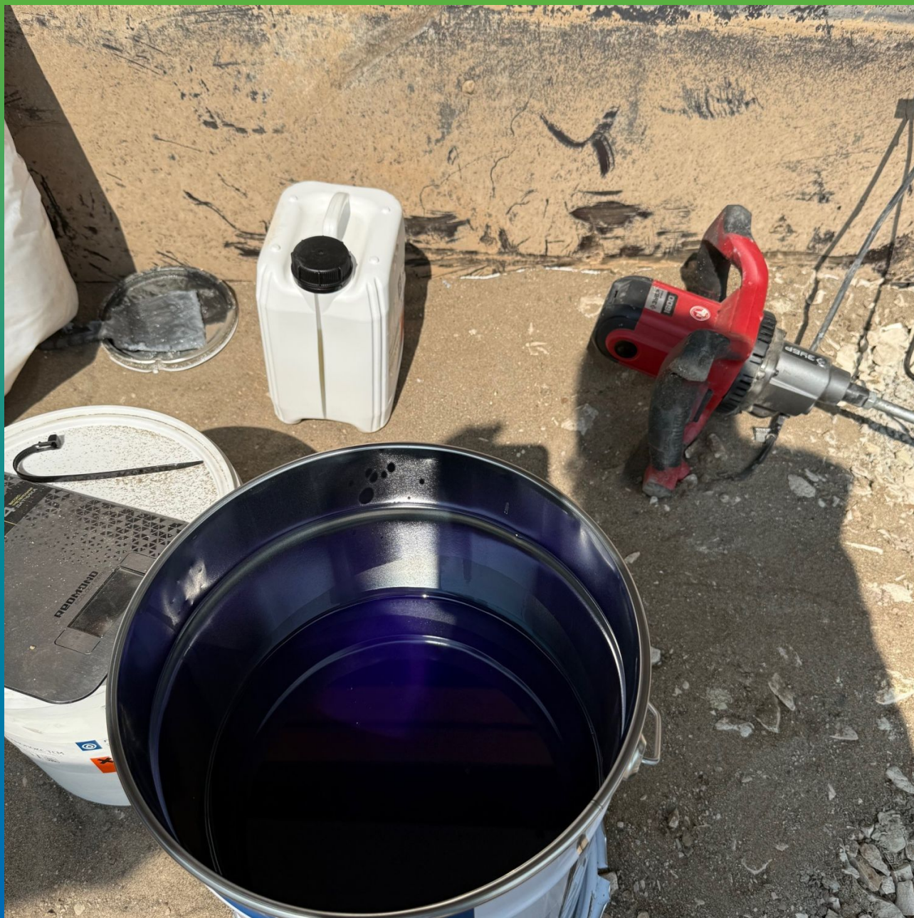
Двухкомпонентный клей на эпоксидной основе для монтажа КСУ Манопокс 372
