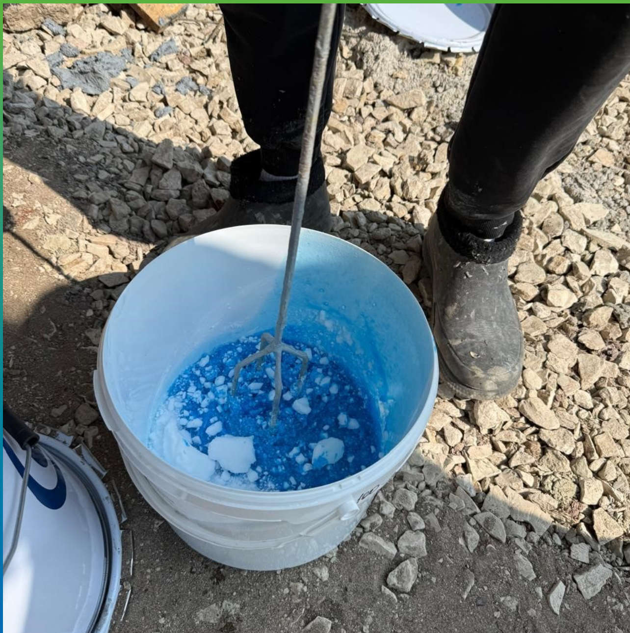
Загущение клея Манопокс 372 для нанесения на вертикальную поверхность
