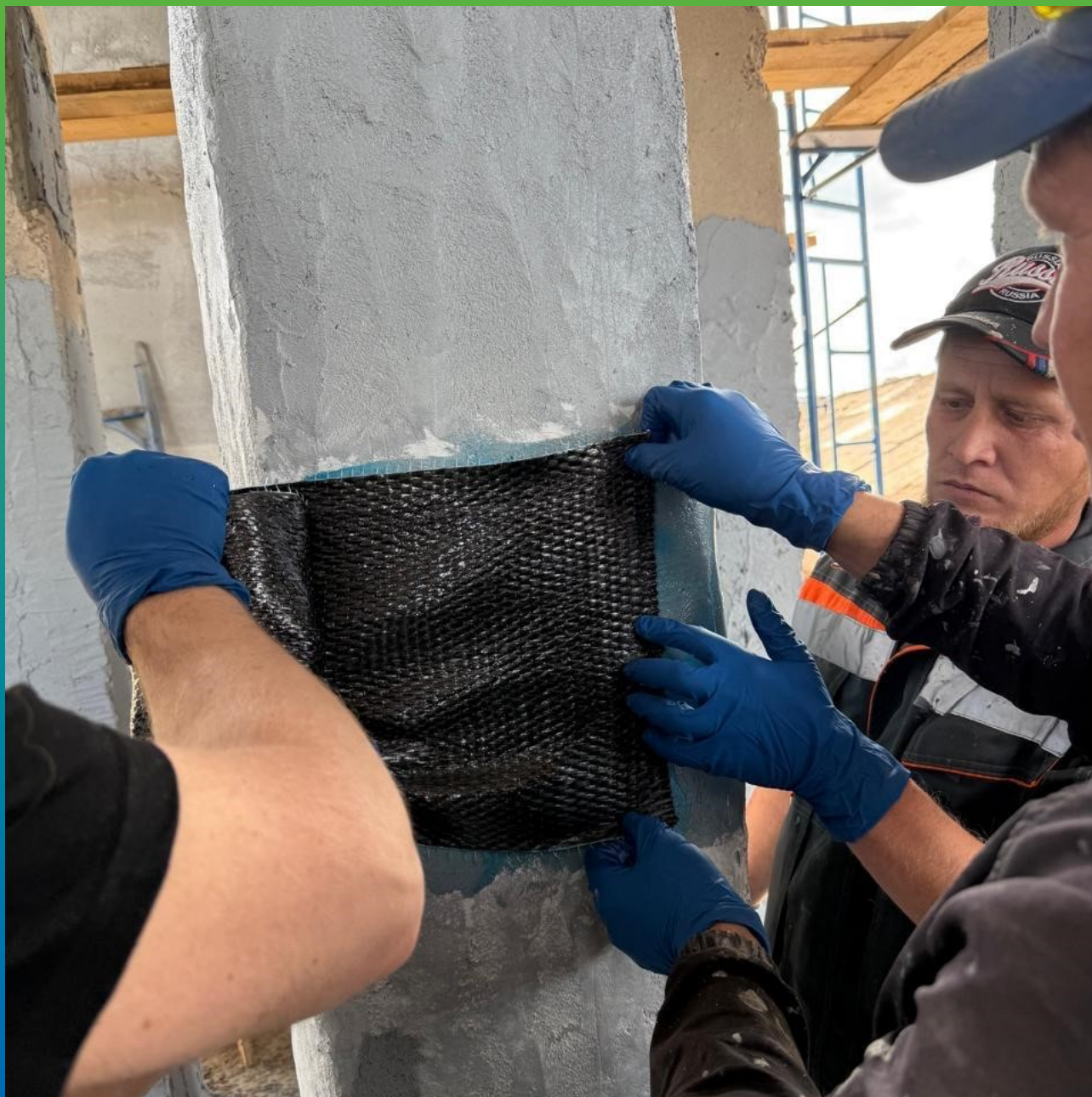
Устройство хомута из композитного холста, пропитанного клеем
