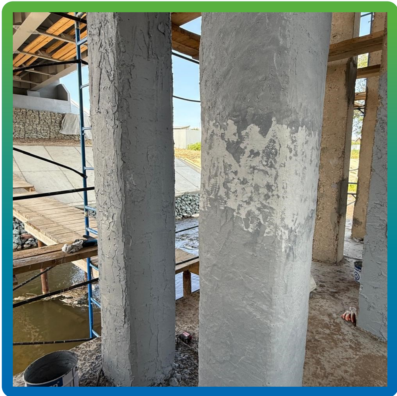
Колонна, подготовленная к нанесению системы композитного усиления
