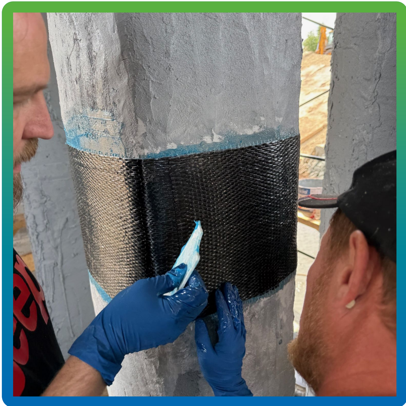
Разравнивание холста при помощи резинового шпателя
