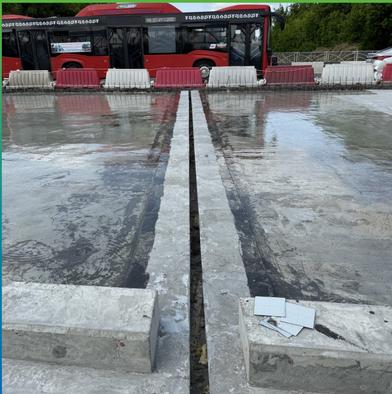
Сформированный деформационный шов.
