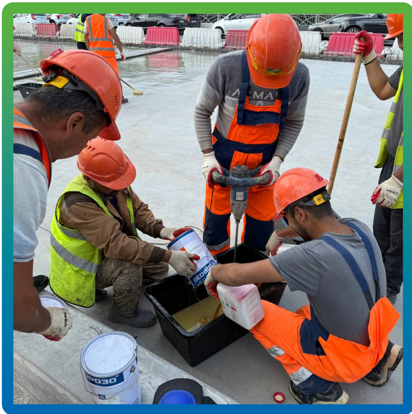
Процесс замешивания грунтовочного состава Манодил ПУ 90.
