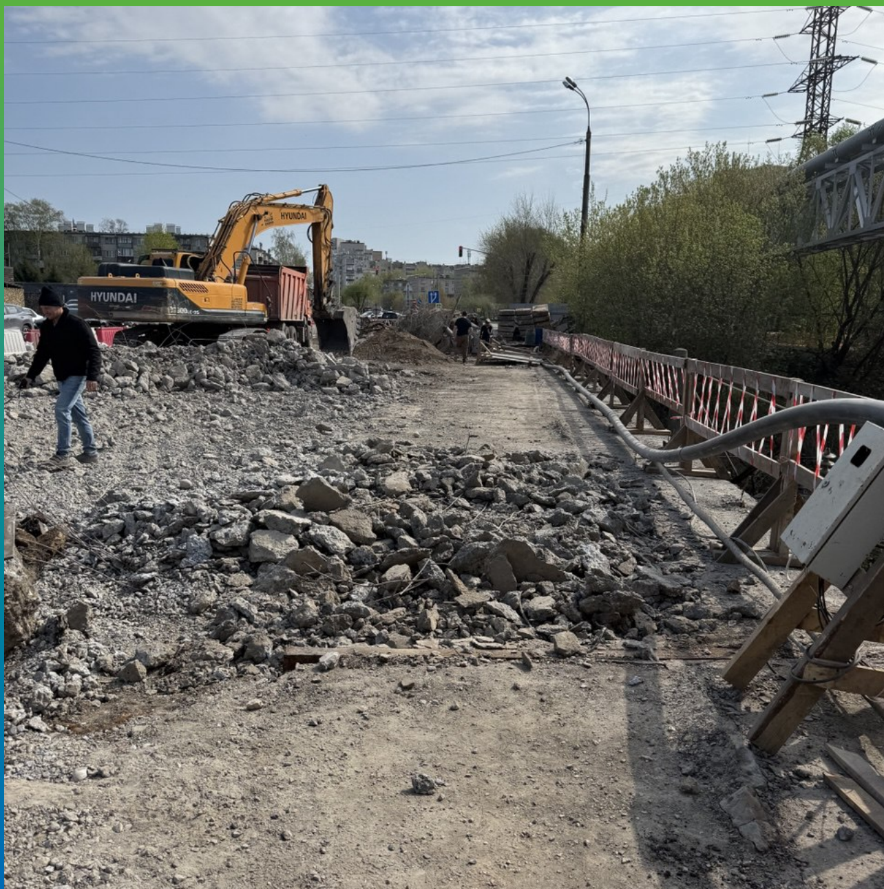
Демонтаж дорожного полотна.
