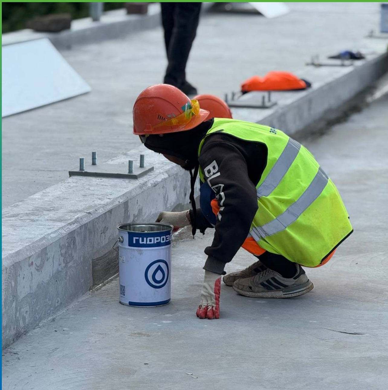
Нанесение Манодил ПУ 90 на стыки и швы.
