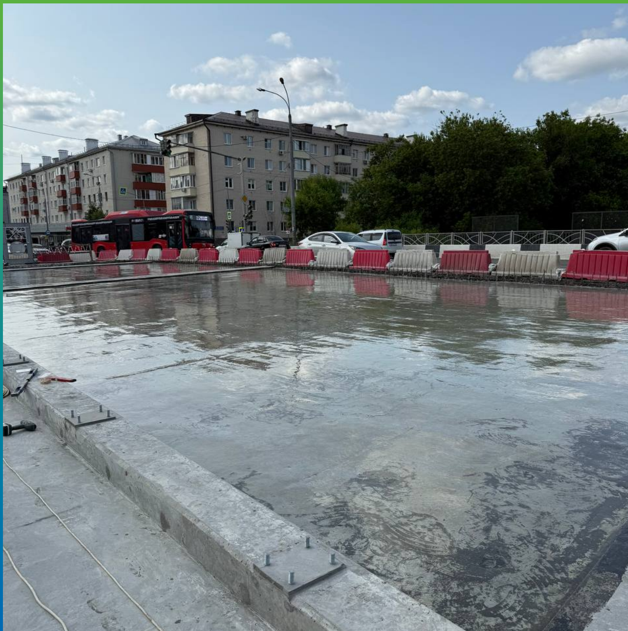
Поверхность после нанесения грунтовочного состава Манодил ПУ 90.
