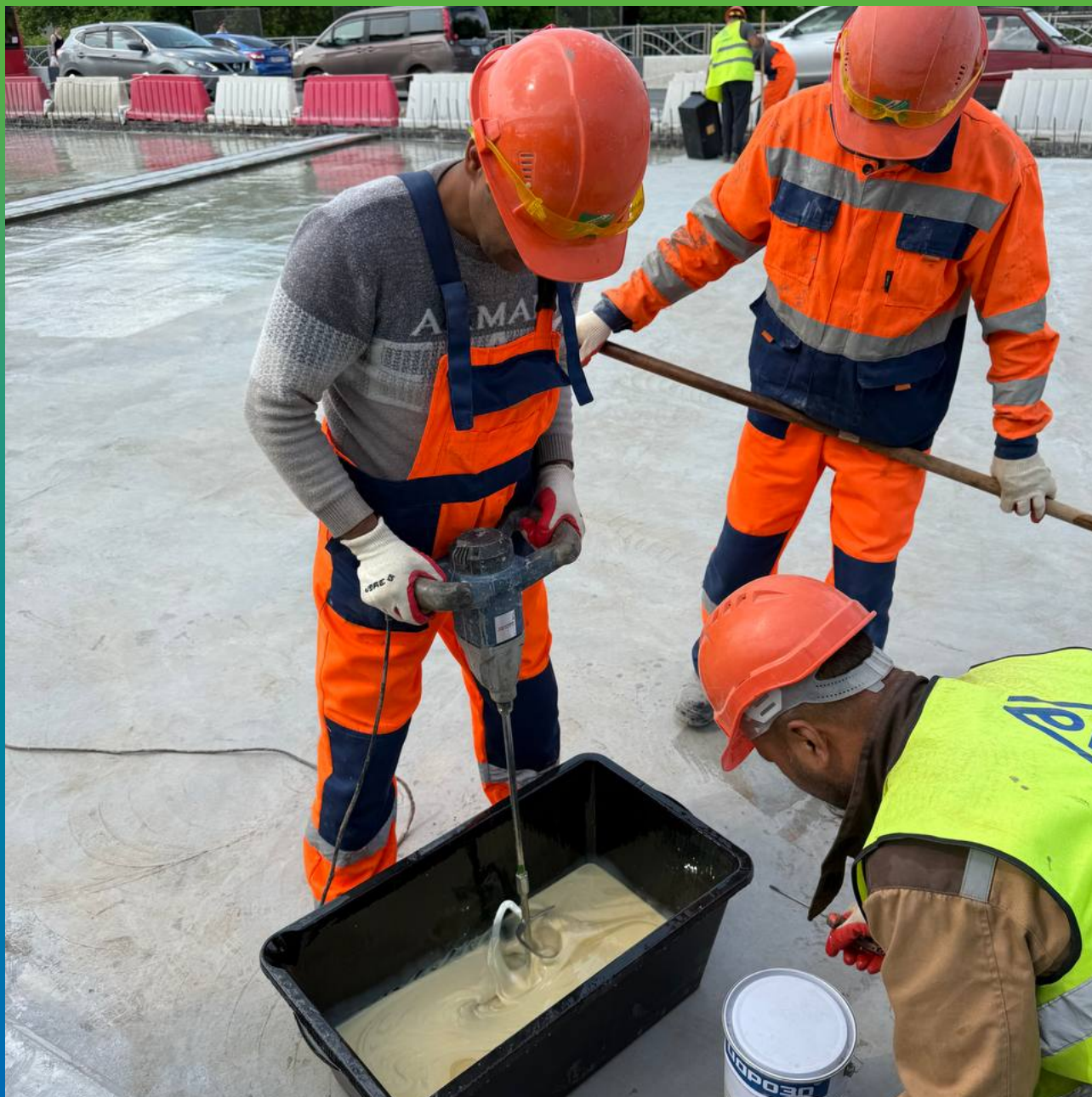
Процесс замешивания грунтовочного состава Манодил ПУ 90.
