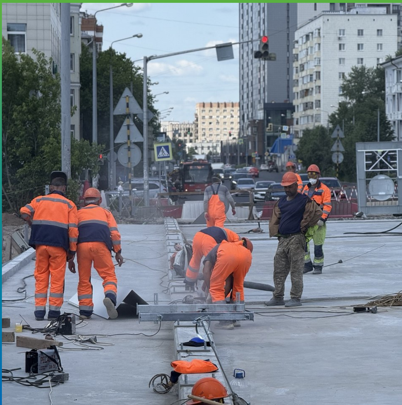
Подготовка поверхности стяжки для последующего нанесения состава Манодел ПУ 90.
