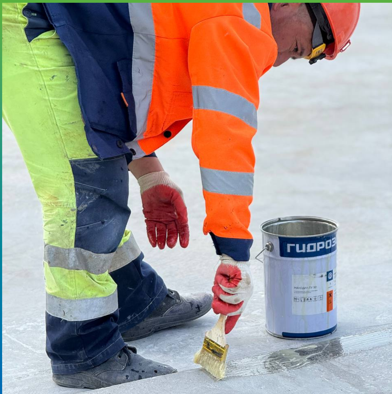
Нанесение Манодил ПУ 90 на стыки и швы.
