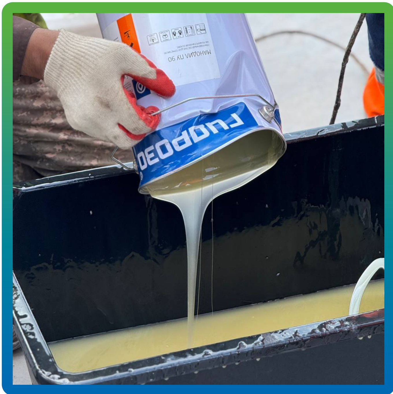
Процесс замешивания грунтовочного состава Мандил ПУ 90.
