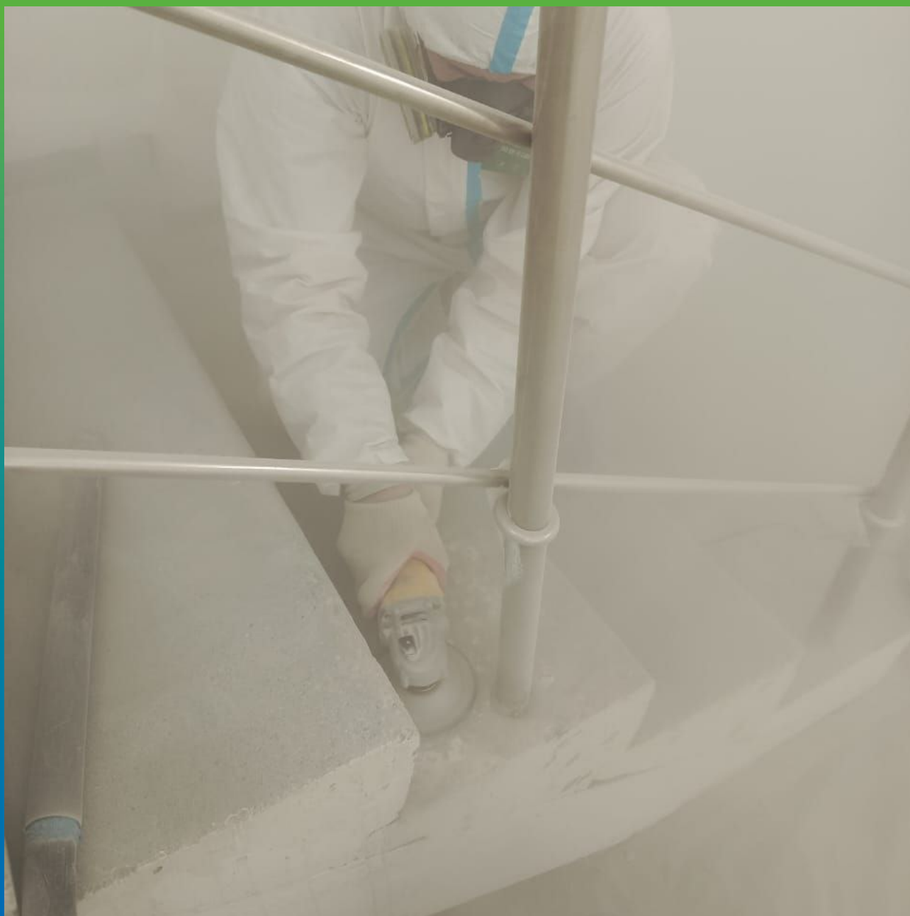
Шлифовка конструкций участка
