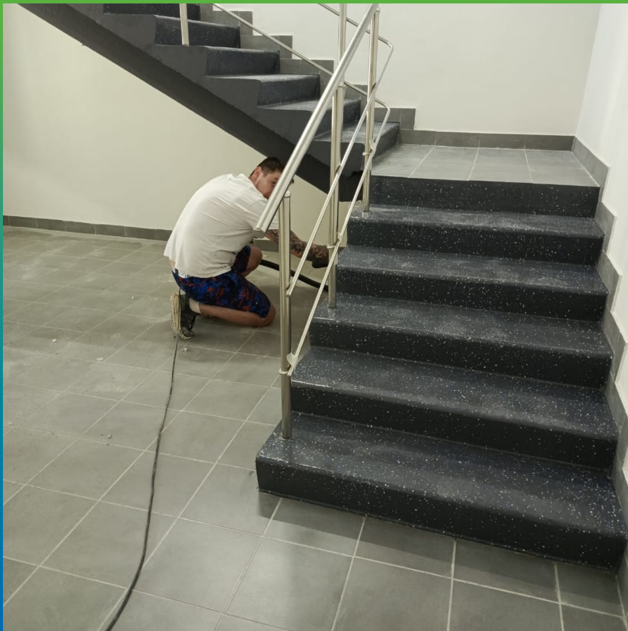
Уборка флоков и нанесение лака ДенсТоп ПУ 310
