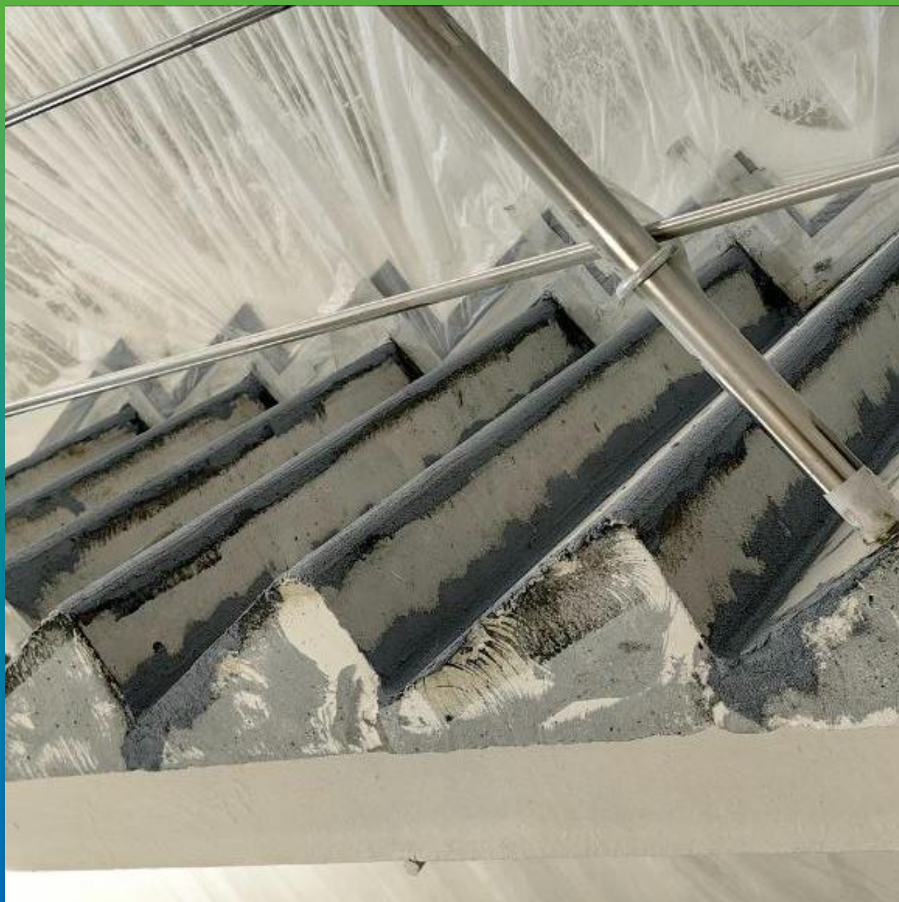
Отремонтированное основание. Общий вид
