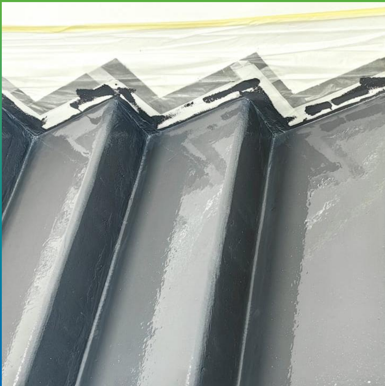
Нанесение ДенТоп ПУ 302 (второй слой)
