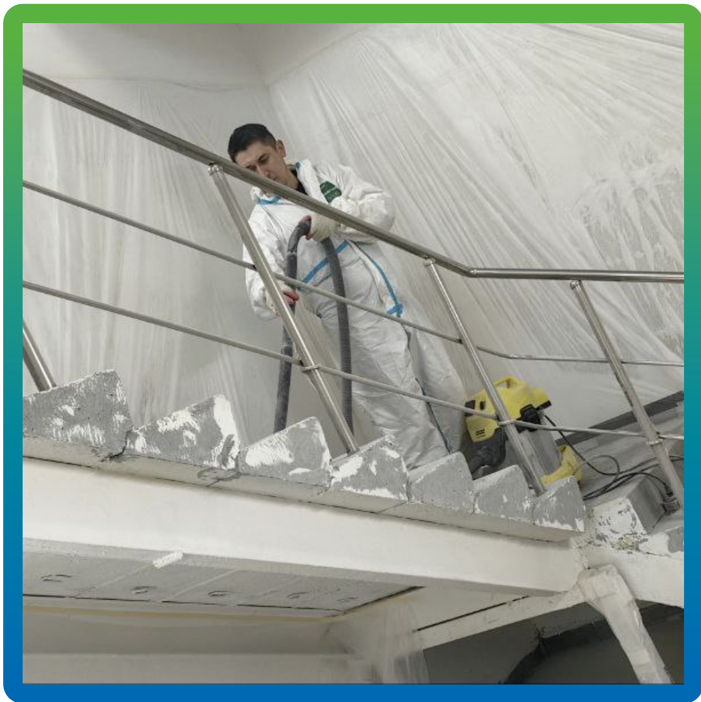
Общий вид обеспыливания конструкций участка
