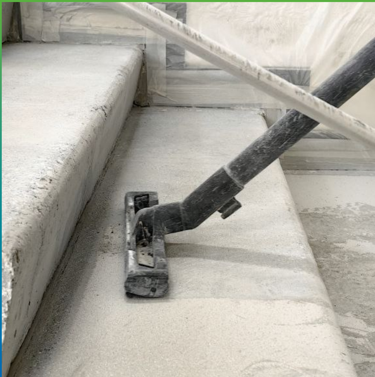
Обеспыливание конструкций участка
