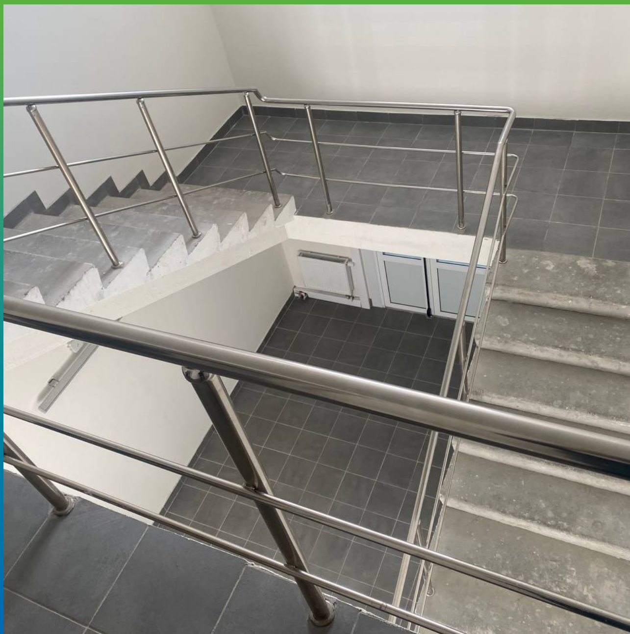
Вид участка. Лестница
