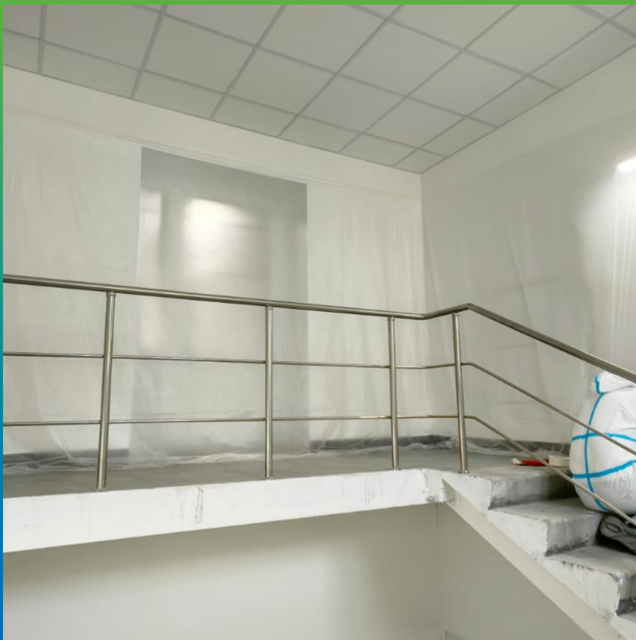
Подготовительные работы. Укрывные работы
