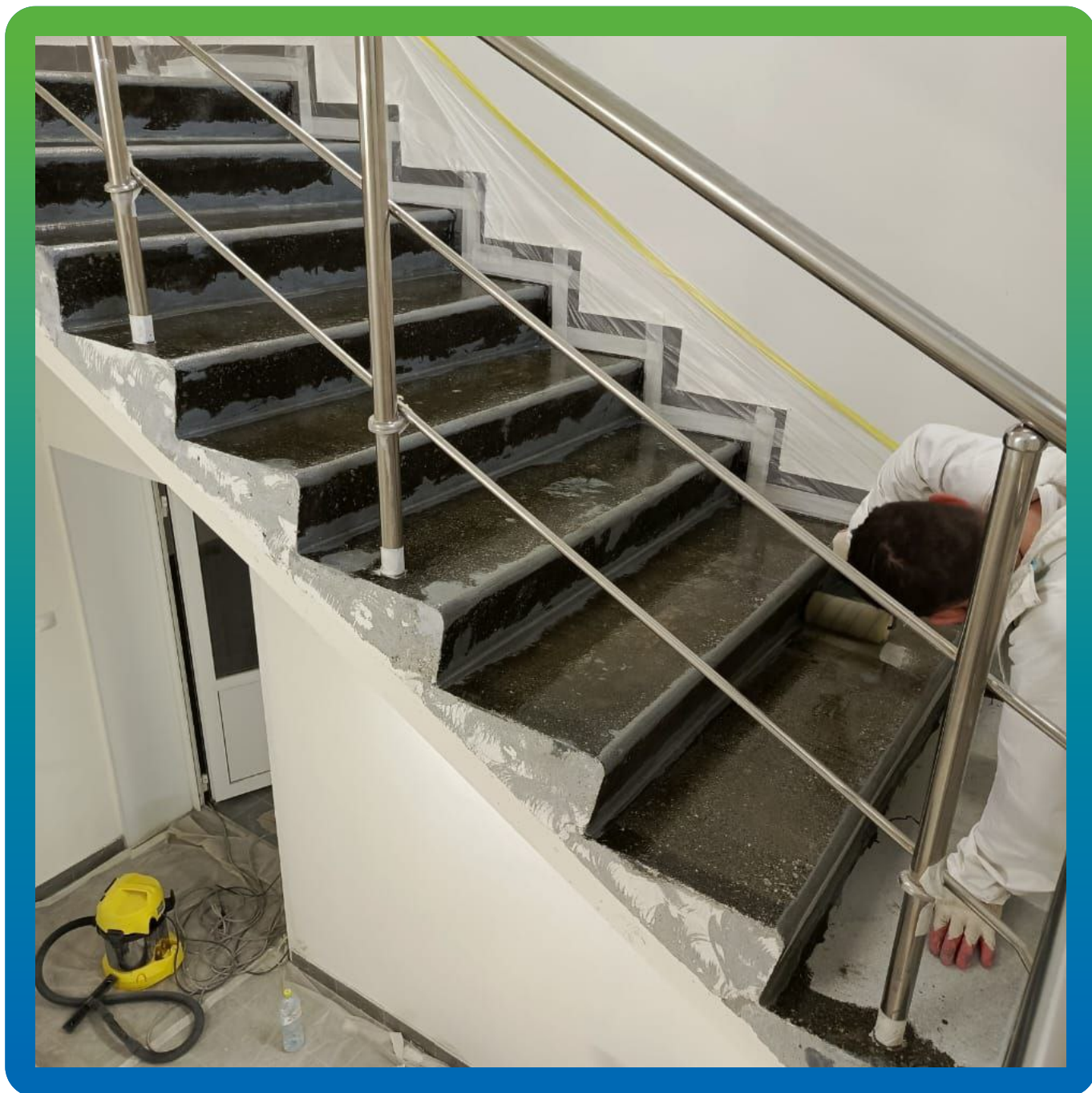
Грунтование всей поверхности составом ДенсоТоп ЭП 106. Другой вид
