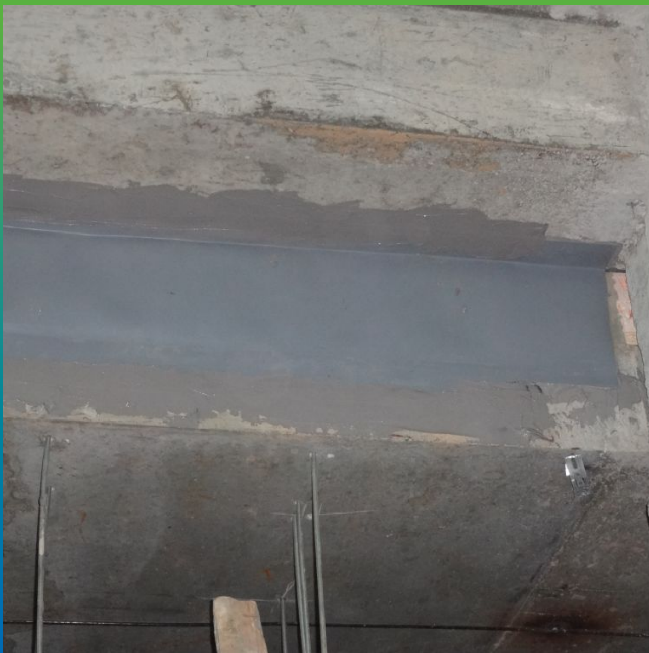
Монтаж ленты Манодил Про на эпоксидный состав Манопокс 331
