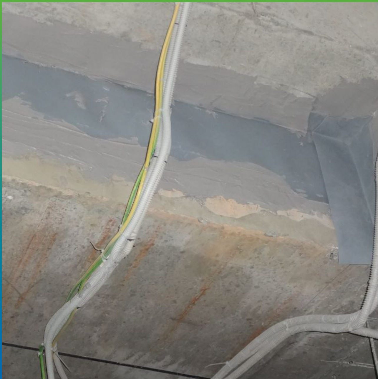
Монтаж углового элемента Манодил Про
