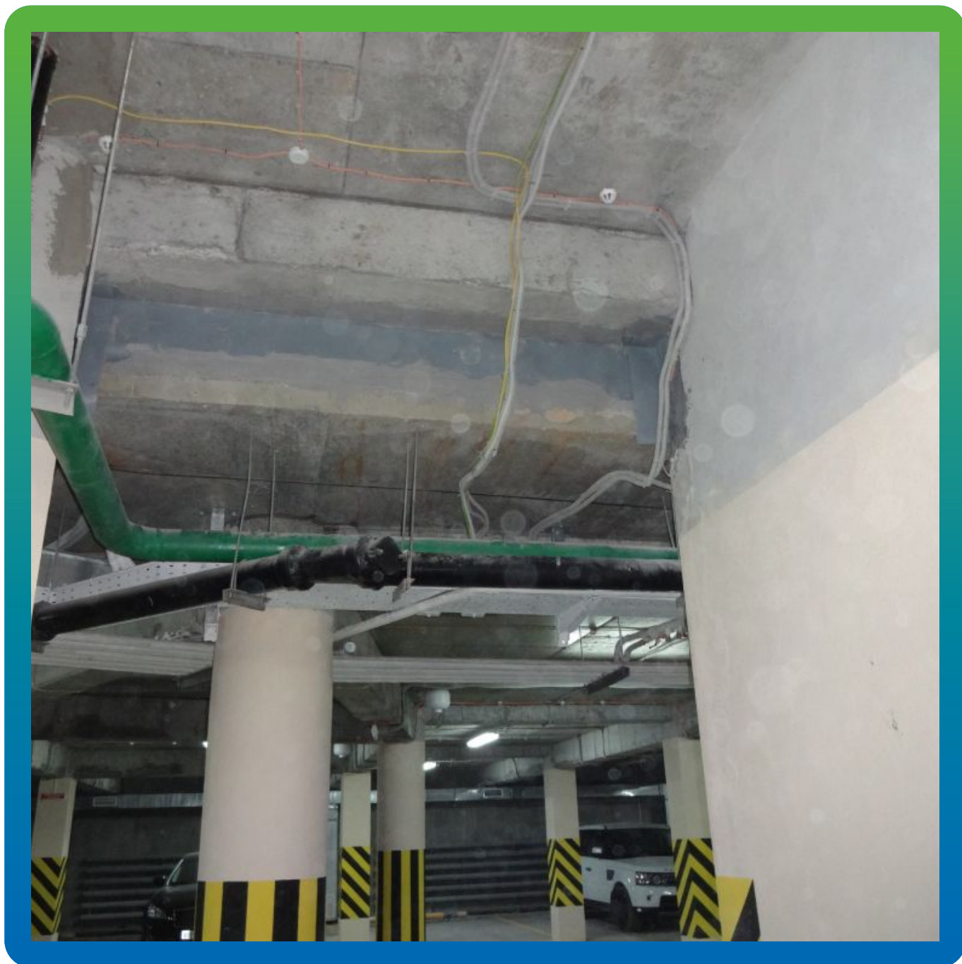
Вид на гидроизолированный деформационный шов
