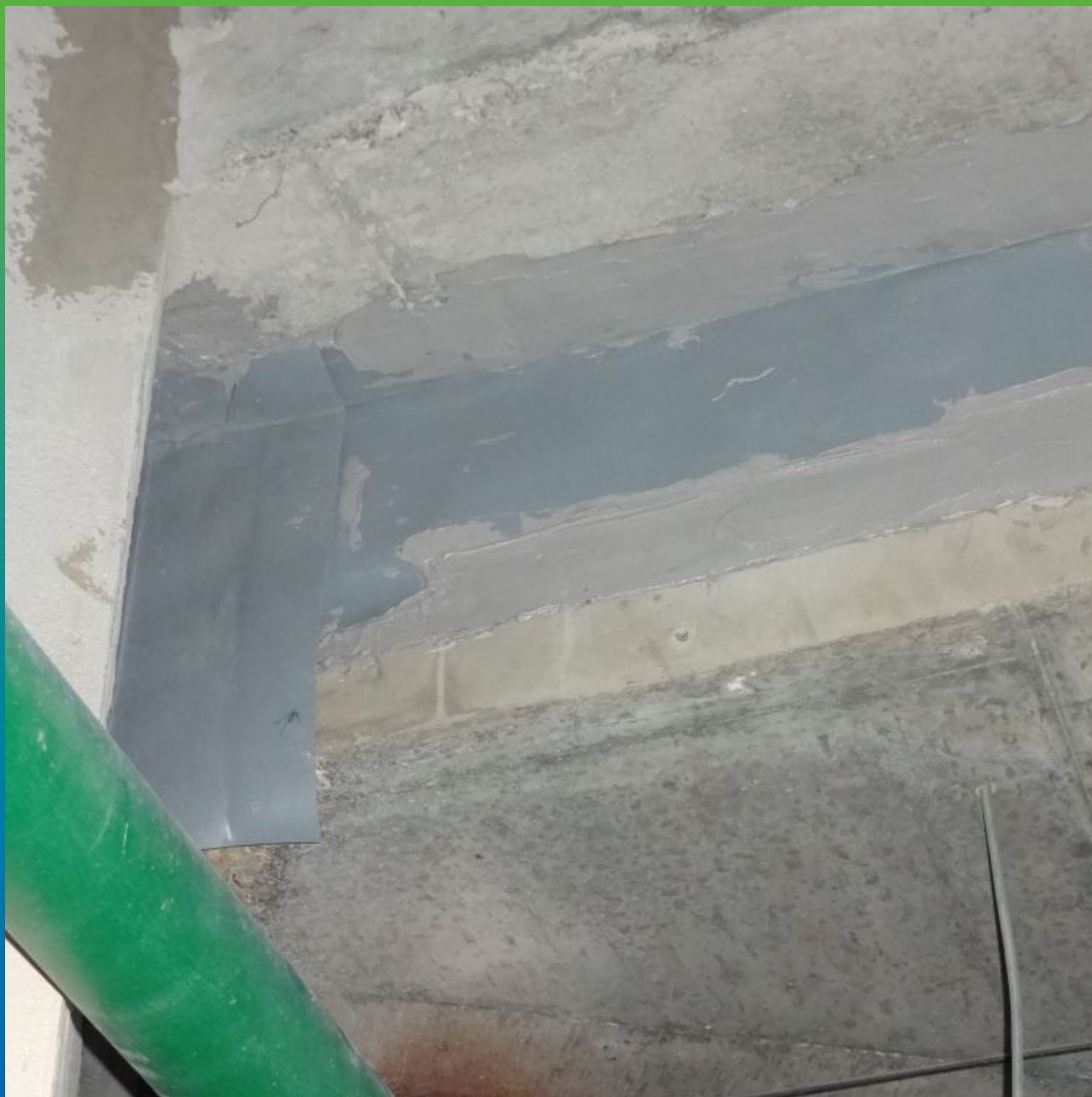
Монтаж углового элемента Манодил Про
