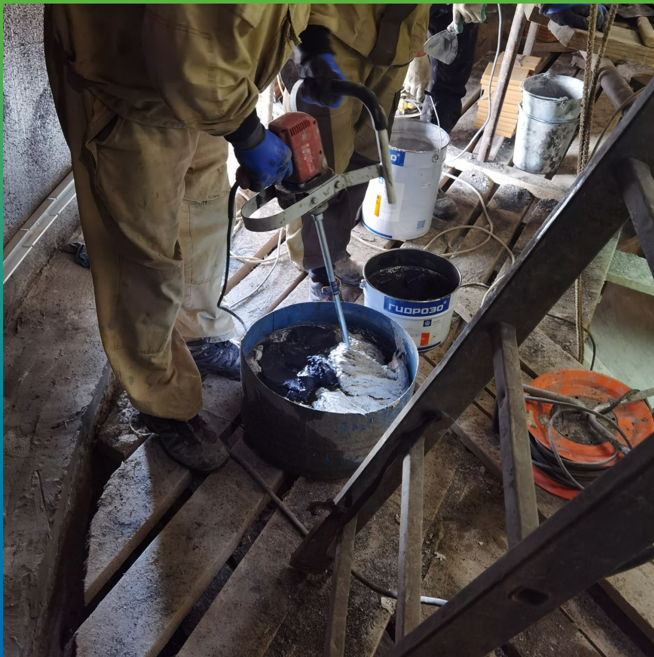
Перемешивание м/у собой двух компонентов Манопкс 331
