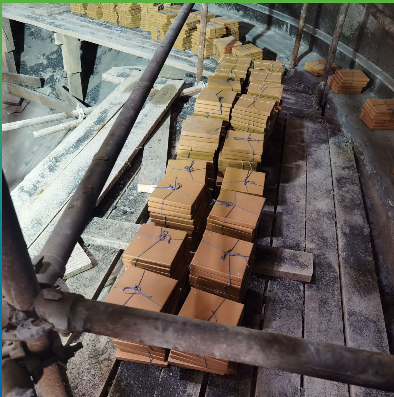
Распределение по объекту кислотоупорной плитки
