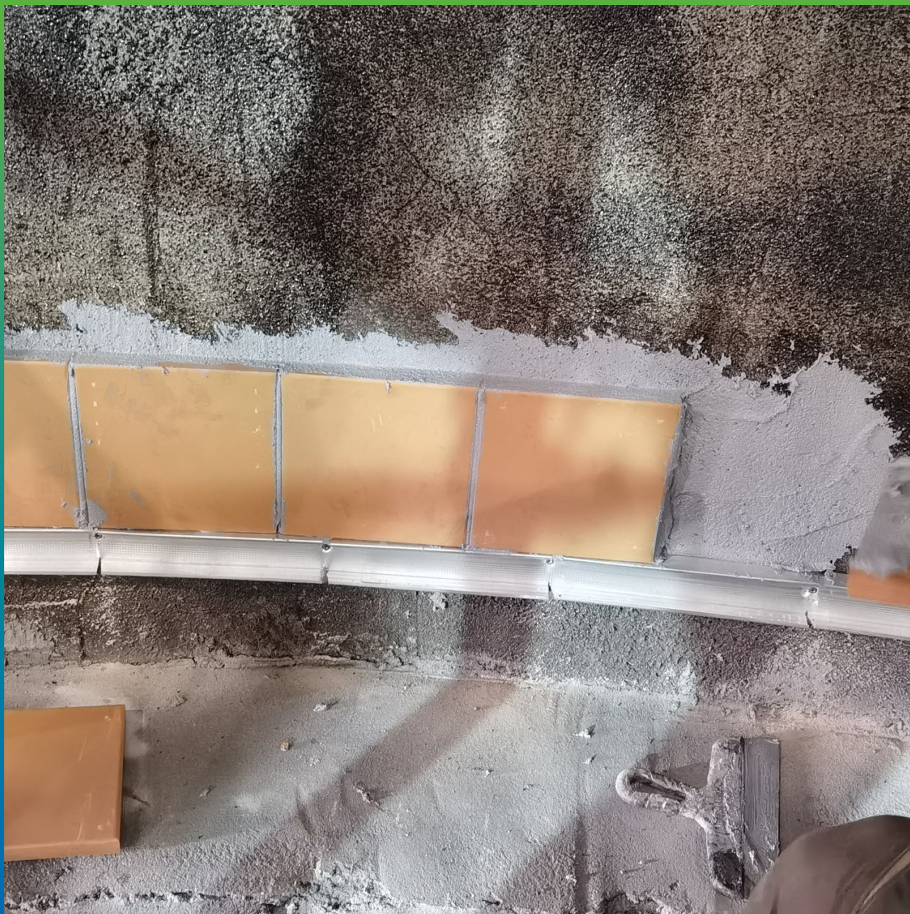
Монтаж кислотоупорной плитки на эпоксидный состав Манопокс 331
