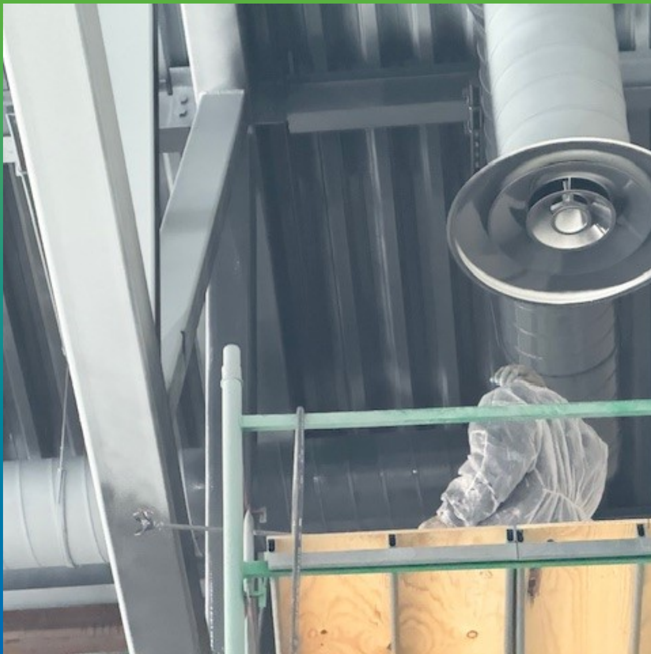
Нанесение ДенсТоп ПУ 113 на вентиляционные оцинкованные трубы.
