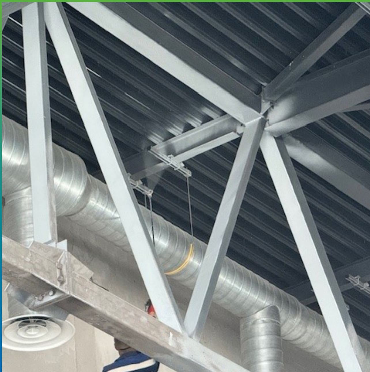
Нанесение ДенТоп ПУ 113 на металлоконструкции
