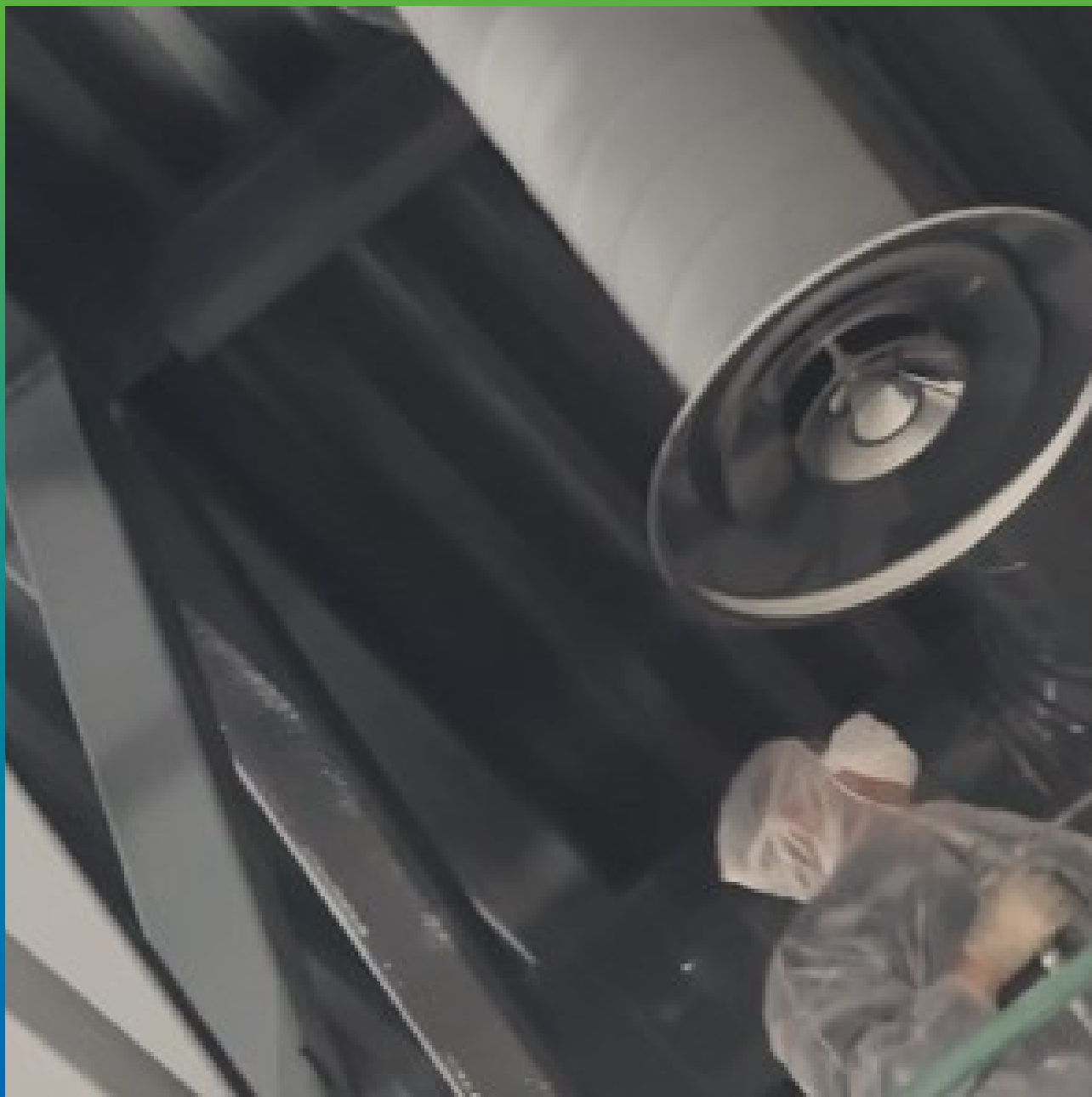
Нанесение ДенсТоп ПУ 302 на вентиляционные оцинкованные трубы
