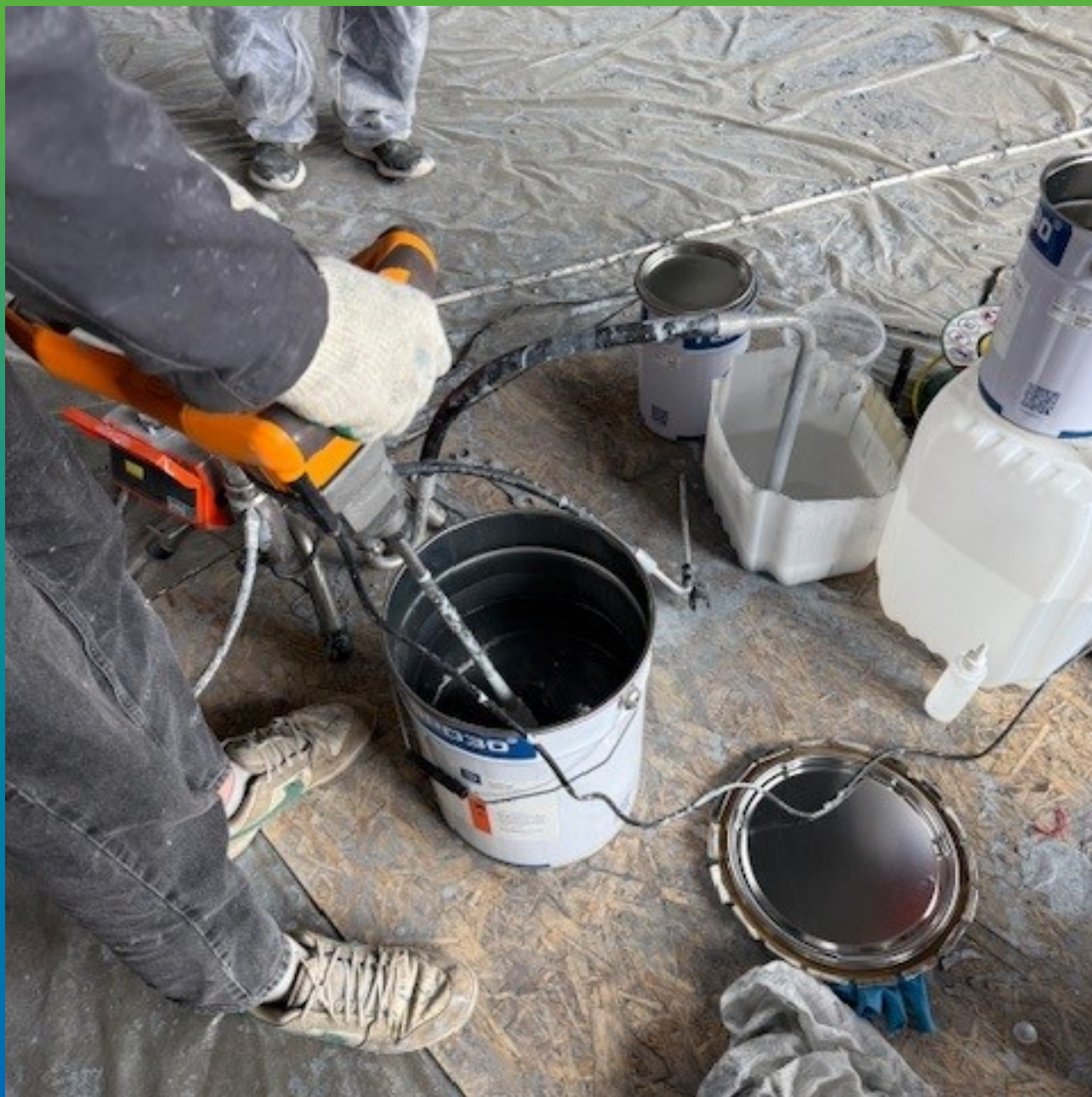
Замешивание ДенТоп ПУ 302 перед нанесением на металлоконструкции
