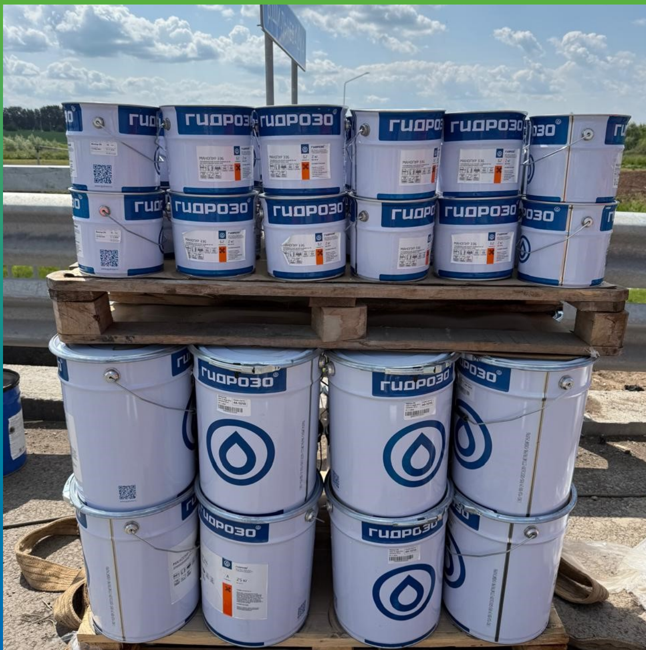
Материал, подготовленный к нанесению
