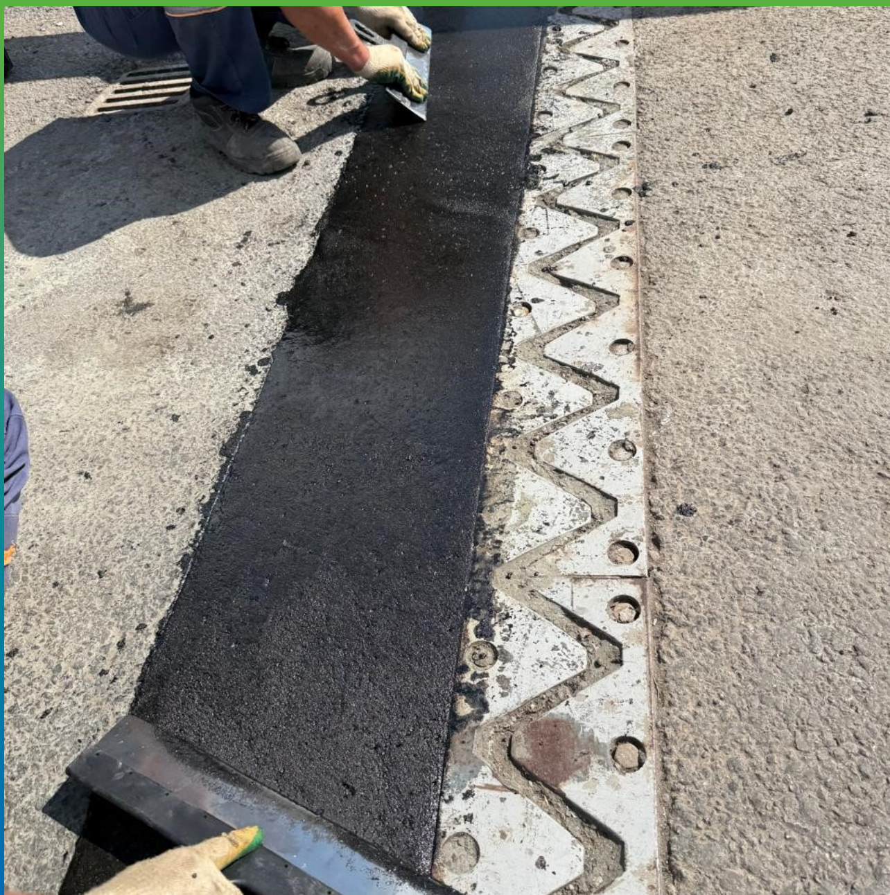
Заглаживание материала в штрабе
