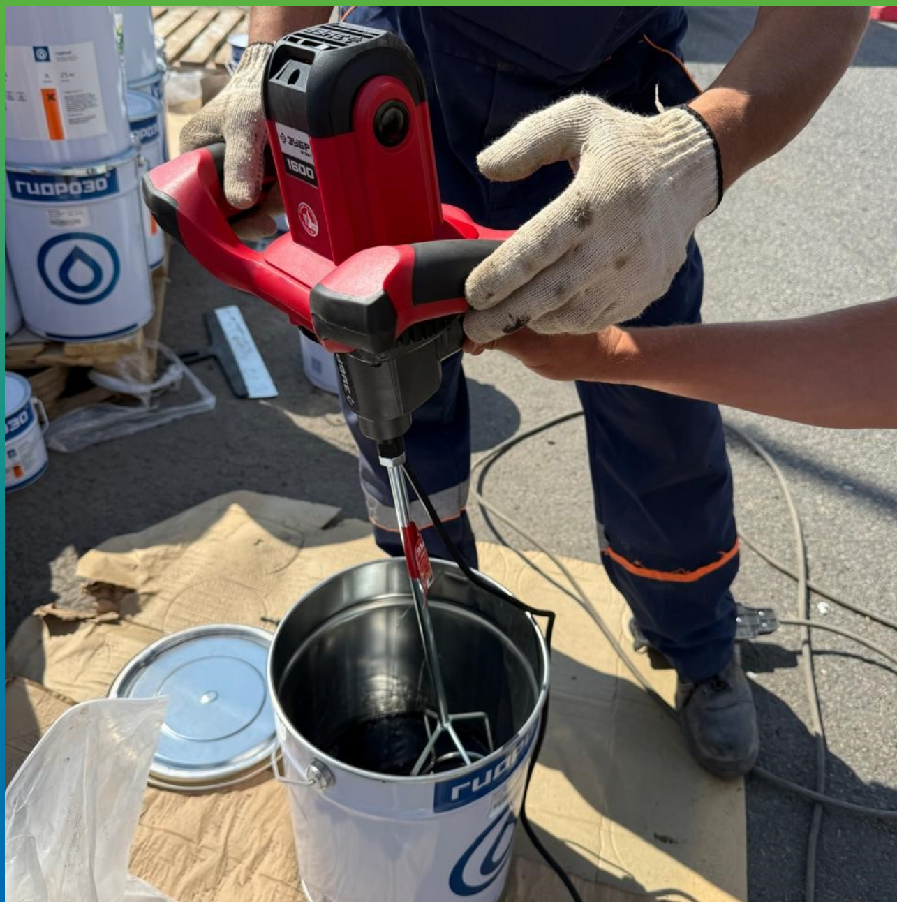
Смешивание компонентов Б1 и Б2 Манопур 336
