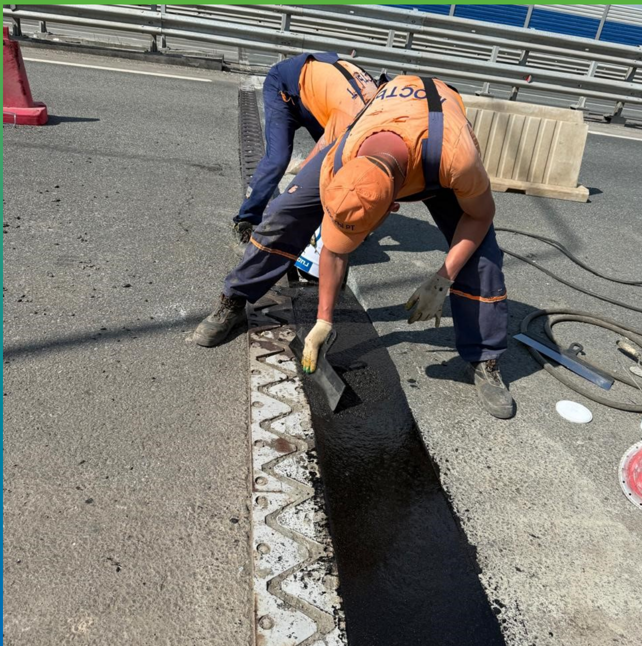
Заглаживание материала в штрабе
