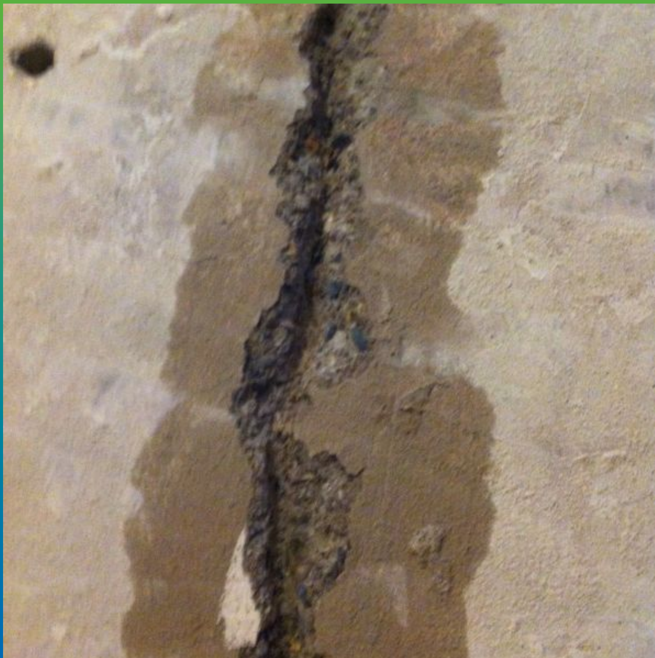
Расшивка трещины
