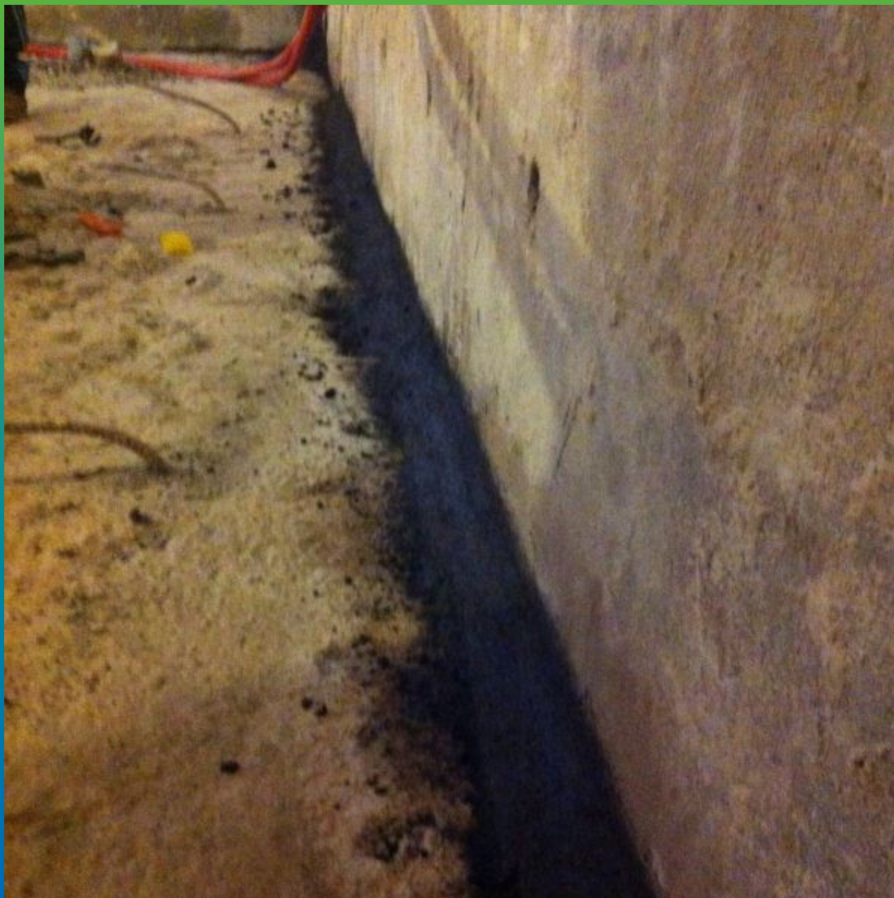
Заполнение штрабы ремонтным составом Максрест
