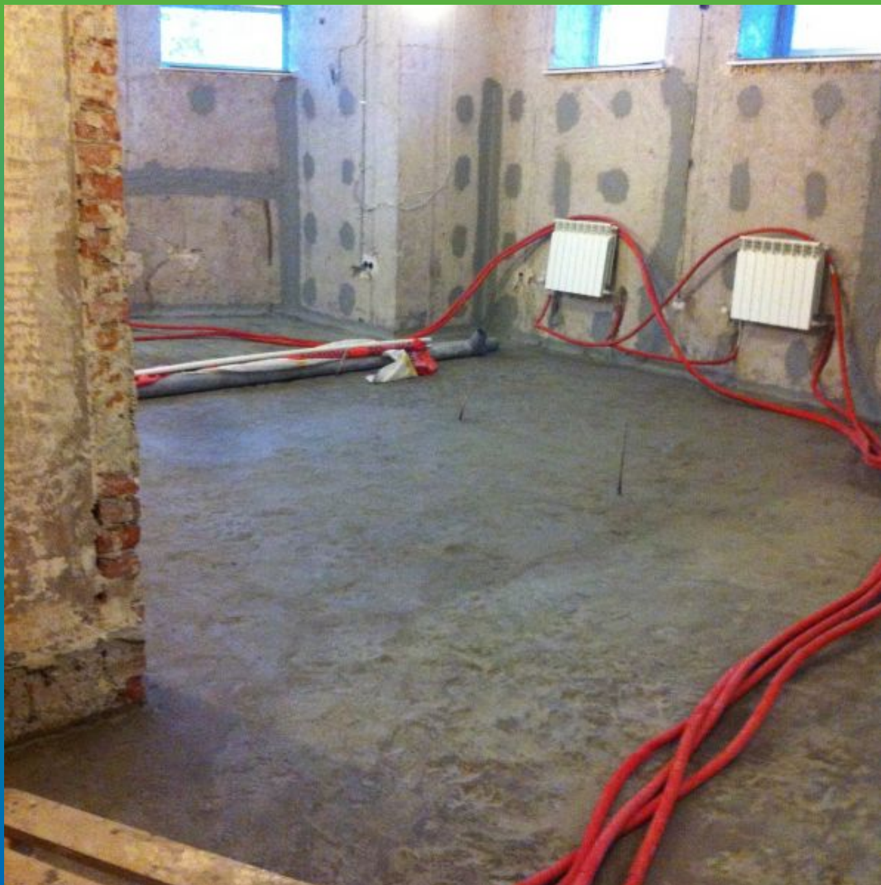
Зачеканенные швы и пол, покрытый составом Стармекс Сил Флекс
