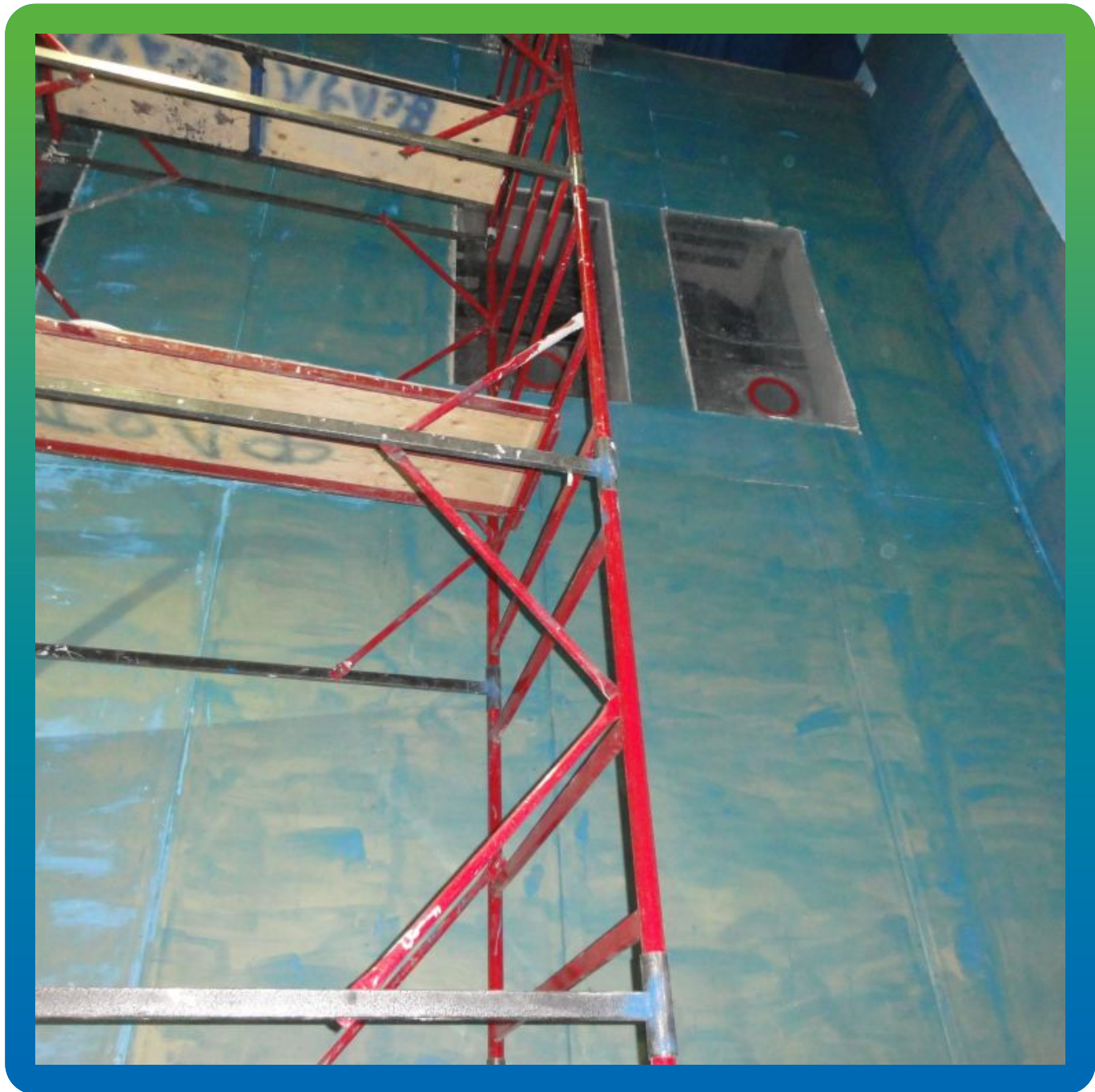
Вид нанесенного первого слоя
