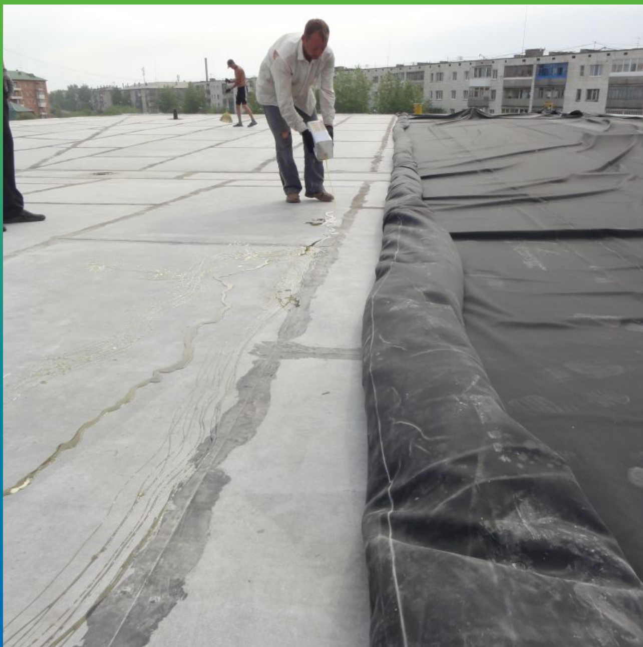
Приклеивание ЭПДМ мембраны к основанию с помощью адгезива П400
