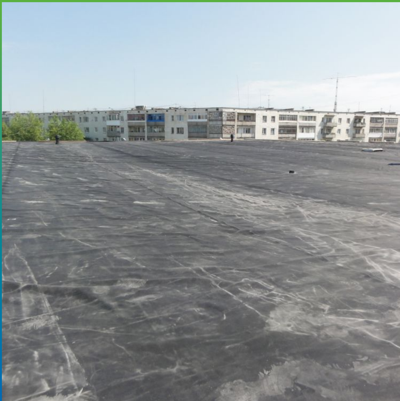
Финальный вид кровли
