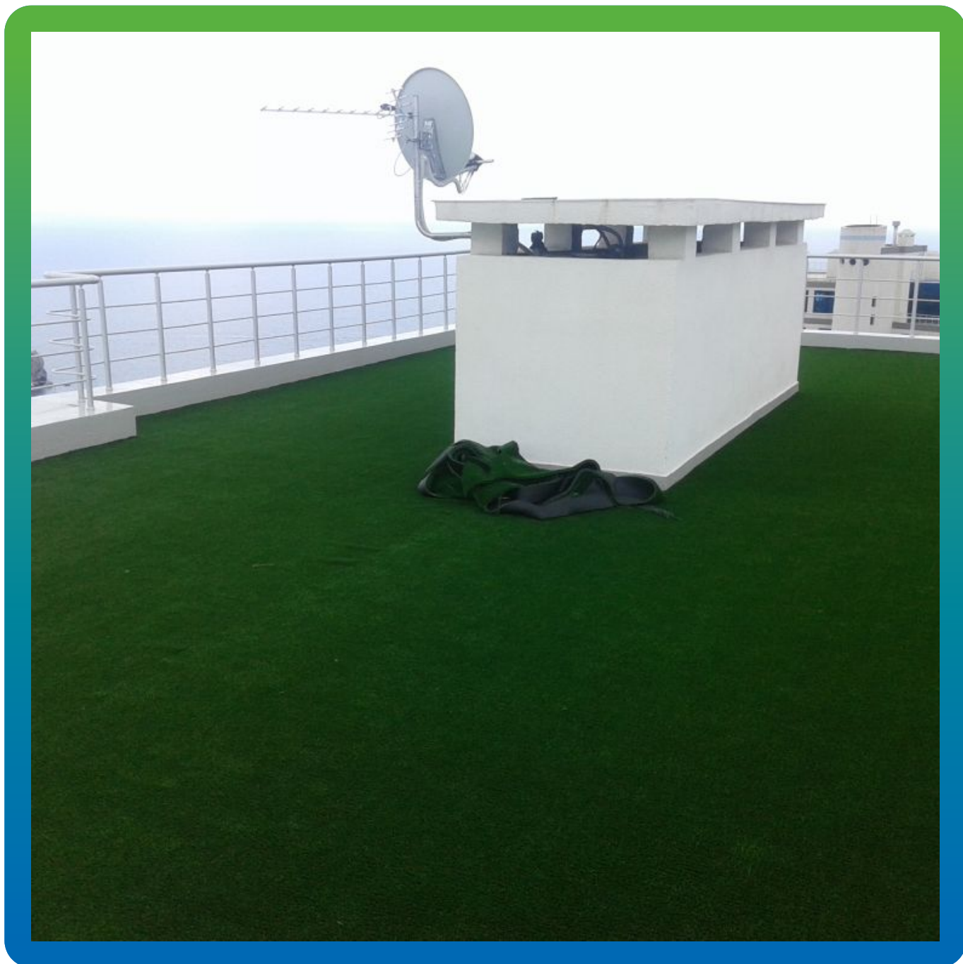
Укладка искусственного газона
