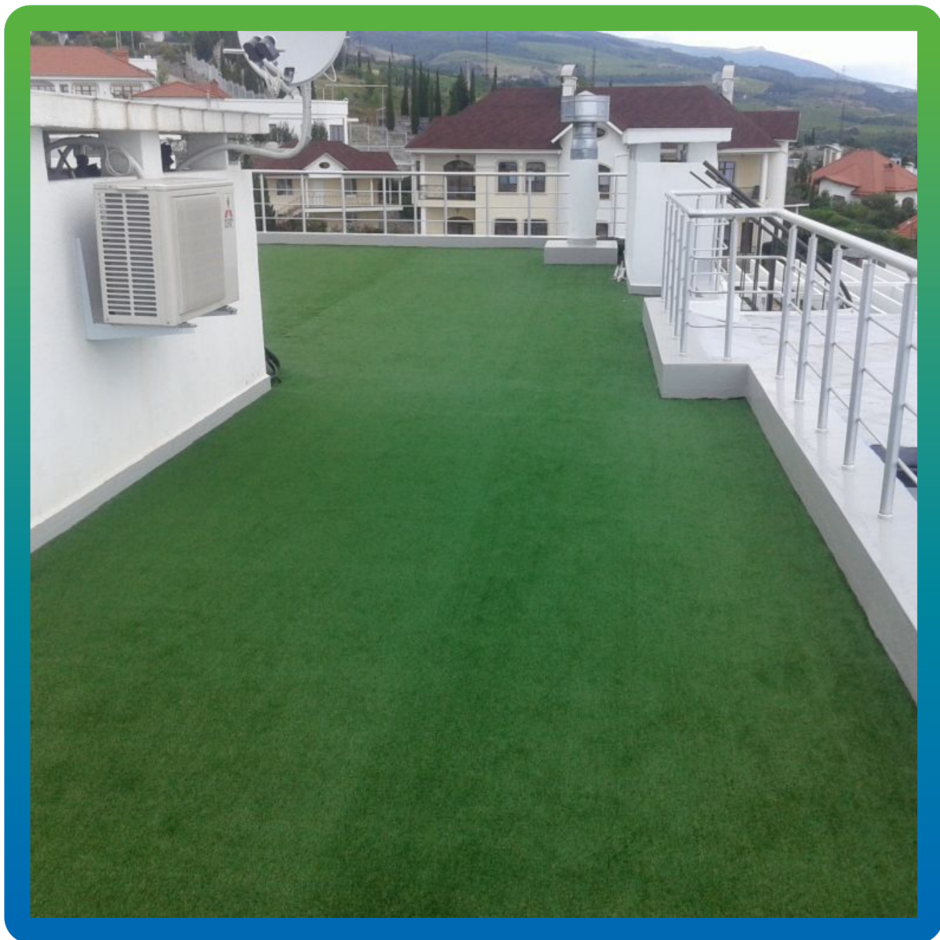
Укладка искусственного газона
