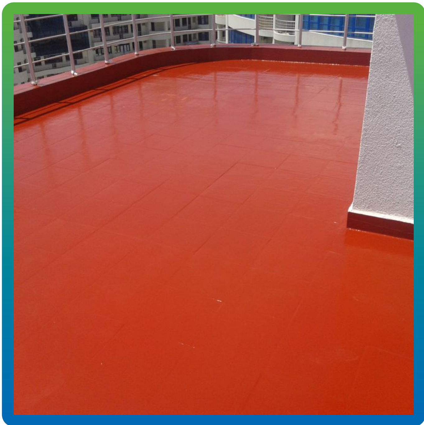
Нанесение первого слоя Максэластик Пур
