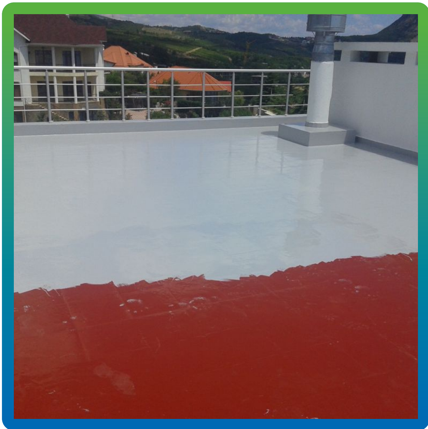
Нанесение второго слоя
