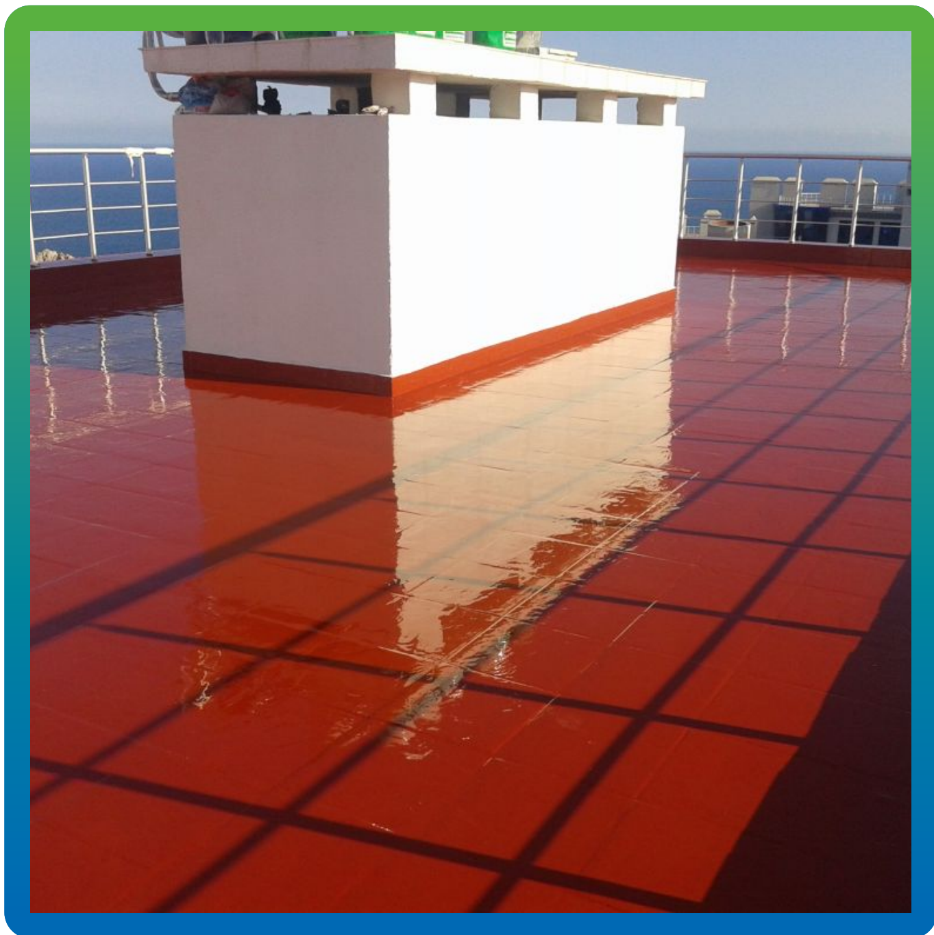
Нанесение первого слоя Максэластик Пур
