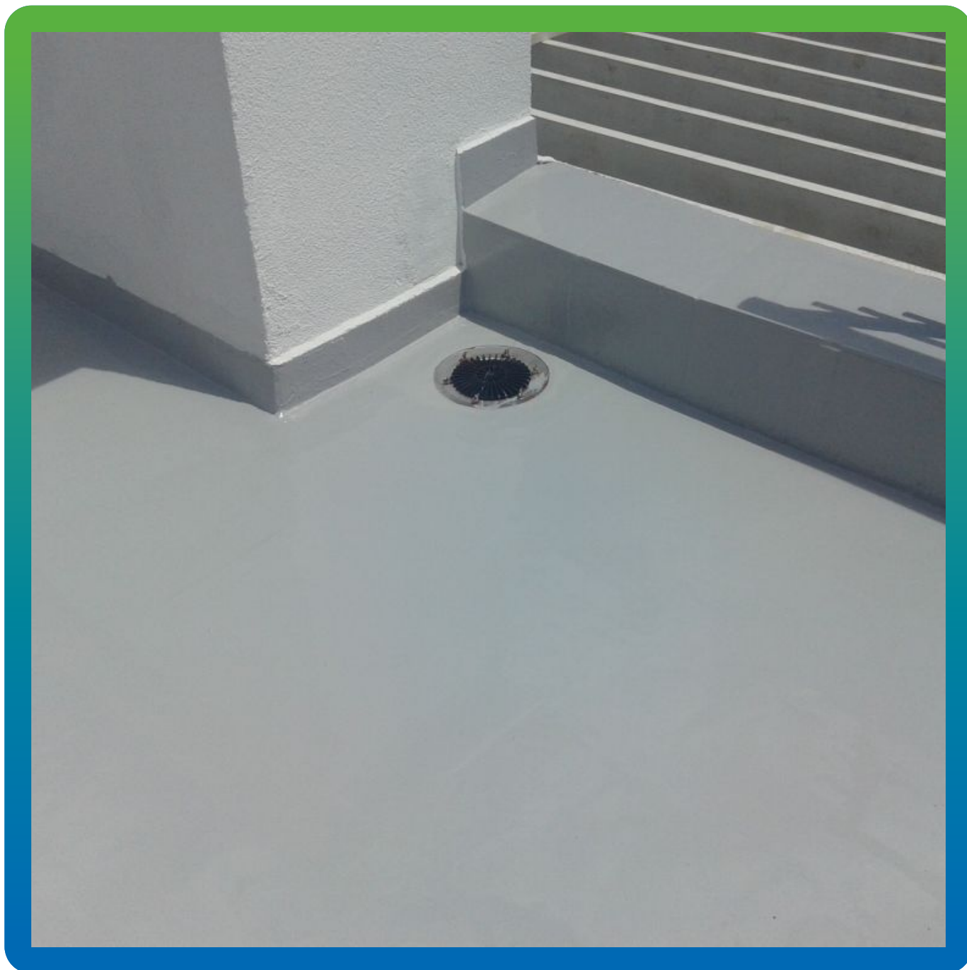
Нанесение второго слоя
