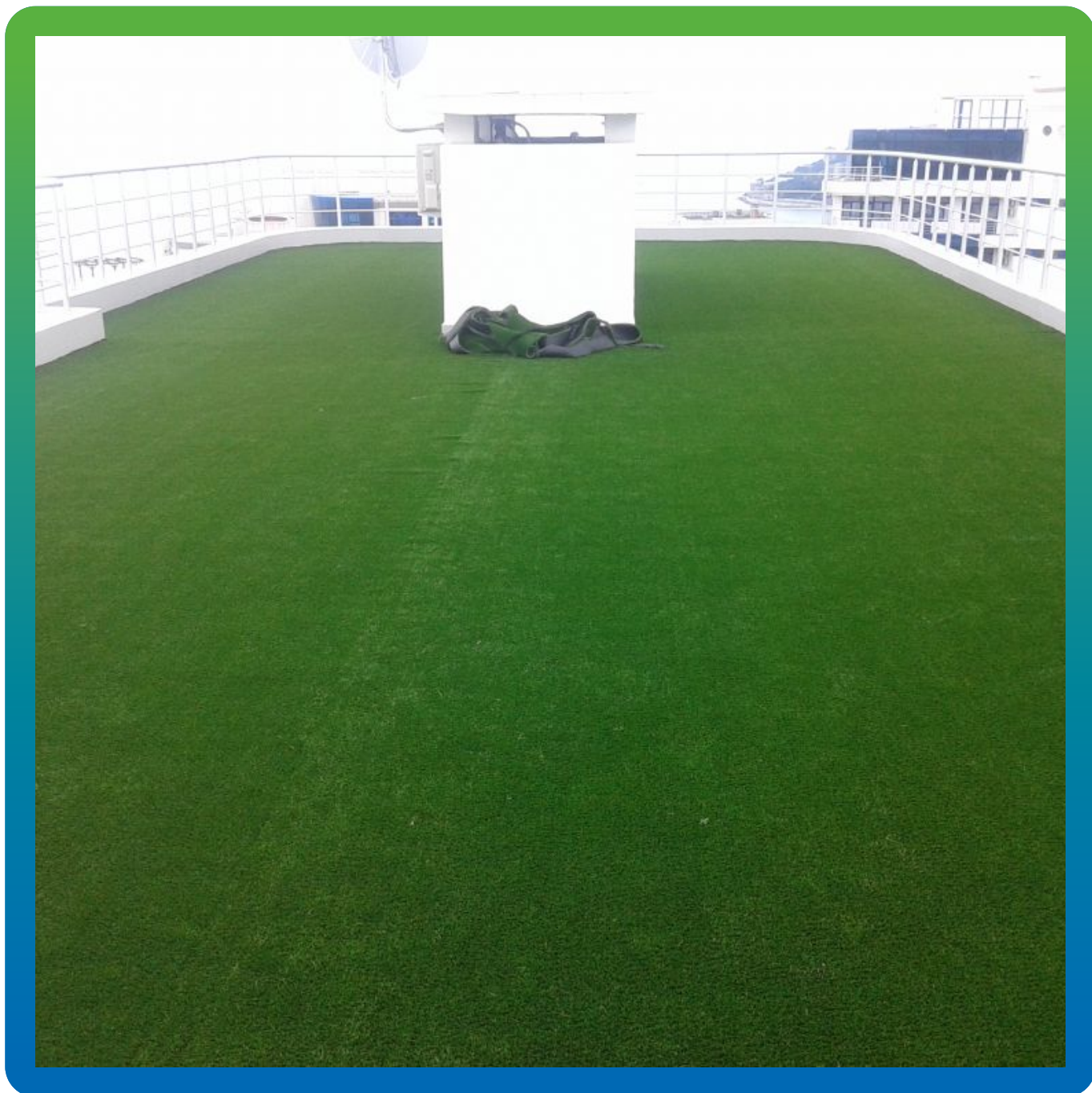
Укладка искусственного газона
