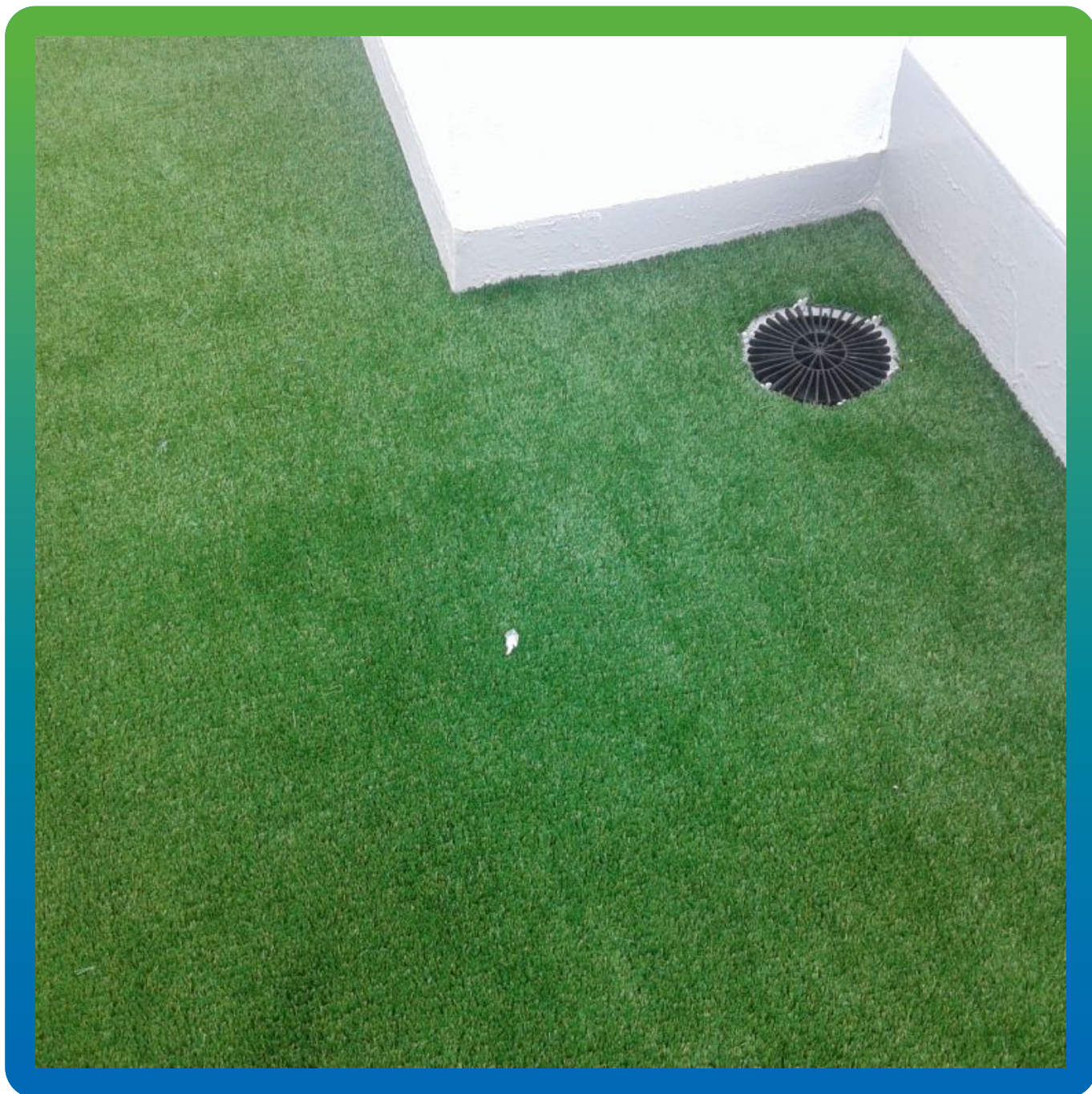
Укладка искусственного газона
