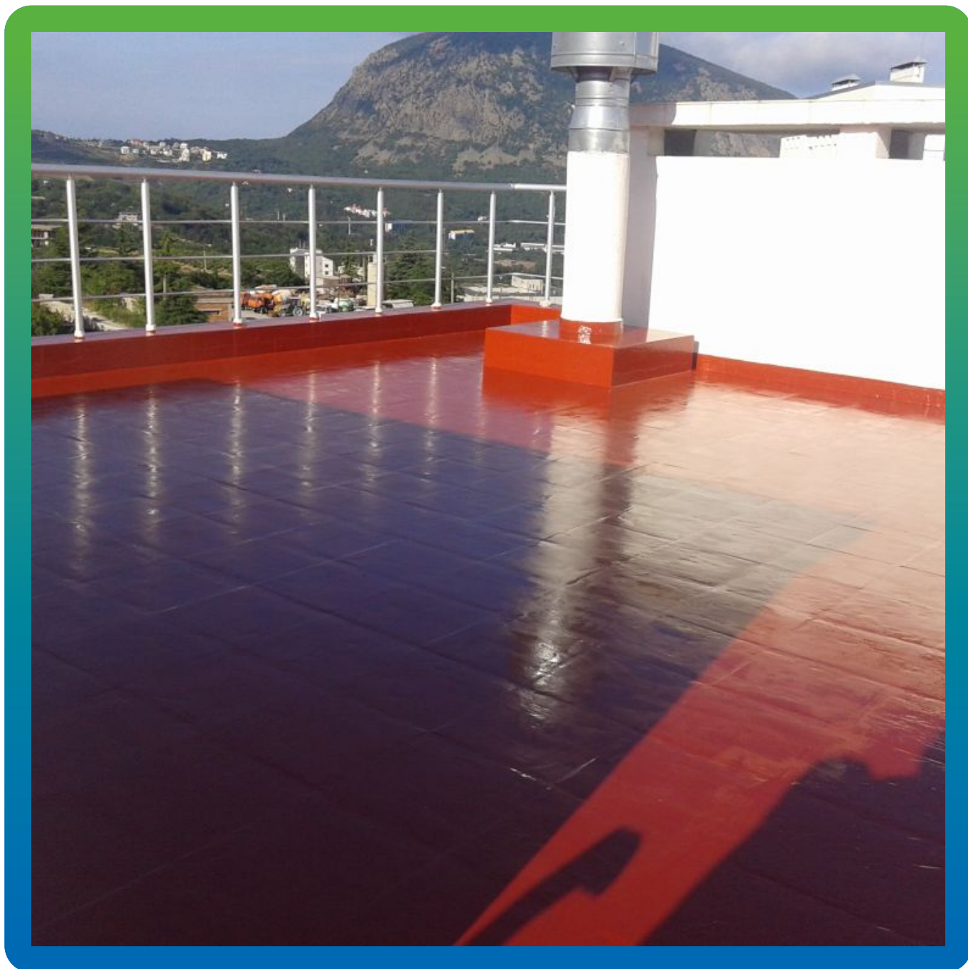
Нанесение первого слоя Максэластик Пур
