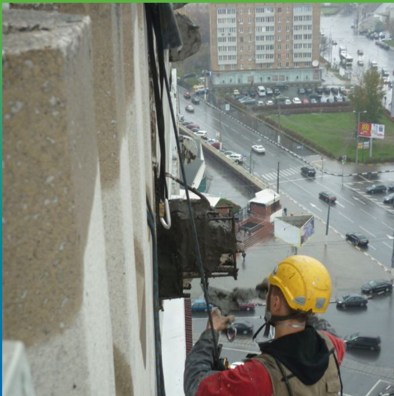
Нанесение ремонтного материала Макрест
