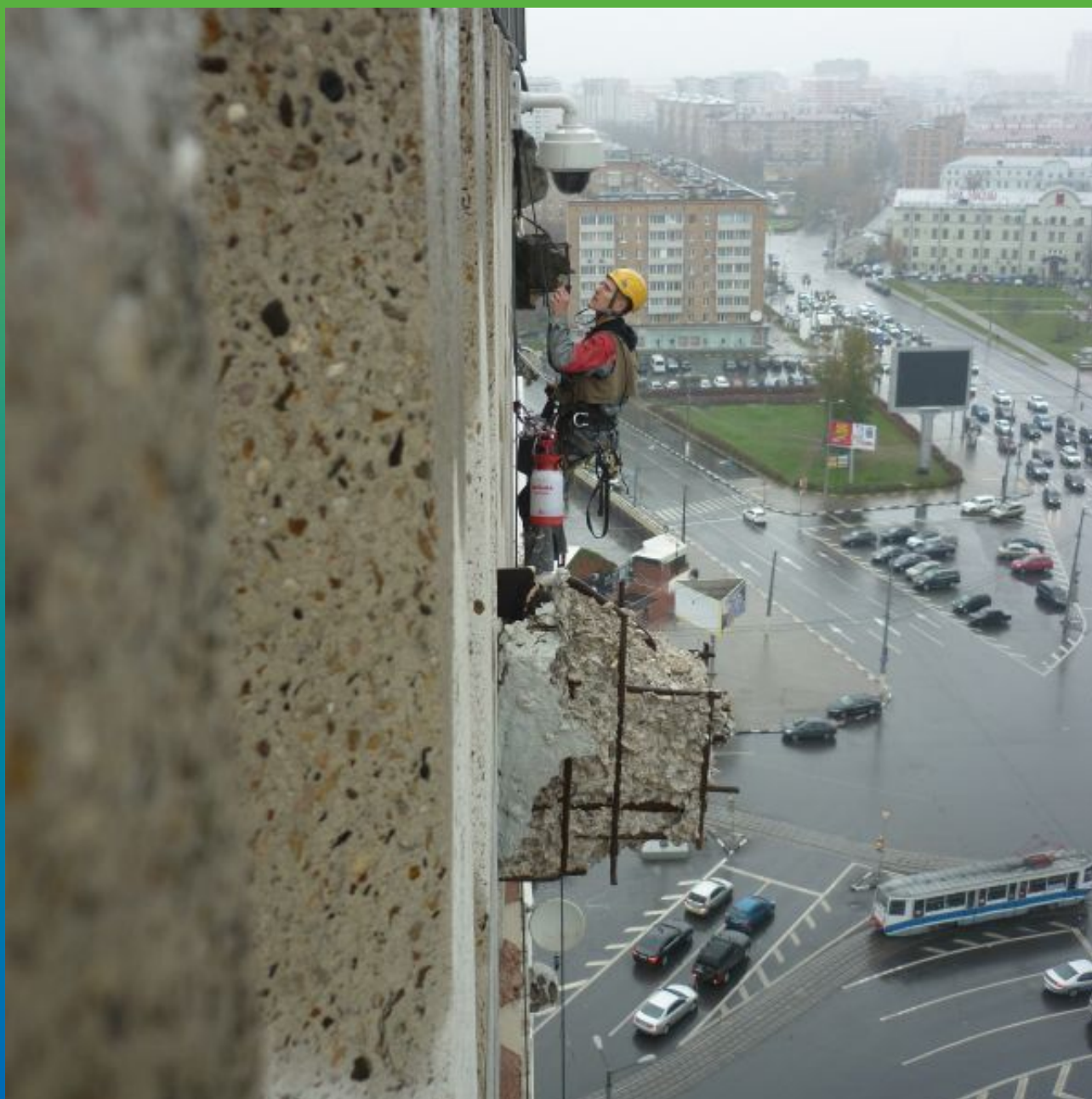
Нанесение ремонтного материала Макрест
