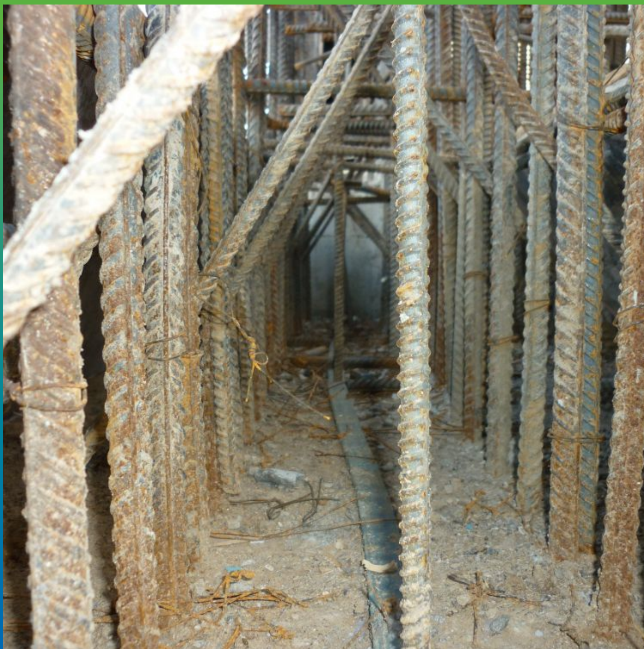
Герметизация холодных швов узла примыкания Манодил Свелл 2003
