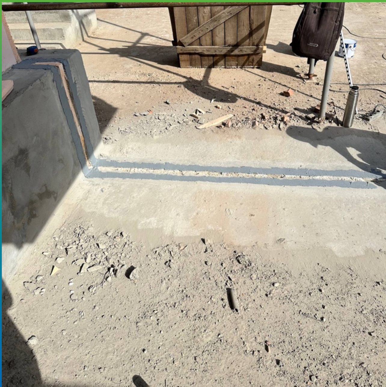
Манопокс 331, нанесенный на кромки шва
