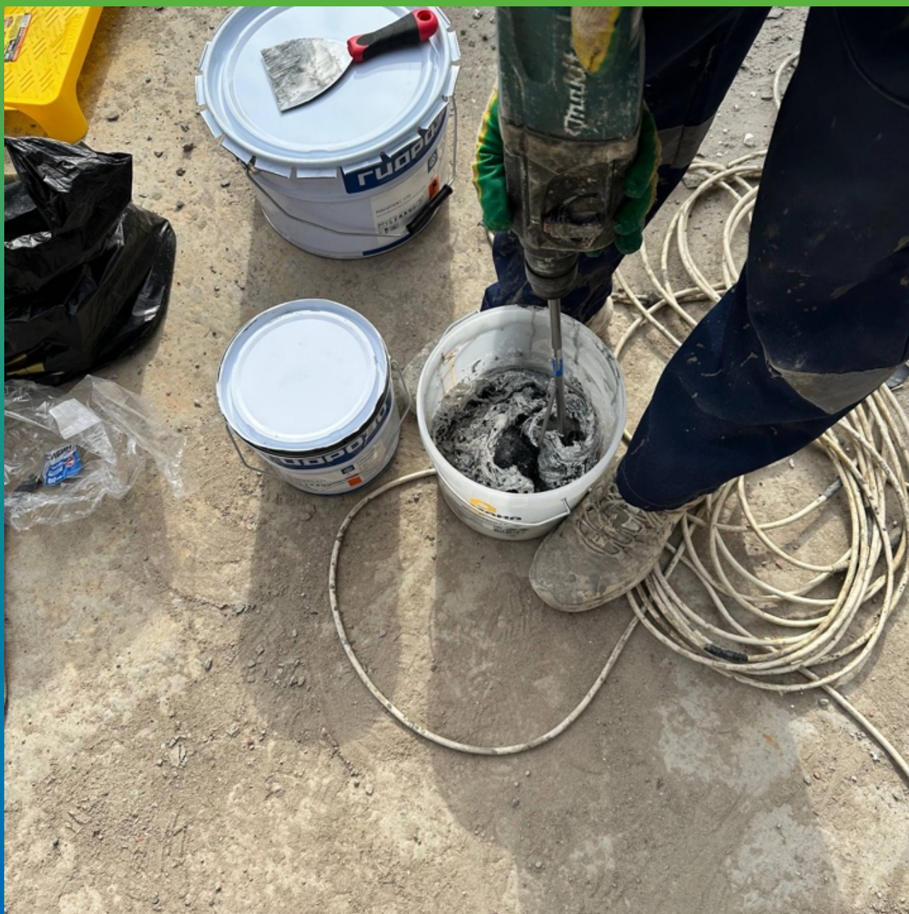
Перемешивание компонентов миксером
