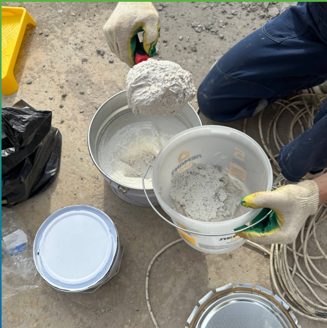
Смешивание компонентов клея Манопокс 331
