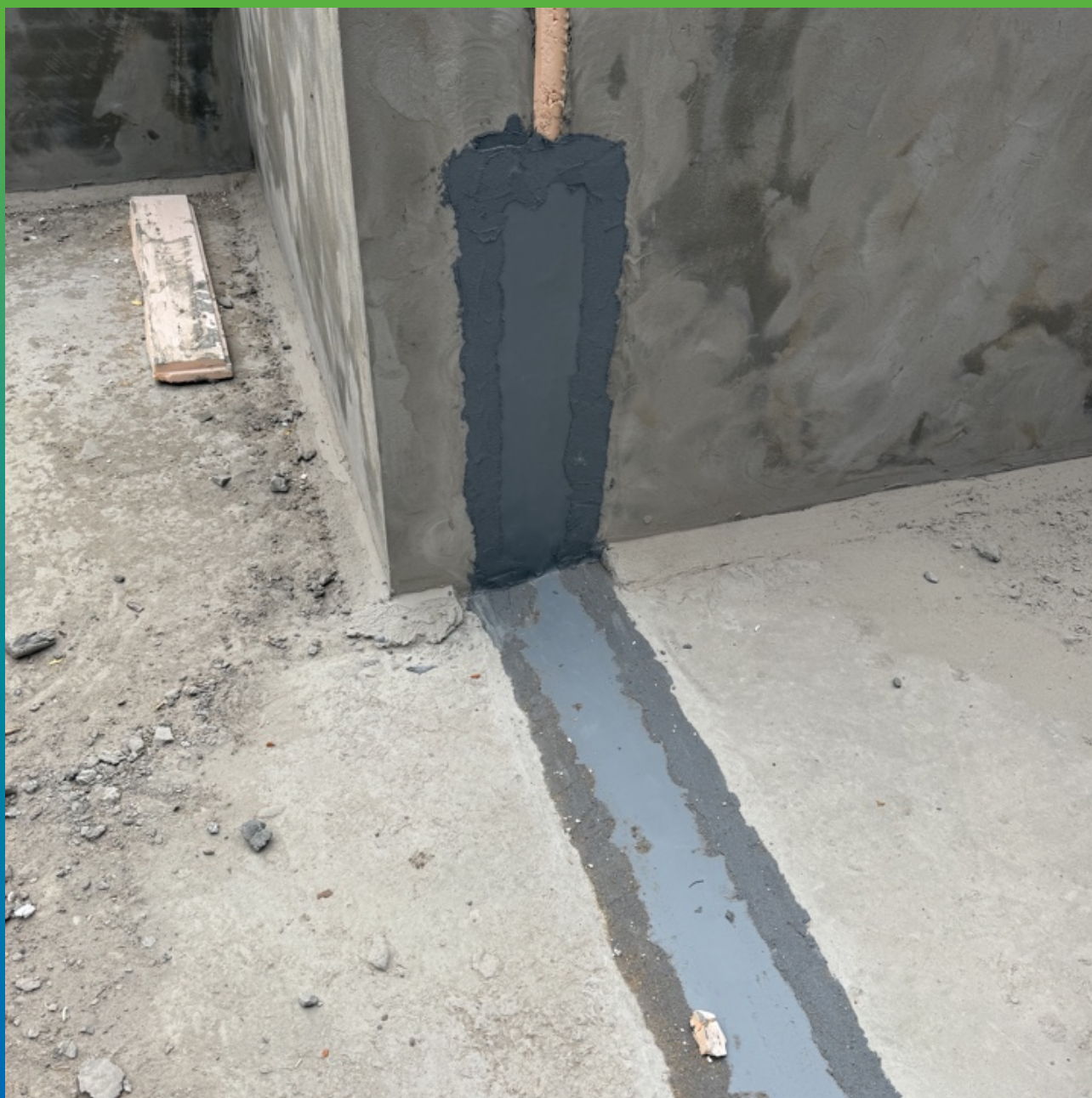
Манопокс 331 и Манодил Про на деформационном шве
