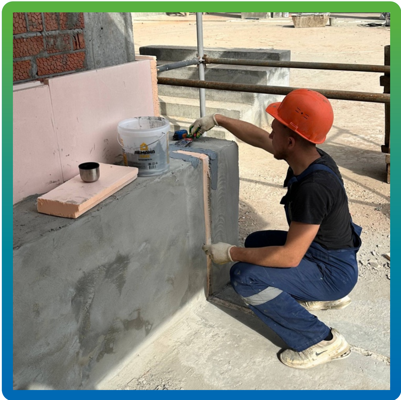
Нанесение Манопокс 331 на кромки шва
