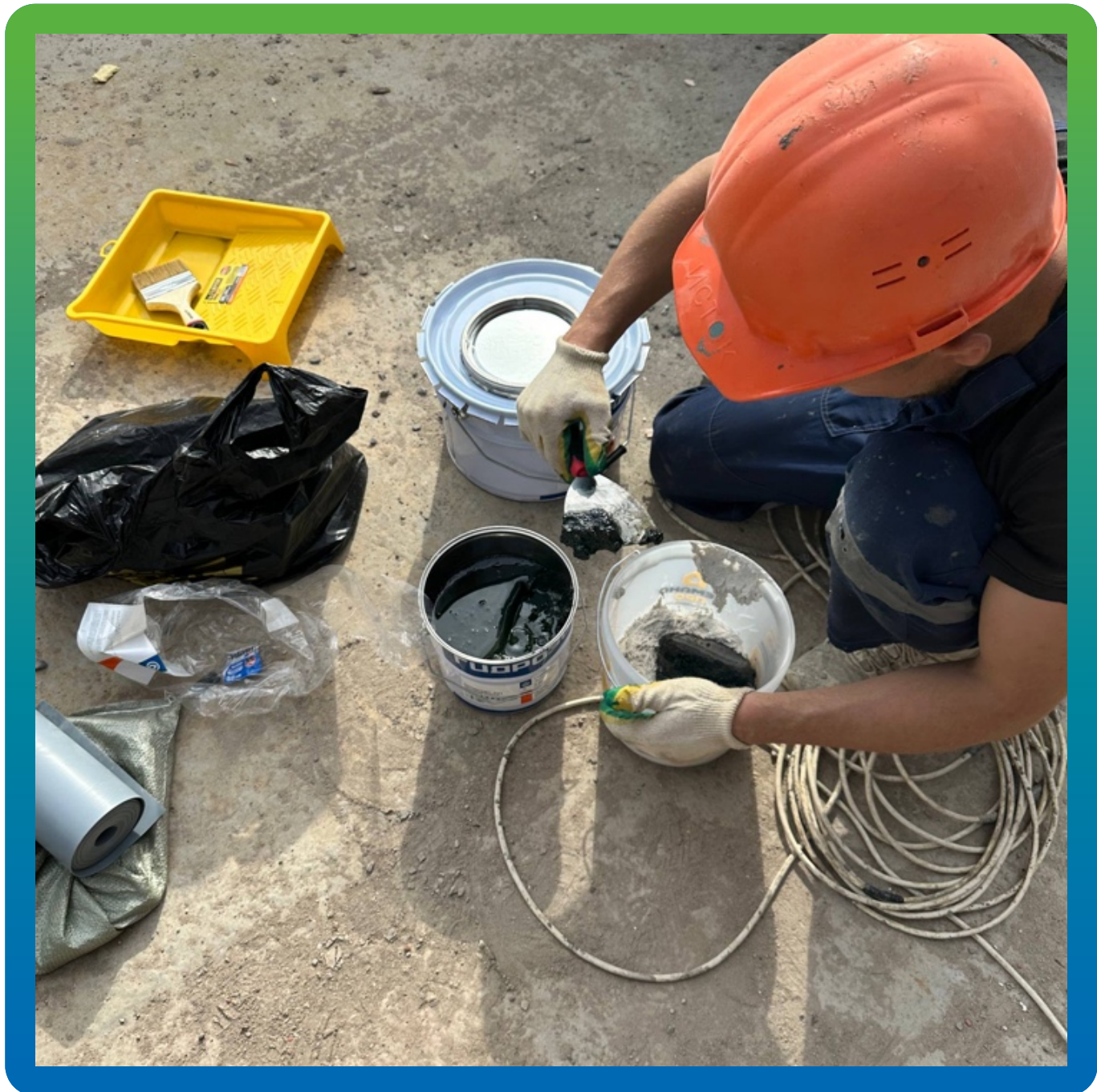
Смешивание компонентов клея Манопокс 331
