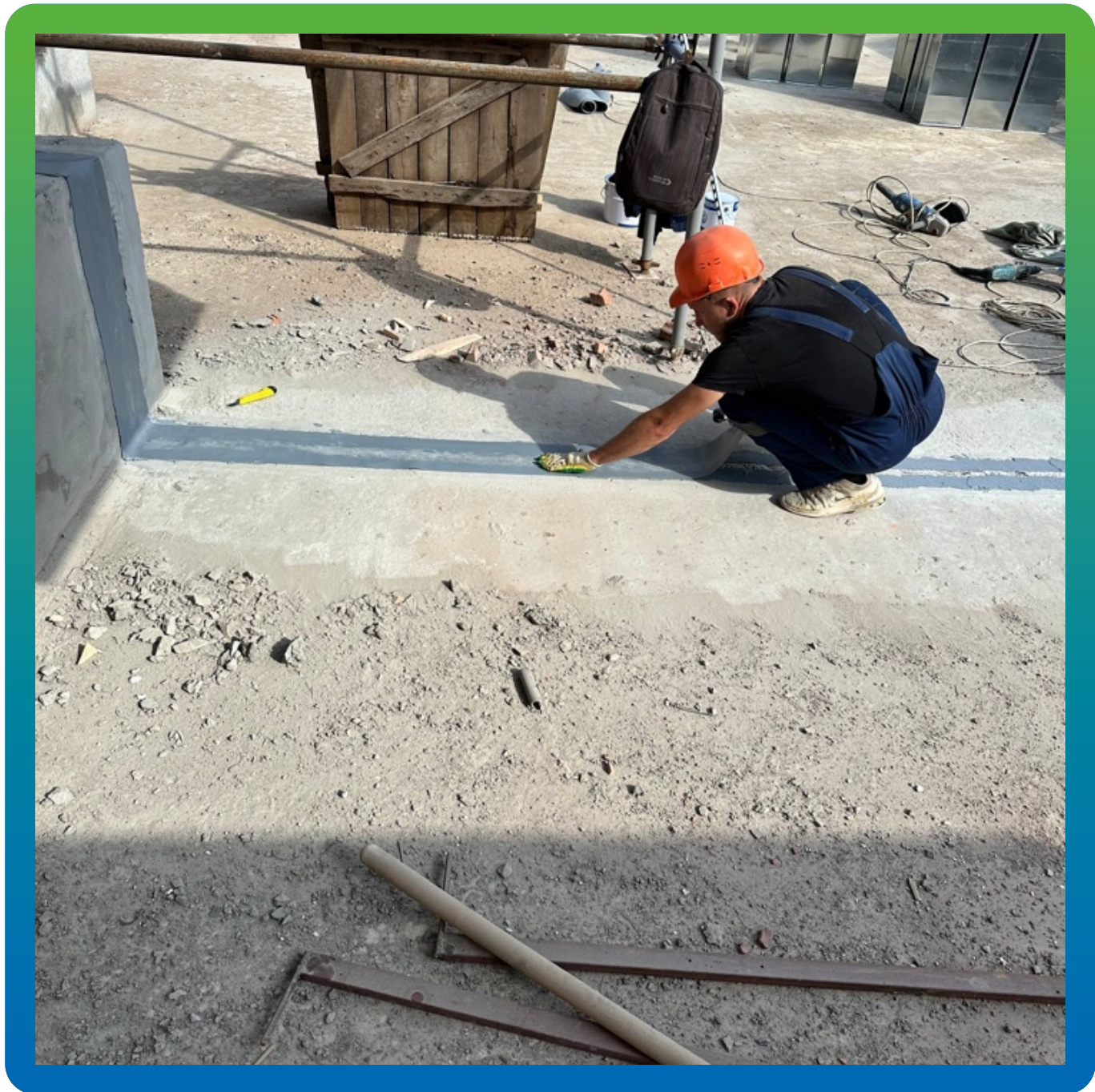
Притапливание ленты Манодил Про в клей Манопокс 331
