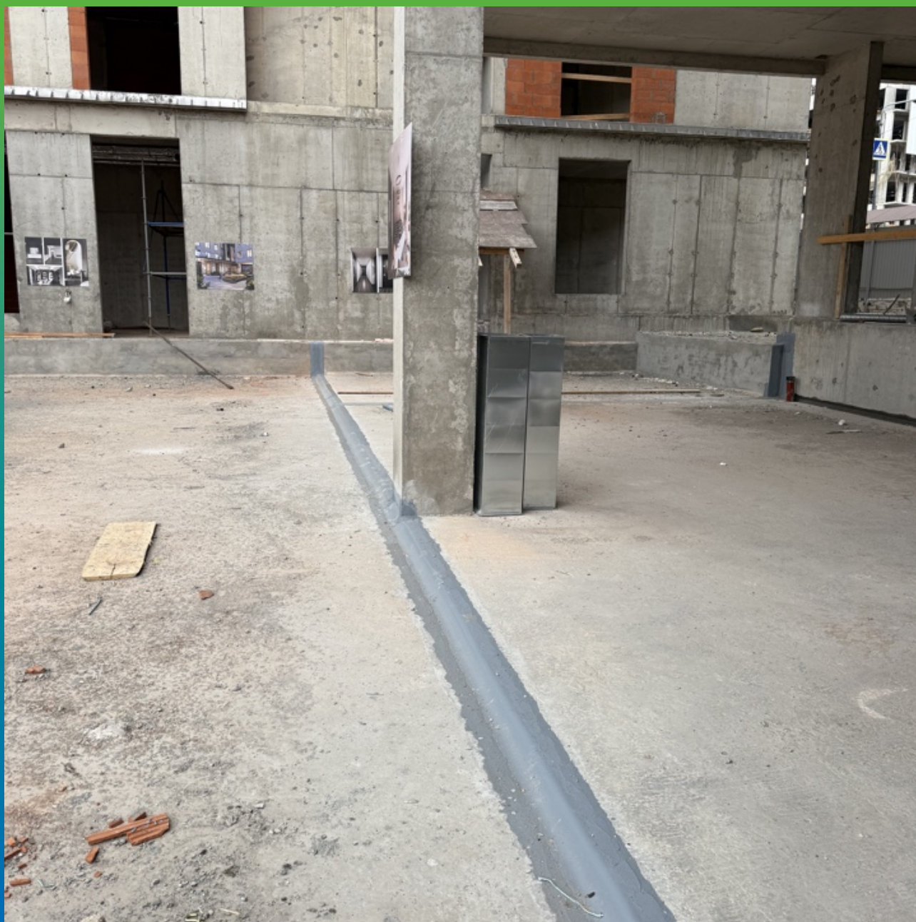
Манопокс 331 и Манодил Про на деформационном шве
