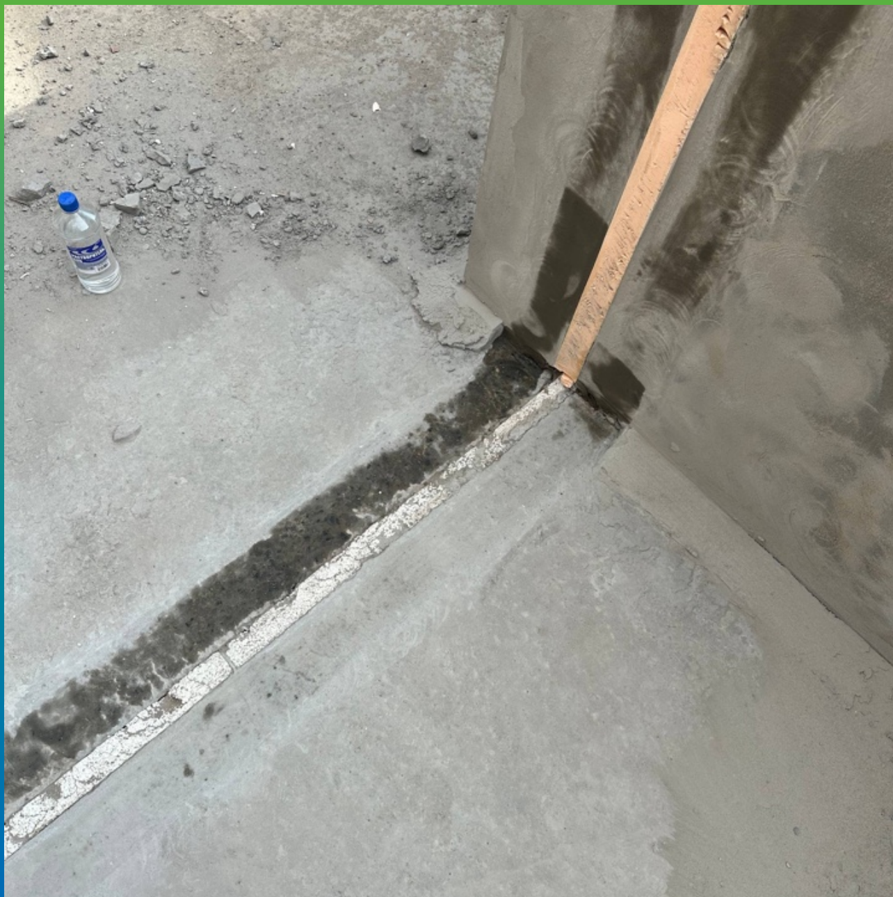
Обезжиривание шва перед нанесением Манопокс 331 и Манодил Про
