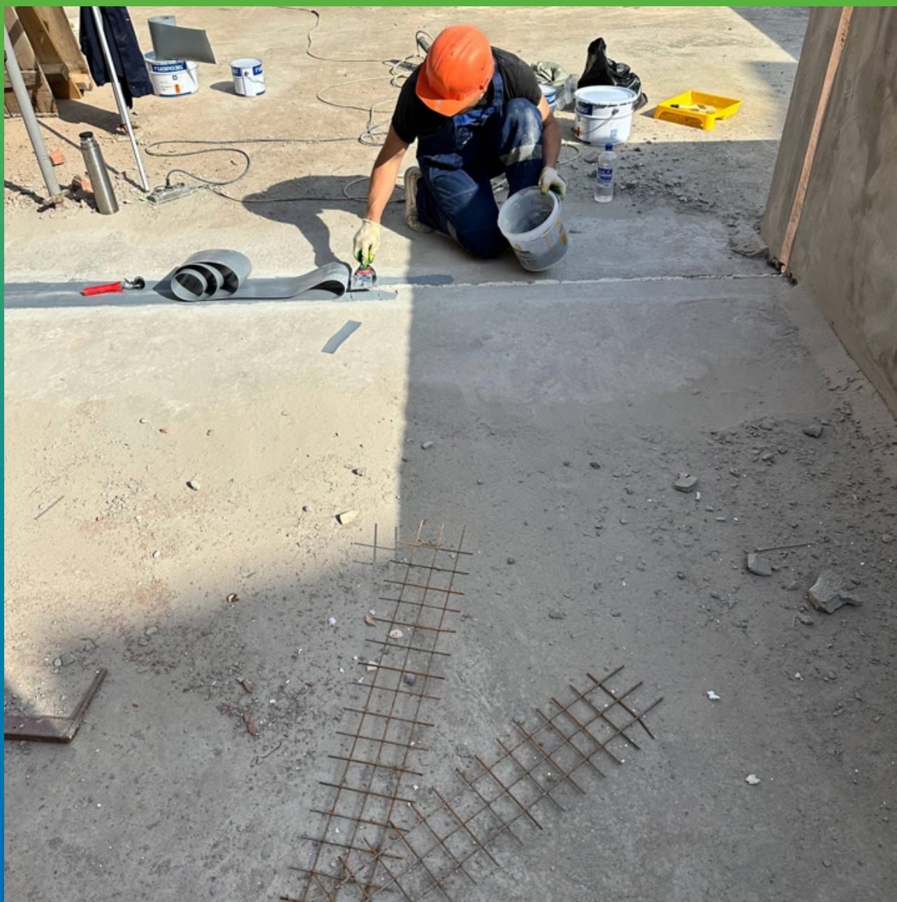
Притапливание ленты Манодил Про в клей Манопокс 331
