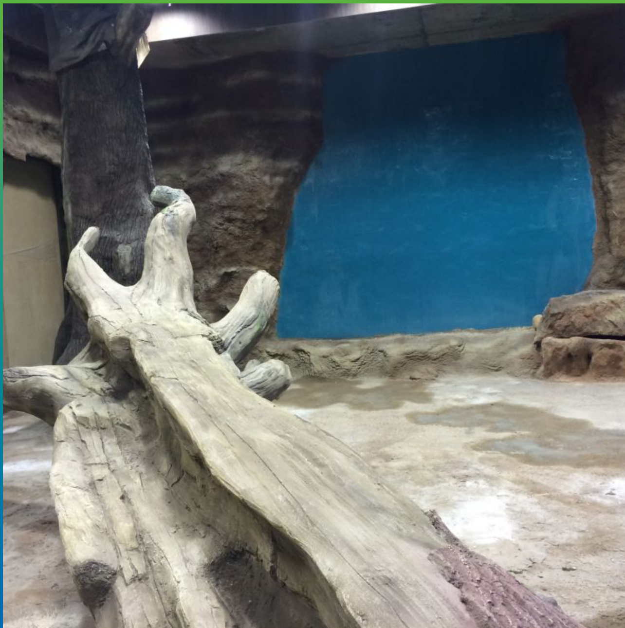
Аквариум с морской водой, цветная гидроизоляция Максэпокс Флекс RAL 5010, гидроизоляция декораций Стармекс Сил Флекс
