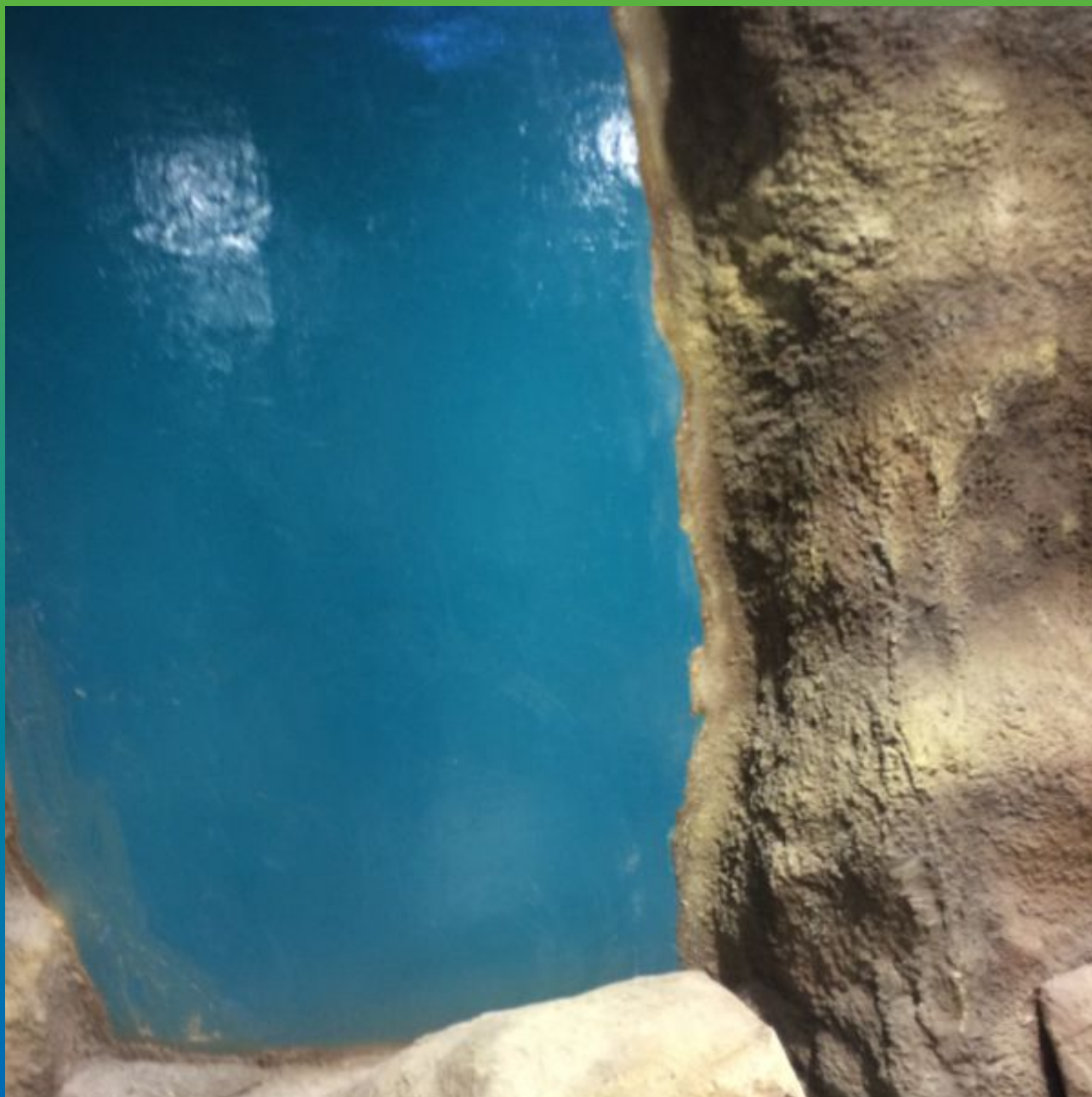
Аквариум с пресной водой, гидроизоляция Максэпокс Флекс RAL 5021
