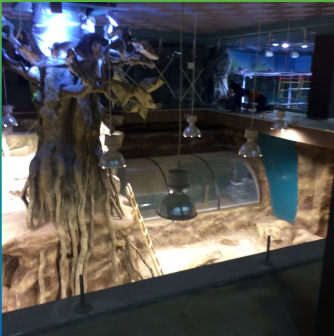
Аквариум с пресной водой общий вид, гидроизоляция Максэпокс Флекс RAL 5021, гидроизоляция декораций Стармекс Сил Флекс
