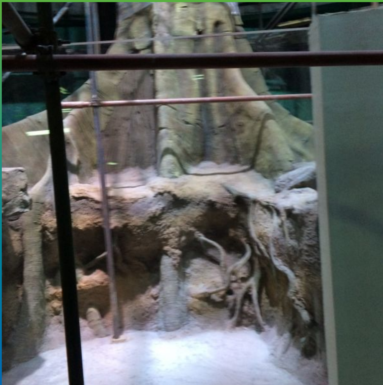
Декорации в аквариуме, гидроизоляция Стармекс Сил Флекс
