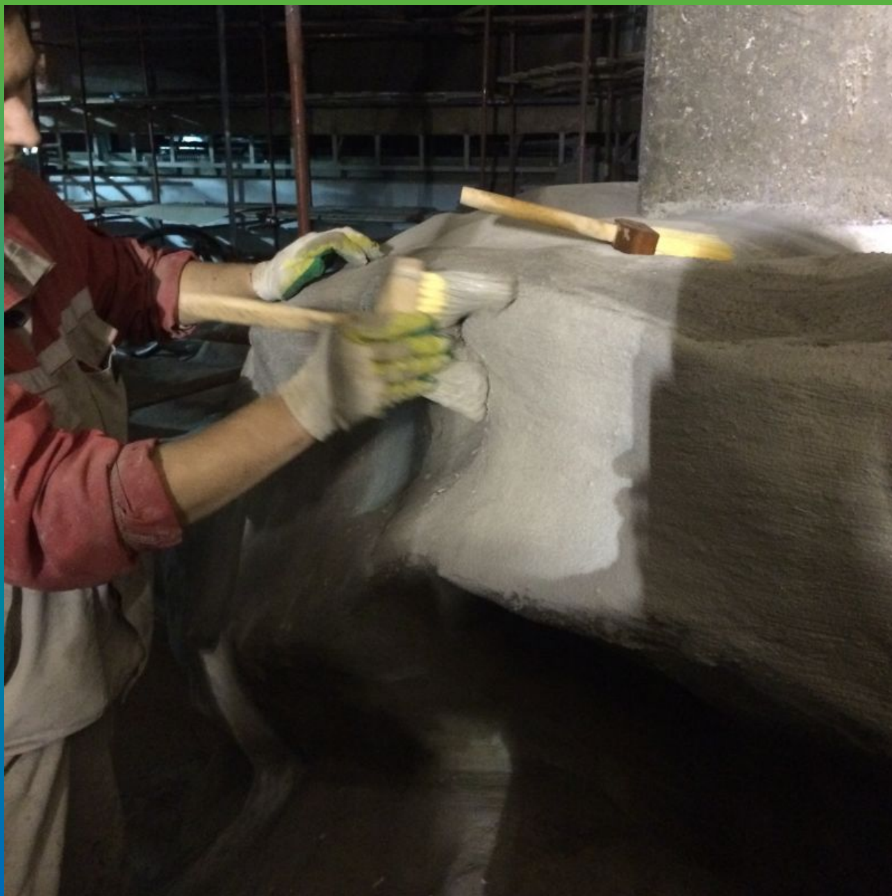
Нанесение гидроизоляции Стармекс Сил Флекс (гидроизоляция декораций)
