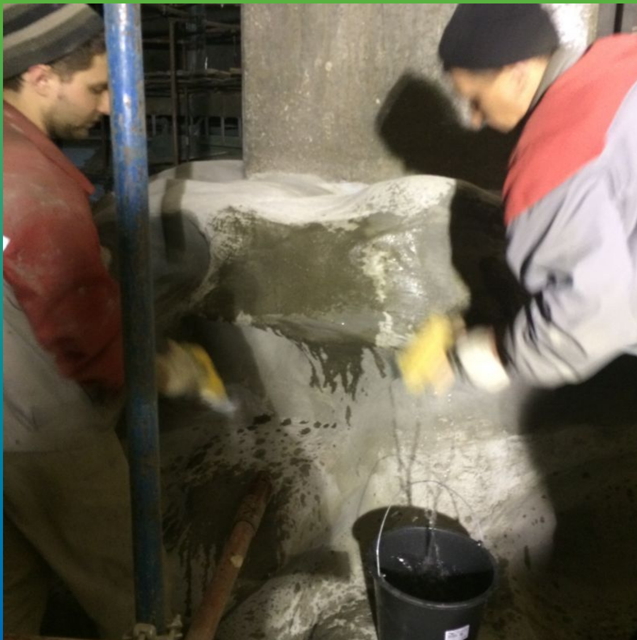
Смачивание гидроизолируемой поверхности (гидроизоляция декораций)
