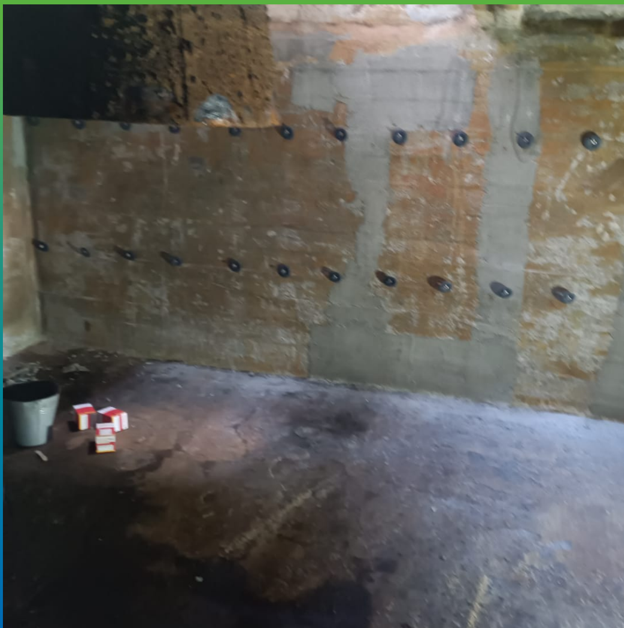
Монтаж шайб под систему крепления Центрикс
