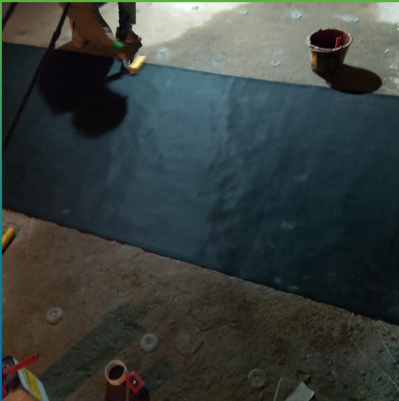
Подготовка горизонтальной поверхности к монтажу мембраны
