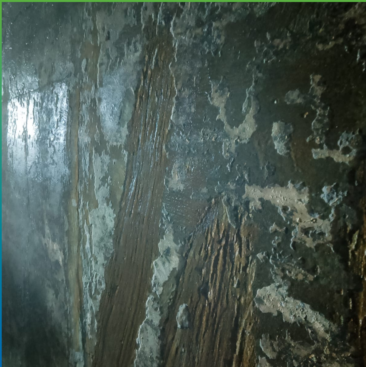
Поверхность после гидроструйной очистки
