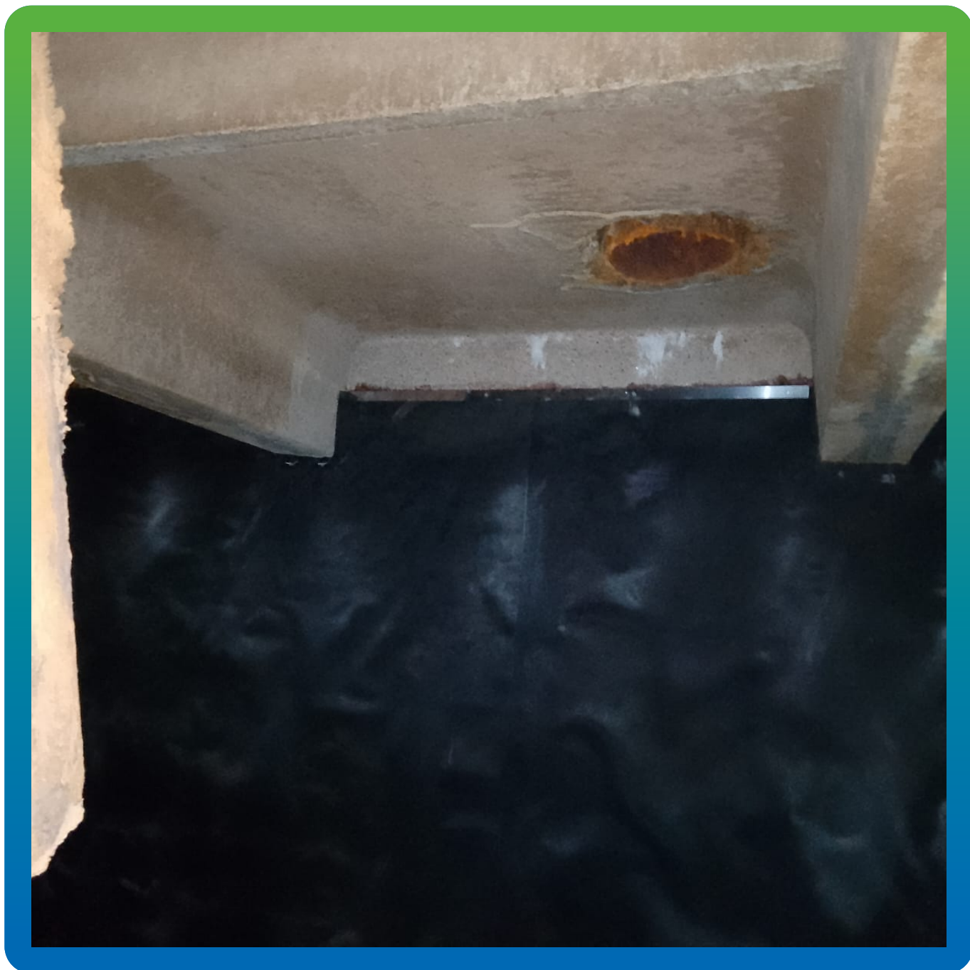
Монтаж вертикальных полос ЭПДМ мембраны Преласта СТ 1.2 мм на планку
