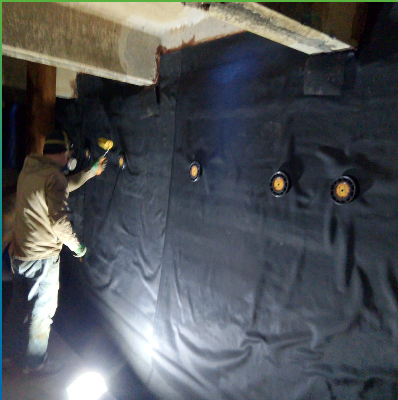
Монтаж вертикальных полос системой Центрикс
