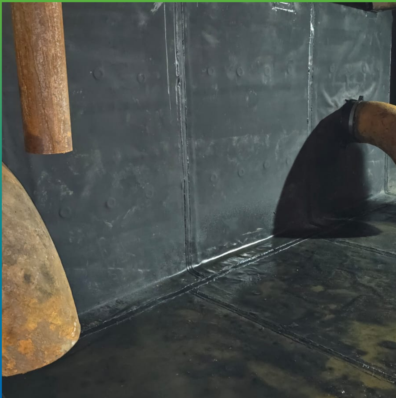
Приближенный вид выполненных участков мембраной ЭПДМ Преласта СТ 1.2 мм
