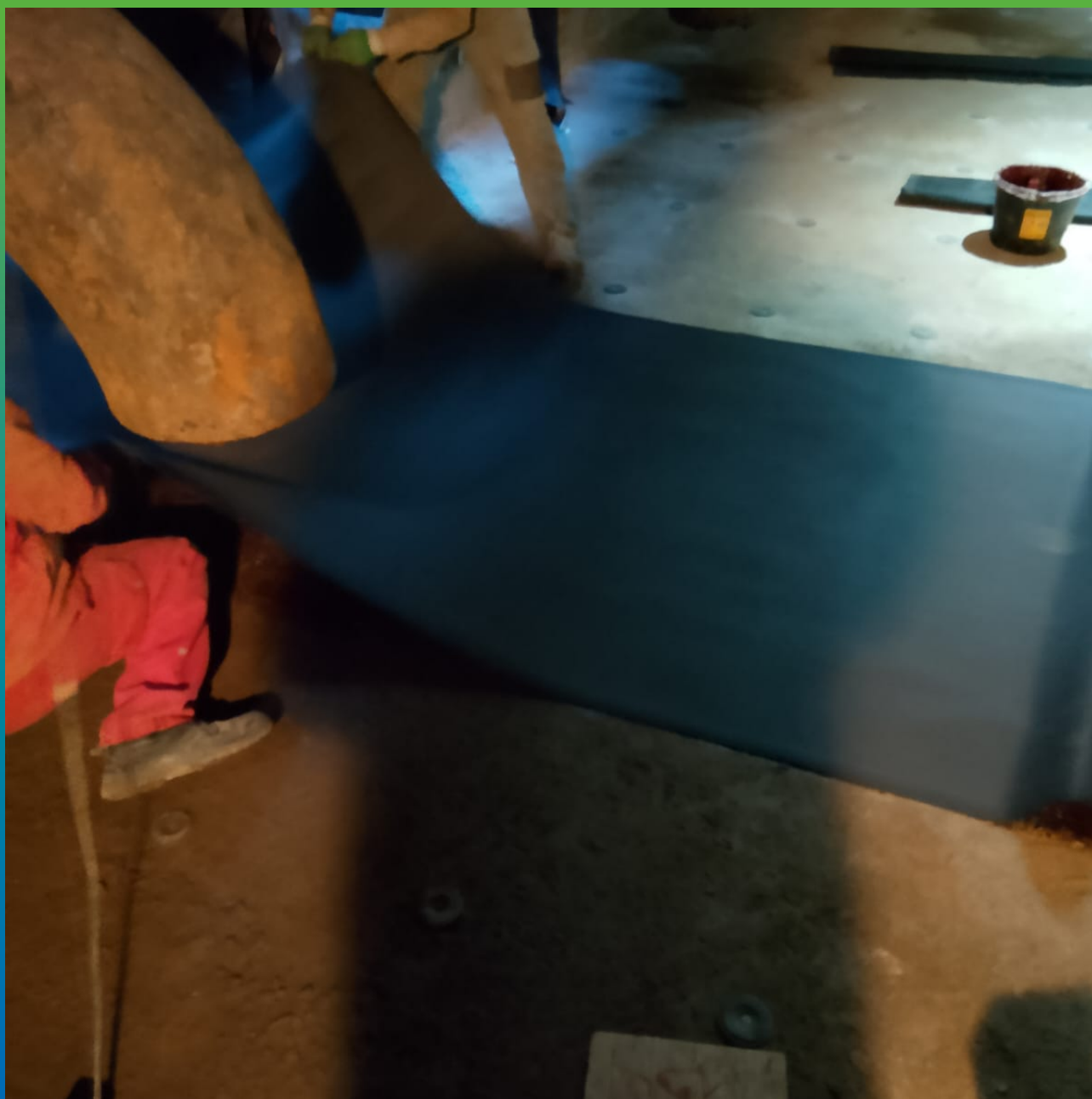
Подготовка горизонтальной поверхности к монтажу мембраны
