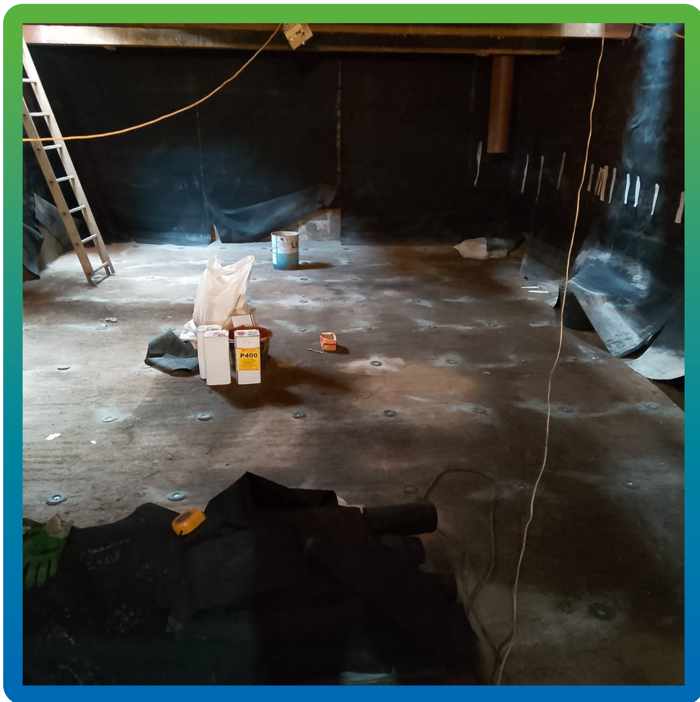
Подготовка горизонтальной поверхности к монтажу мембраны
