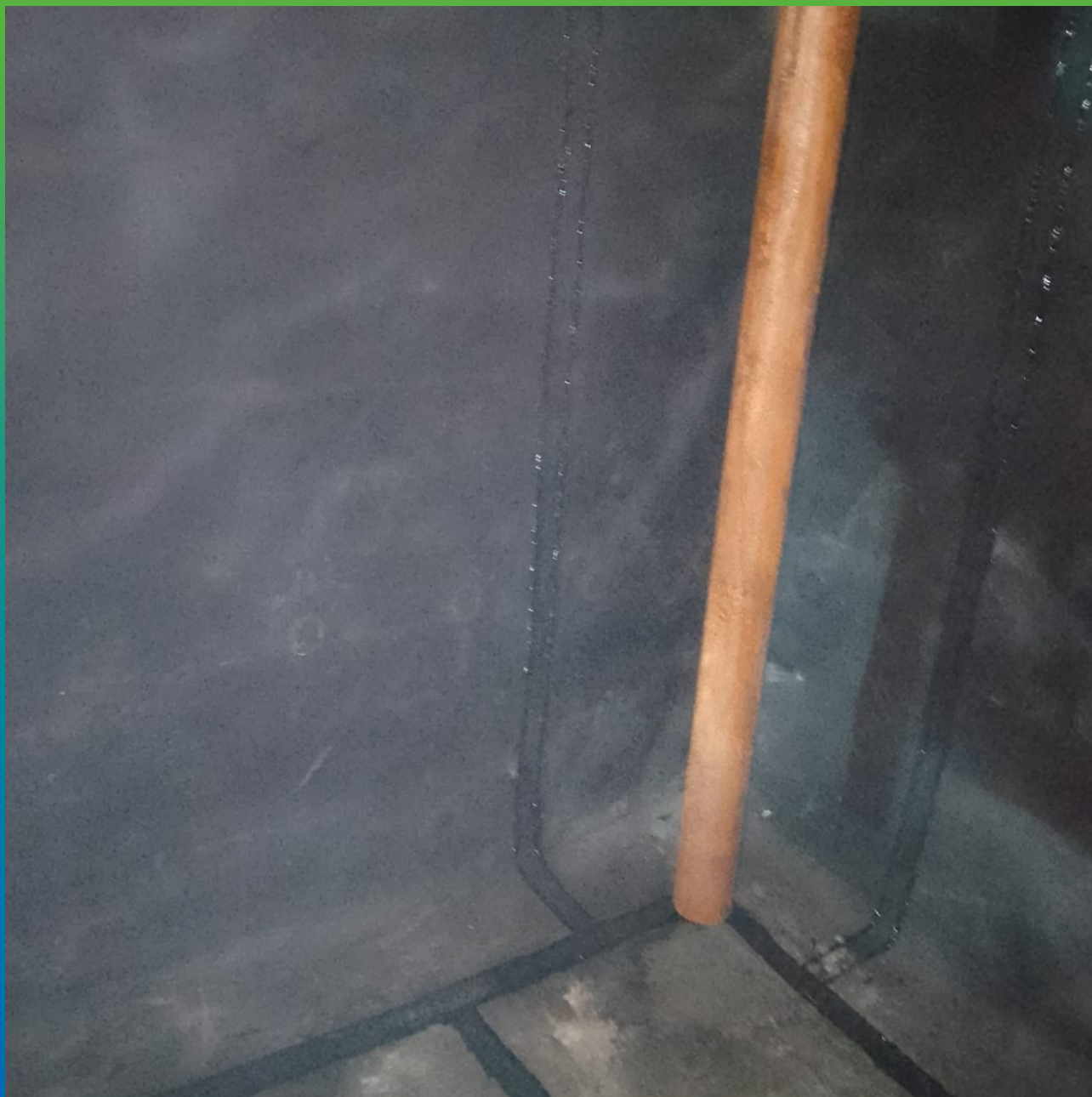
Приблизженный вид выполненных участков мембраной ЭПДМ Прелести СТ 1.2 мм
