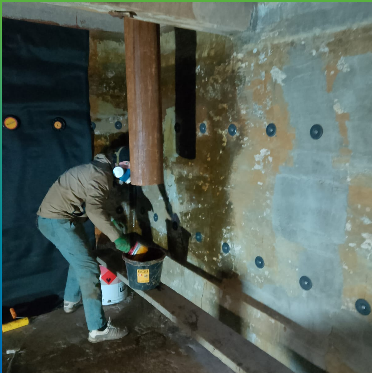
Нанесение клея на каучуковой основе Адгезив П400 на вертикальные поверхности
