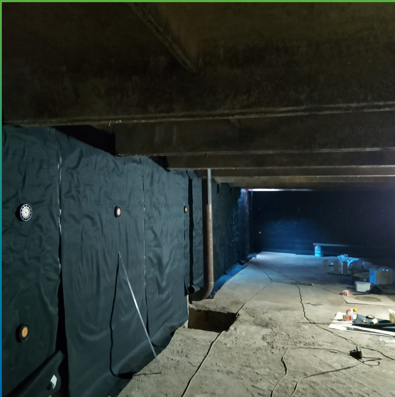
Вид выполненного монтажа вертикальных полос ЭПДМ мембраной Прелести СТ 1.2 мм
