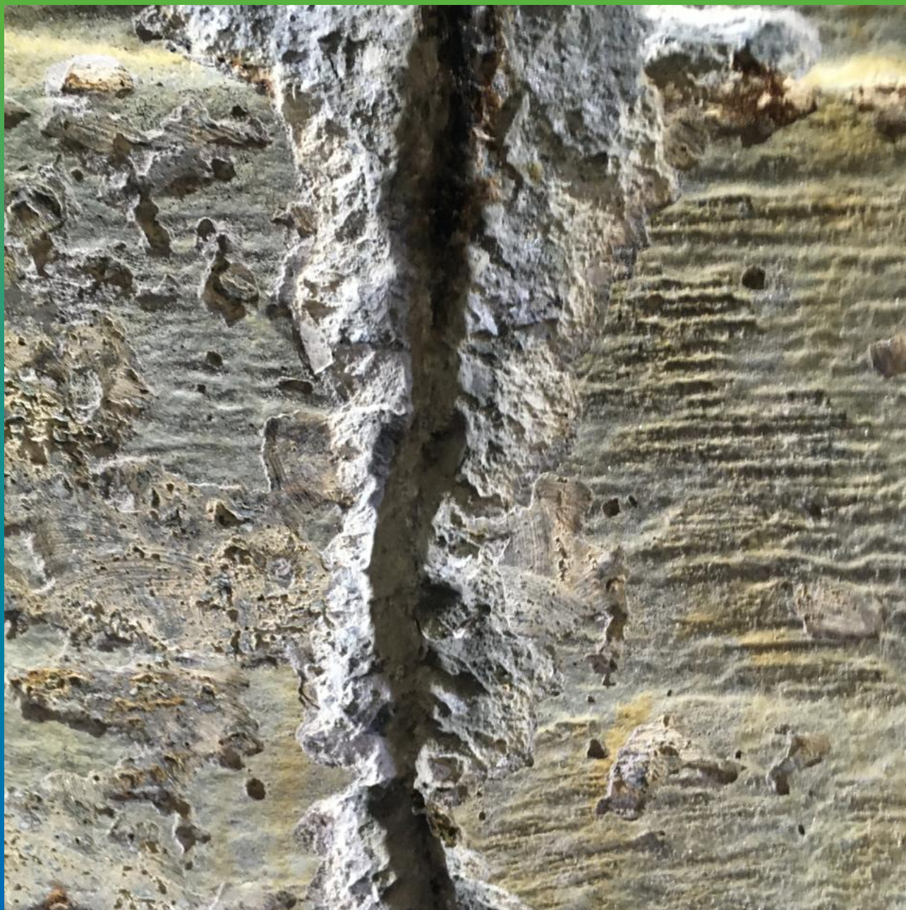
Расшивка трещин
