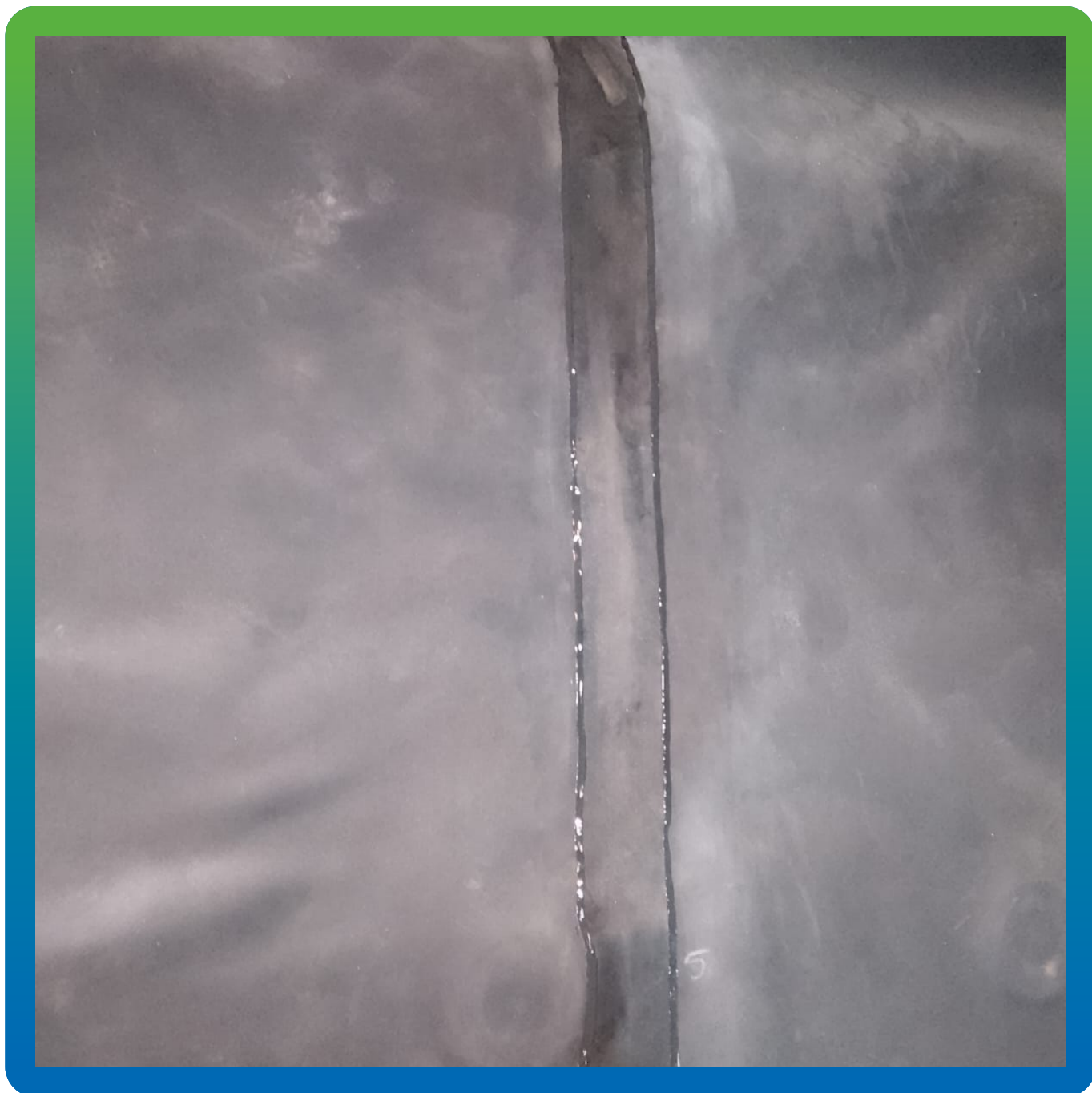
Приблизительный вид сваренных полотен ЭПДМ мембраны
