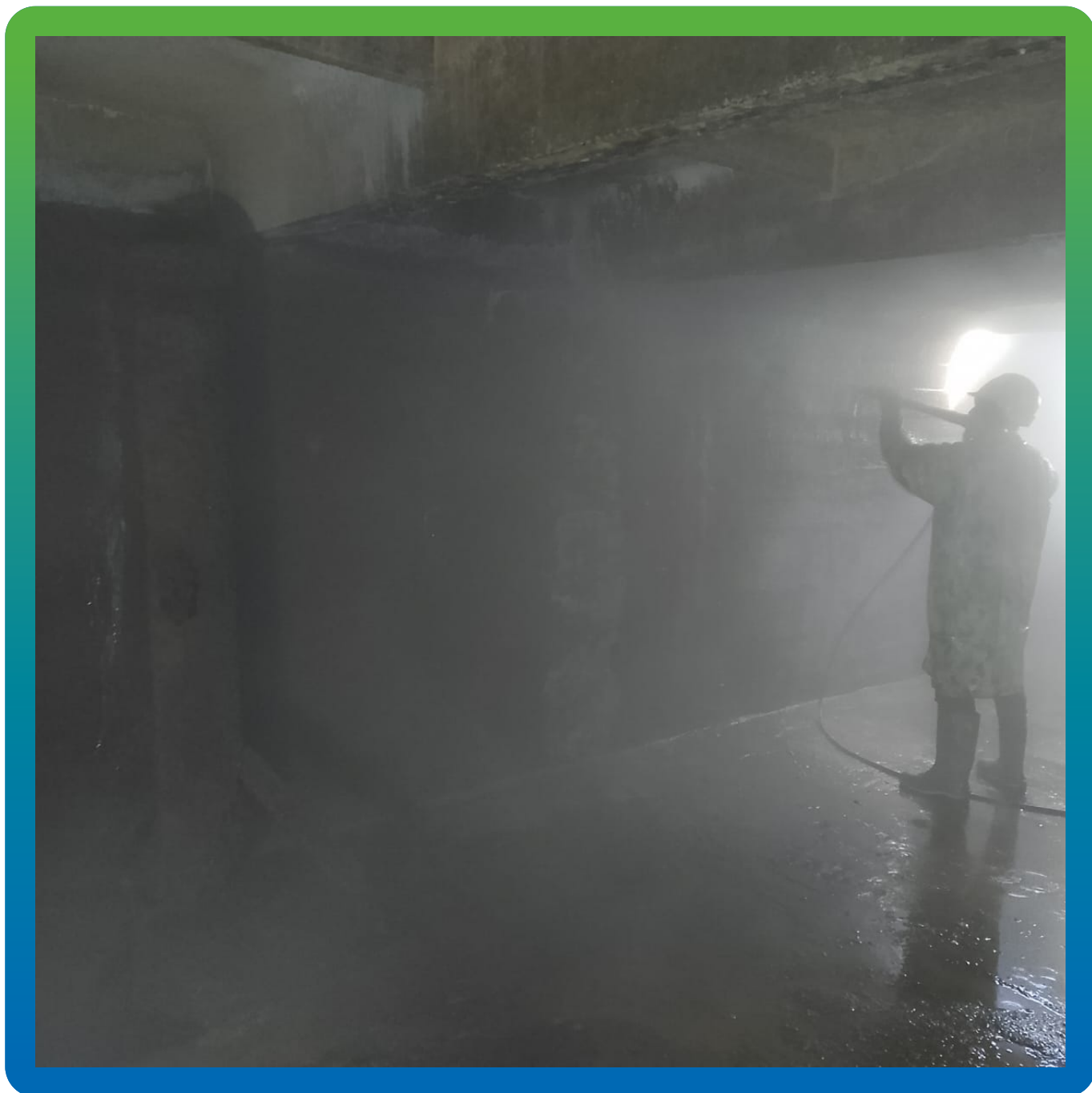
Гидроструйная очистка бетонных поверхностей
