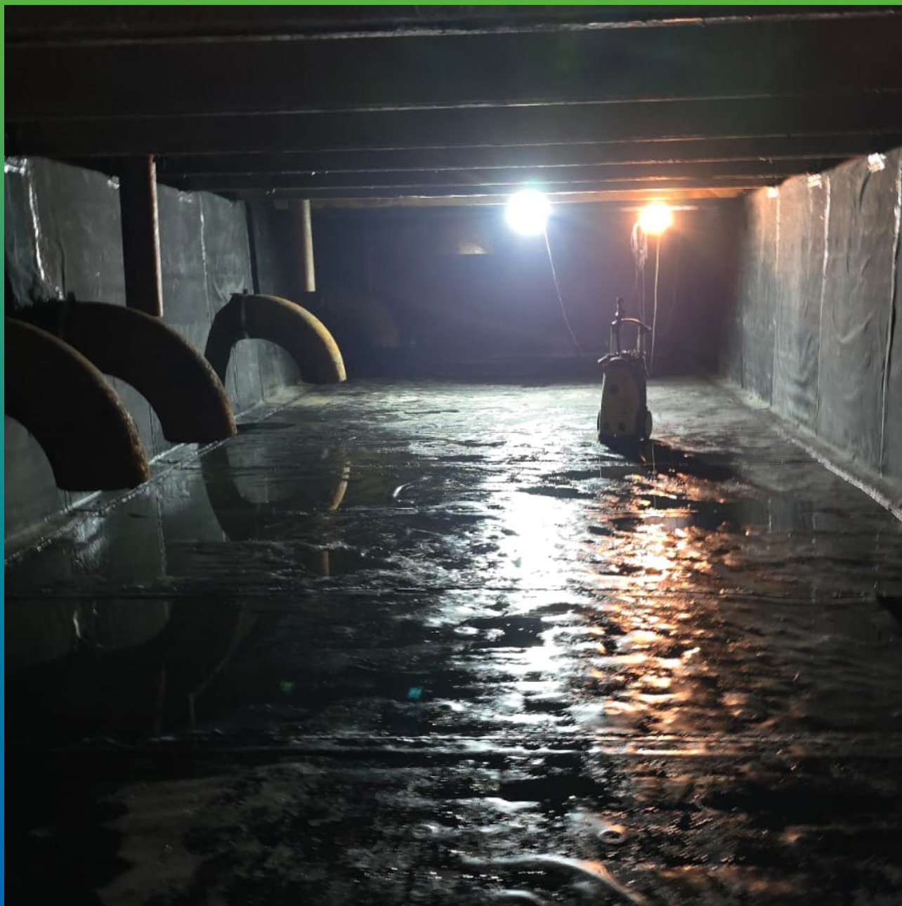
Общий вид резервуара, гидроизоляция ЭПДМ мембраной Преласты СТ 1.2мм
