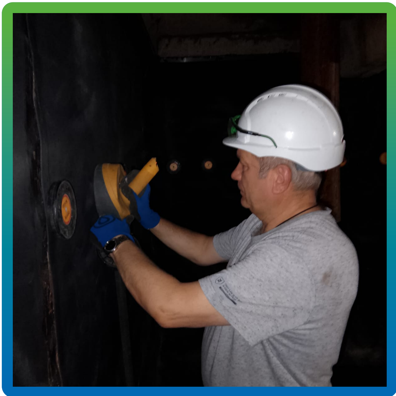
Монтаж вертикальных полос системой Центрикс
