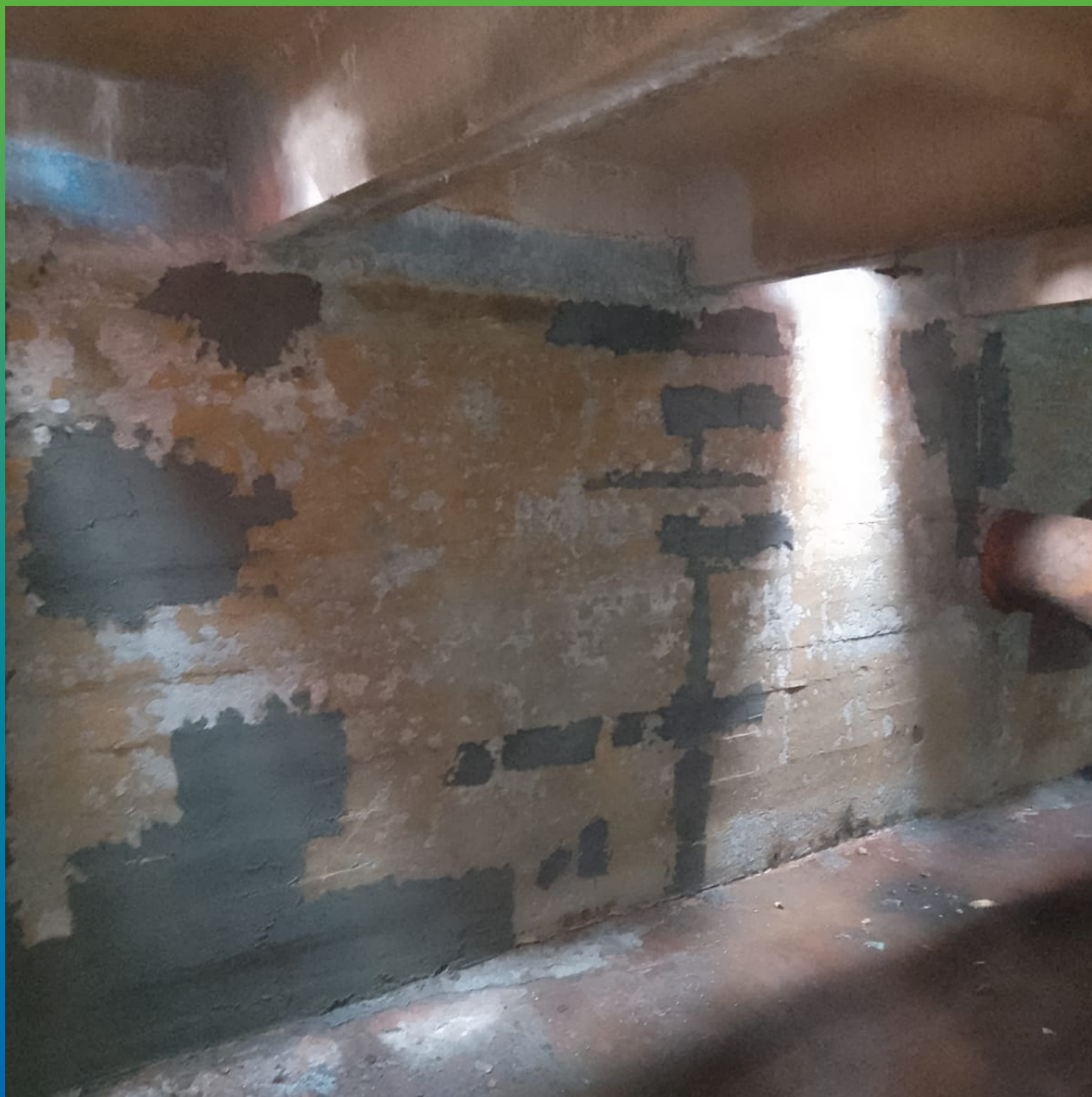
Устранение дефектов после гидроструйной очистки материалом Стармекс РМЗ
