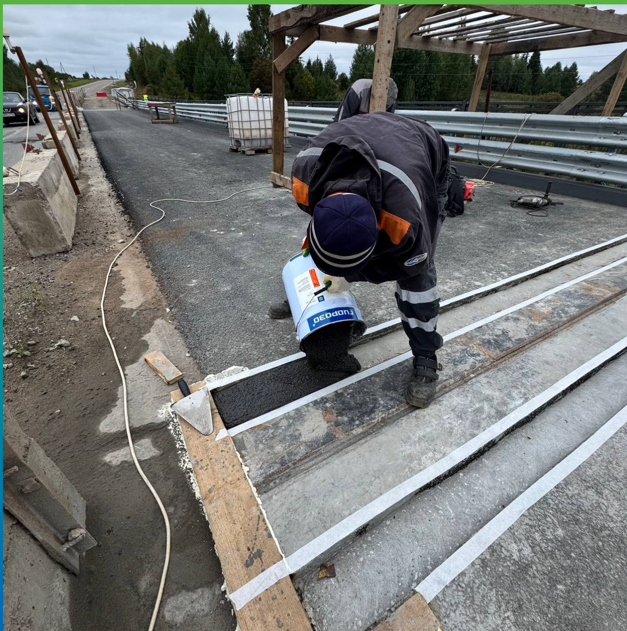
Укладка состава Манопур 336 в штробу
