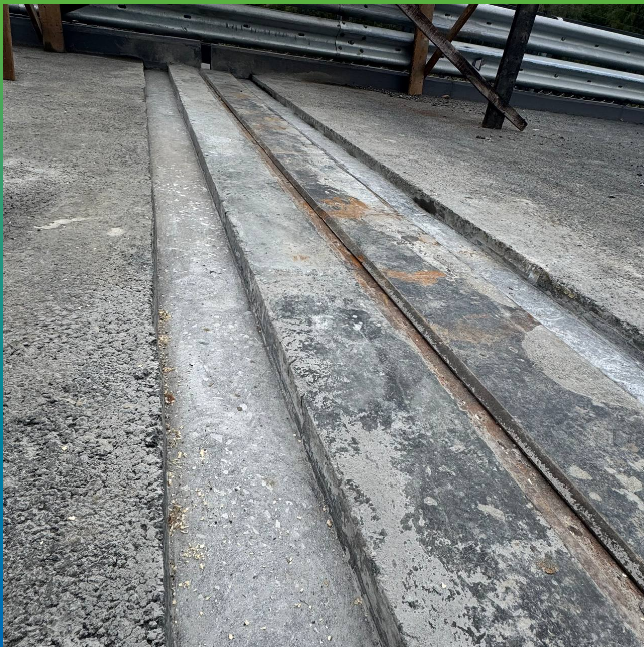
Штраба, подготовленная к заливке материала Манопур 336
