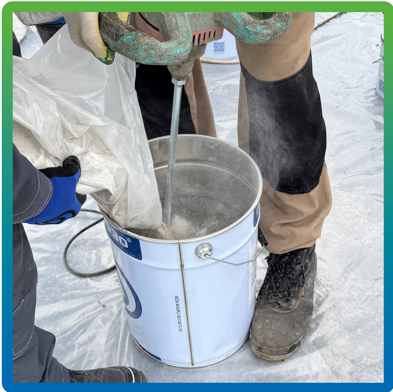
Добавление компонента А в заранее размешанные Б1 и Б2
