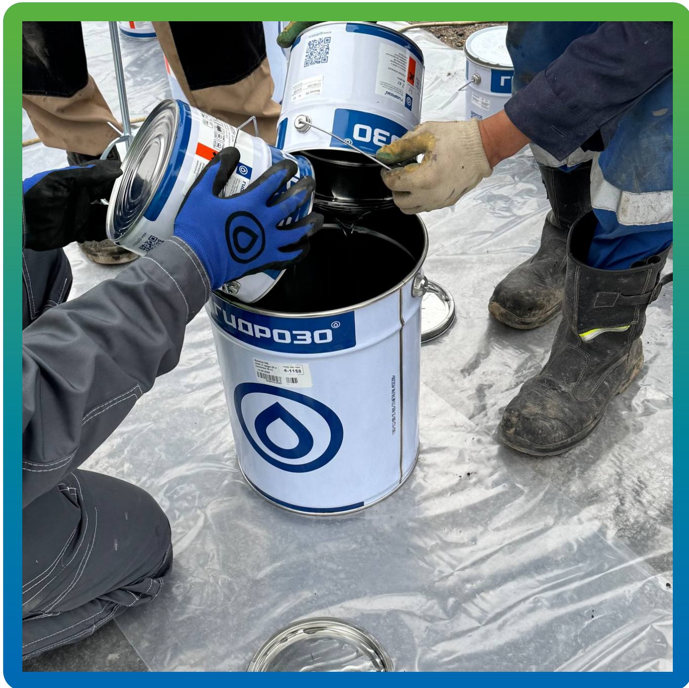
Смешивание компонентов Б1 и Б2 Манопур 336
