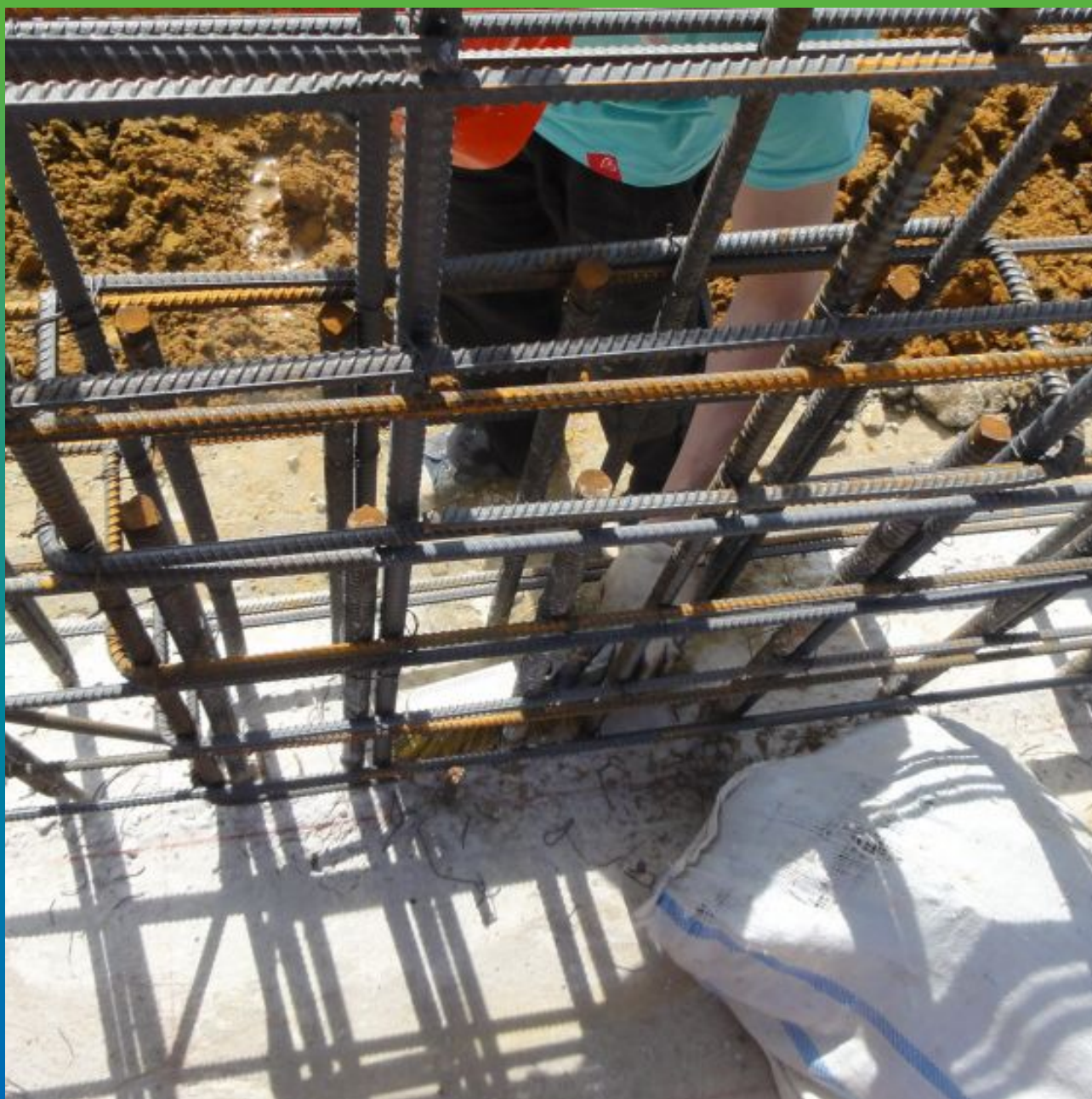
Прочистка и обеспыливание рабочего шва
