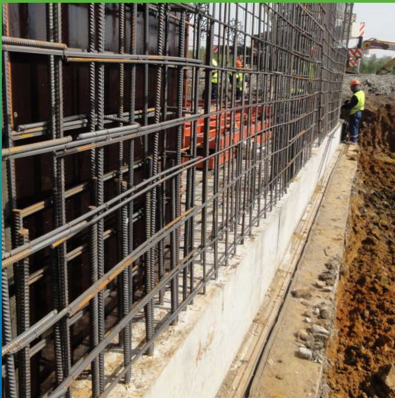
Вид рабочего шва перед укладкой профиля
