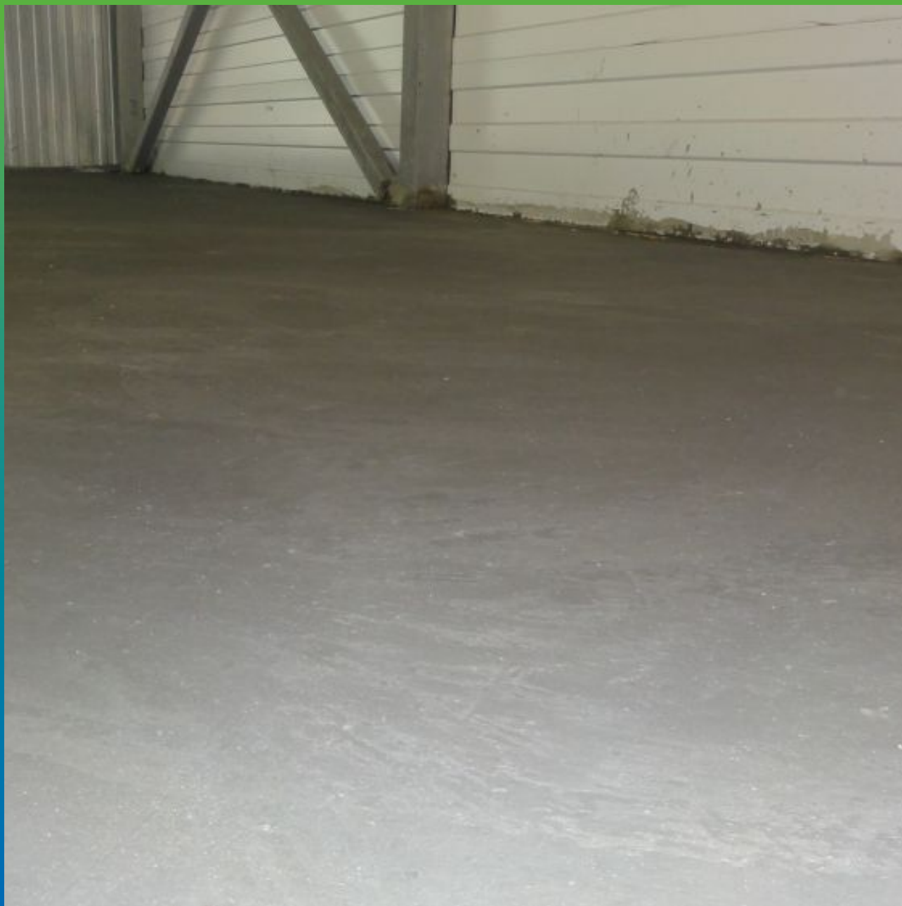
Вид пола перед нанесением пропитки
