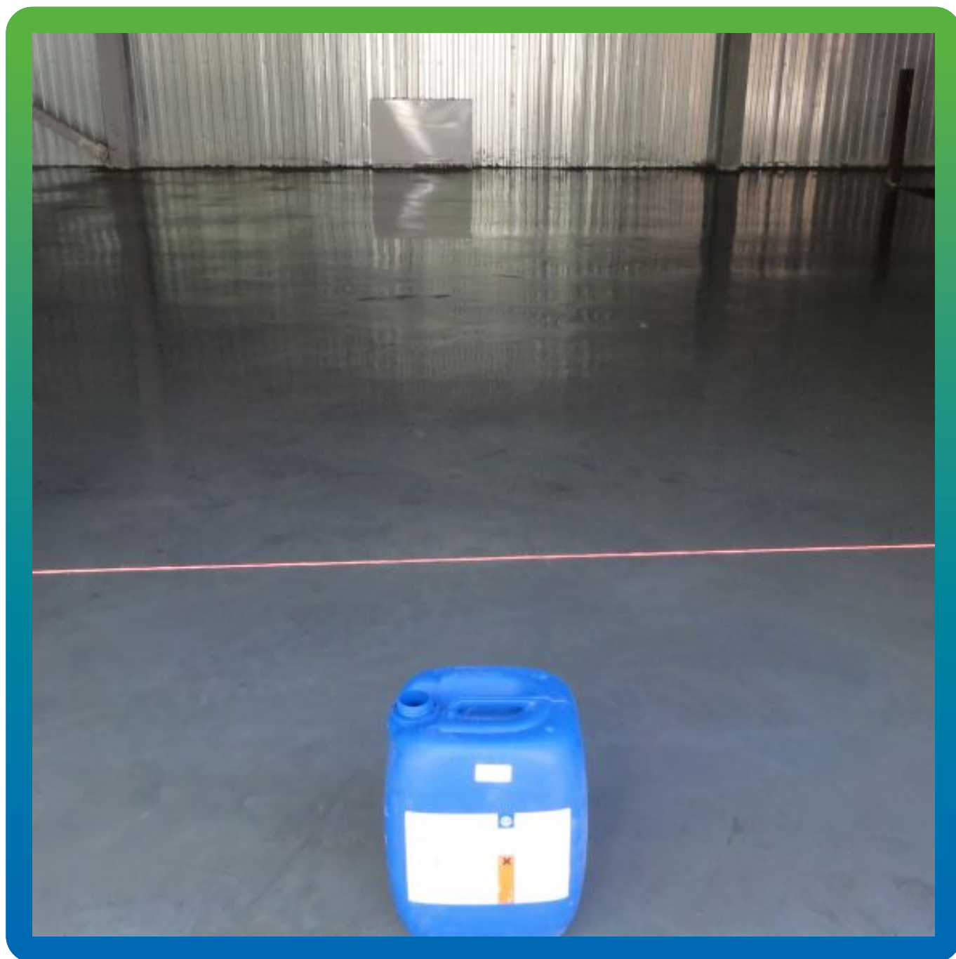
Финальный вид объекта
