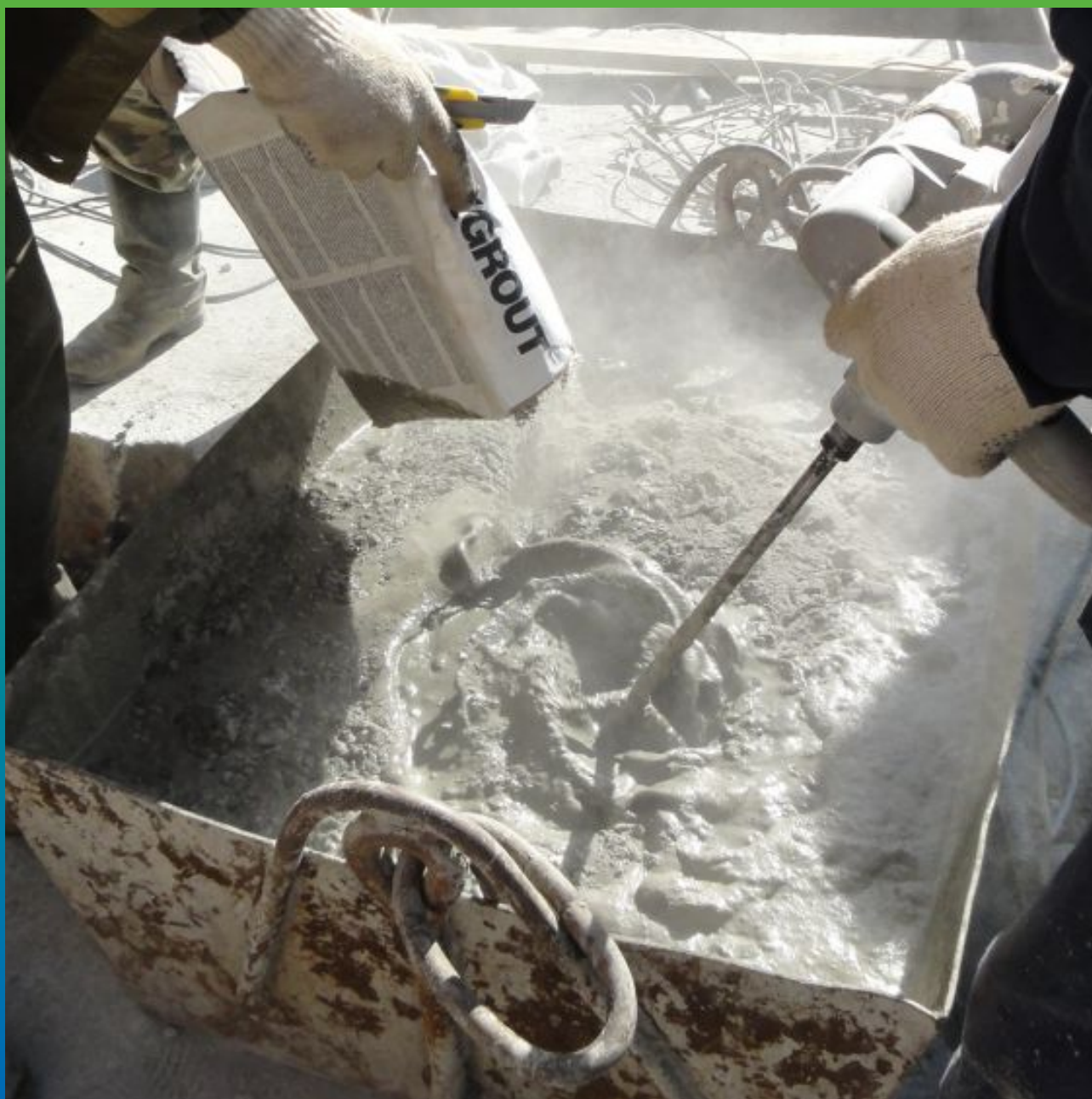
Замешивание состава "Максгрут" с водой.
