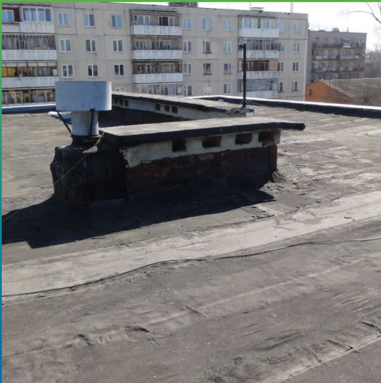
Первоначальный вид кровли
