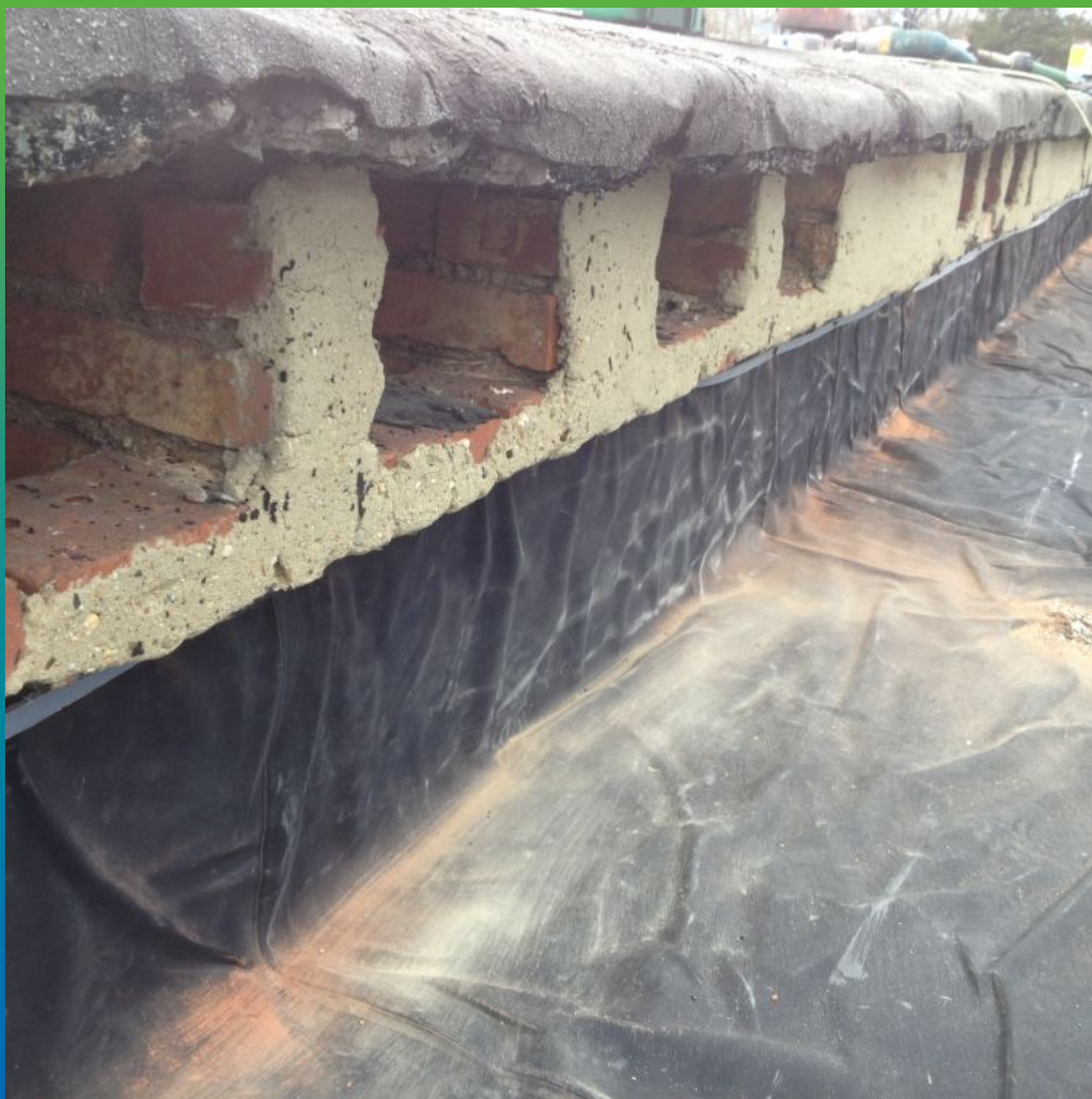
Вид примыкания к парапету
