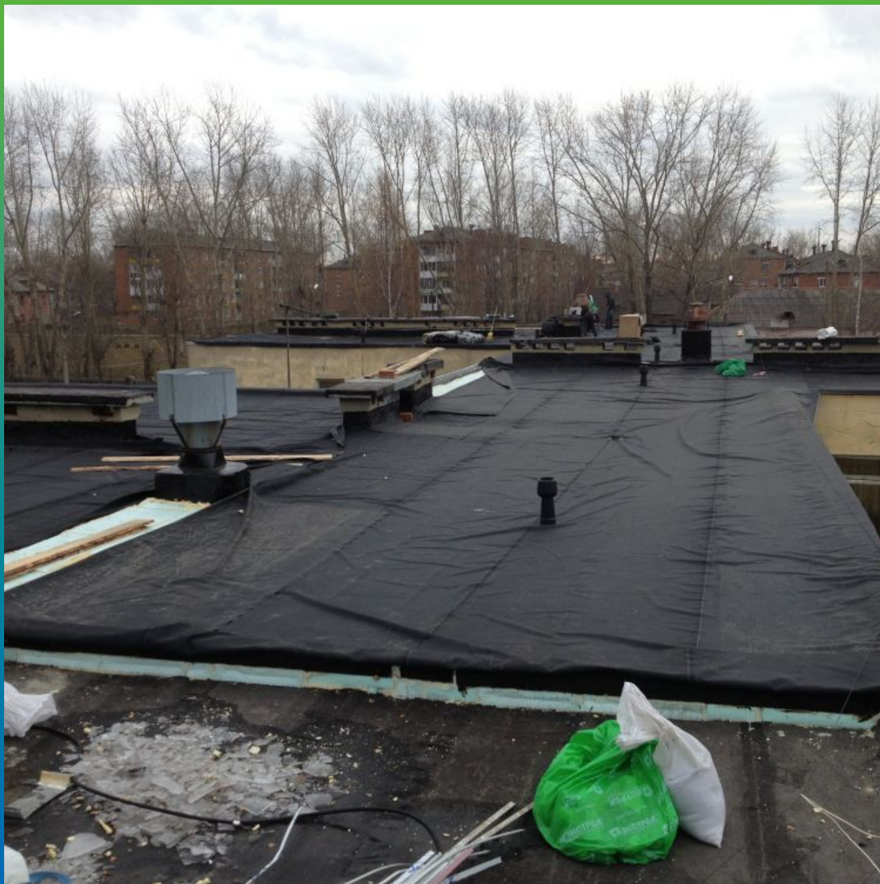
Укладка ЭПДМ мембраны Прелести СТ 1.2мм
