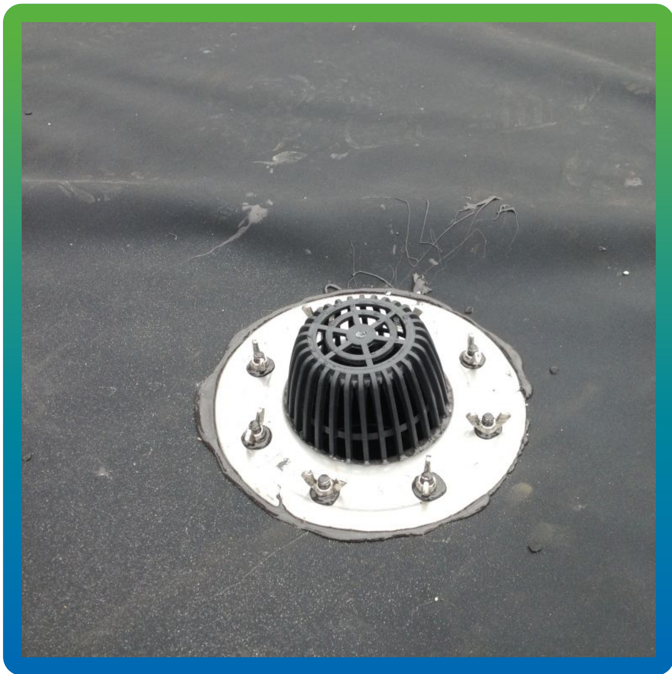
Герметизация водосливной воронки с помощью гшерметика Витрафин Бонд Ф
