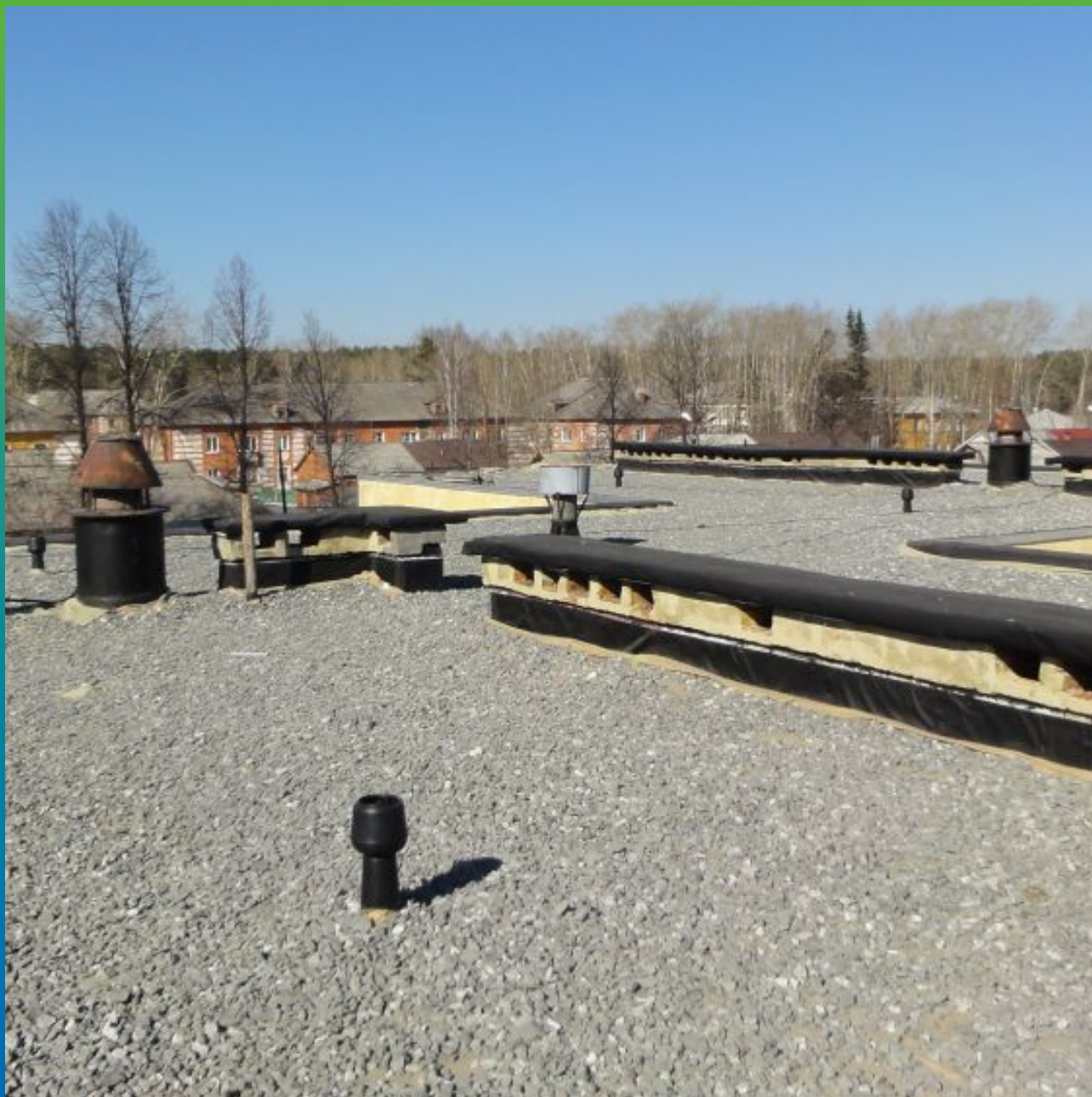
Итоговый вид кровли
