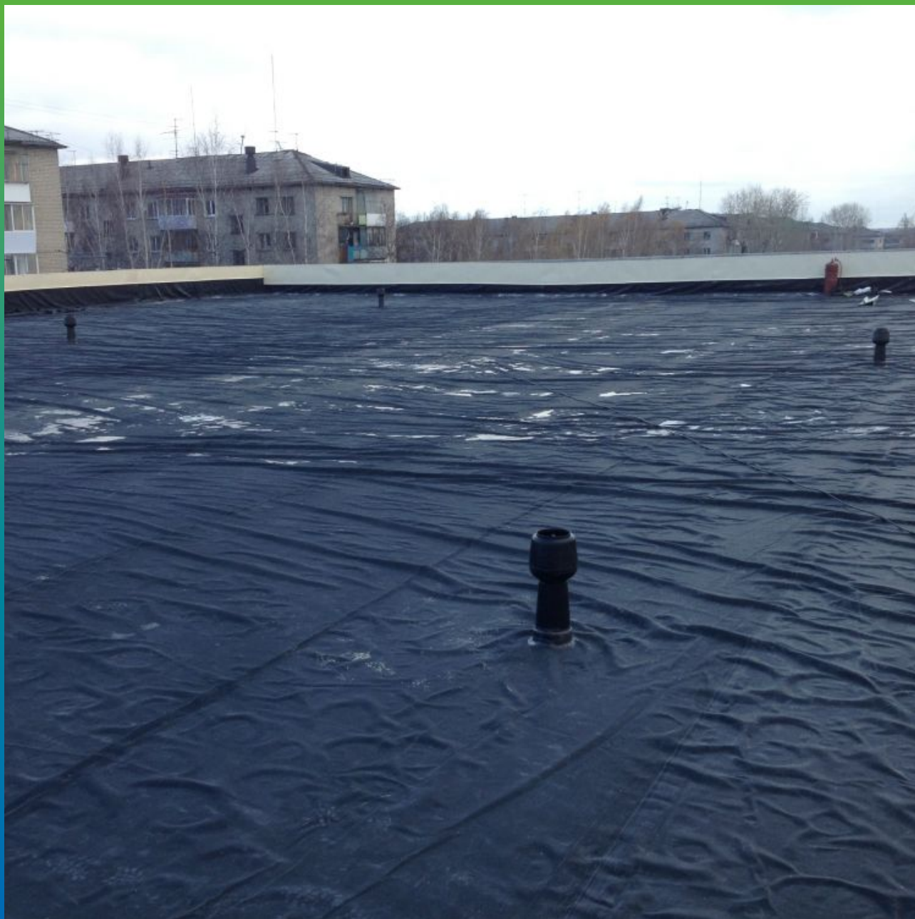
Вид уложенной ЭПДМ мембраны
