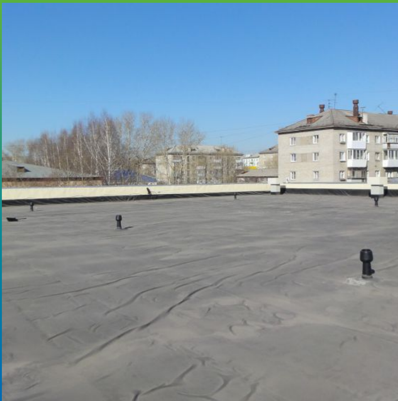
Финальный вид кровли
