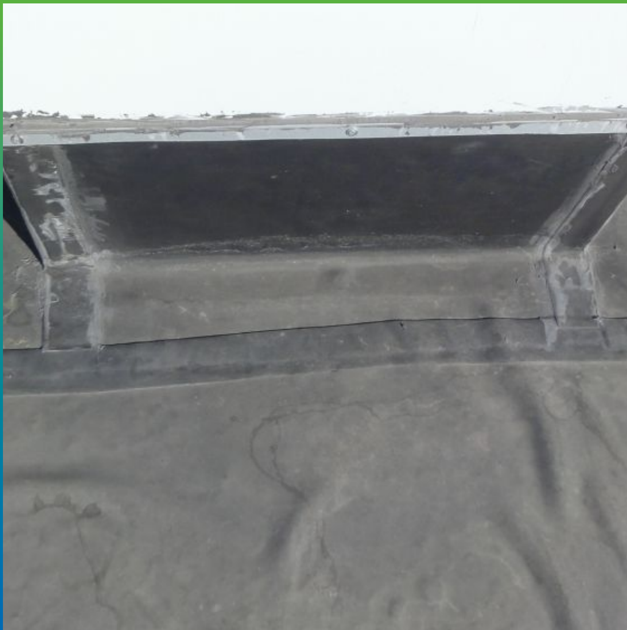
Герметизация примыкания к вентиляционной шахте. Термобонд + Витрафин Бонд Ф
