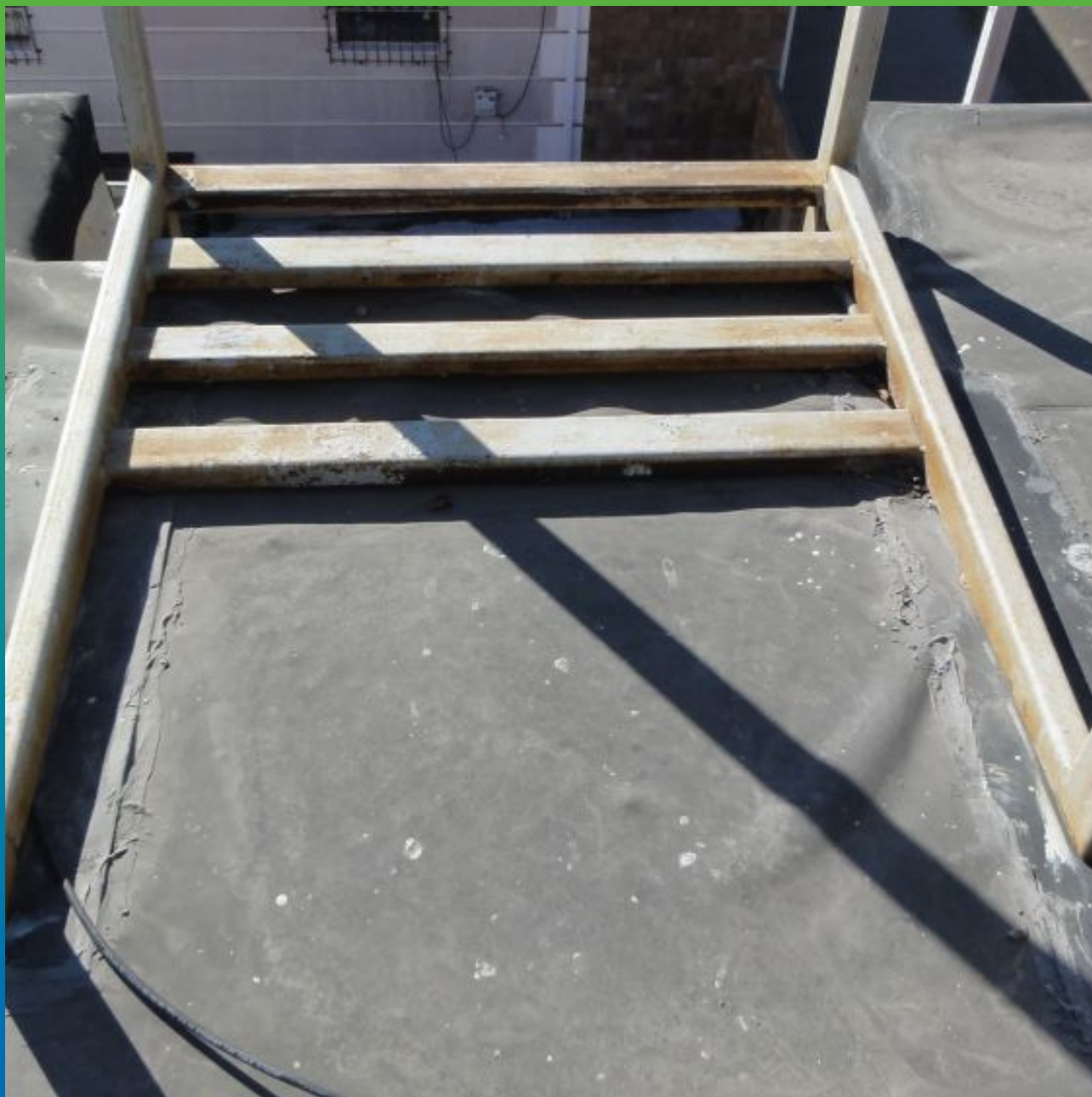
Устройство примыкания пожарной лестницы к основанию
