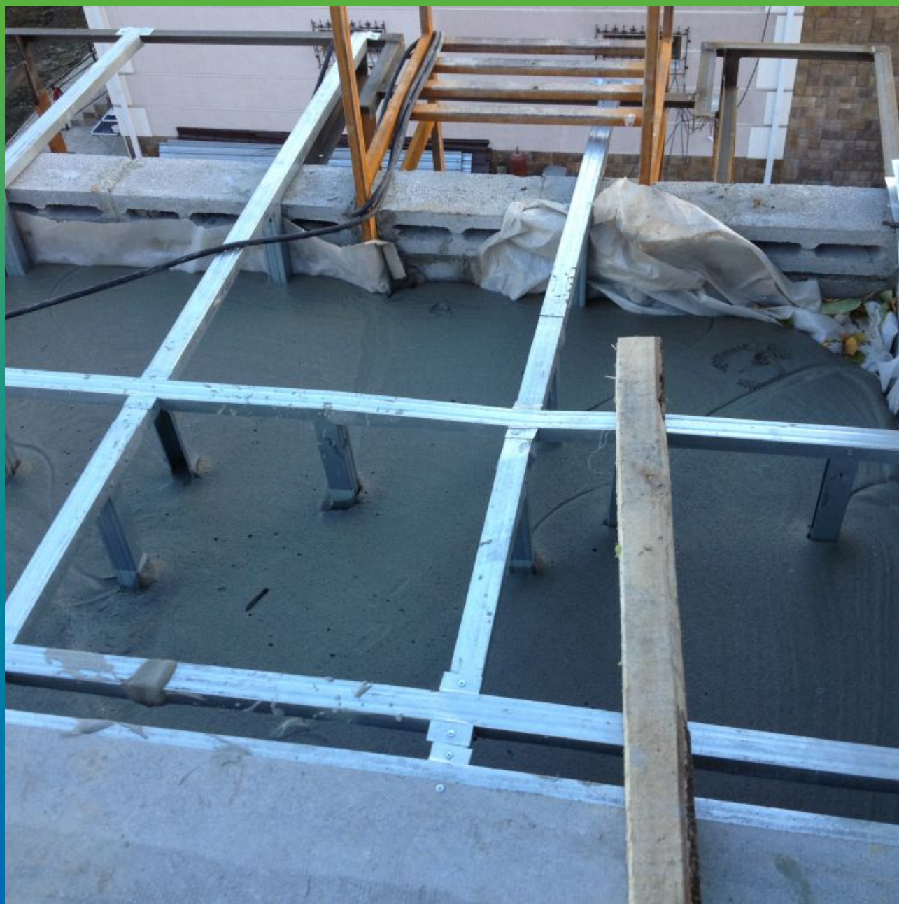
Утепление кровли с помощью пенобетона
