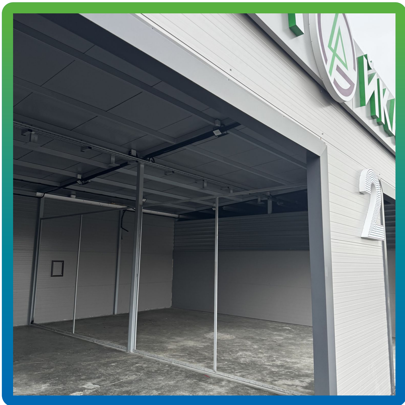
Внешний вид после нанесения двух слоев ДенсТоп ПУ 113
