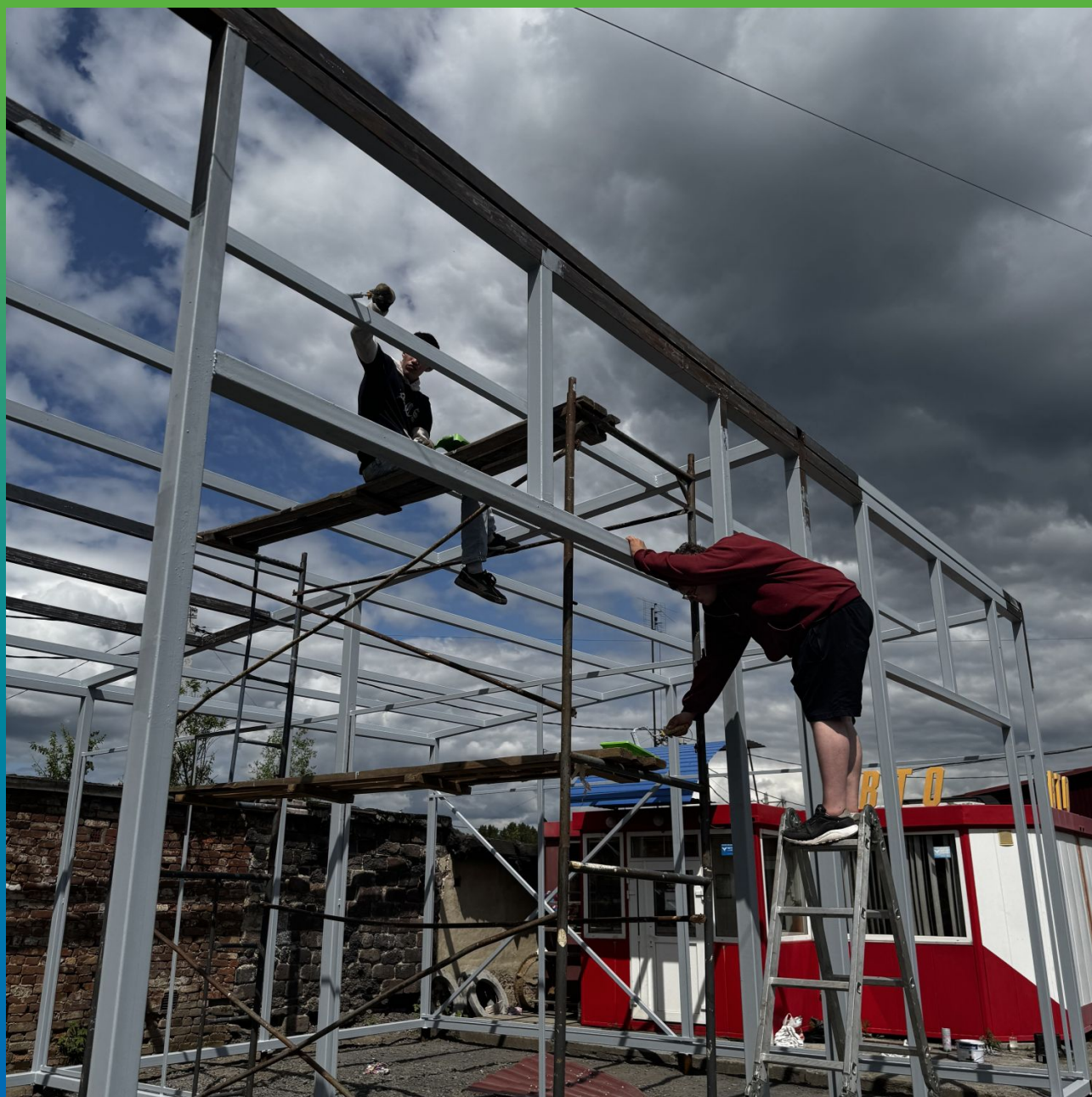
Нанесение первого слоя ДенТоп ПУ 113
