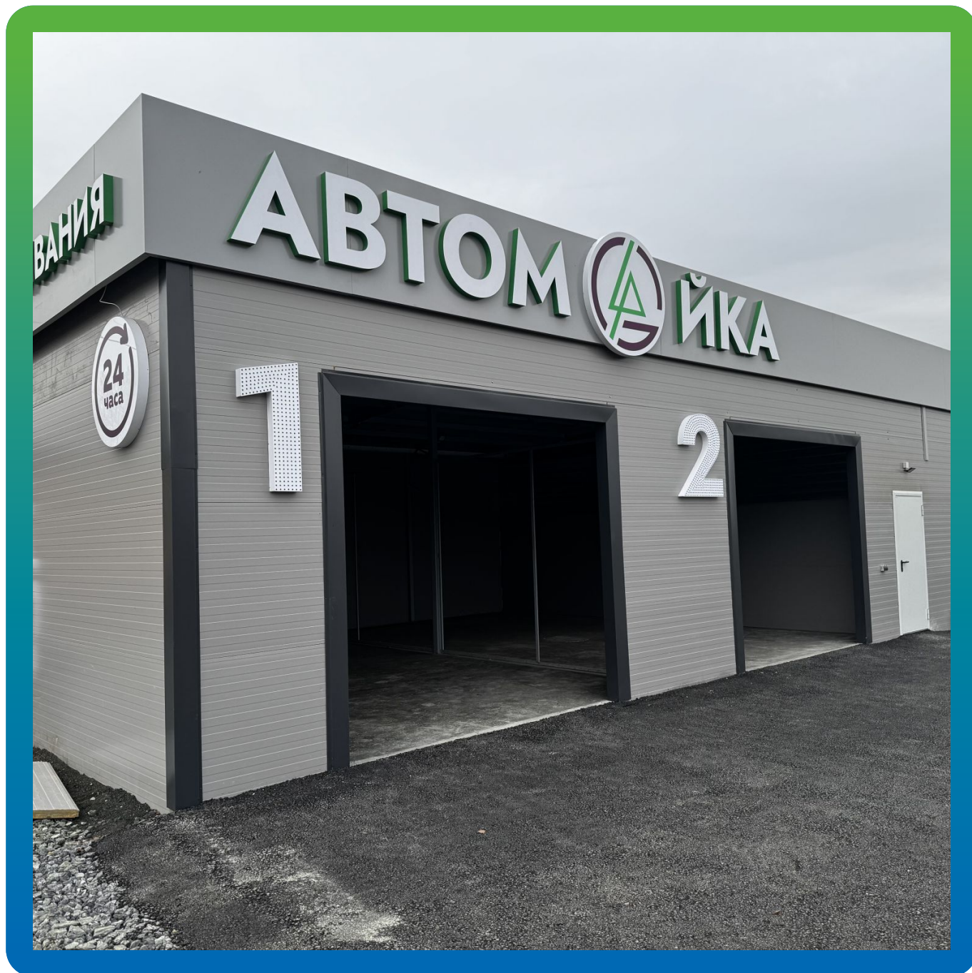
Внешний вид после окончания работ
