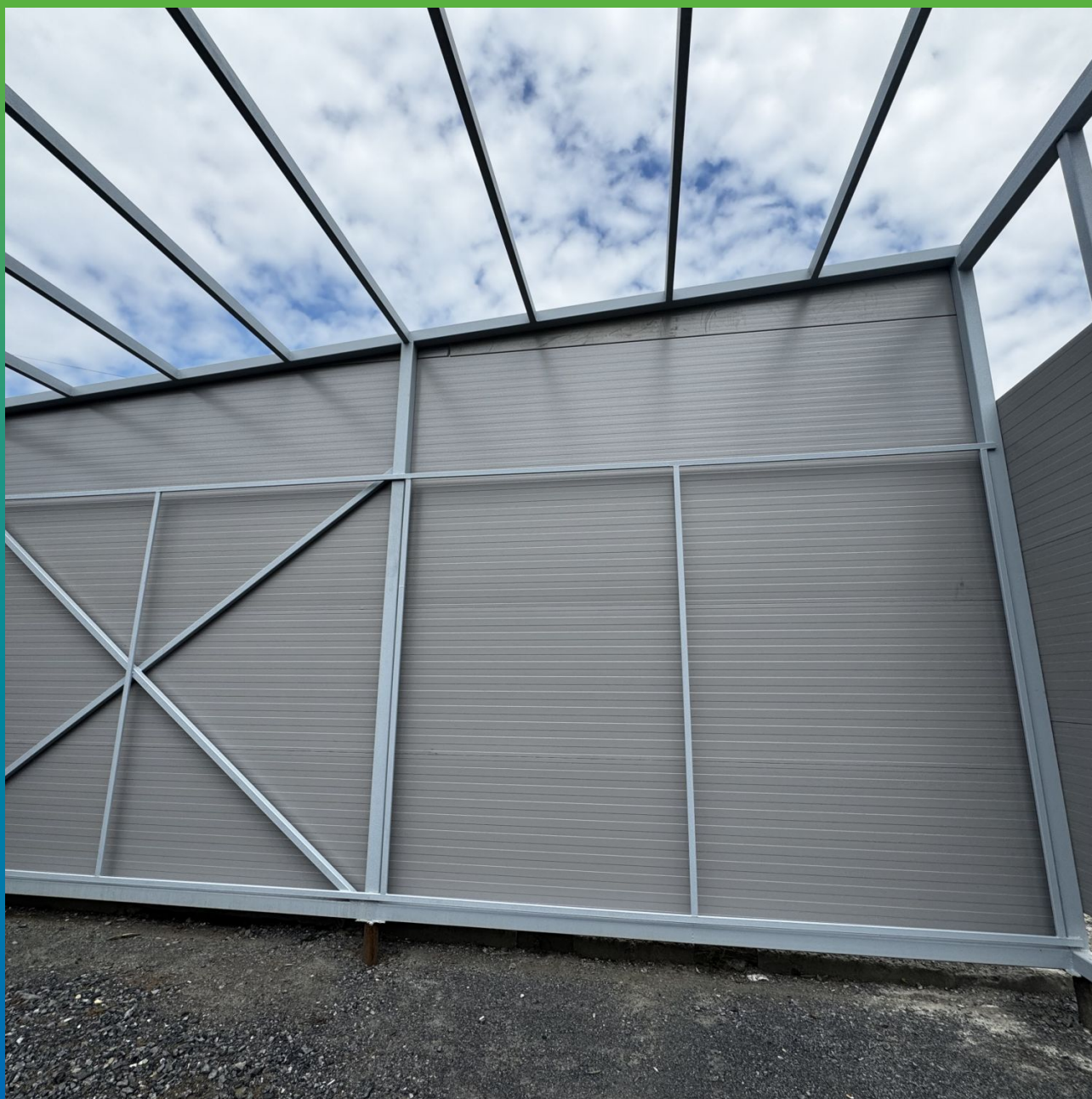
Внешний вид после нанесения двух слоев ДенТоп ПУ 113
