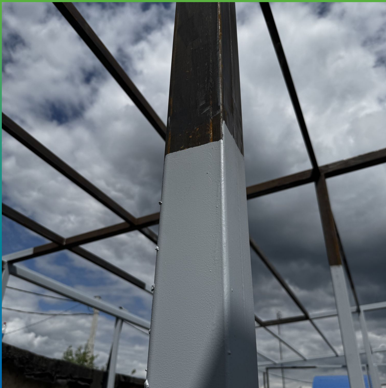
Нанесение первого слоя ДенТоп ПУ 113
