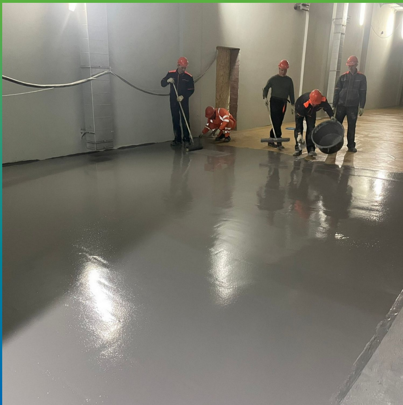
Монтаж цементно-полиуретанового цветного антистатического гладкого покрытия ДенсТоп ПМ 605 Флоу АС
