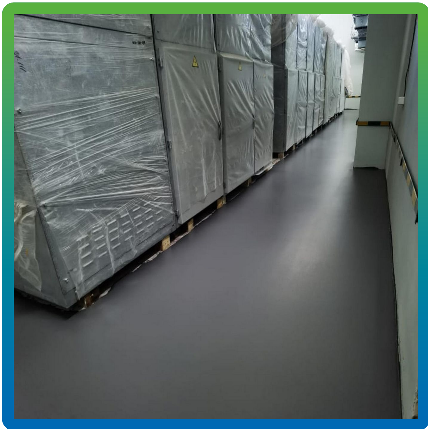
Покрытие ДенсТоп ПМ 605 Флоу АС перед монтажом электрического оборудования
