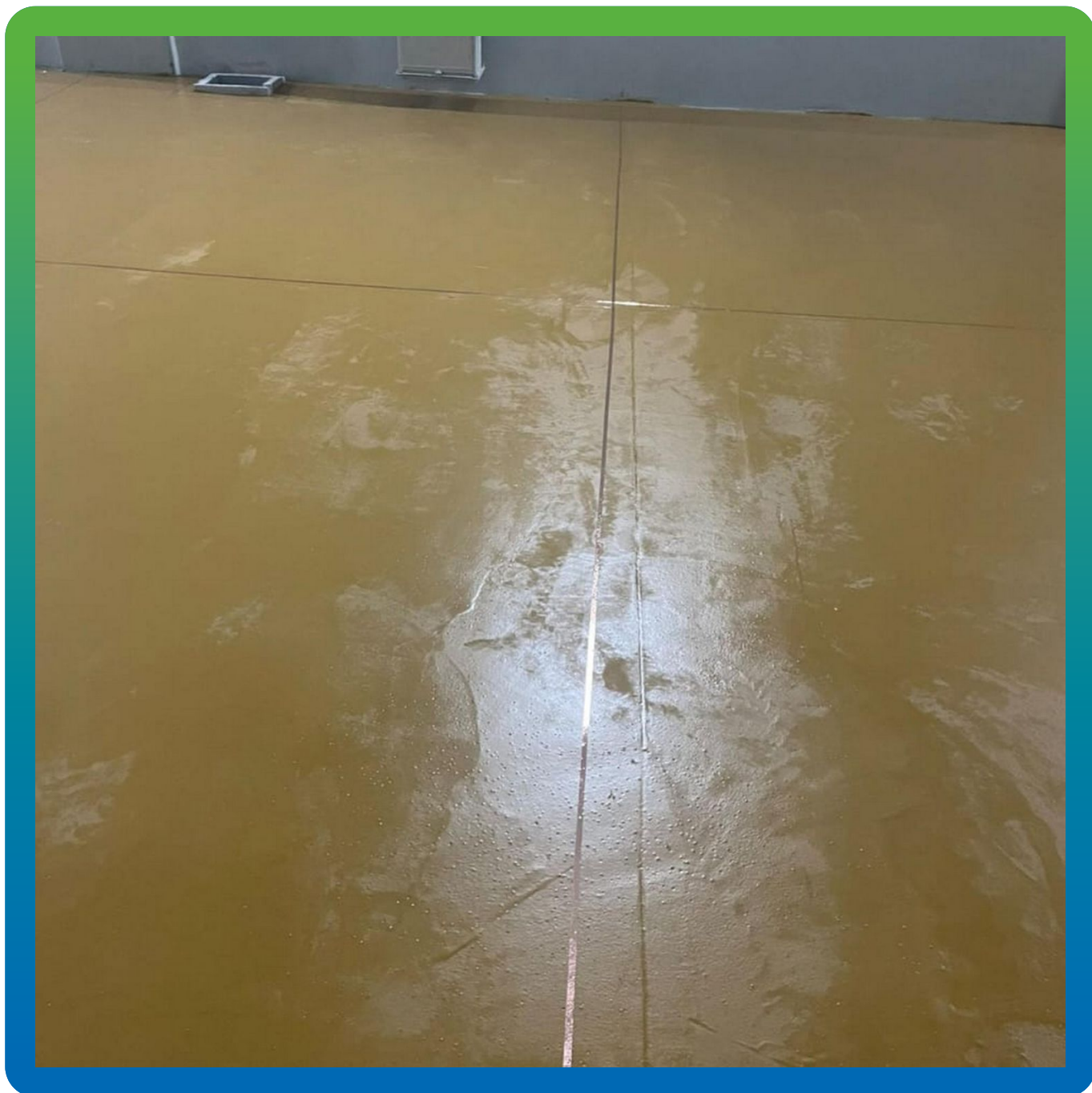
Монтаж токопроводящей ленты ДенсТоп Купрум, с выводом ленты на специальную шину
