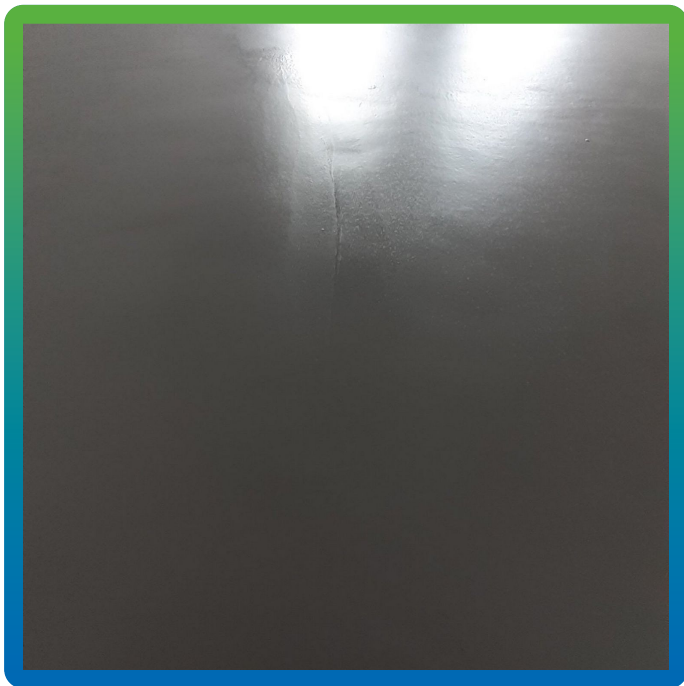
Антистатическое покрытие ДенТоп ПМ 605 Флоу АС после полимеризации
