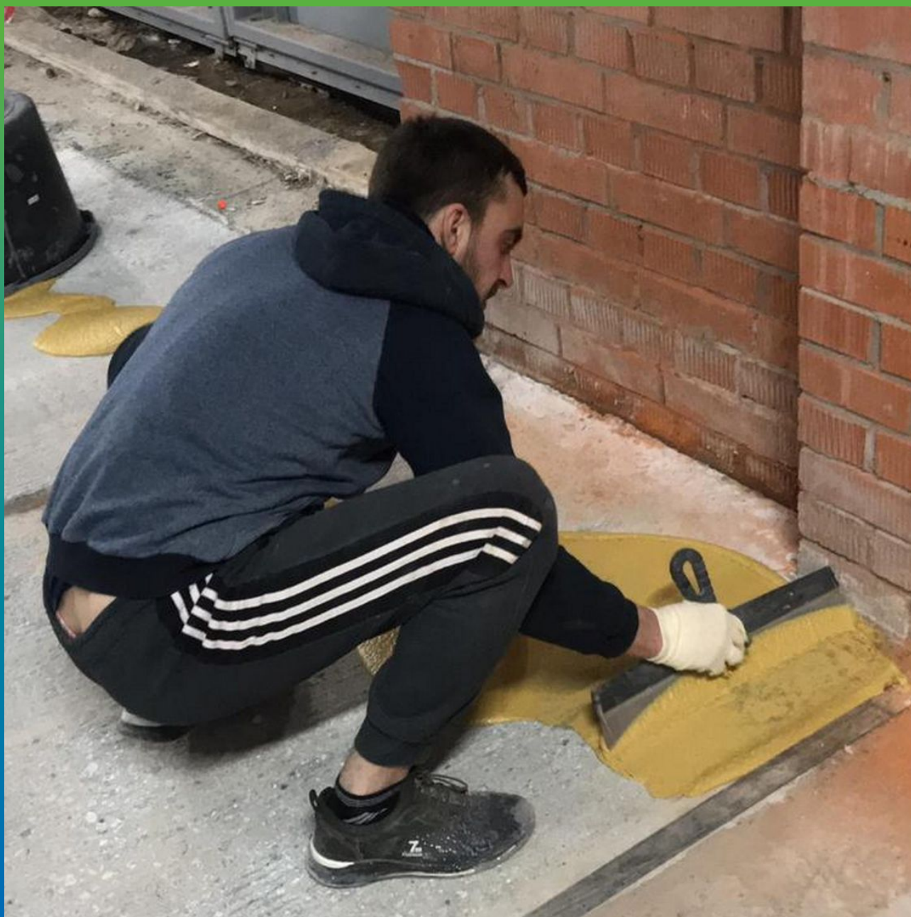
Пробное нанесение грунтовки ДенТоп ПМ 601 на основание с целью определения расхода на 1 м 2
