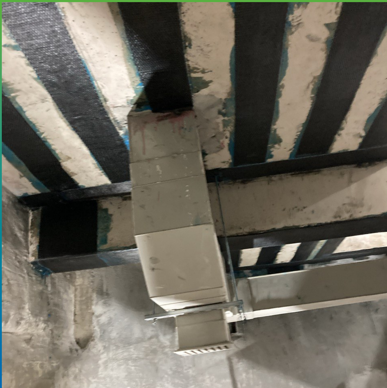
Нанесение Армошел KB 900 на основание.
