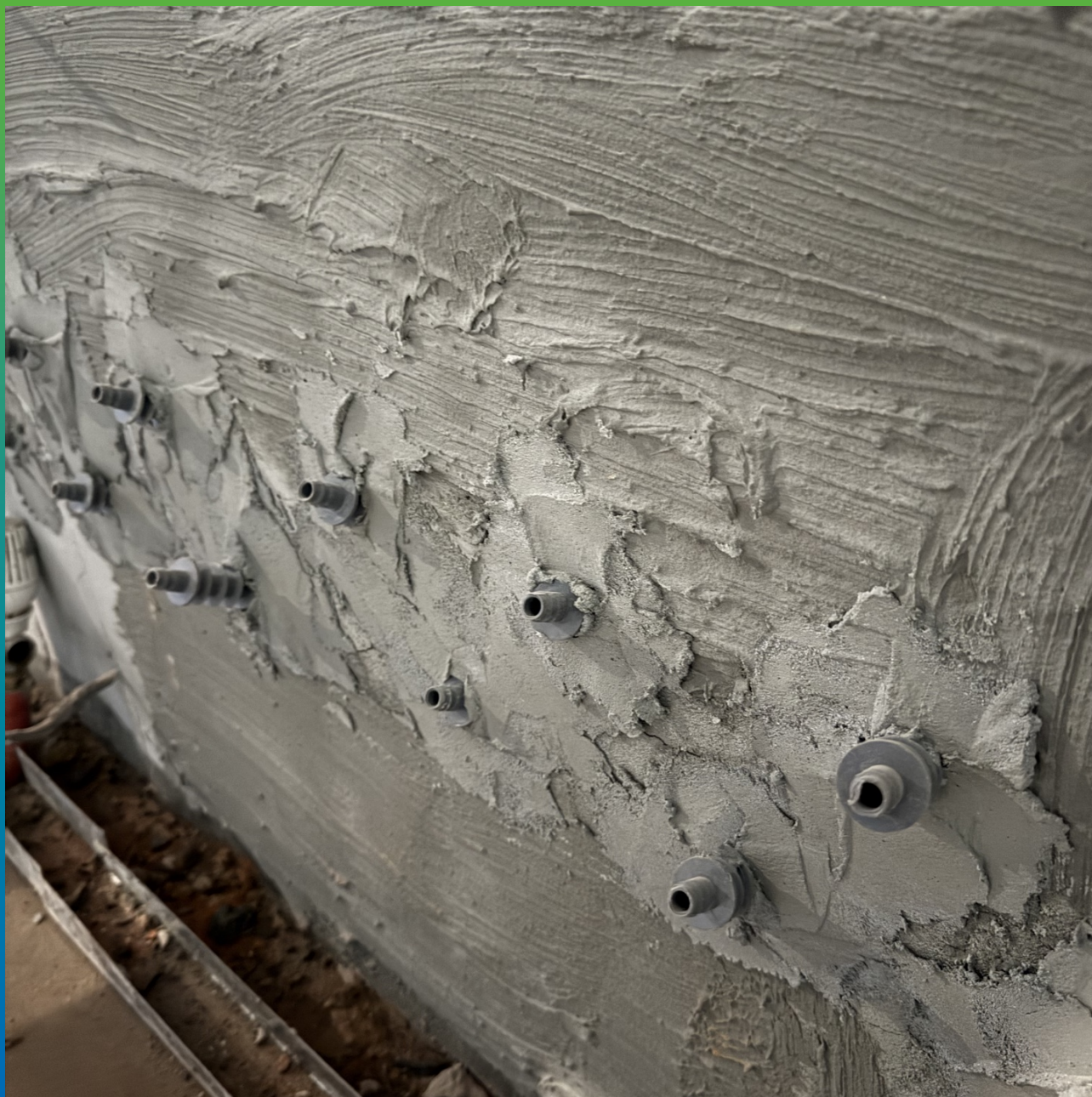
Стена, обработанная составом Стармекс Лайм С и Стармекс Сил Флекс
