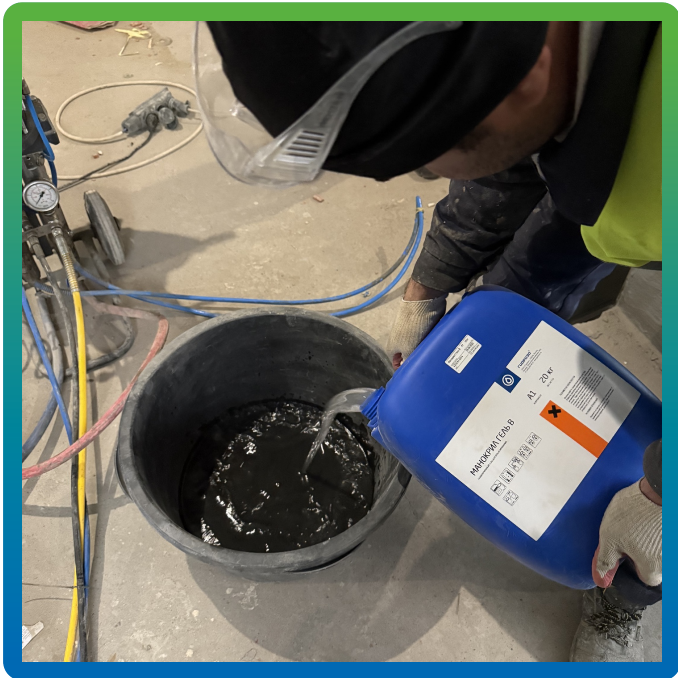
Замешивание компонентов Манокрил Гель В
