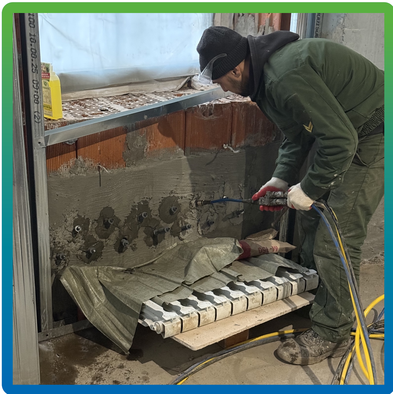
Инъектирование Манокрил Гель В
