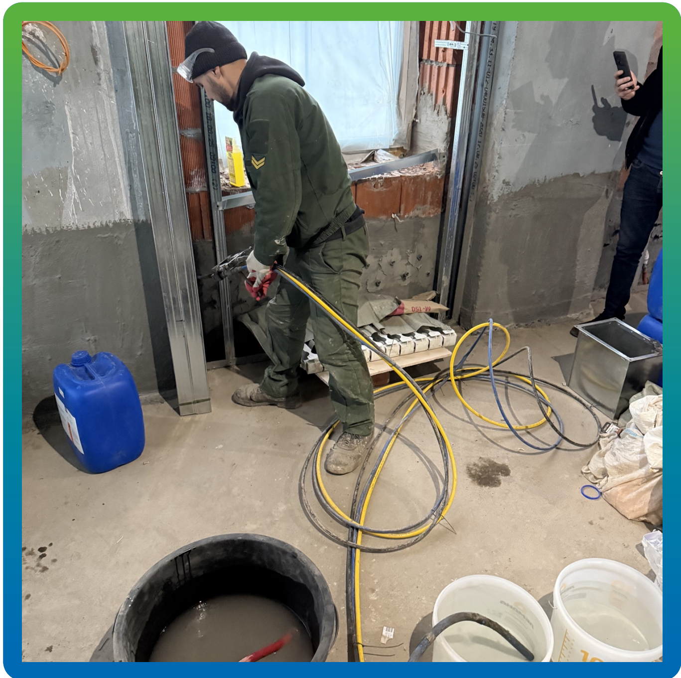
Инъектирование Манокрил Гель В
