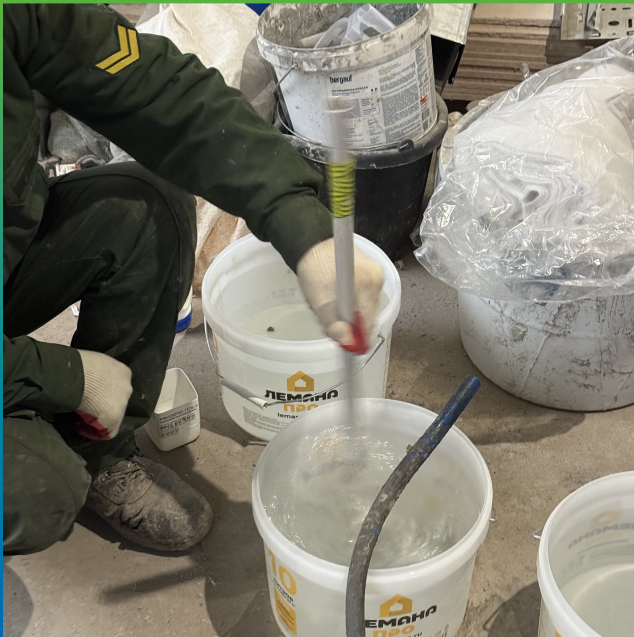
Замешивание компонента Б с водой
