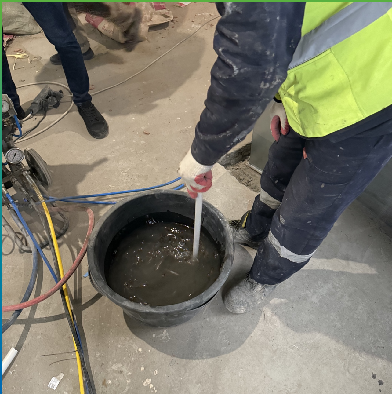
Замешивание компонентов Манокрил Гель В
