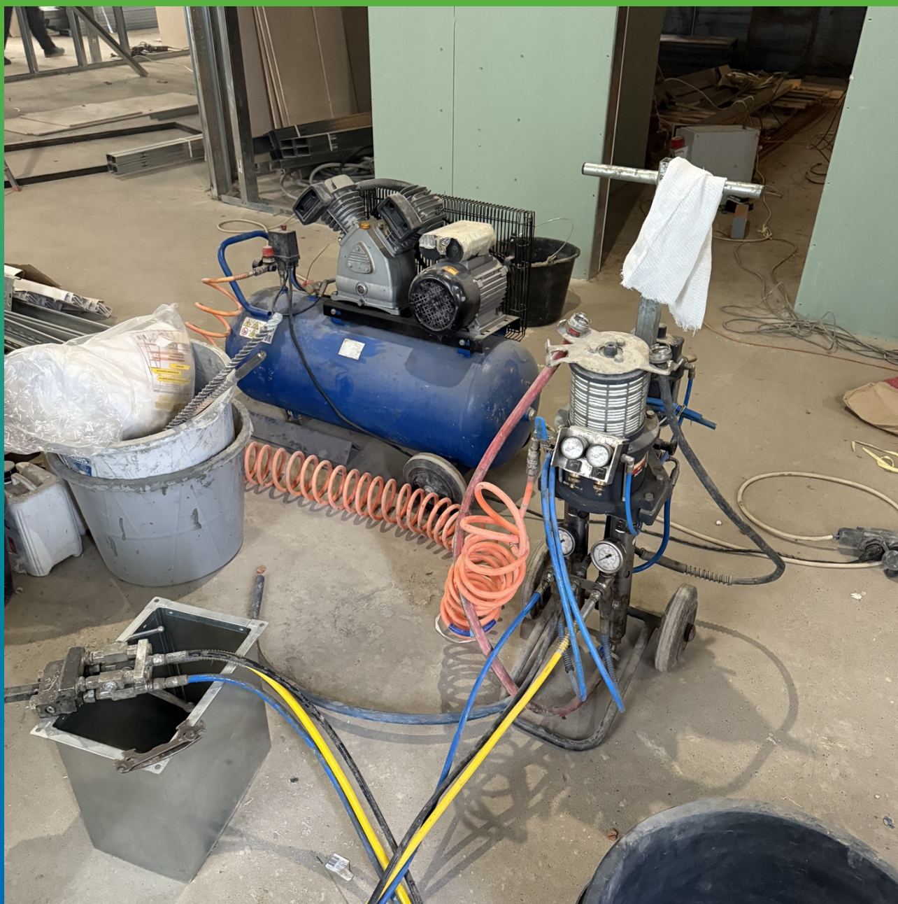
Насос БМ 1425, подготовленный к инъектированию
