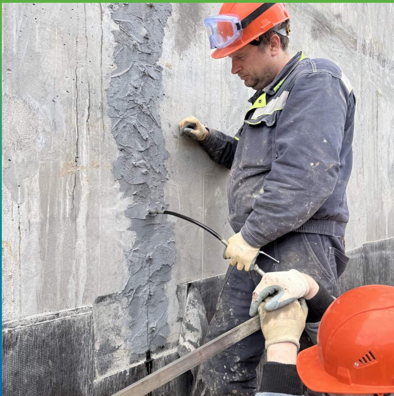
Общий вид производства работ
