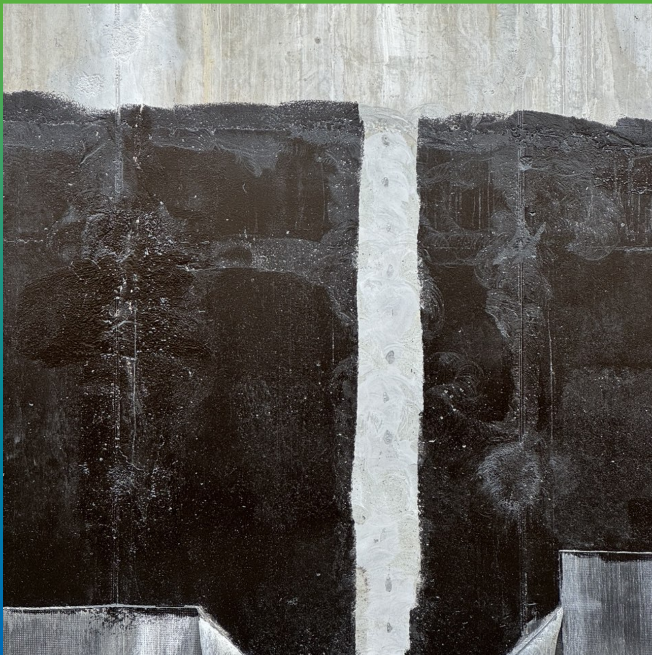
Подготовка основания. Шлифовка трещин
