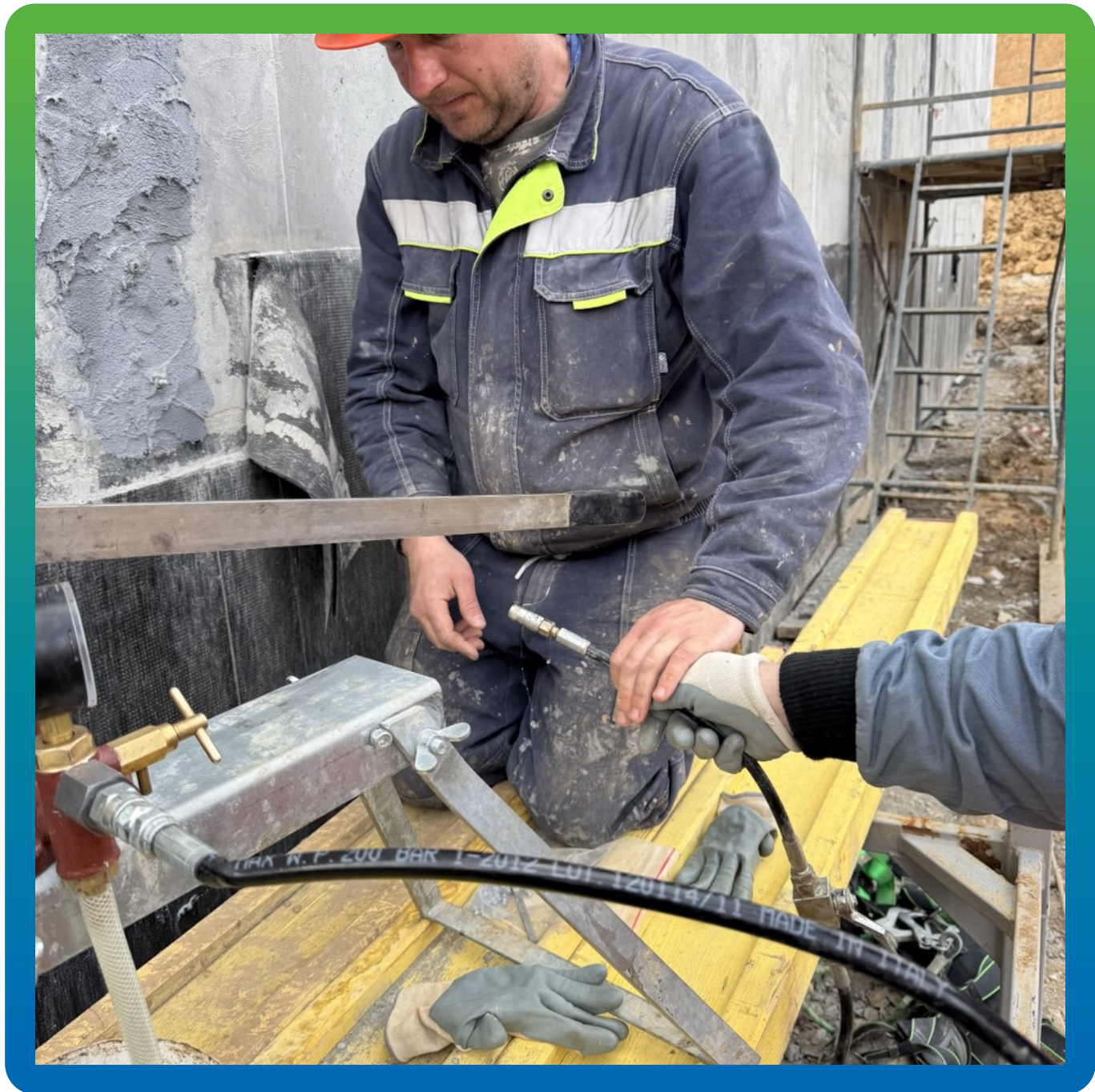
Проверка оборудования перед производством работ
