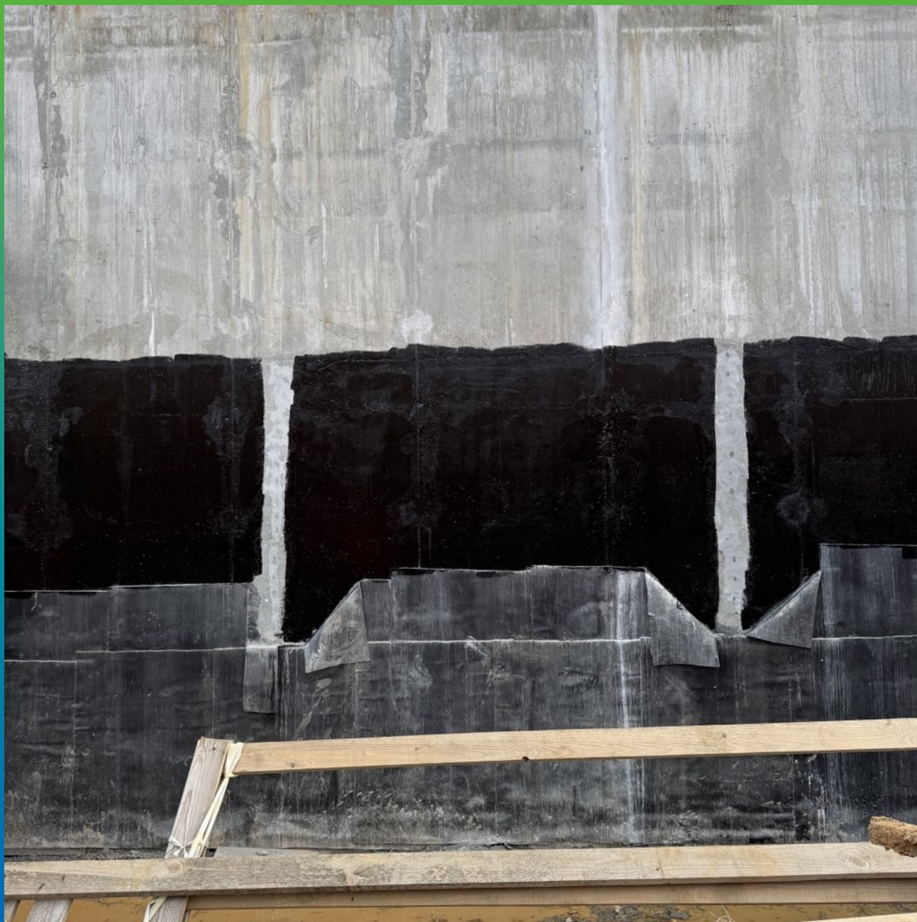
Подготовка основания. Шлифовка трещин
