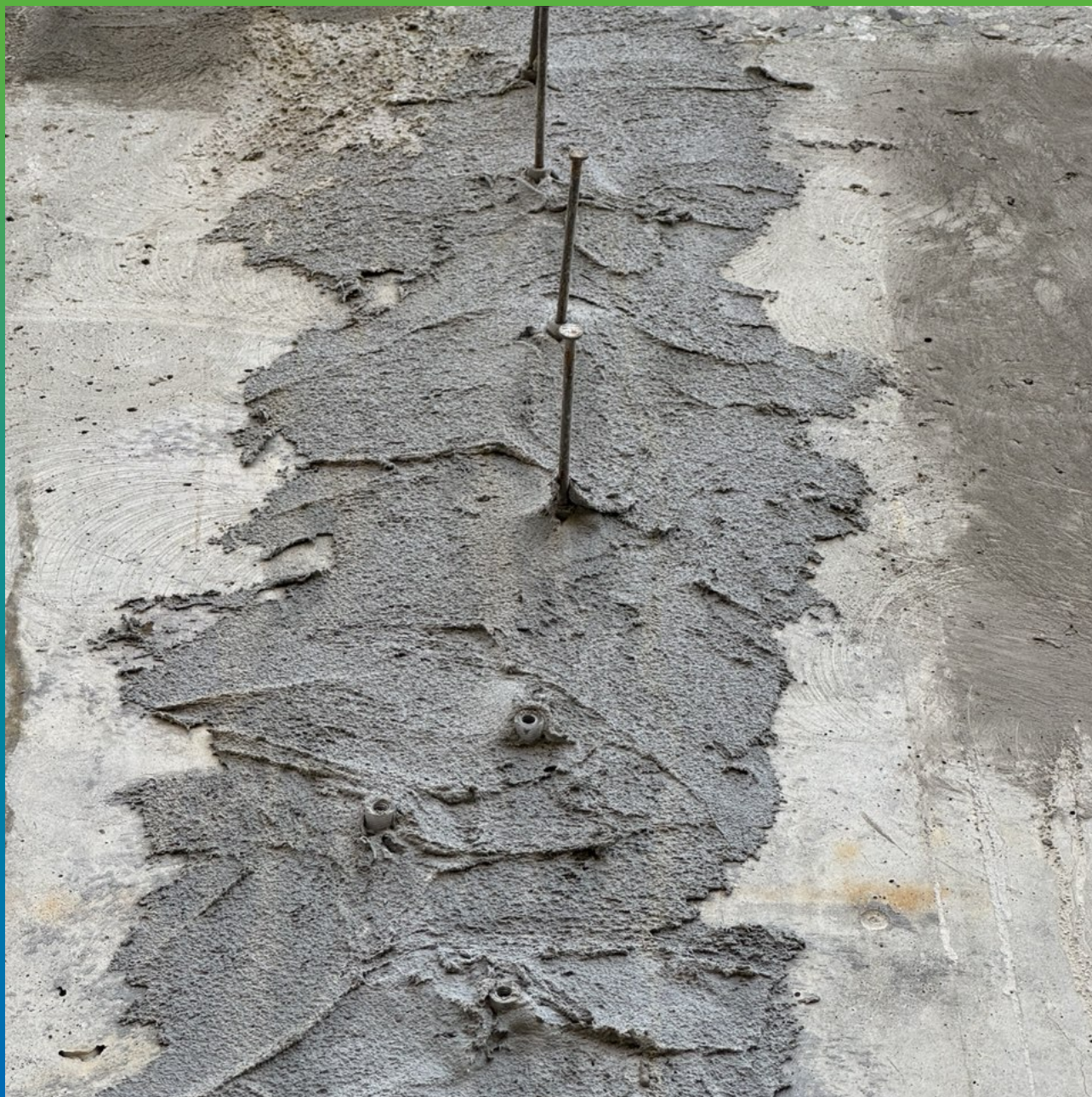
Установка пластиковых пакеров БМ 0187 на клей Манопокс 331
