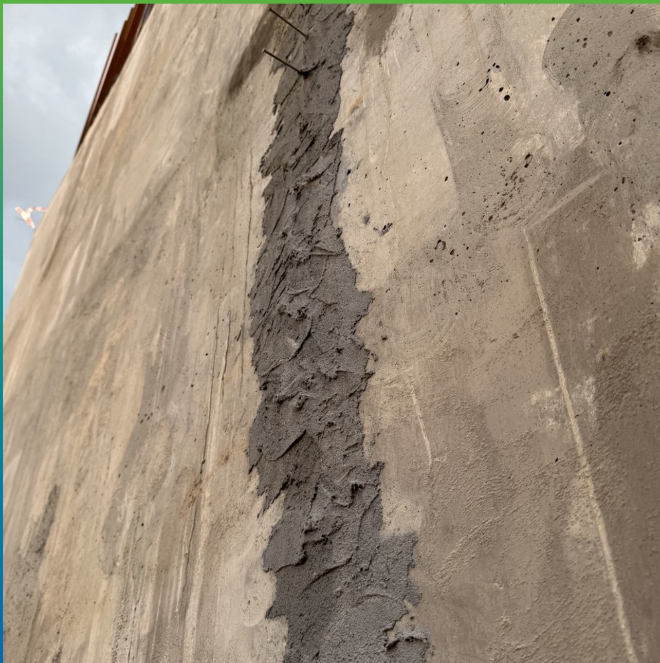
Установка пластиковых пакеров БМ 0187 на клей Манопокс 331
