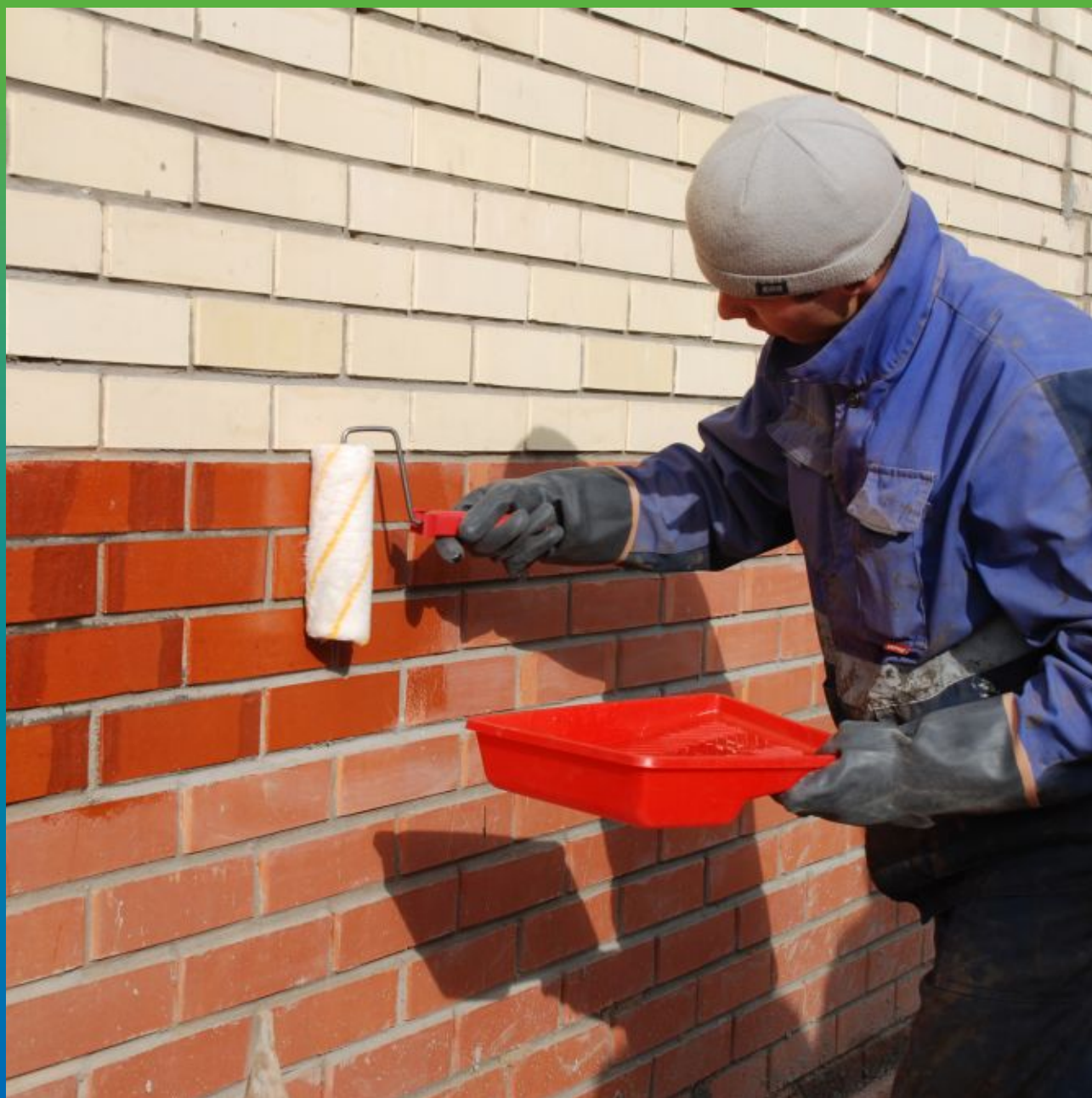
Грунтовка поверхности смолой Тайфо С
