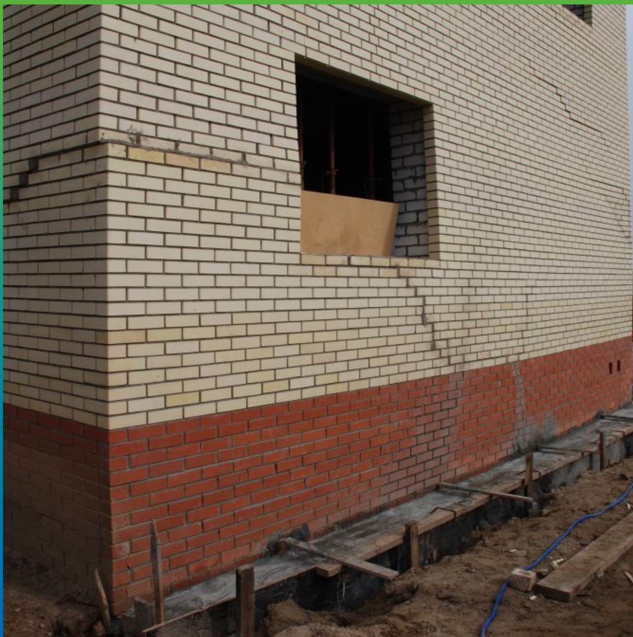
Фасад коттеджа до начала производства работ
