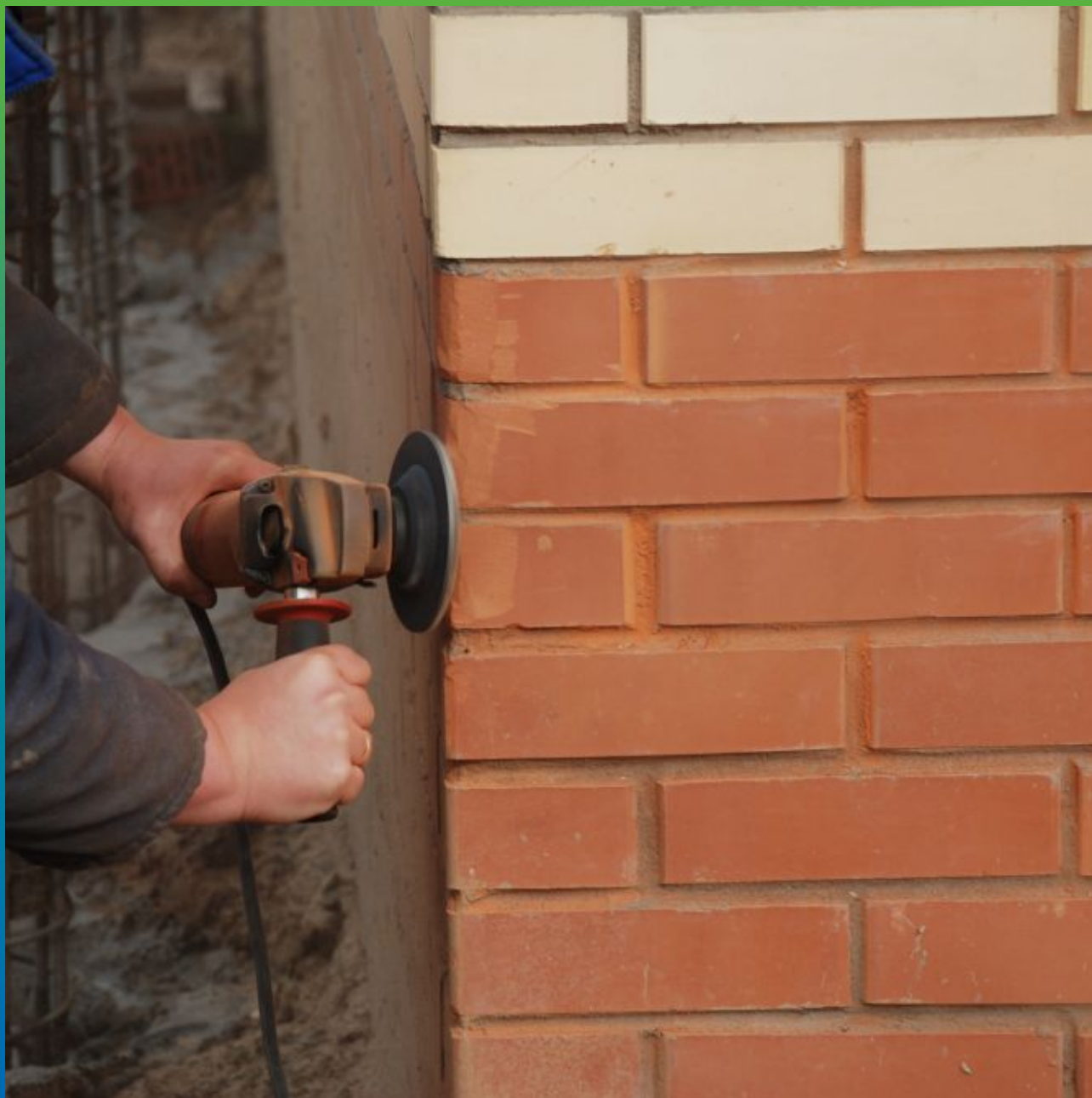
Выравнивание поверхности
