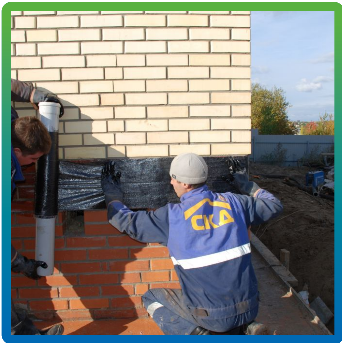
Нанесение волокна на подготовленную поверхность
