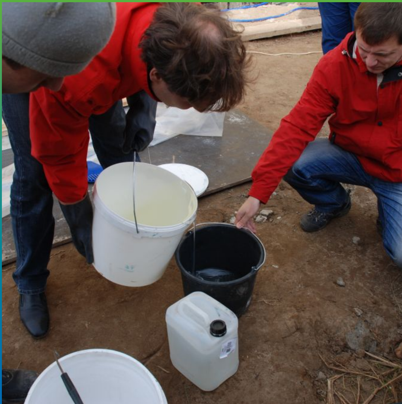
Приготовление эпоксидной смолы Тайфо С
