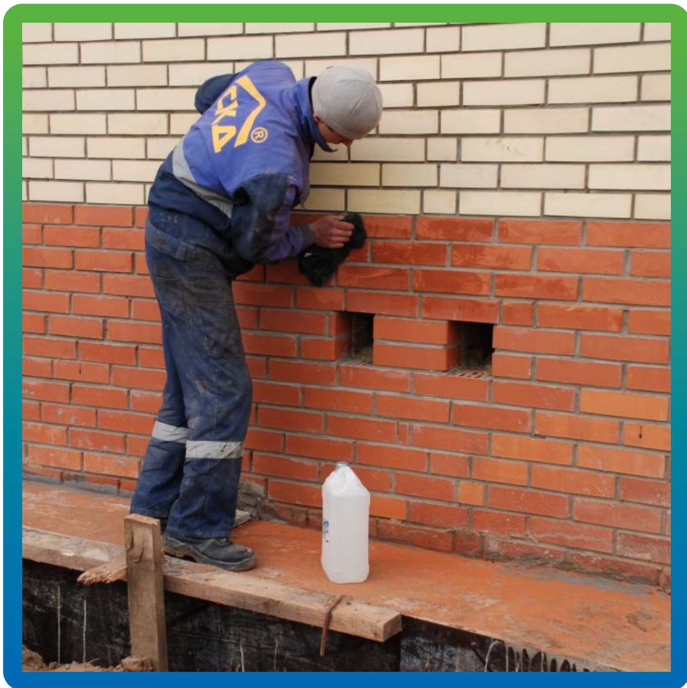
Обезжиривание поверхности
