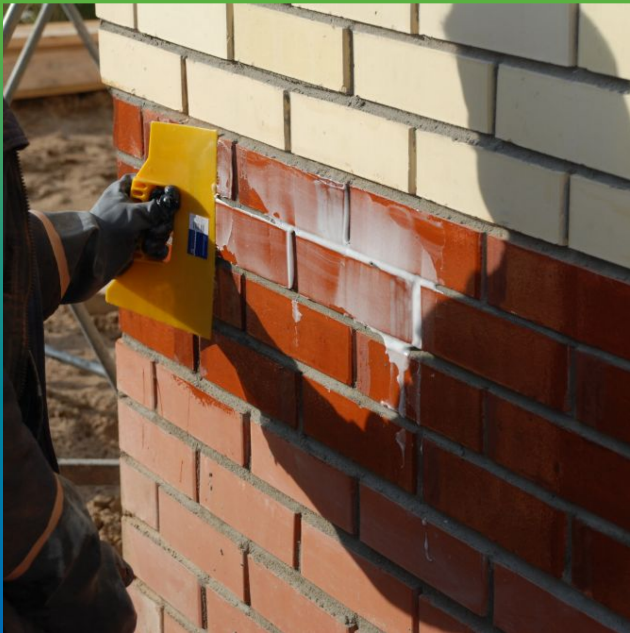
Грунтовка поверхности Тайфо ТХ
