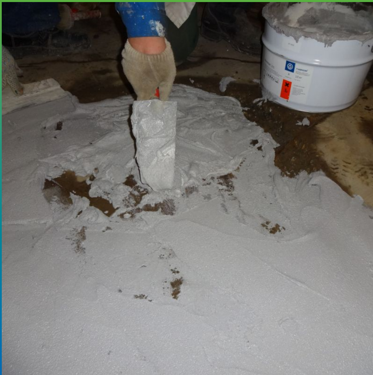
Ремонт разрушенного напольного покрытия составом Манопокс 331
