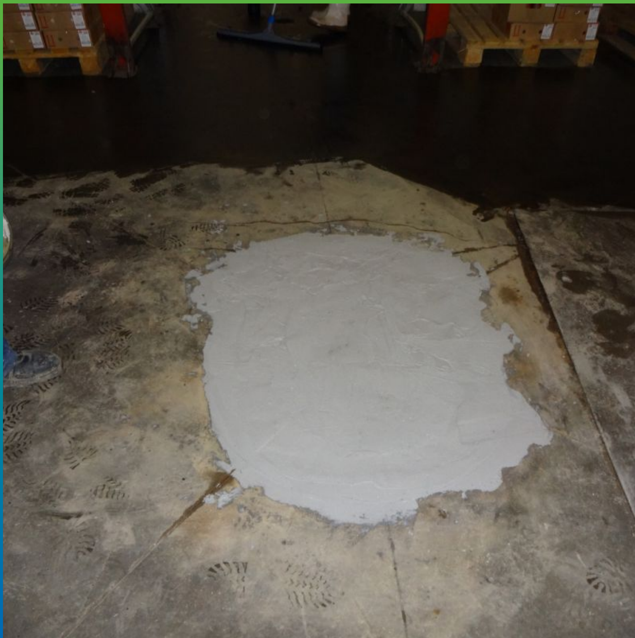
Отремонтированные дефекты напольного покрытия
