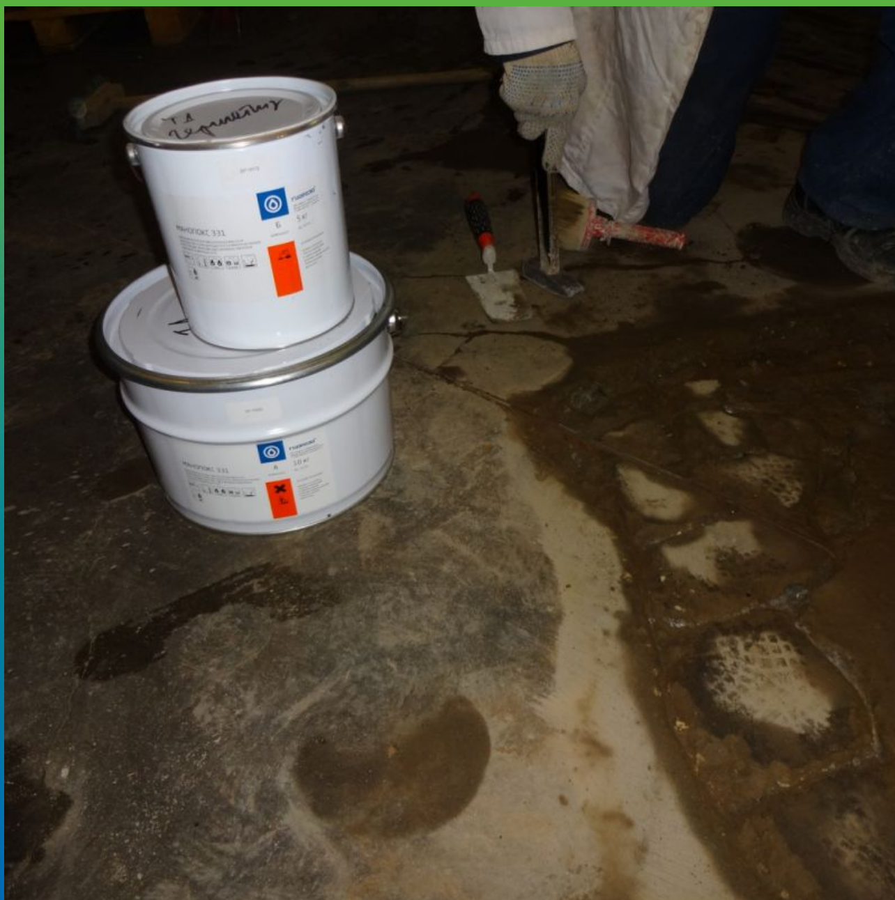
Материалы "Гидрозо" на объекте
