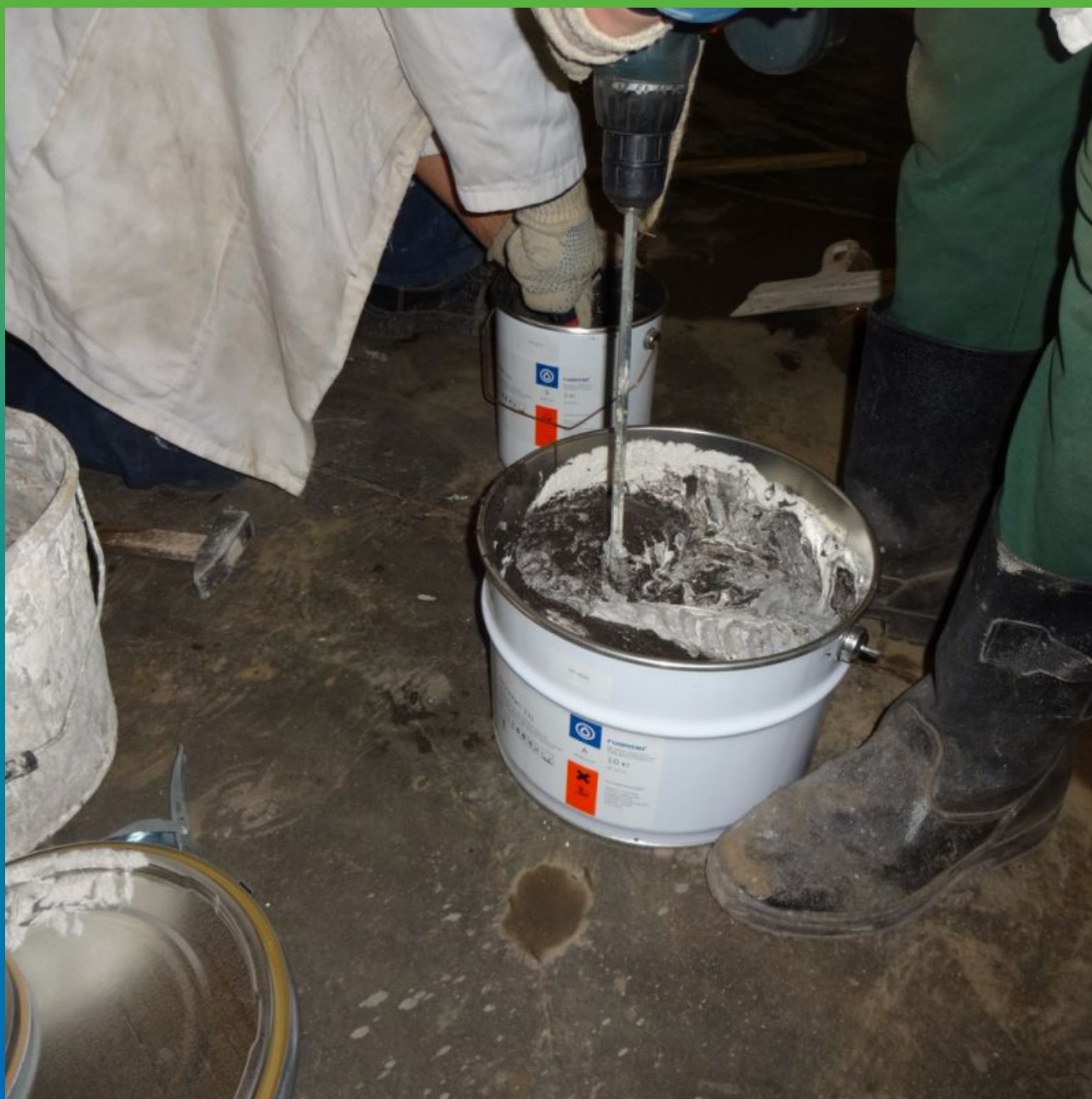
Перемешивание между собой компонентов А+В
