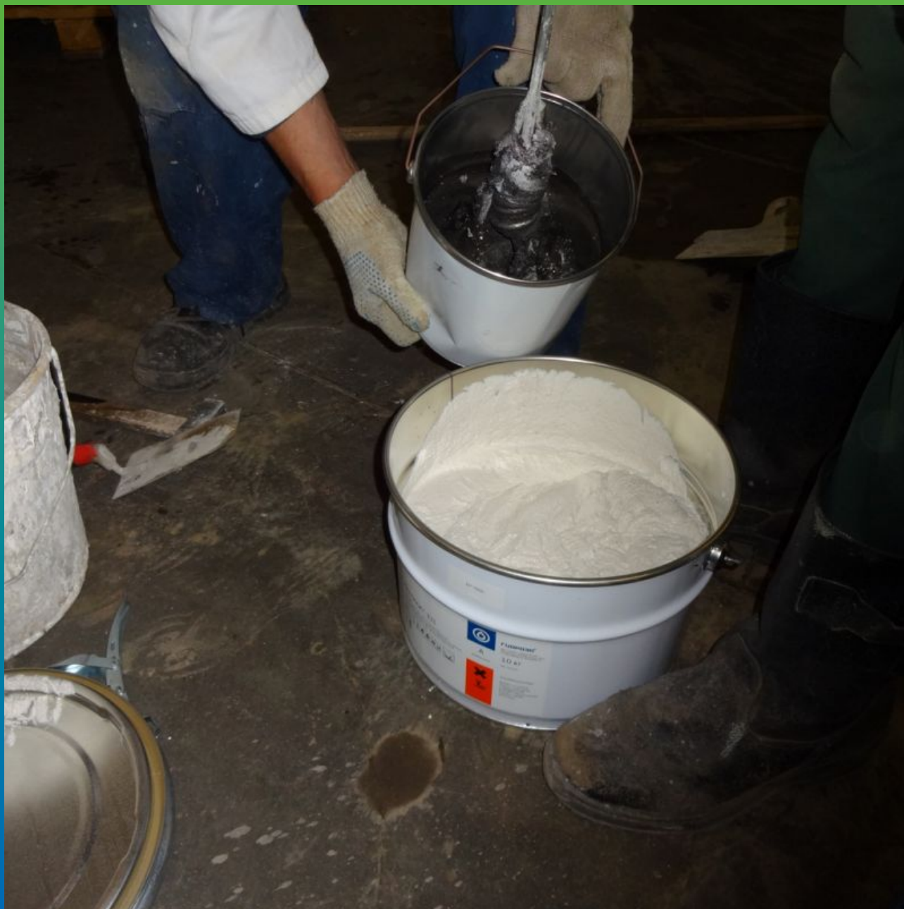
Затворение на площадке компонентов А+В
