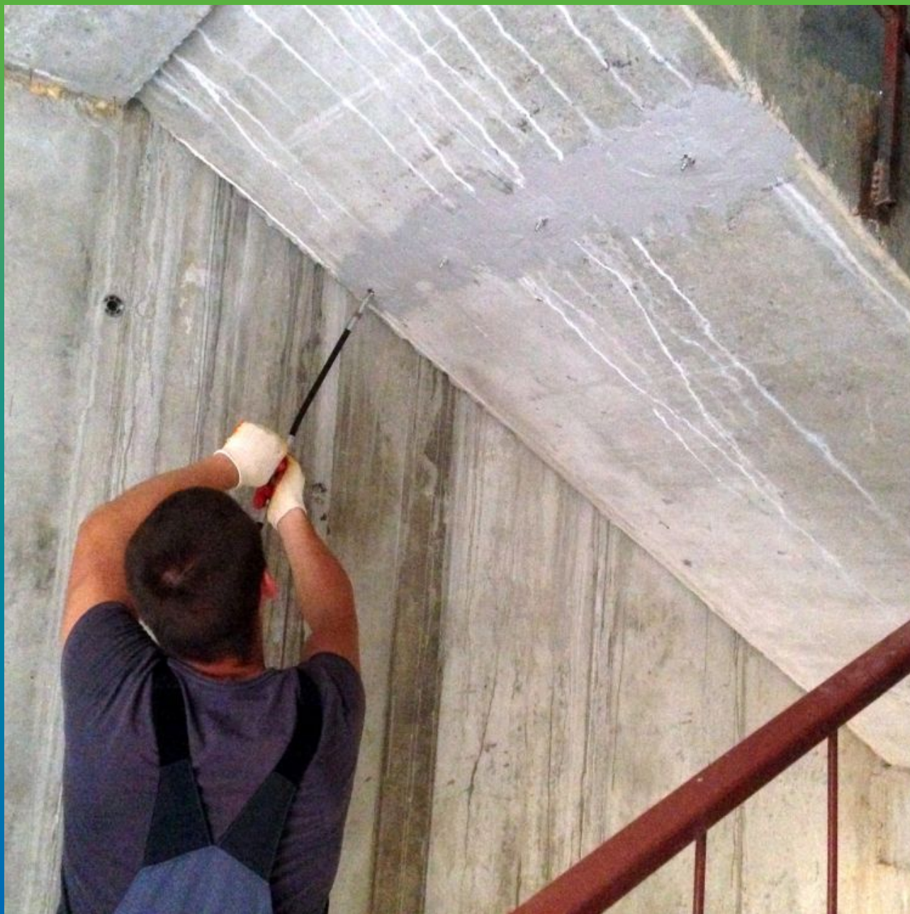
Подготовленное рабочее место к процессу инъектирования. Общий вид.
