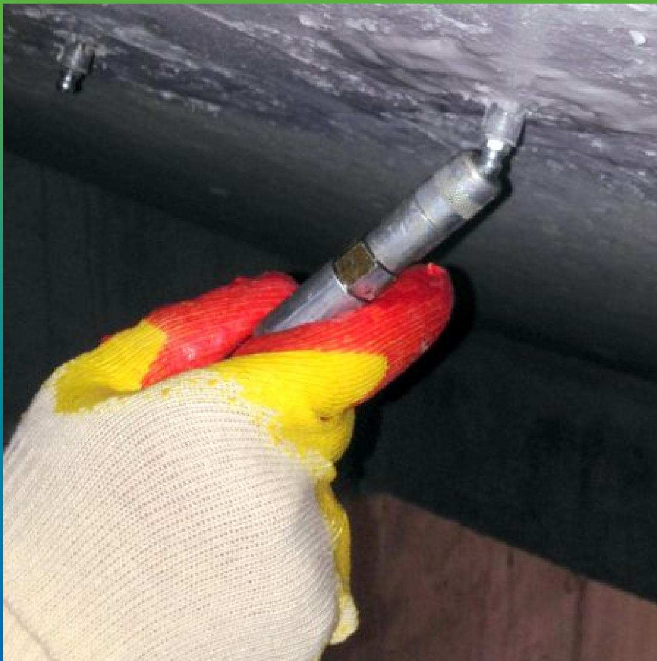
Подсоединение цанговой муфты "БМ 0331" к пакерам через цанговую головку.
