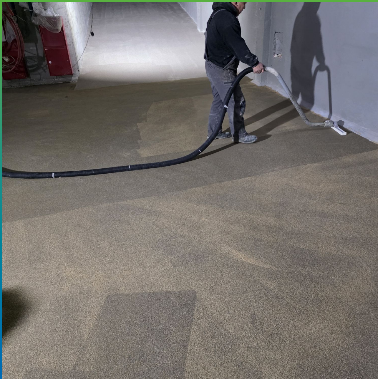
Уборка излишков песка ДенТоп Филлер 01 в зонах проезда
