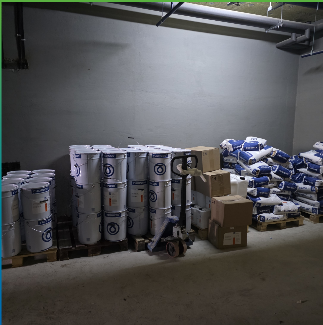
Материалы Гидрозо на объекте
