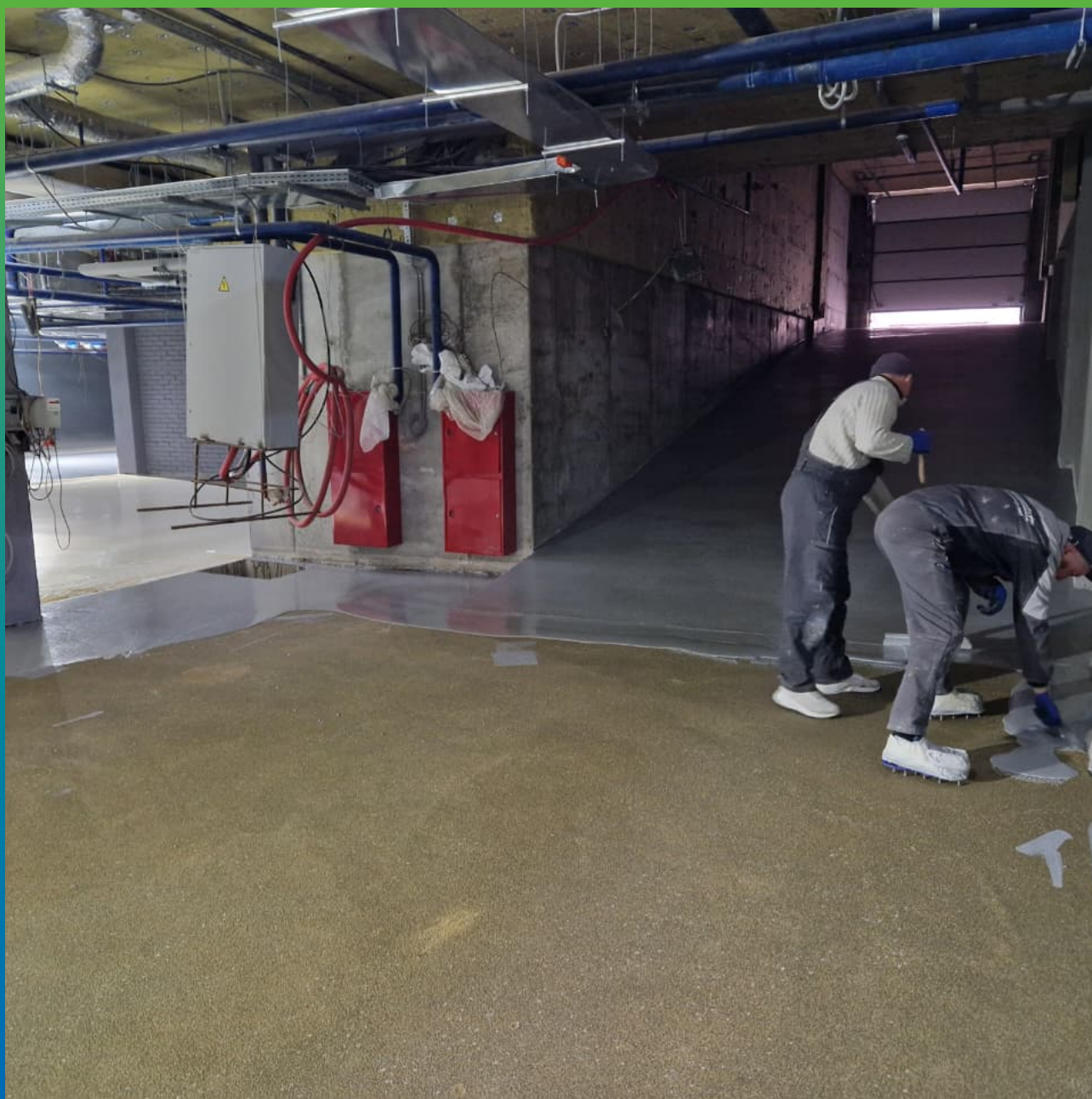
Нанесение ДенТоп ЭП 500 Ral 7040 по зонам проезда и рампе
