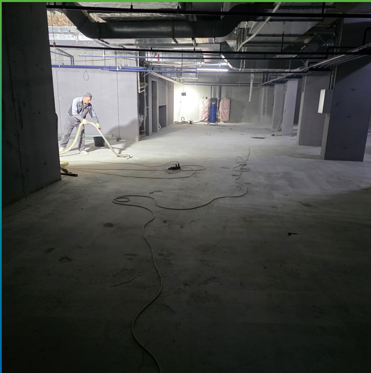
Обеспыливание поверхности промышленным пылесосом
