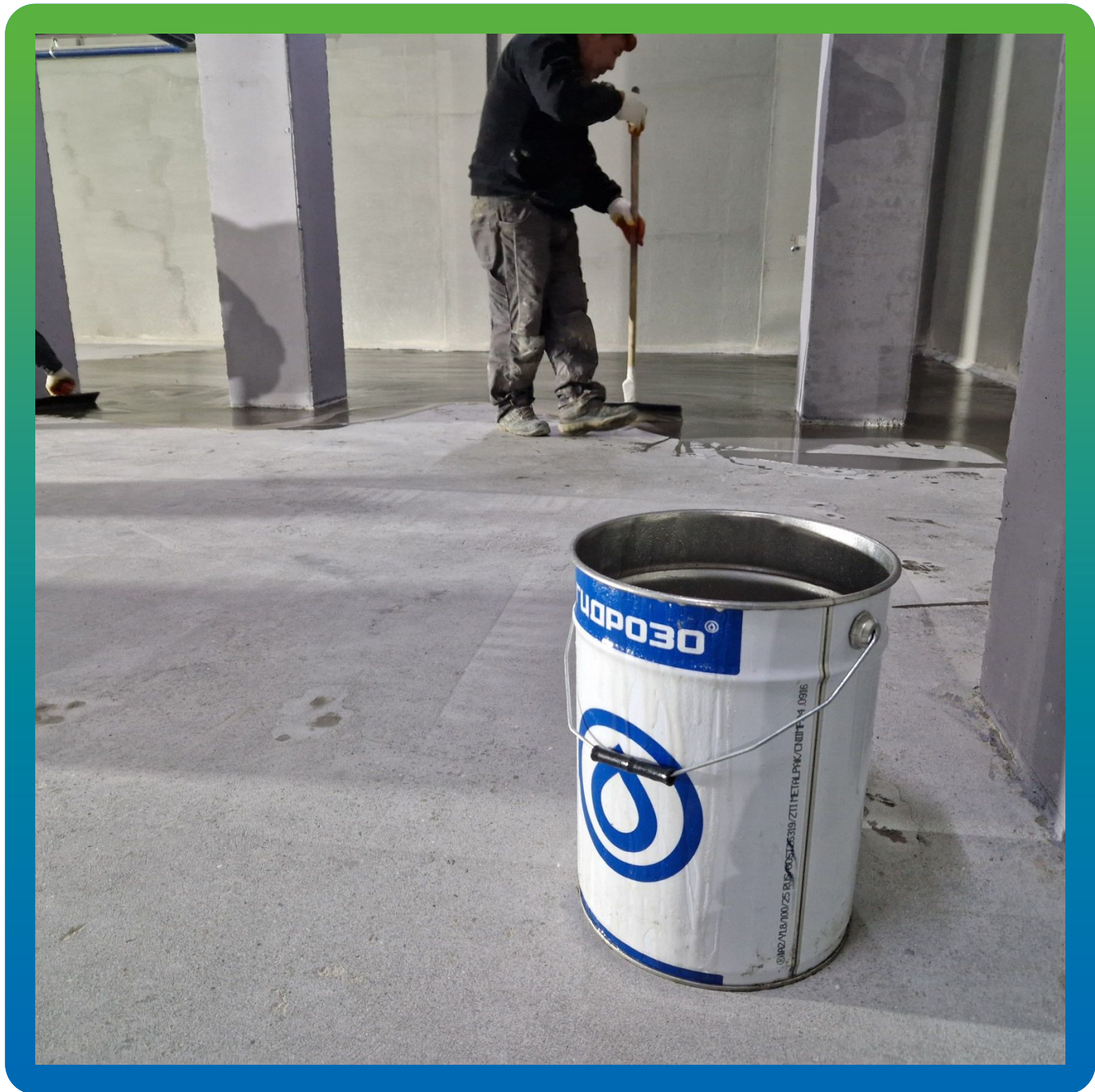
В процессе грунтования
