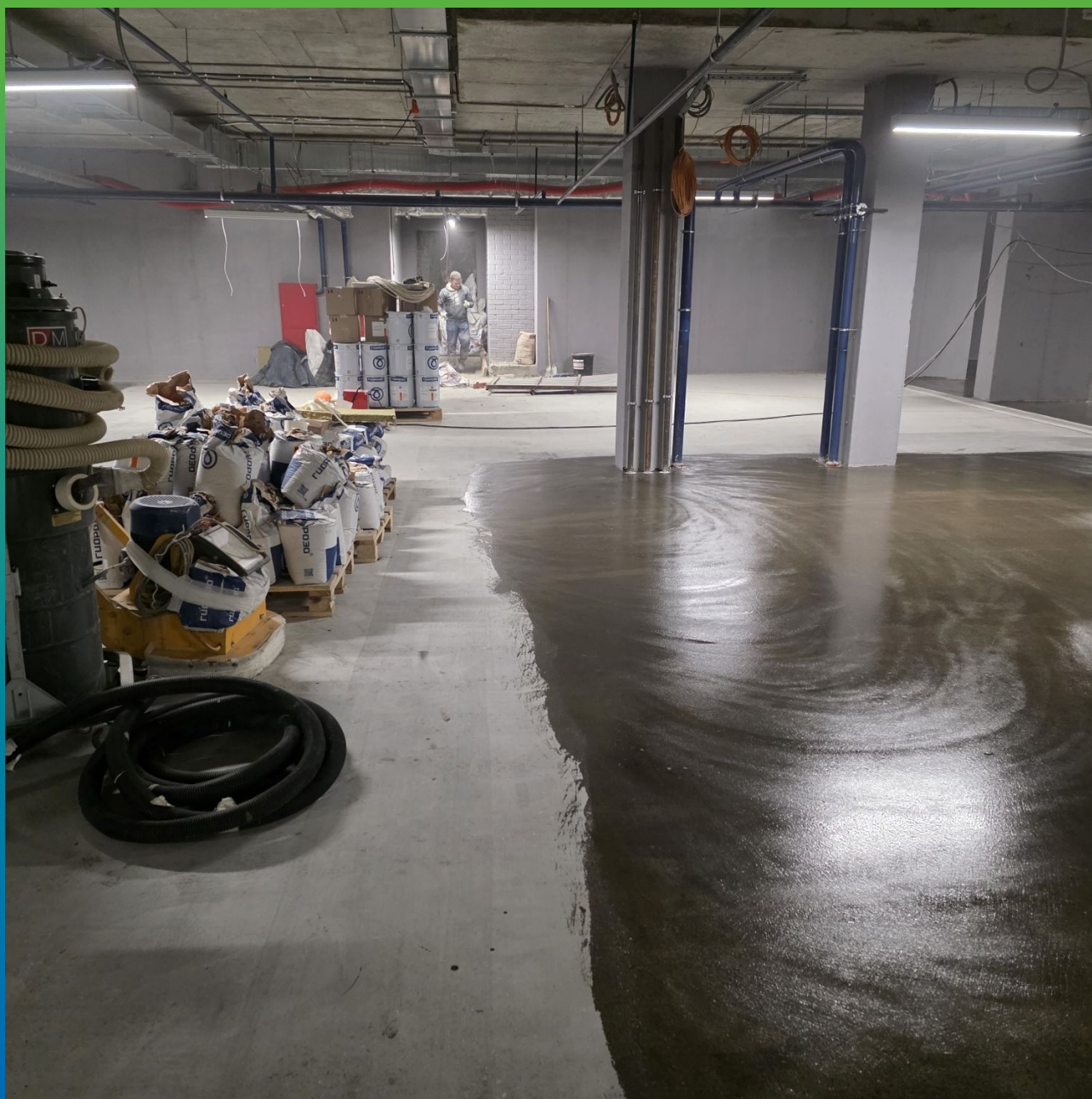
Загрунтованные ДенТоп ЭП 100 участки
