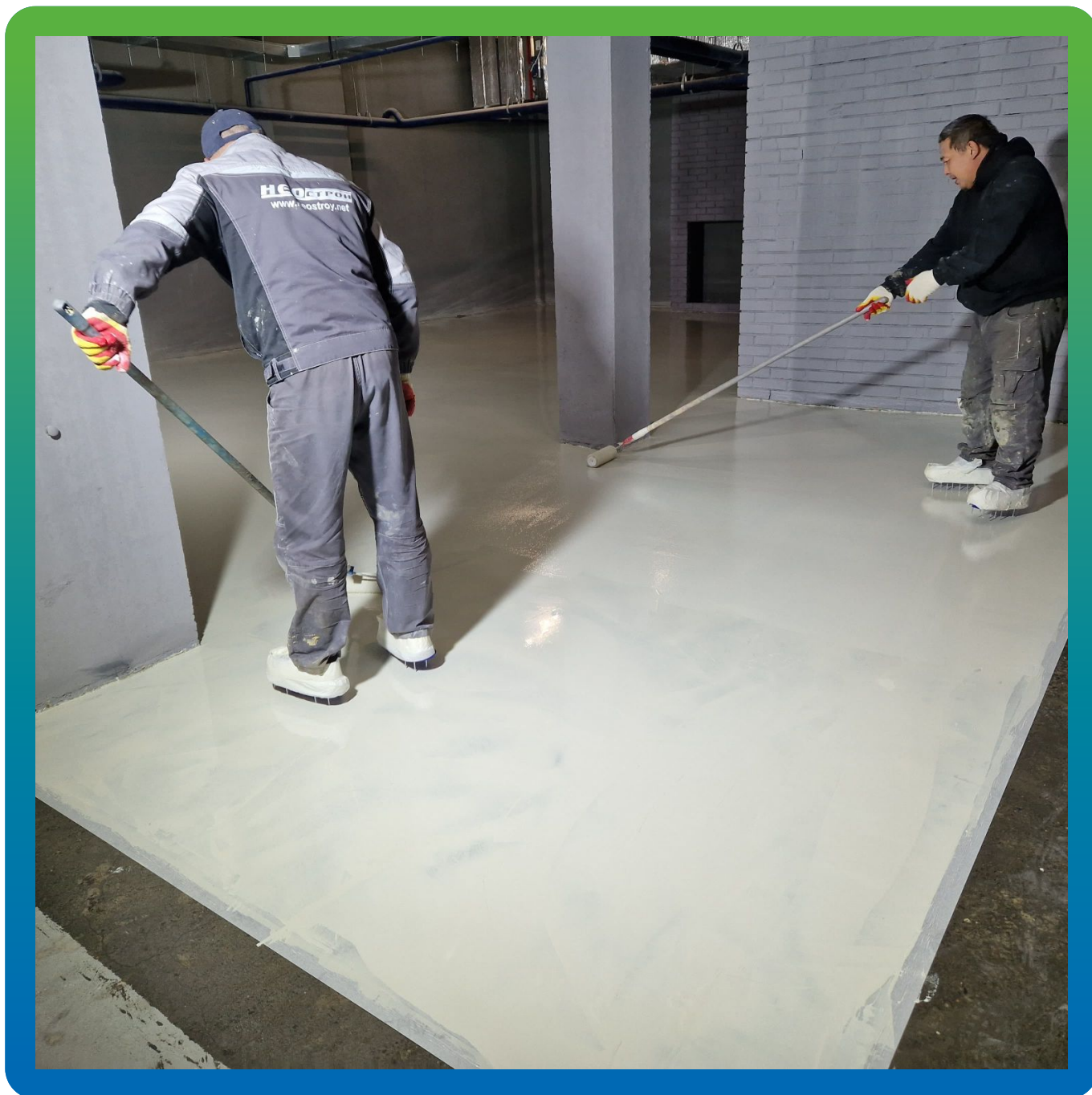
Нанесение ДенТоп ЭП 500 Ral 1013 по стояночным местам
