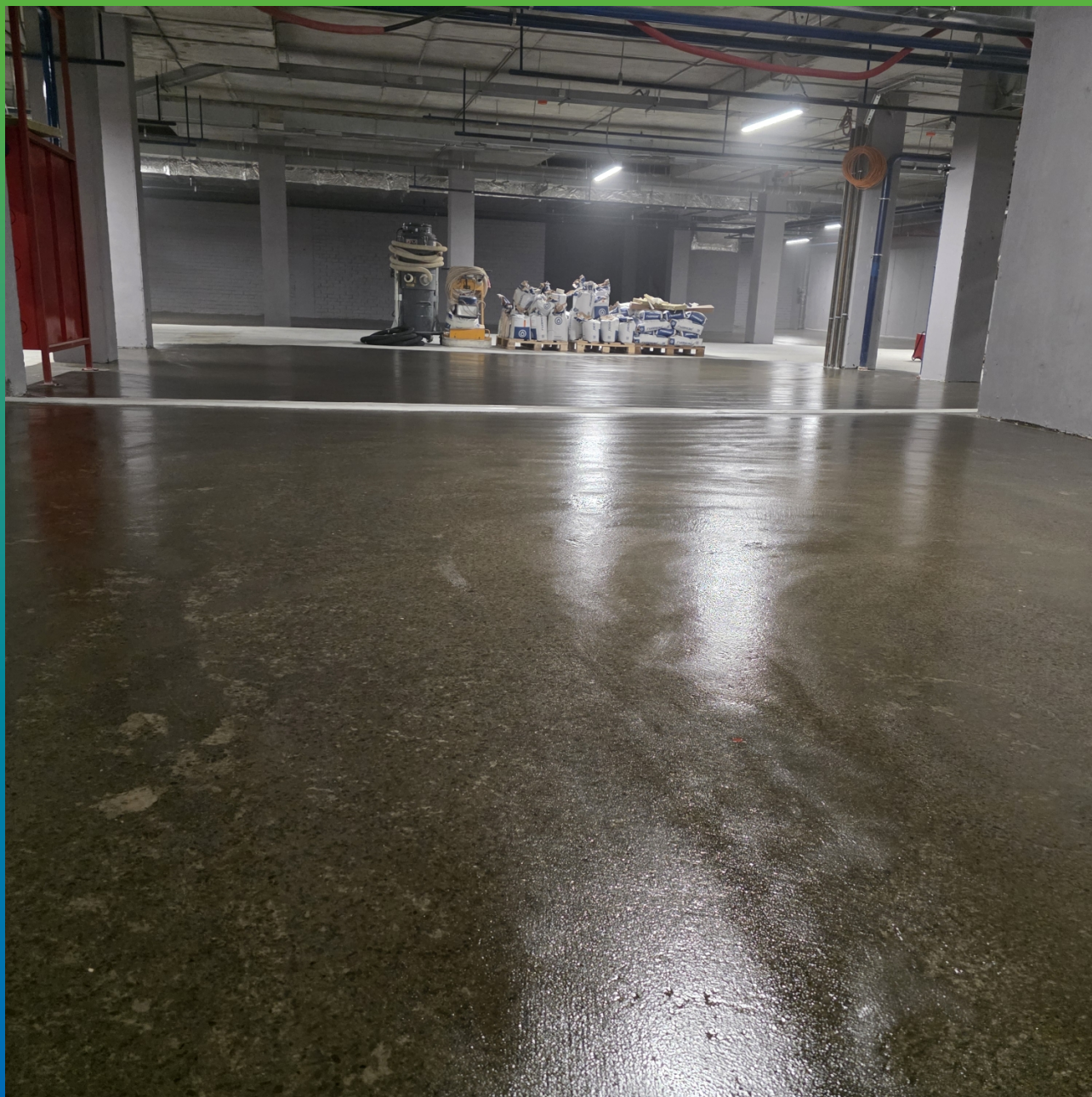
Загрунтованное ДенсТоп ЭП 100 основание
