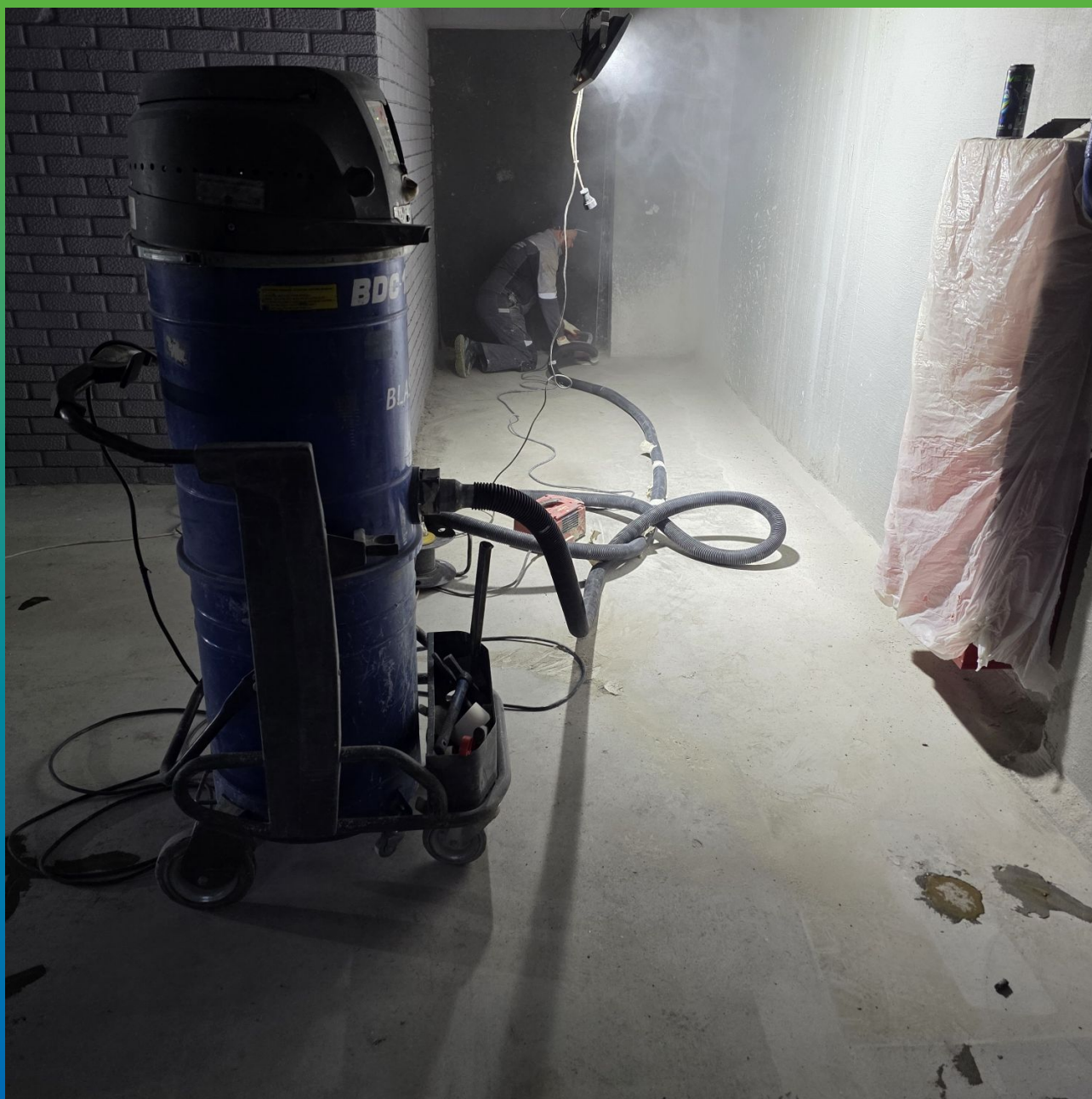
Подготовка поверхности бетона шлифованием
