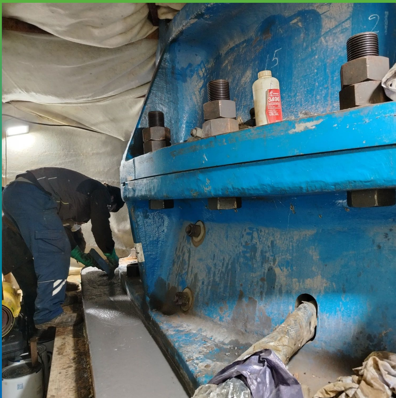
Выравнивание второго слоя
