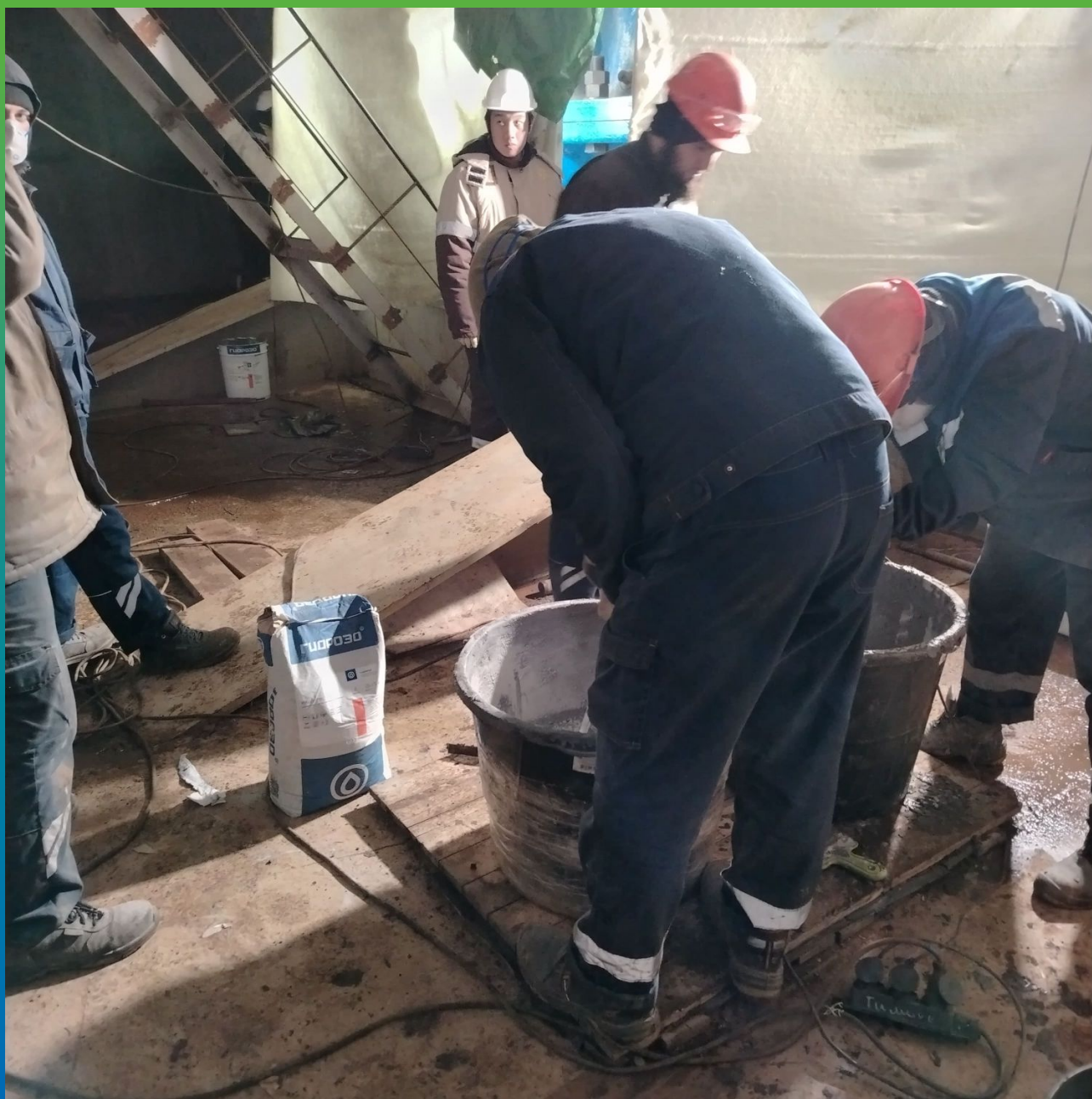
Смешивание жидких компонентов Б1 и Б2
