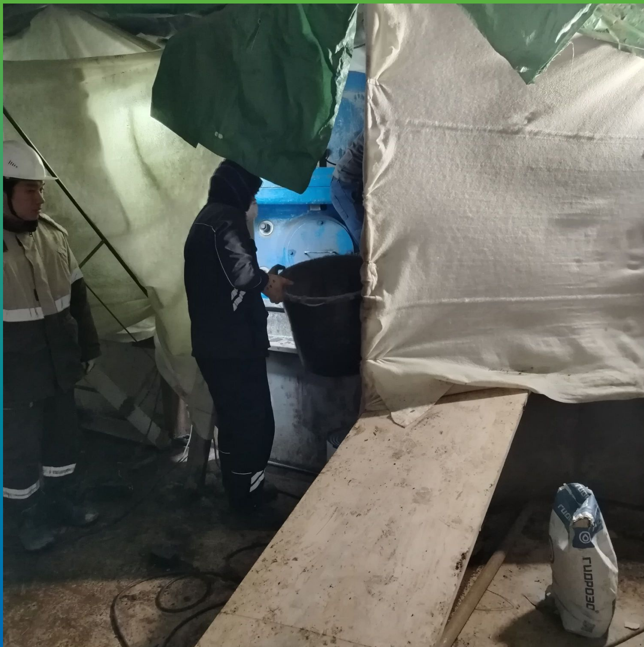
Ручная подача состава в зону опалубки
