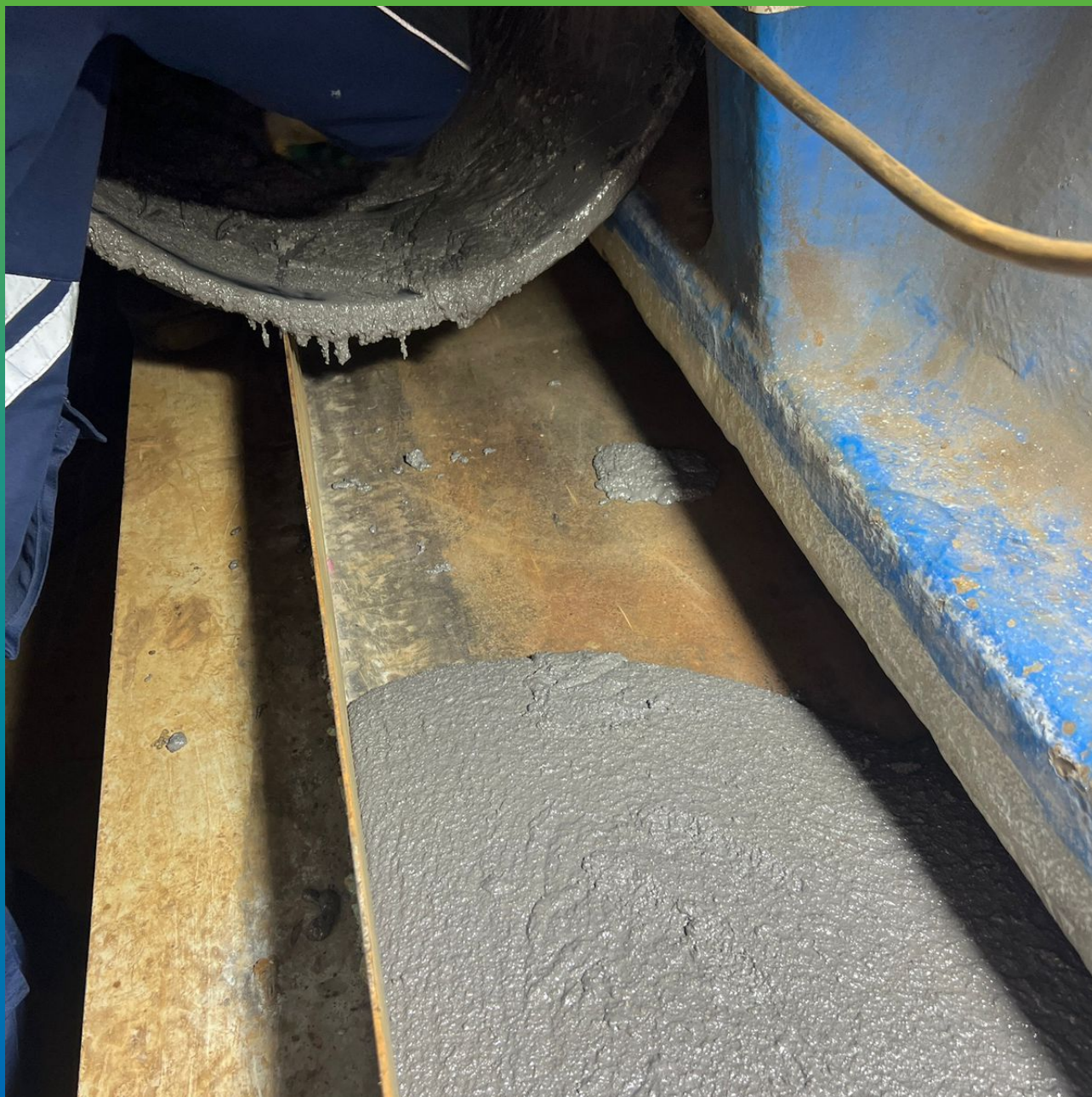
Начало заливки первого слоя состава
