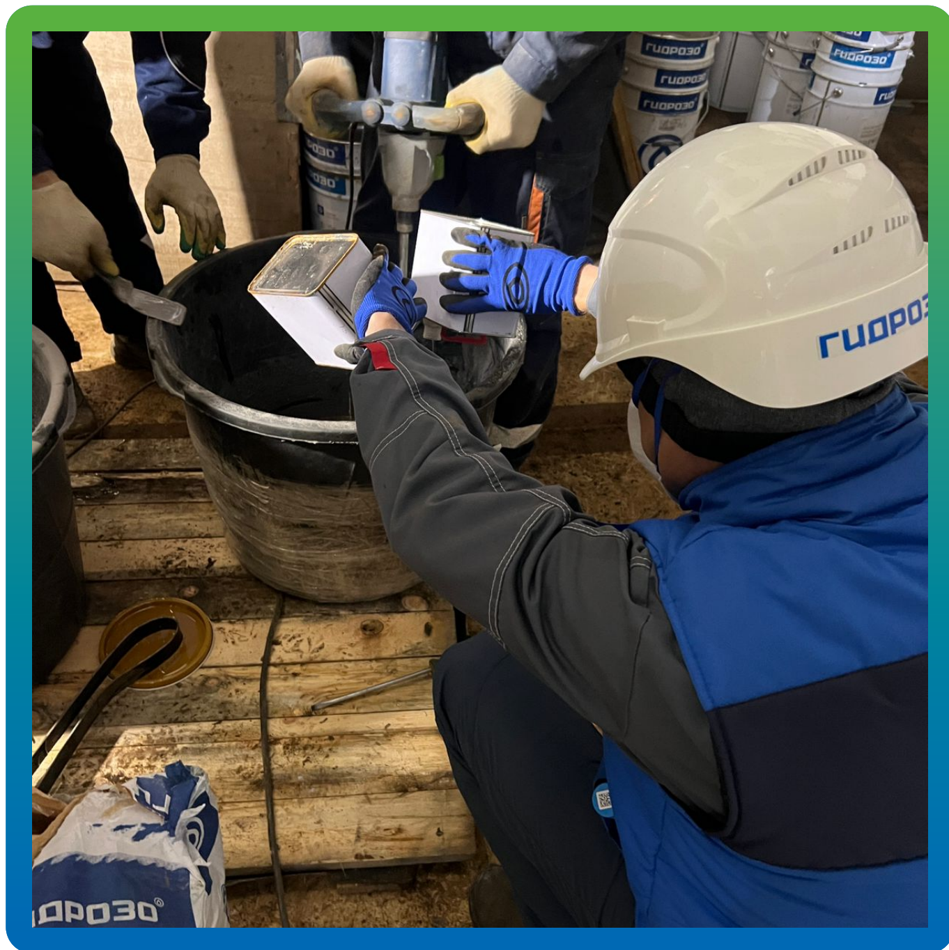
Заливка жидких компонентов в емкость для смешивания
