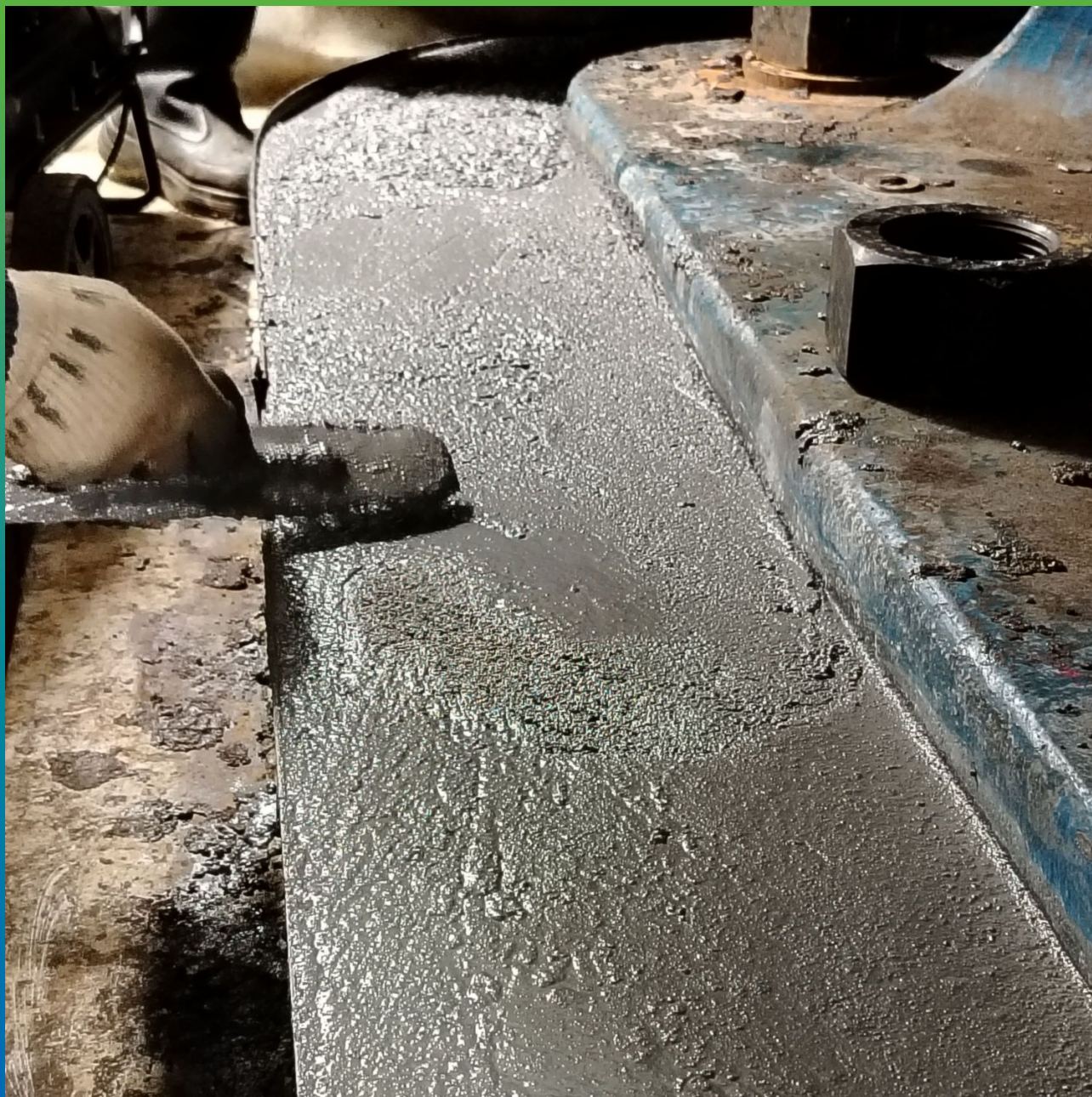
Заглаживание под опалубку
