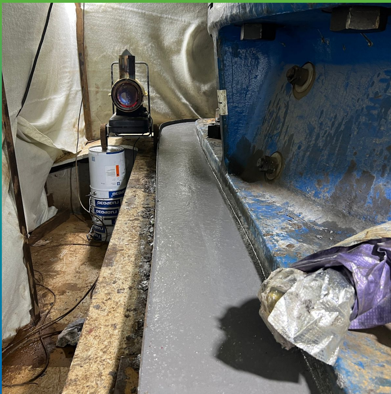
Второй слой подлит до уровня станины
