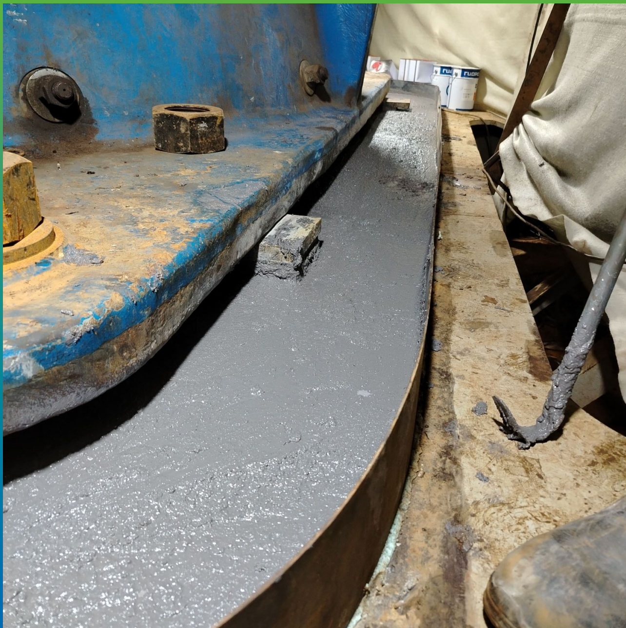
Первый слой залит, технологическая пауза
