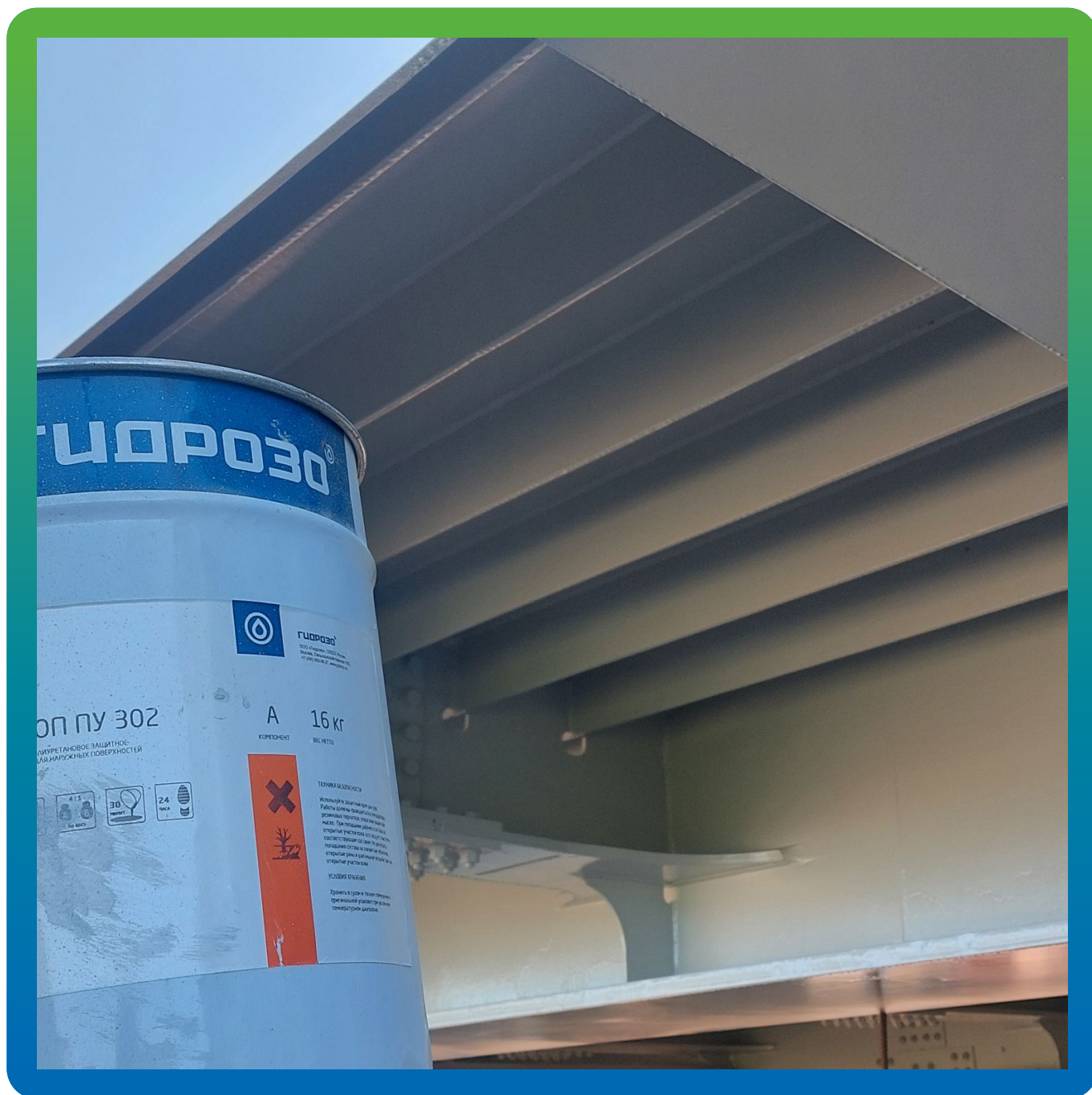
Результат нанесения финишного слоя системы АКЗ ДенСтоп ПУ 302. Практический расход состава: 0,3 кг/м 2
