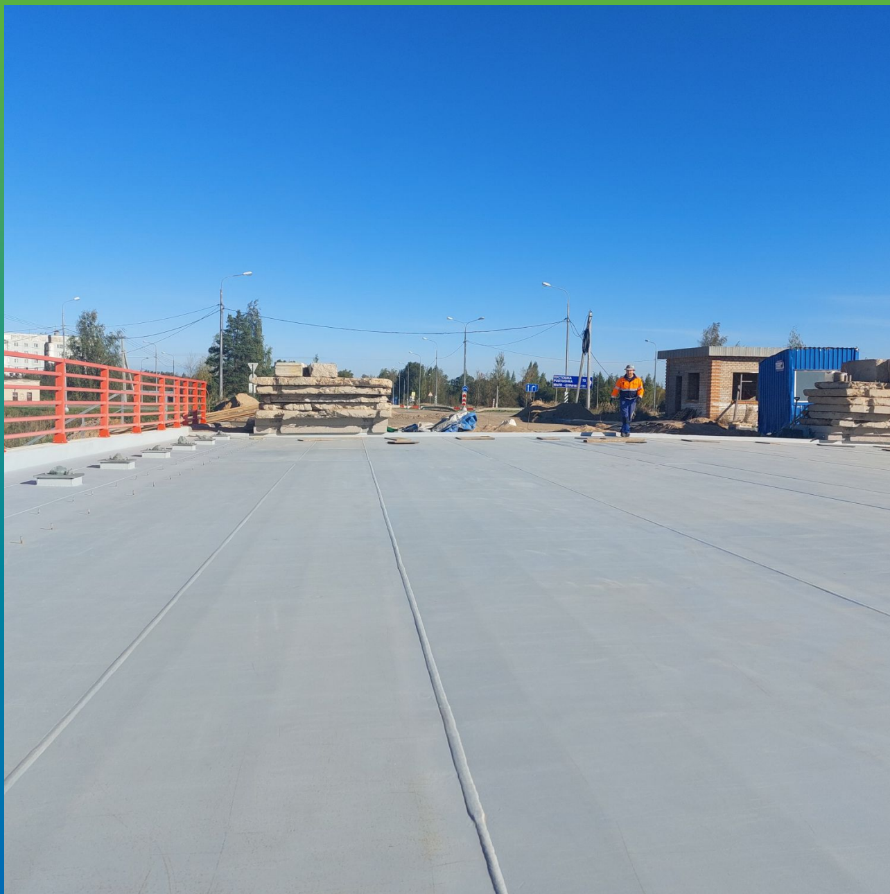
Поверхность после нанесения грунтовочного состава ДенсТоп ПУ 113
