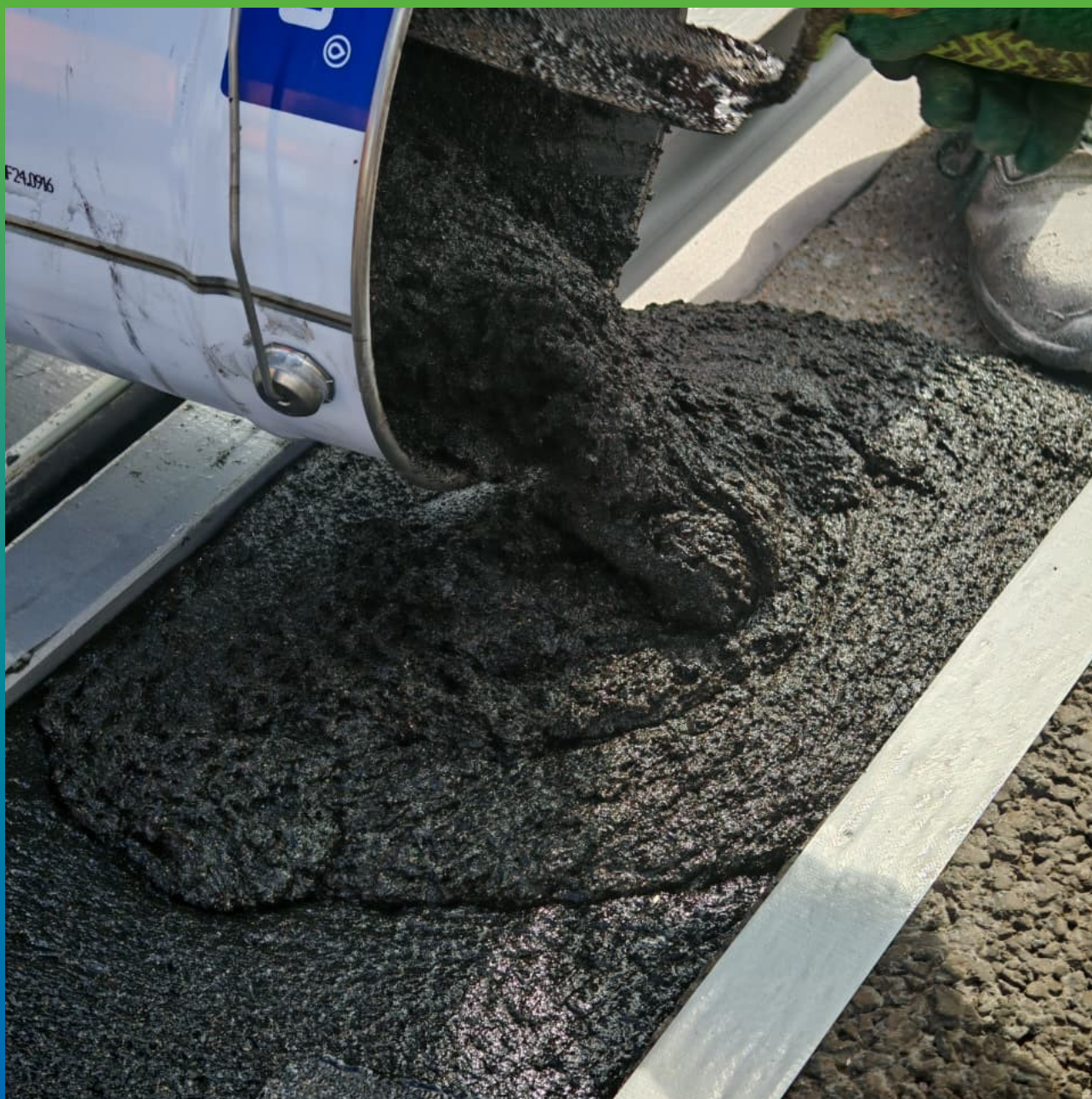
Укладка состава Манопур 336 в штробу деформационного шва
