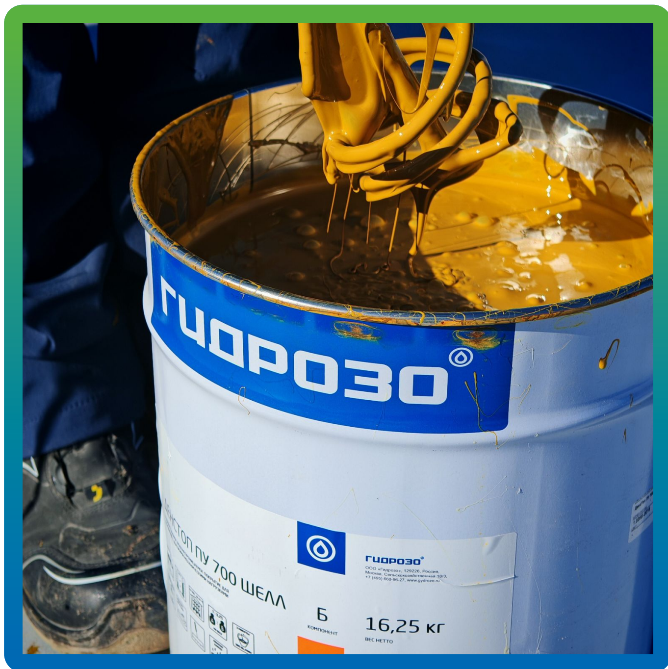
Процесс замешивания компонентов системы ДенТоп ПУ 700 Шелл
