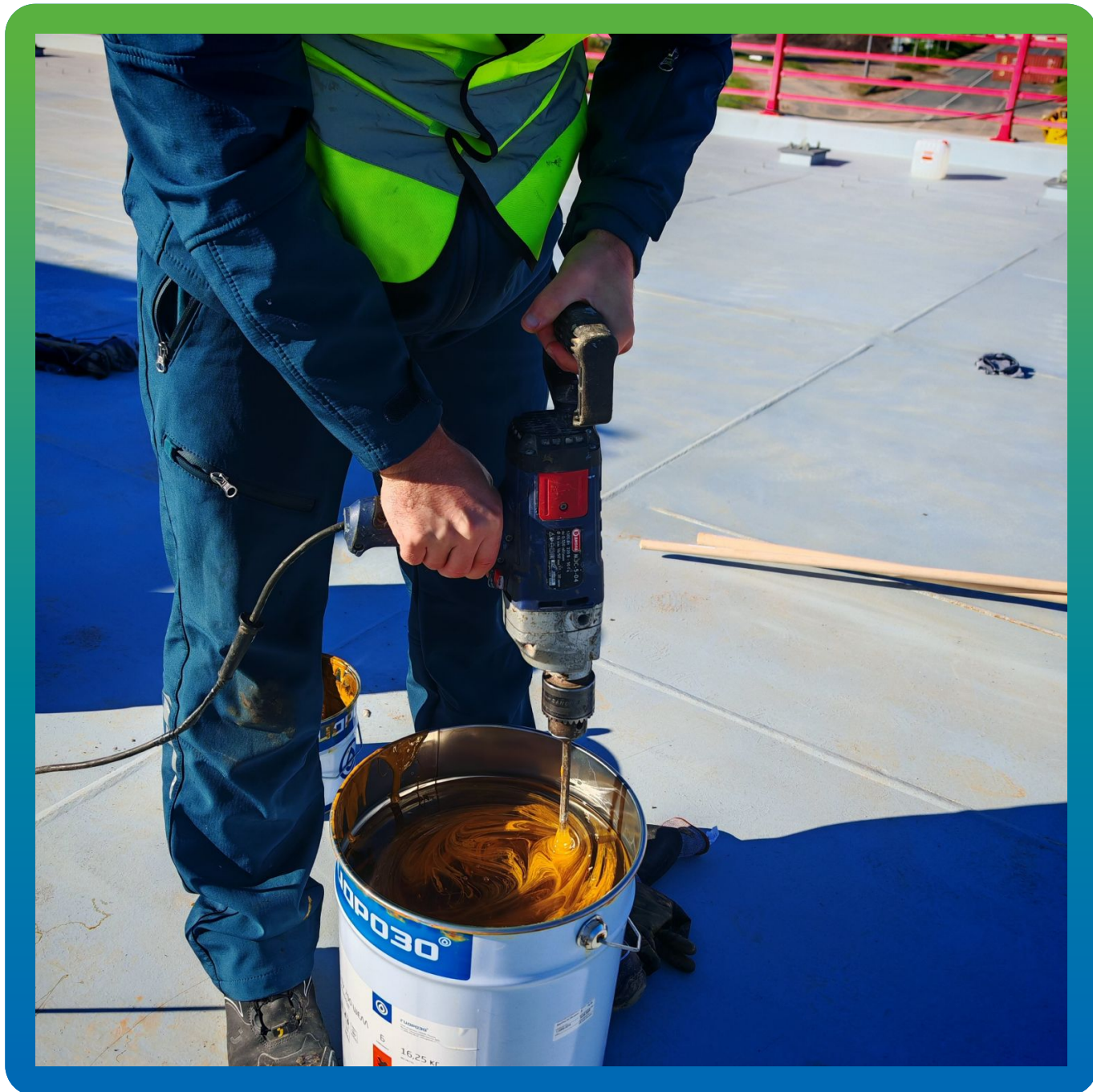
Процесс замешивания компонентов системы ДенТоп ПУ 700 Шелл
