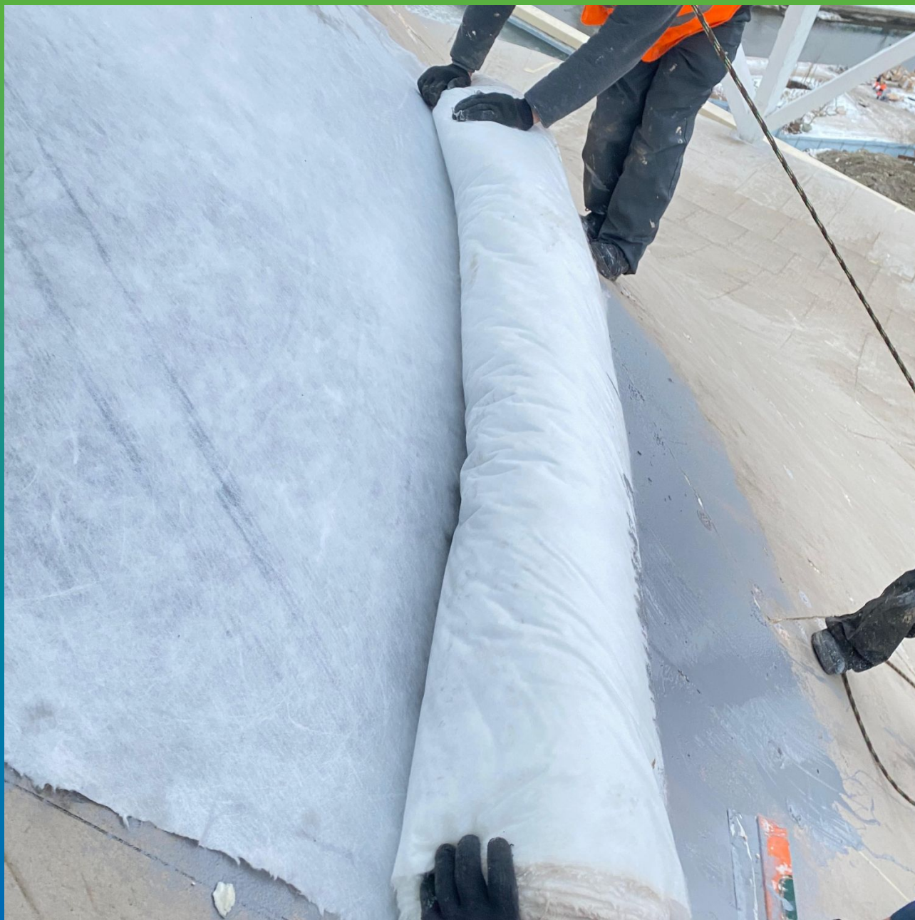
Расстиланье и утапливание Армошел ГТ 100
