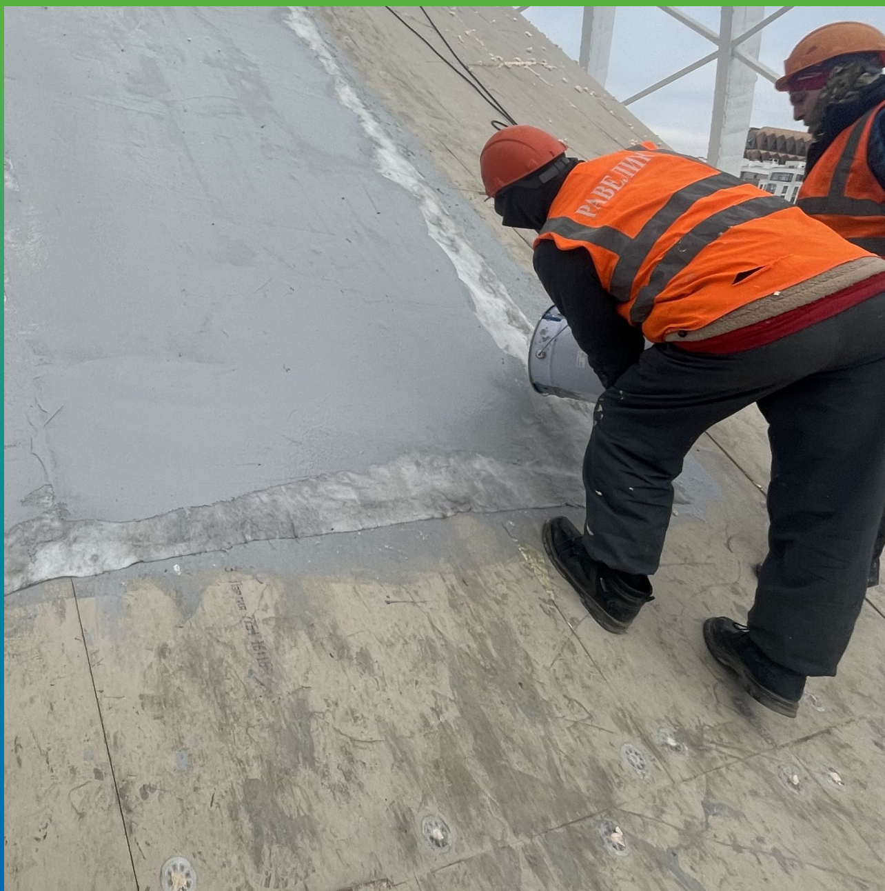
Нанесение второго слоя шпателем после технологического интервала до полимеризации ДенТоп МС 351
