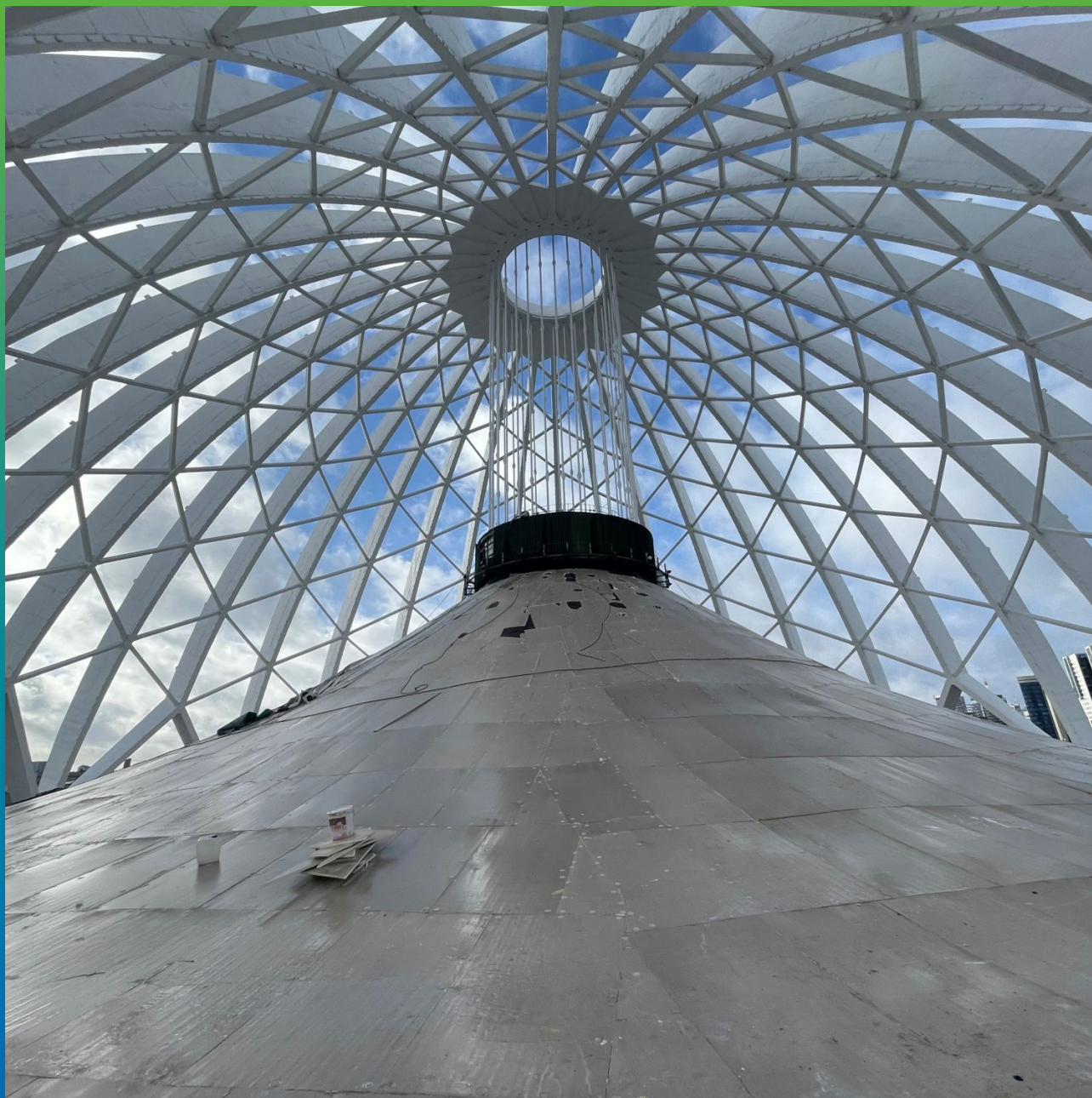
Купол цирка, подготовленный к монтажу гидроизоляционной системы ДенсТоп МС 351 с межслойным армированием полотном Армошел ГТ 100
