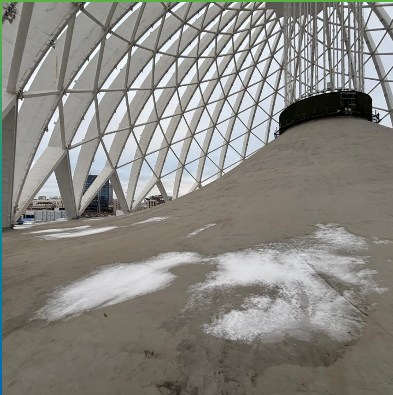
Итоговый вид на полностью нанесённую гидроизоляционную систему ДенсТоп МС 351 + Армошел ГТ 100
