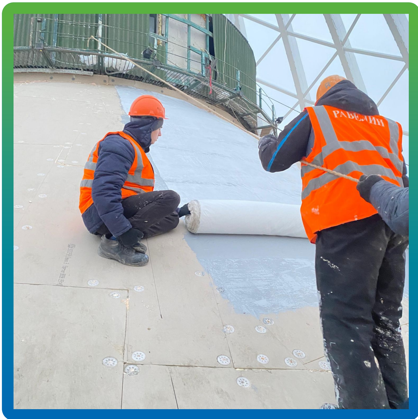
Нанесение первого слоя ДенТоп МС 351 с армированием Армошел ГТ 100
