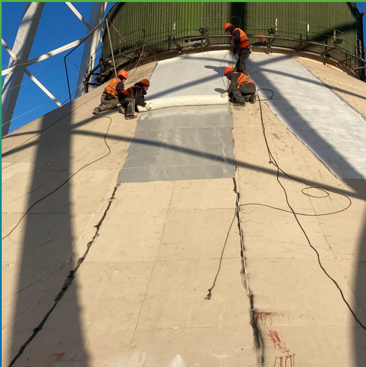
Производство работ по нанесению первого слоя ДенсТоп МС 351
