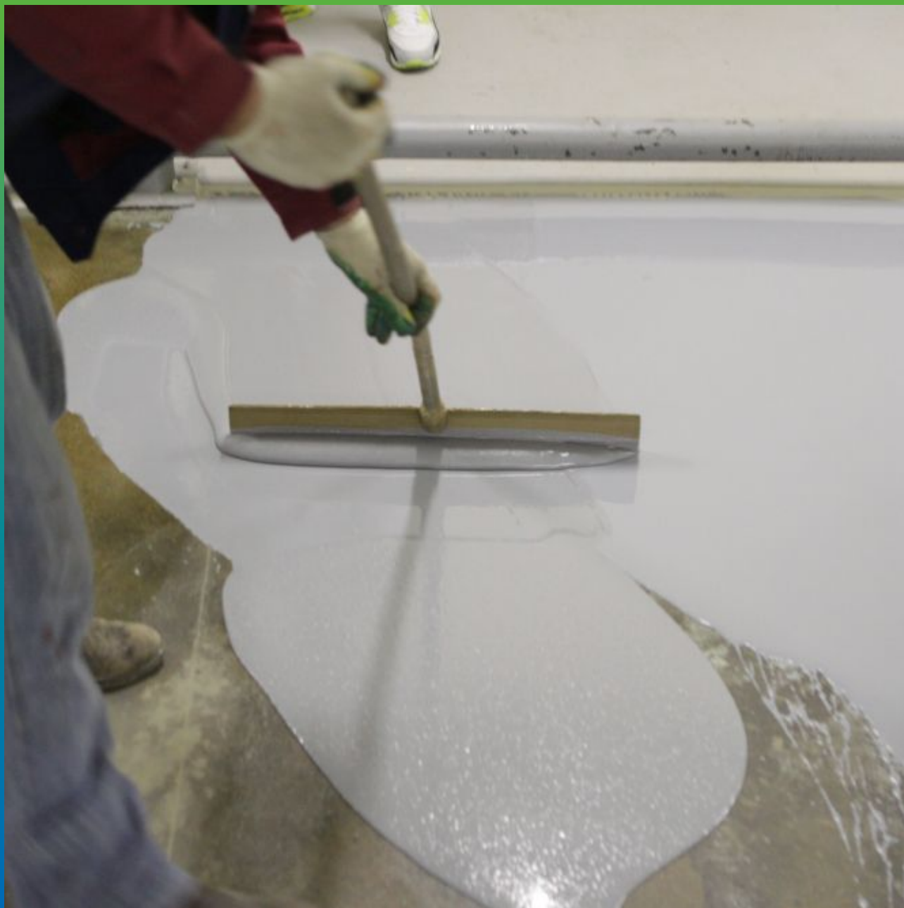
Выравнивание раклей наливного пола Денстоп ЭП 500
