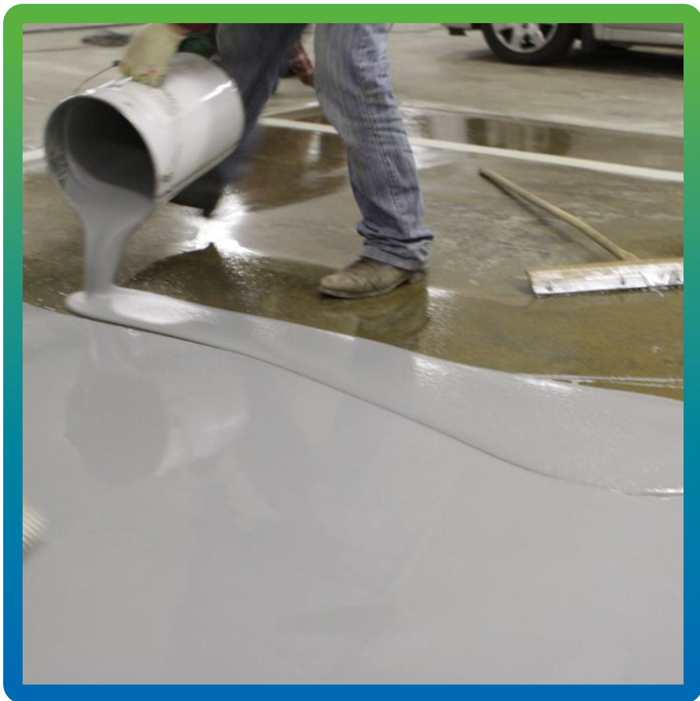
Устройство эпоксидного пола Денстоп ЭП 500
