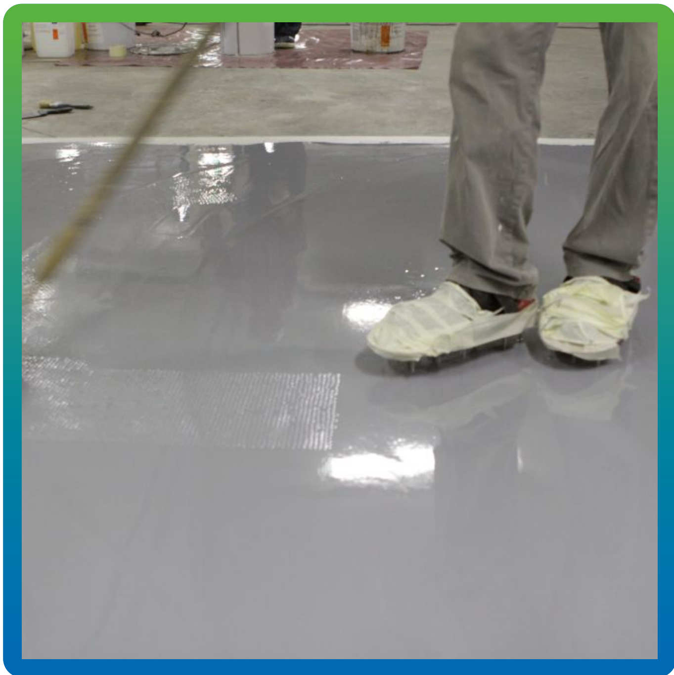
Прокатка игольчатым валиком с целью извлечения пузырьков воздуха
