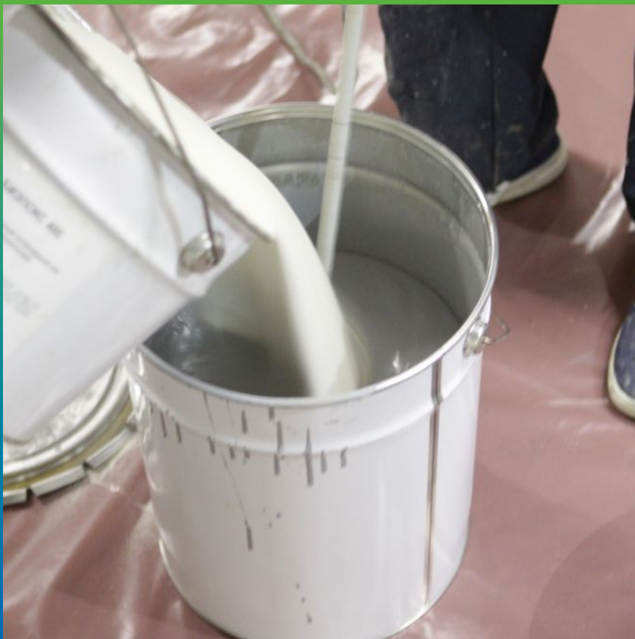
Добавление кварцевого песка в готовую смесь Денстоп ЭП 500
