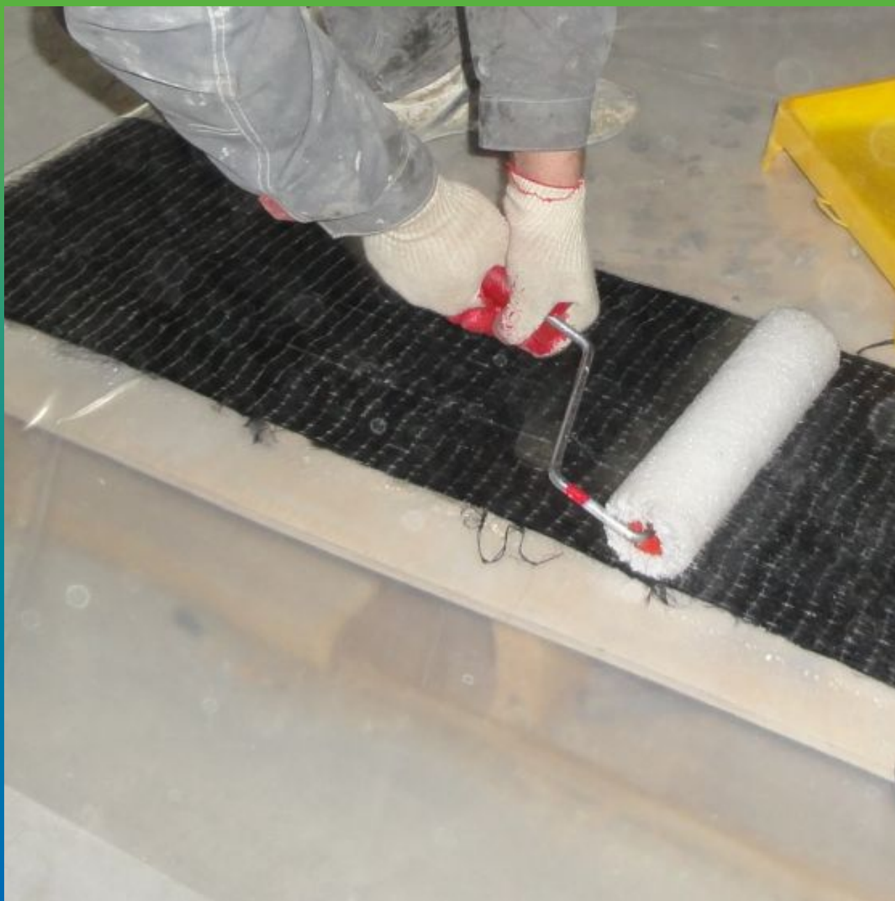
Пропитка ткани "Тайфо СЦХ 41" эпоксидным клеем "Тайфо С"
