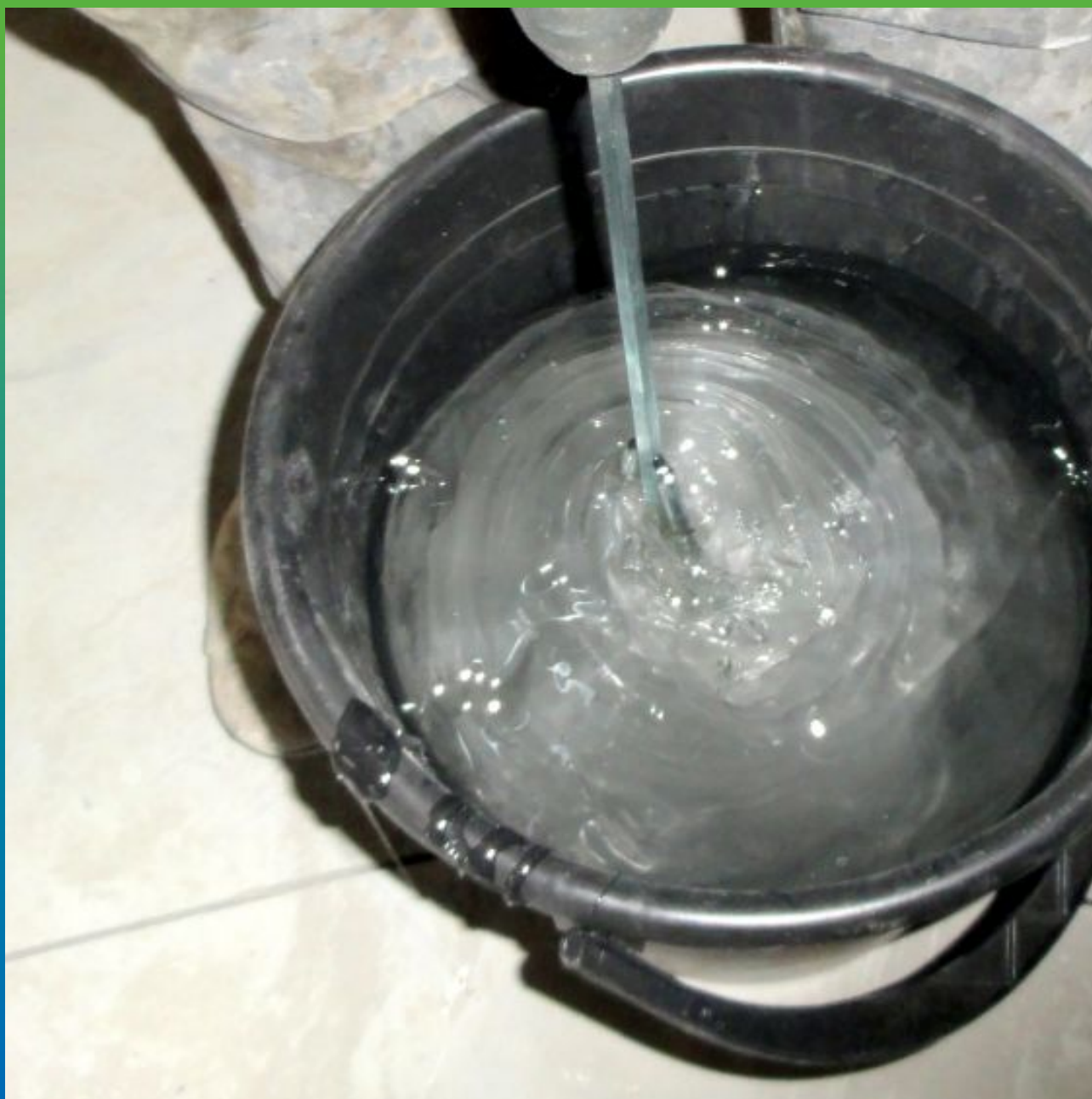
Замешивание компонентов А+В эпоксидного клея "Тайфо С"
