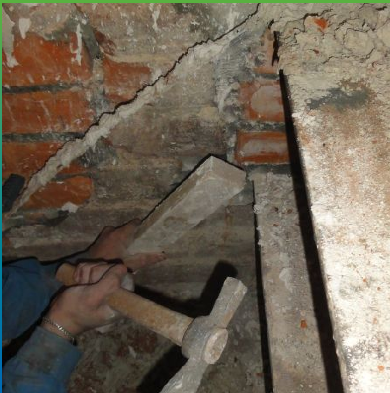
Установка пакеров БМ 2830
