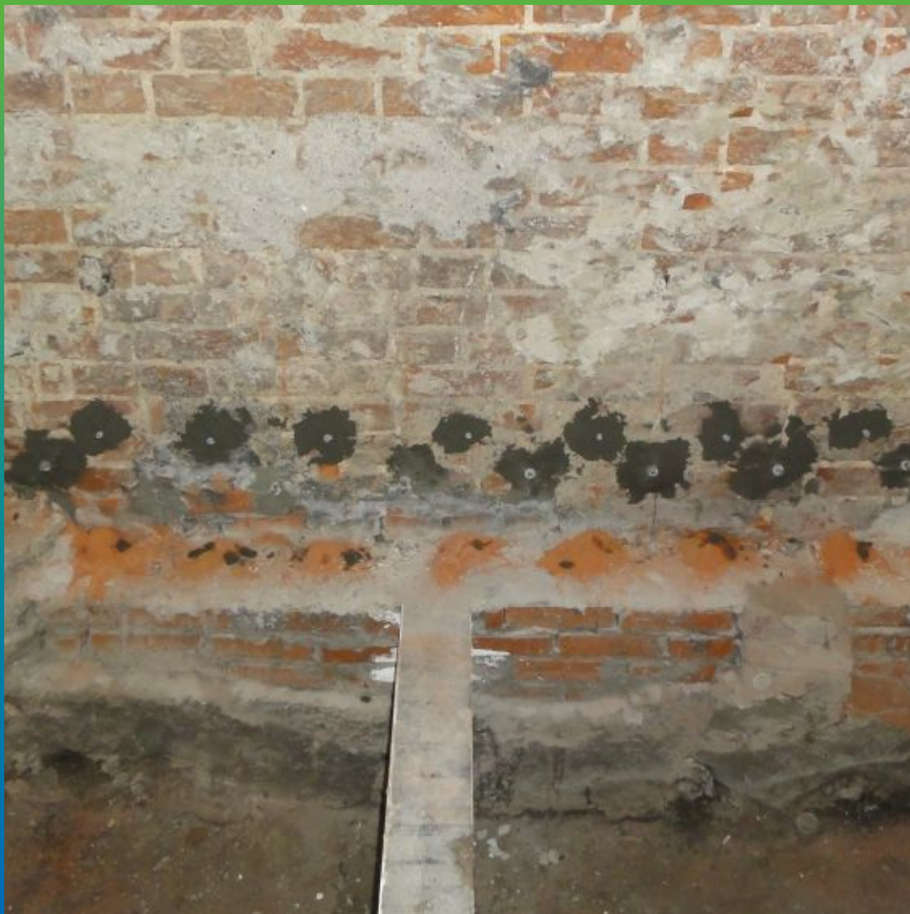
Вид пакеров после инъектирования. Нижний ряд - Максгрут Инжекшн. Верхний ряд - Максклир Инжекшн.
