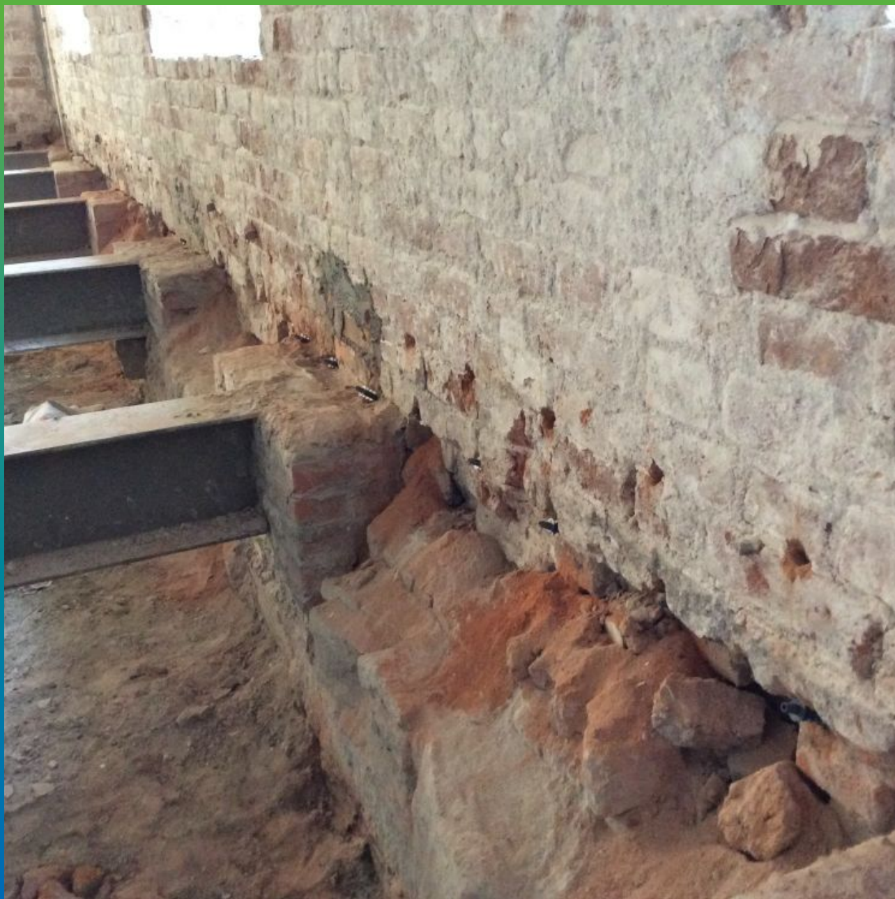
Вид установленных пакеров
