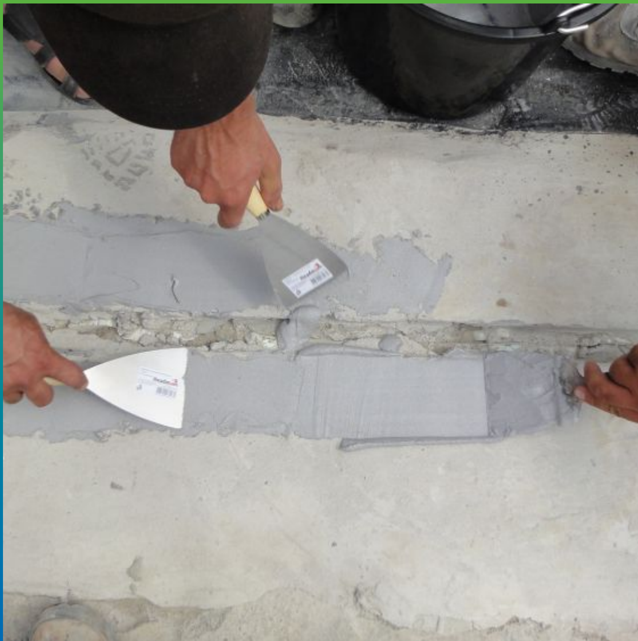
Нанесение Манопокс 331 на кромки шва
