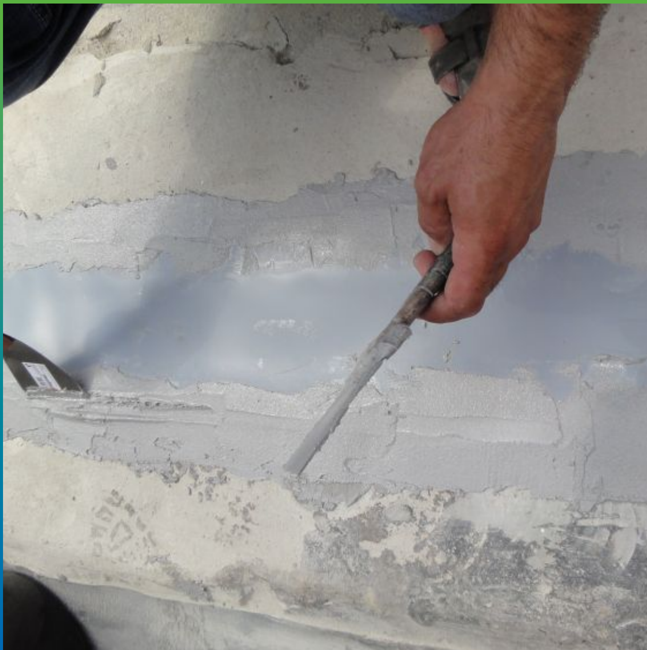
Монтаж ленты Манодил Про на Манопокс 331
