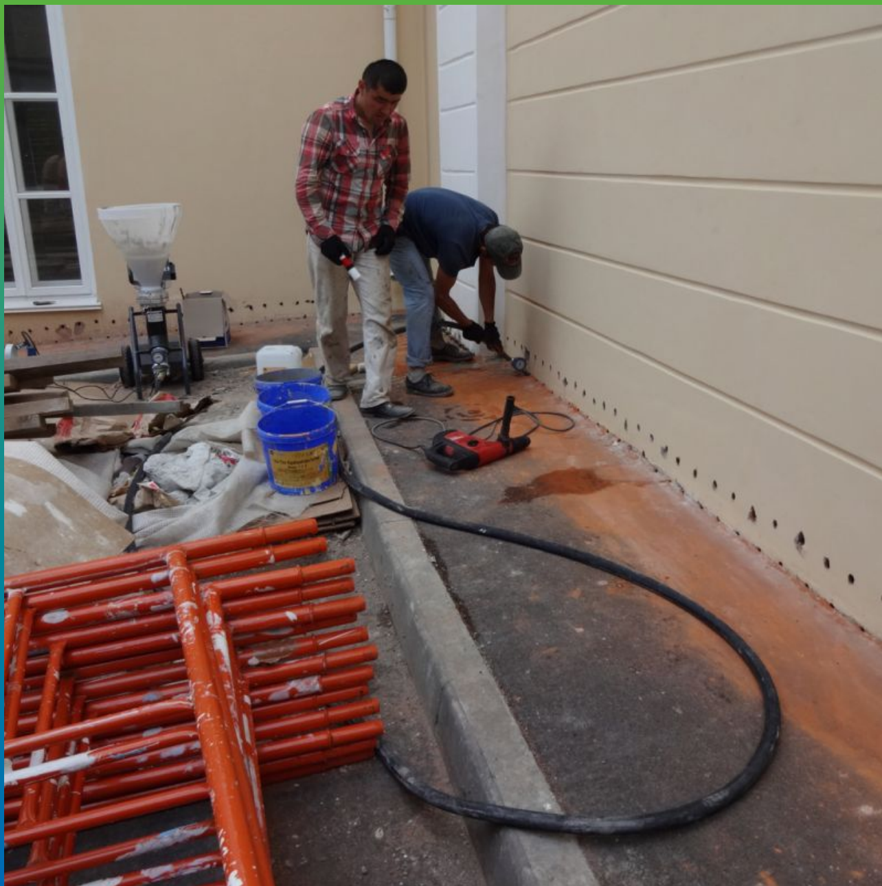
Инъектирование высокотекучего состава Максгрут инъекшн в кирпичную кладку с помощью насоса БМП-6
