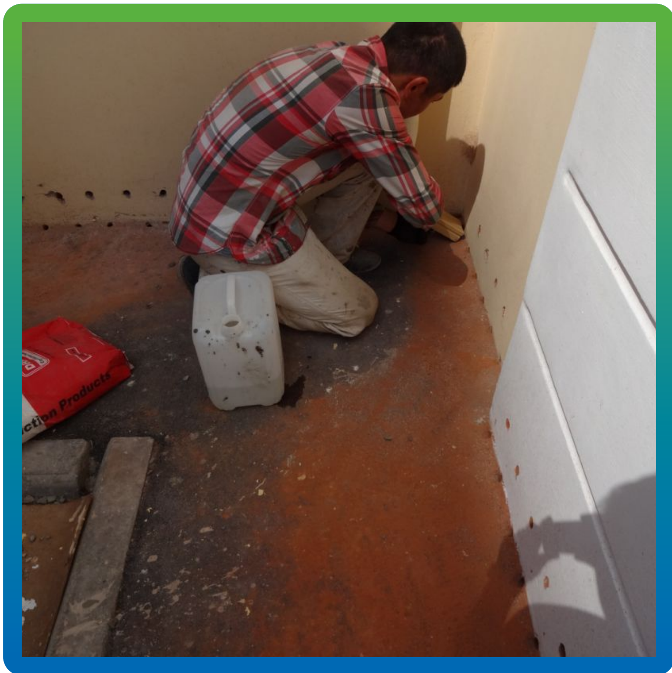
Установка в пробуренные шпуров пакеров с обратным клапаном БМ 2830
