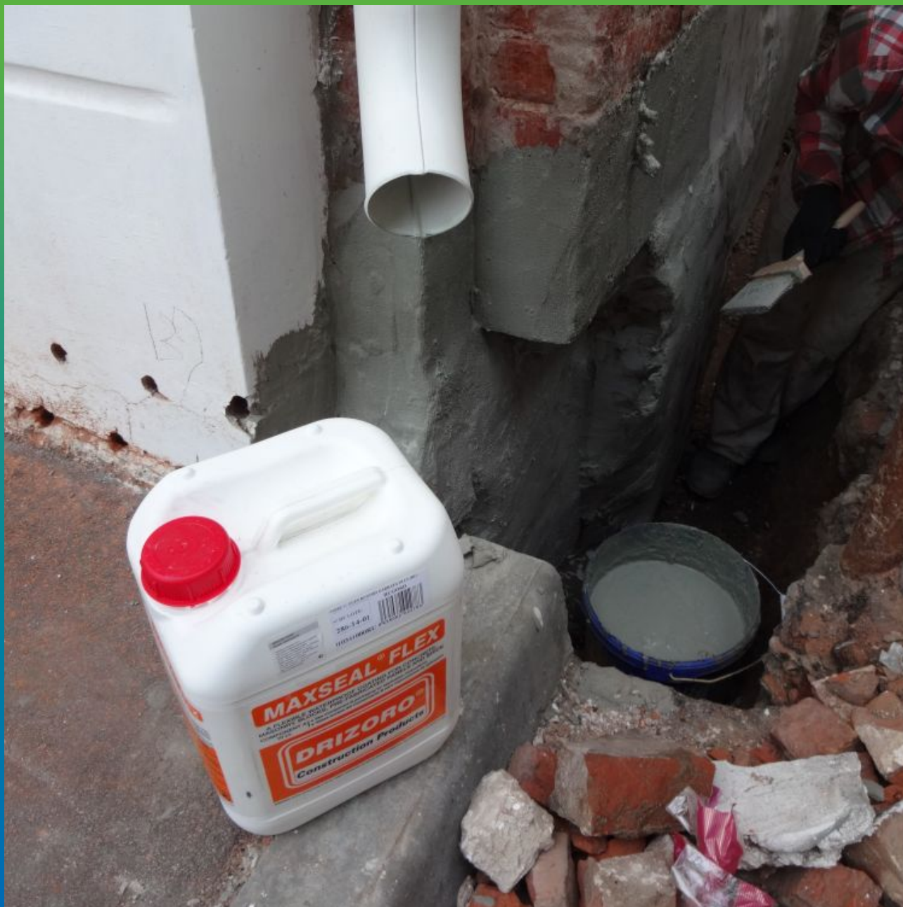
Нанесение гидроизоляции Максил Флекс на стены храма
