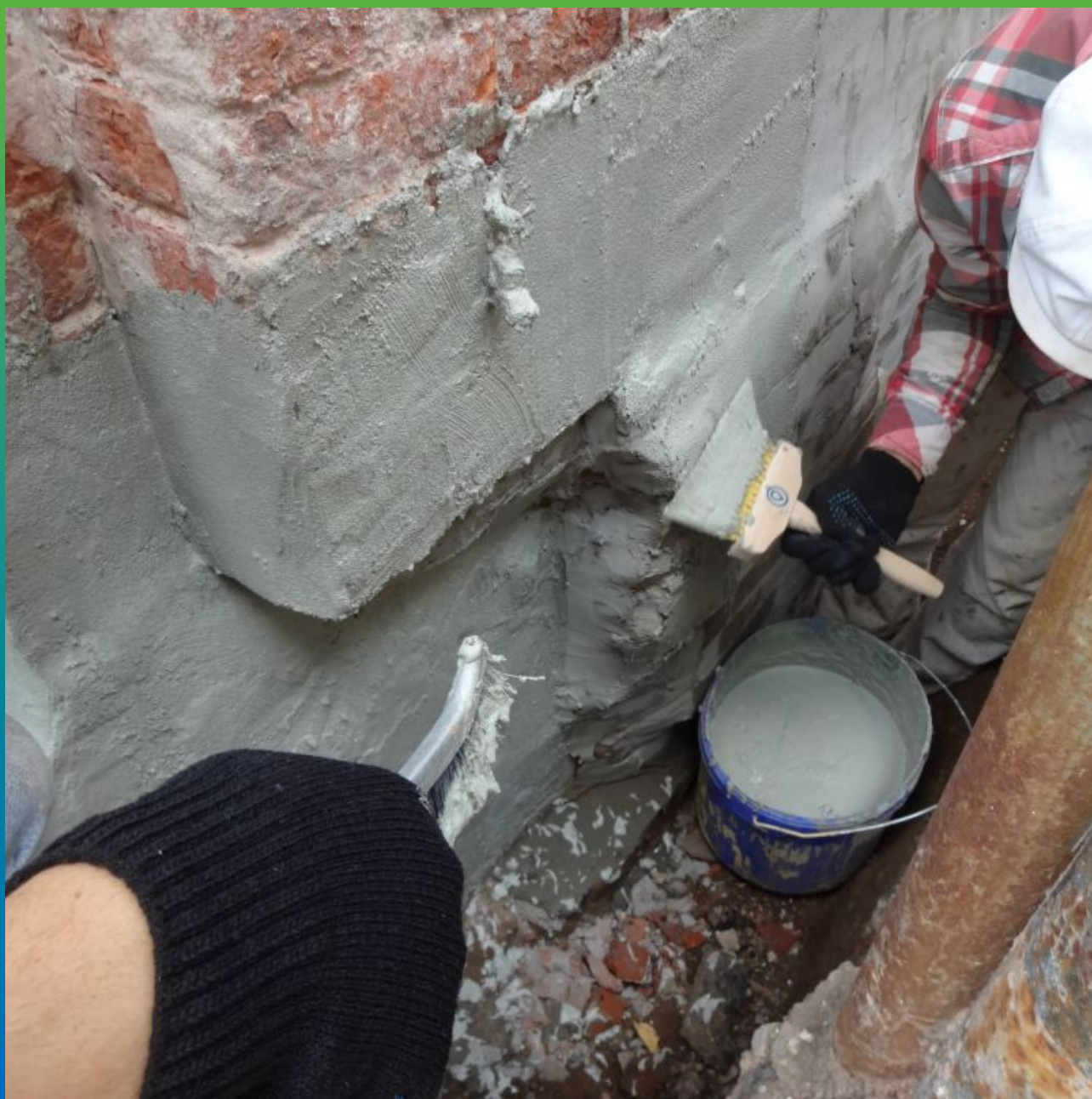
Нанесение гидроизоляции Максил Флекс на стены храма
