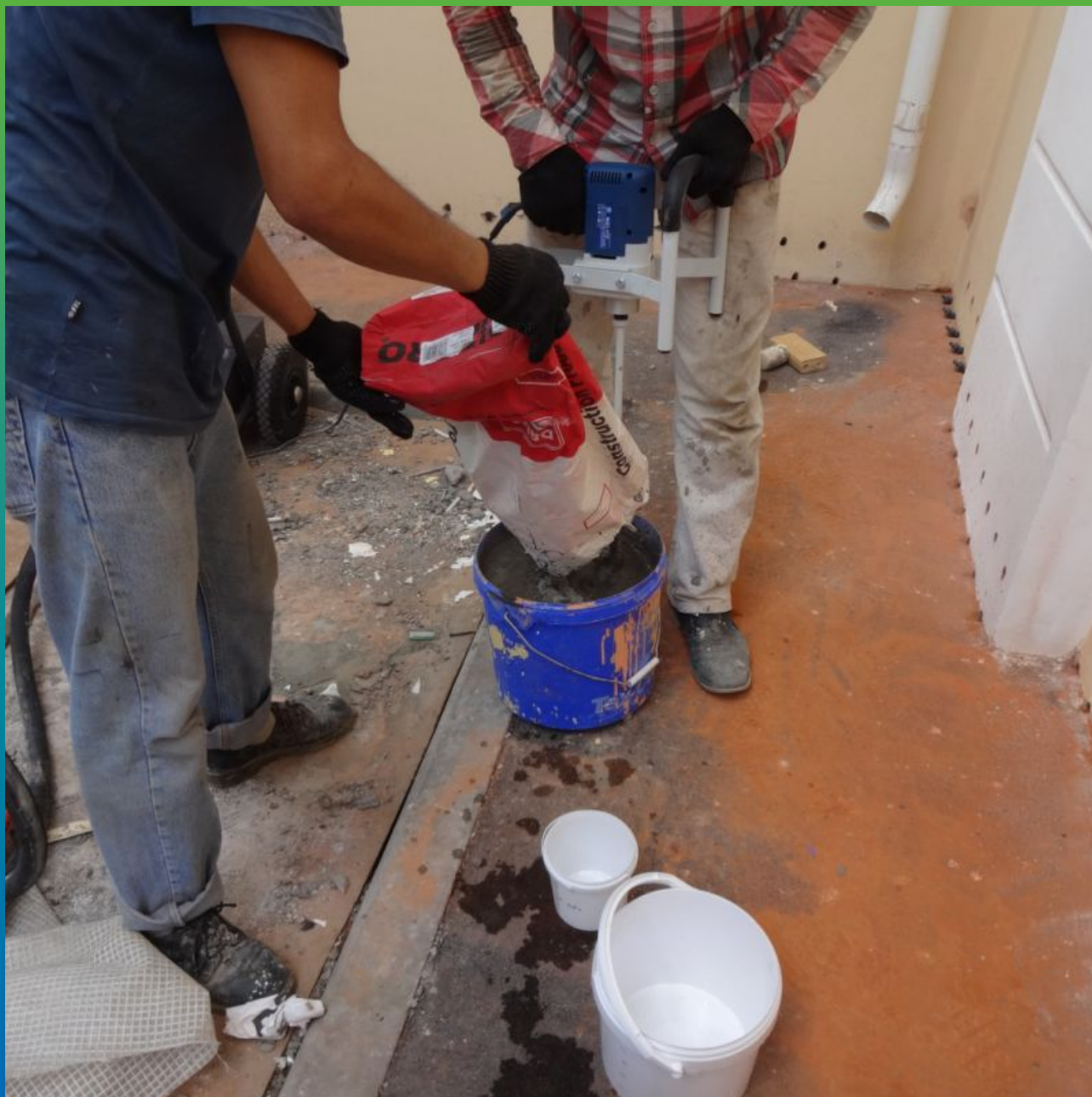
Затворение с водой инъекционного раствора Максгрут Инжекшн
