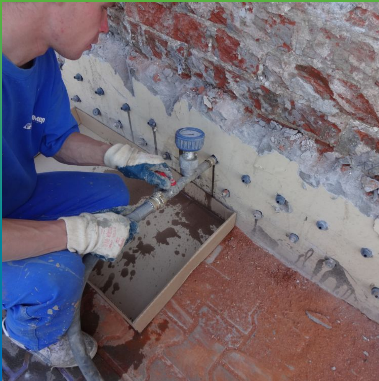
Инъектирование состава Максклир Инжекшн в кирпичную кладку
