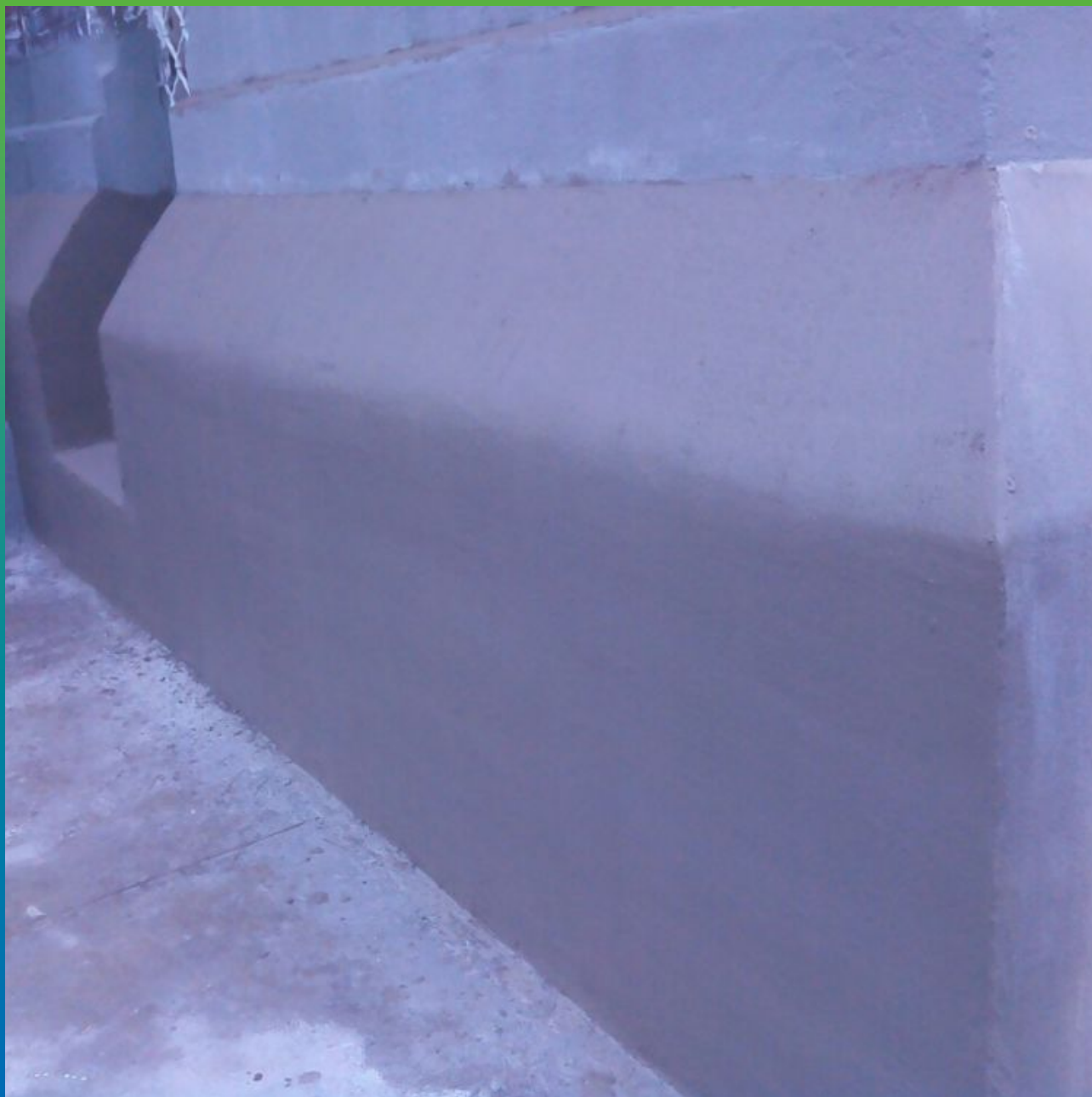
Нанесение Макссил Флекс на кирпичную кладку
