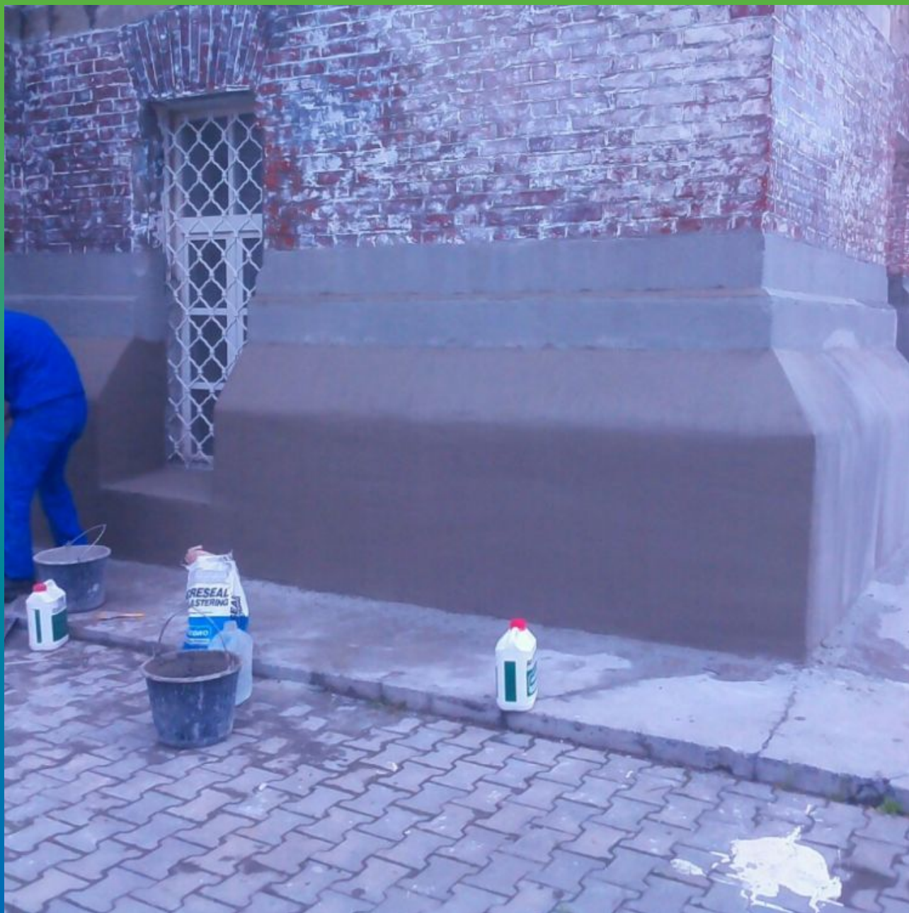
Нанесение защитного слоя Конкресил Пластеринг поверх гидроизоляции Максил Флекс
