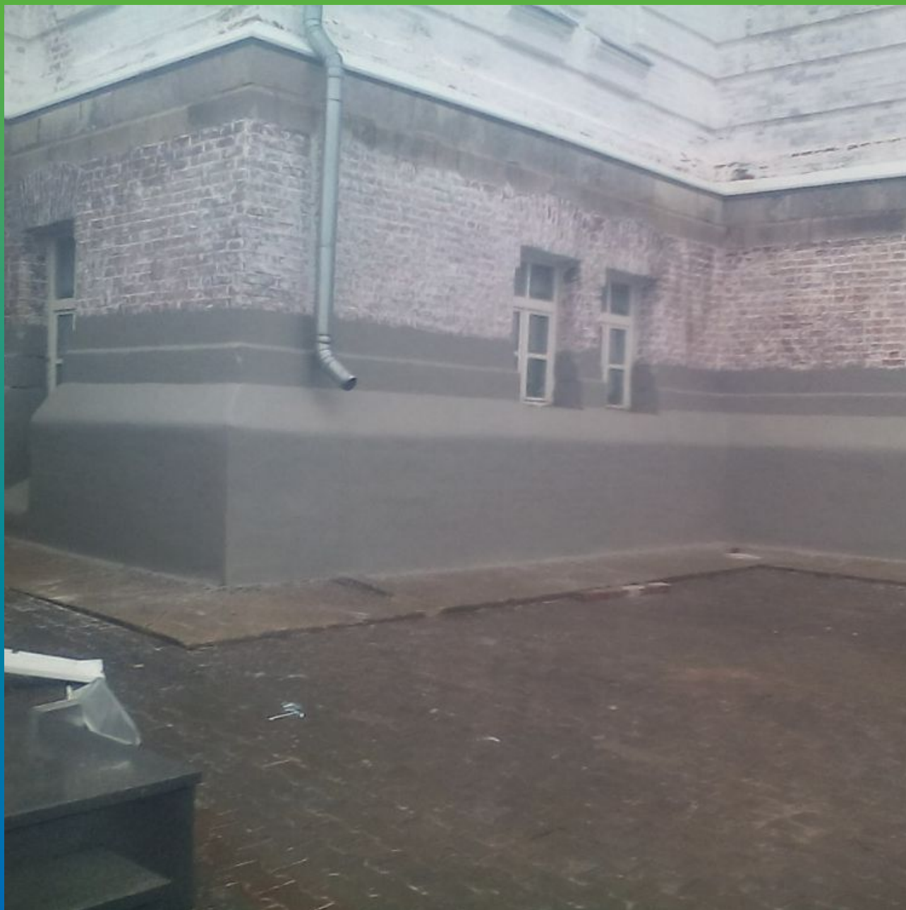
Кирпичная кладка с нанесенной гидроизоляцией Макссил Флекс
