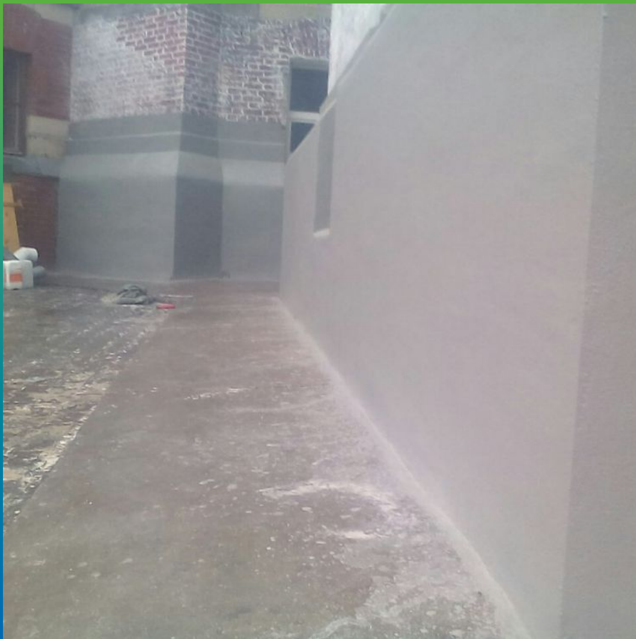
Кирпичная кладка с нанесенной гидроизоляцией Максил Флекс
