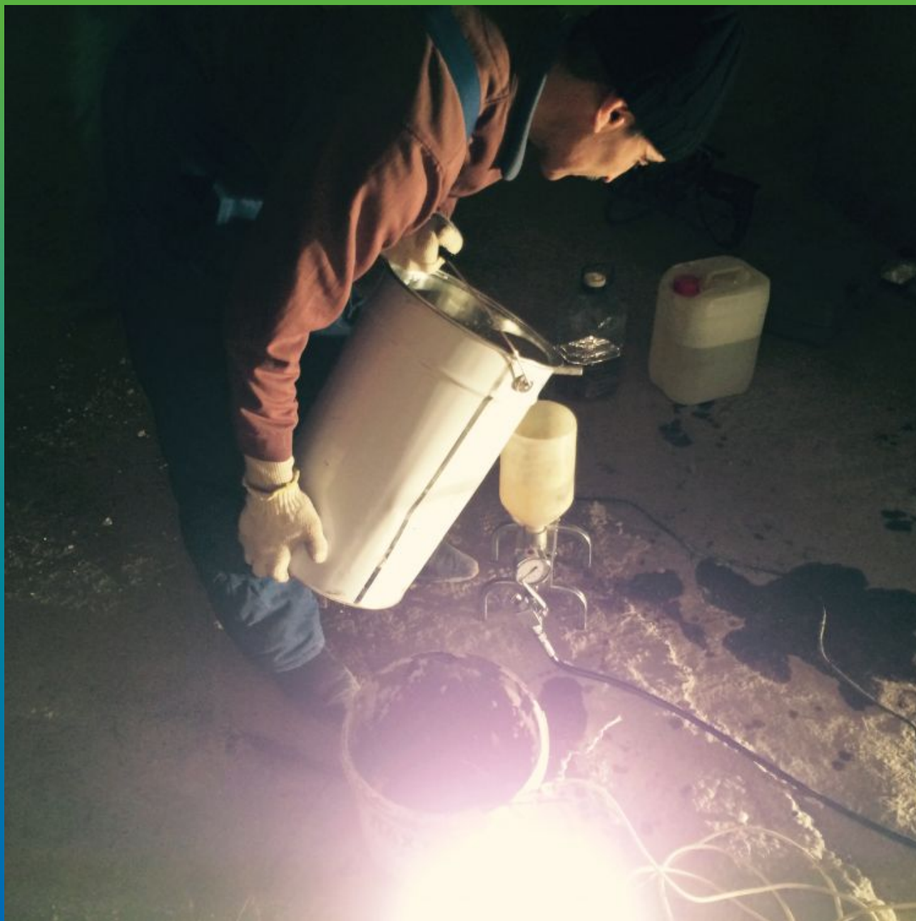
Загрузка бункера насоса составом Манопур С
