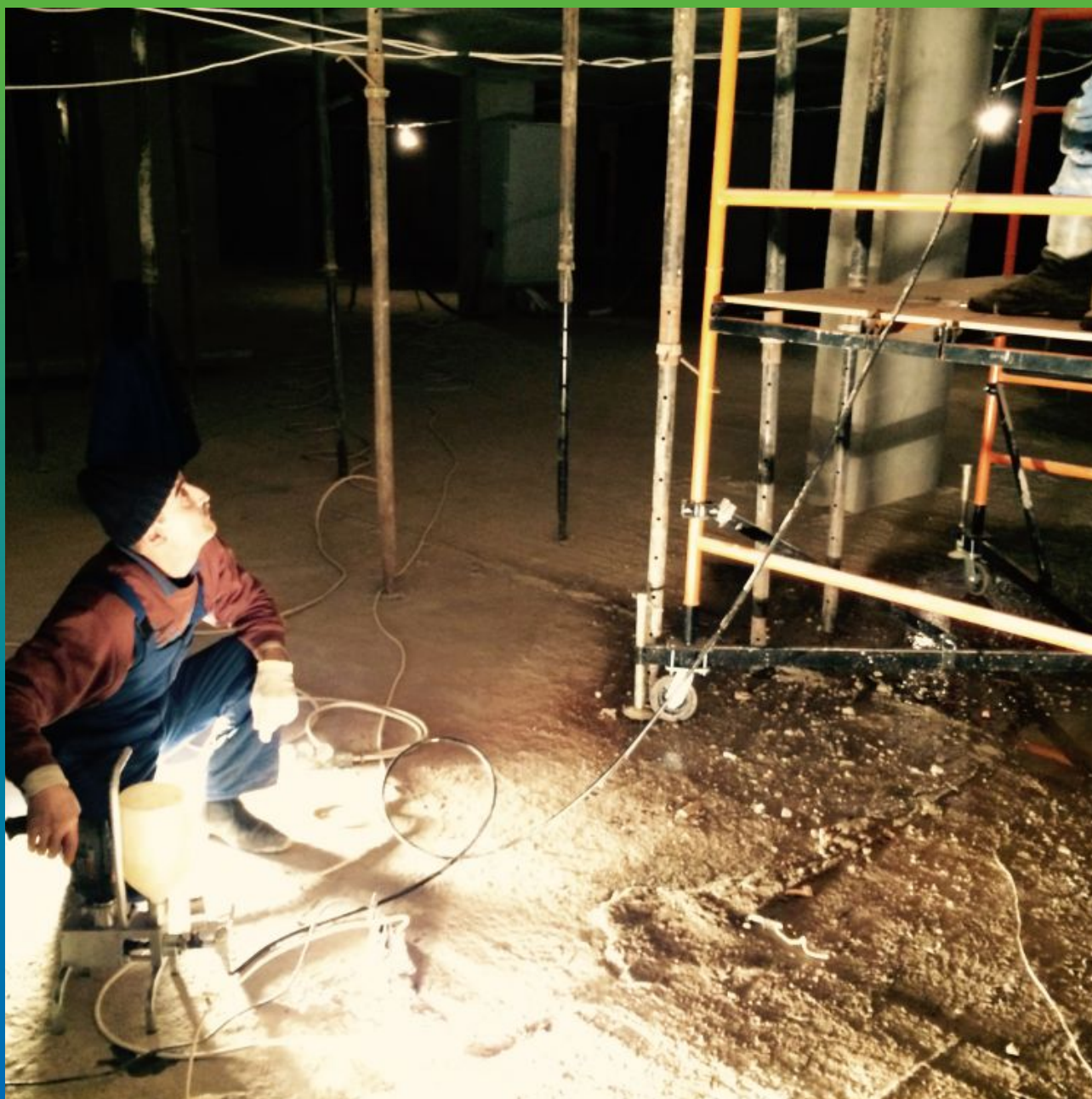
Инъектирование состава Манопур С
