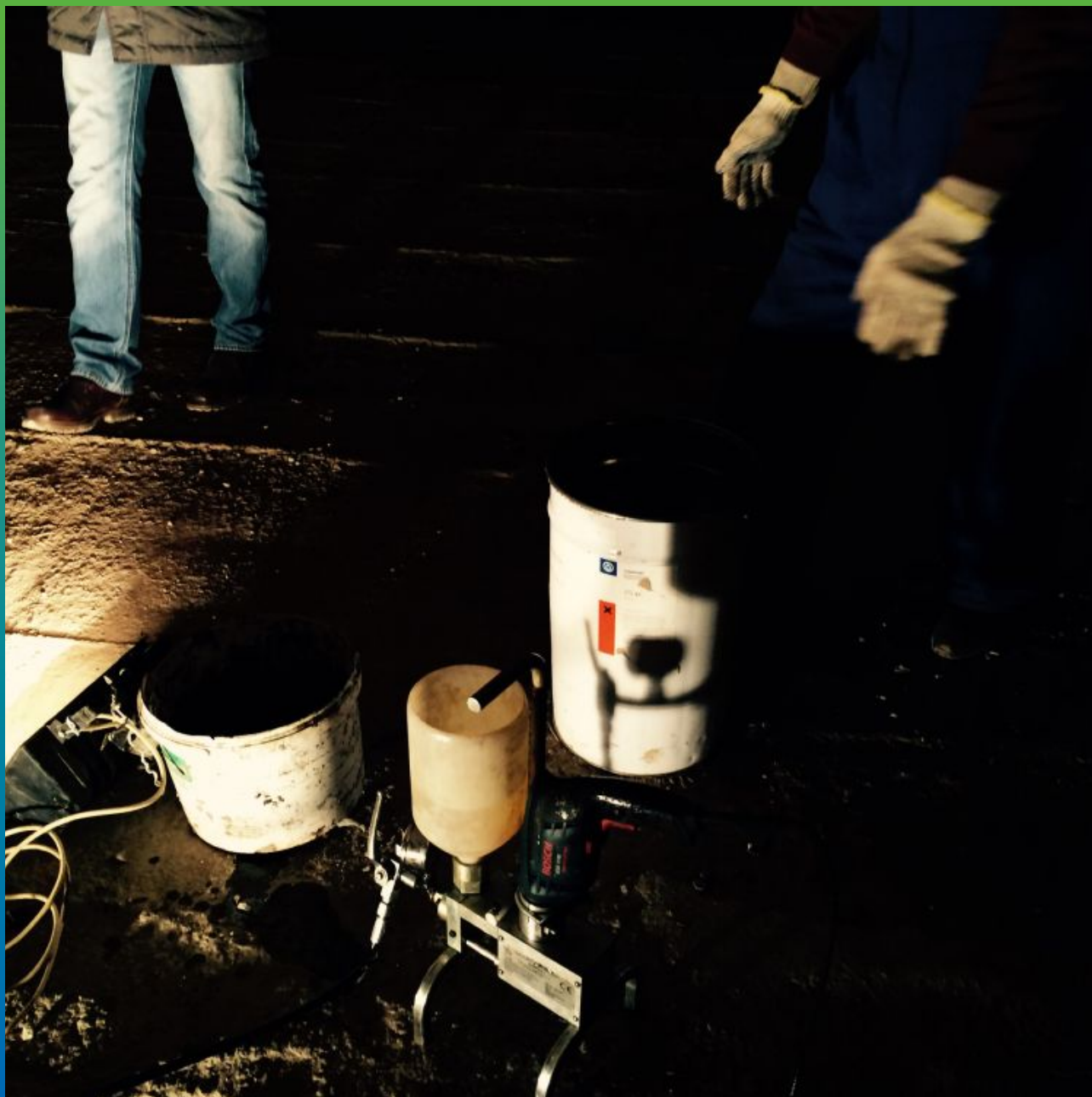
Подготовка к инъекционным работам
