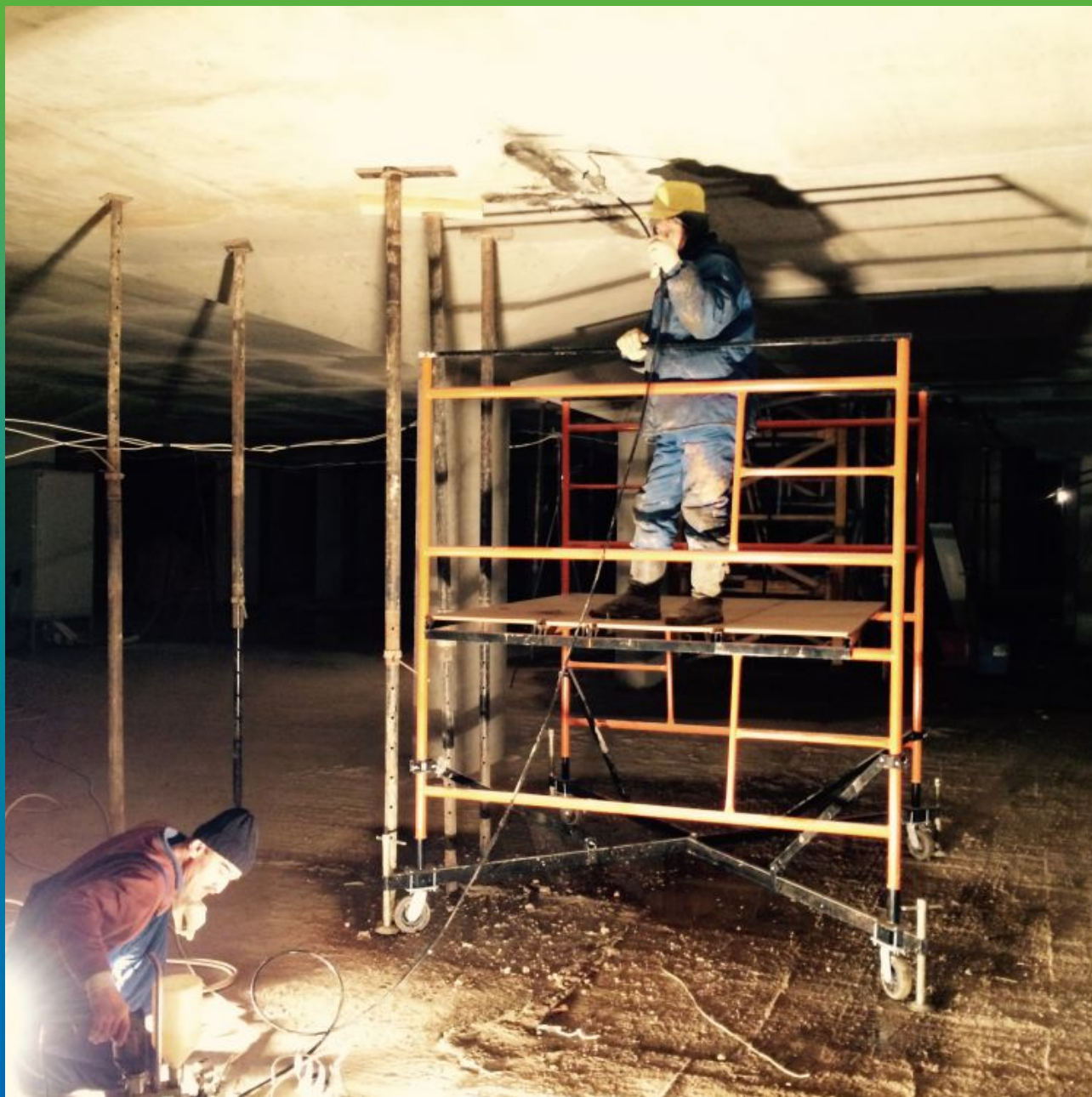
Инъектирование состава Манопур С
